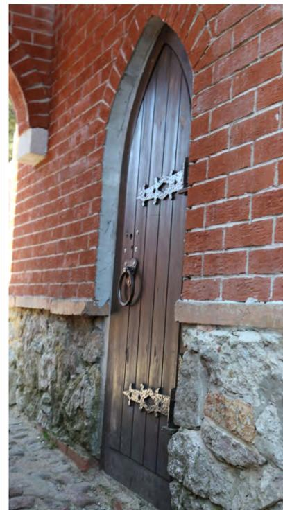
Стрельчатый дверной проем входа в южный объем. Габариты, местоположение, материал дверных заполнений (дерево, металл)
