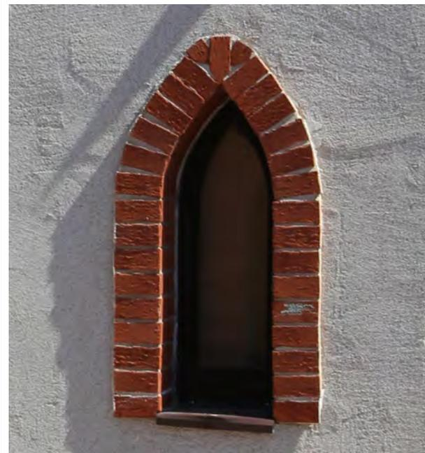
Стрельчатые оконные проемы южного фасада южного объема, с кирпичными наличниками. Количество (3), габариты, местоположение, материал оконных заполнений (дерево)
