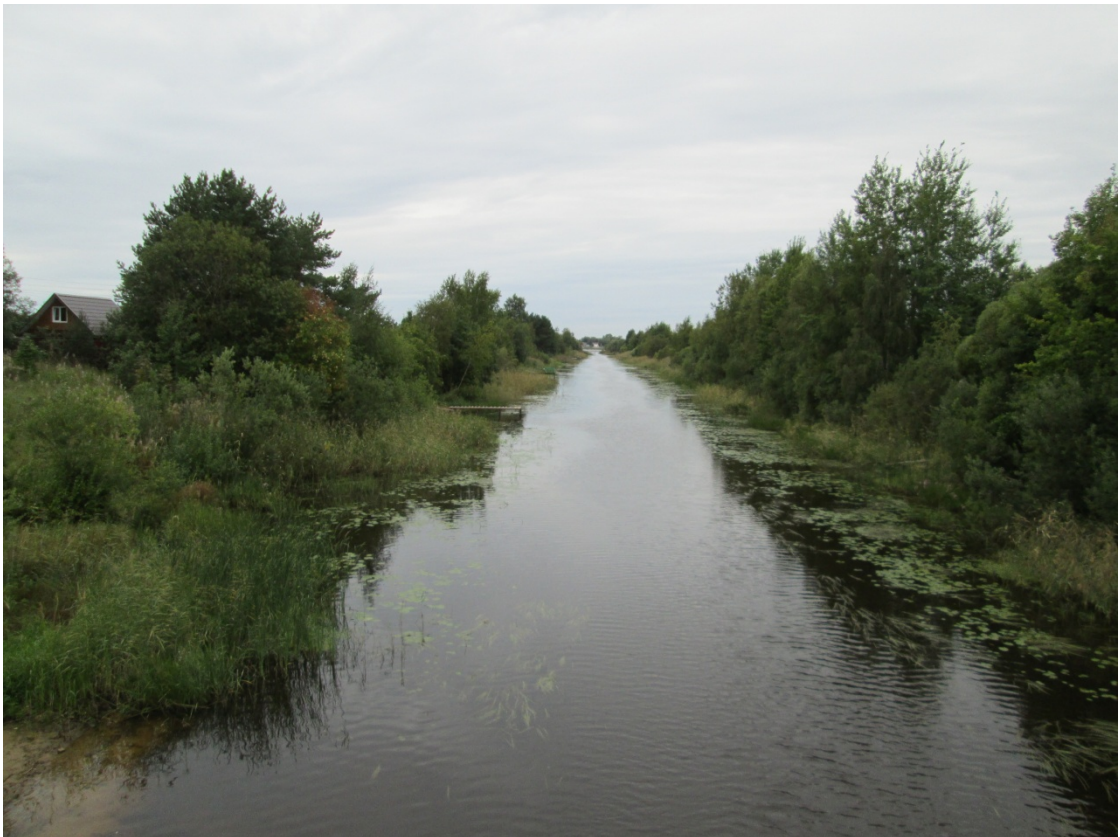
Илл. 43. Ленинградская обл., Волховский р-н. ОКН «Сяьский канал (б. канал Екатерины II)». Точка фотофиксации Ф11. Вид с северо-востока на русло канала, д. Немятово 2.
