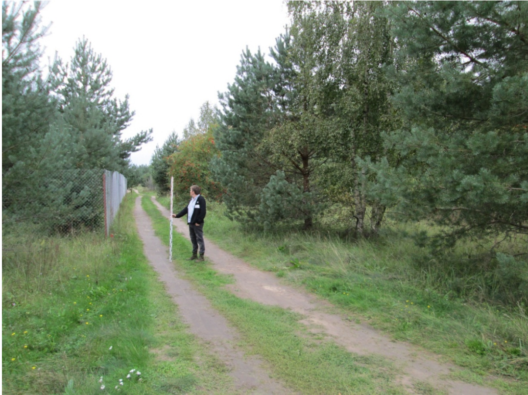
Илл. 39. Ленинградская обл., Волховский р-н. ОКН «Новосясский канал (б. канал Императрицы Марии Федоровны)», северный берег. Точка фотофиксации Ф9. Вид с северо-востока на трассу проектирования, д. Немятово 1, ул. Дачная.
