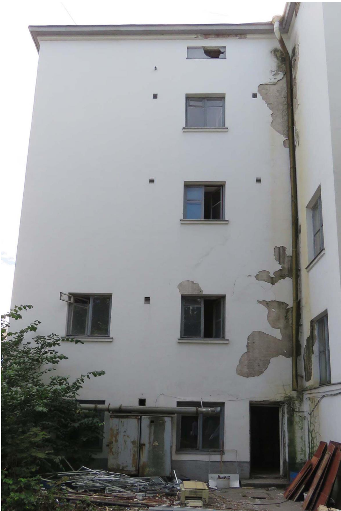
Фото 11. Проемы правой части С-3 дворового фасада. Дата съемки: 23.09.2021 г.
