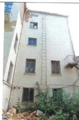
Правая часть дворового С-З фасада
