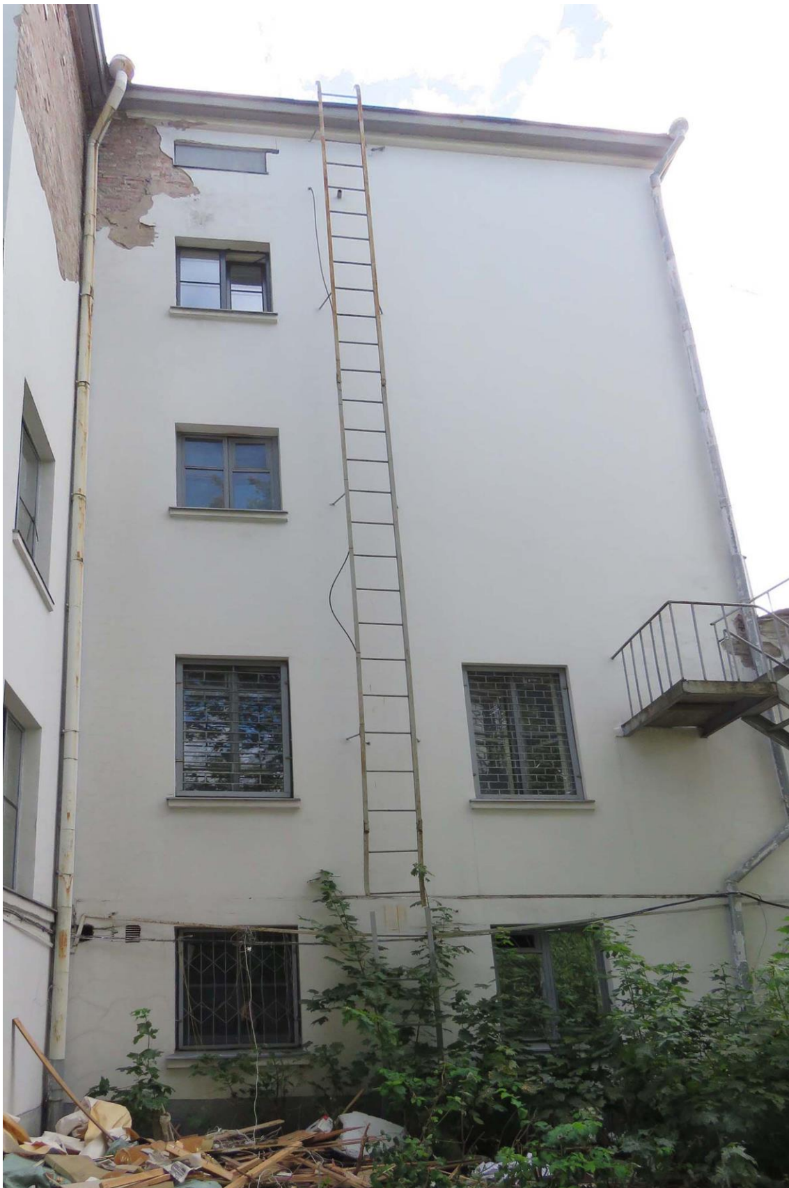
Фото 14. Проемы левой части дворового СС-3 фасада. Дата съемки: 23.09.2021 г.
