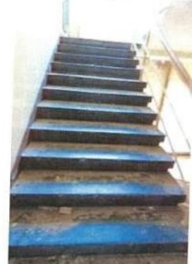
Лестница ЛК-1. Марш с 3-го этажа на 4-ый этаж
