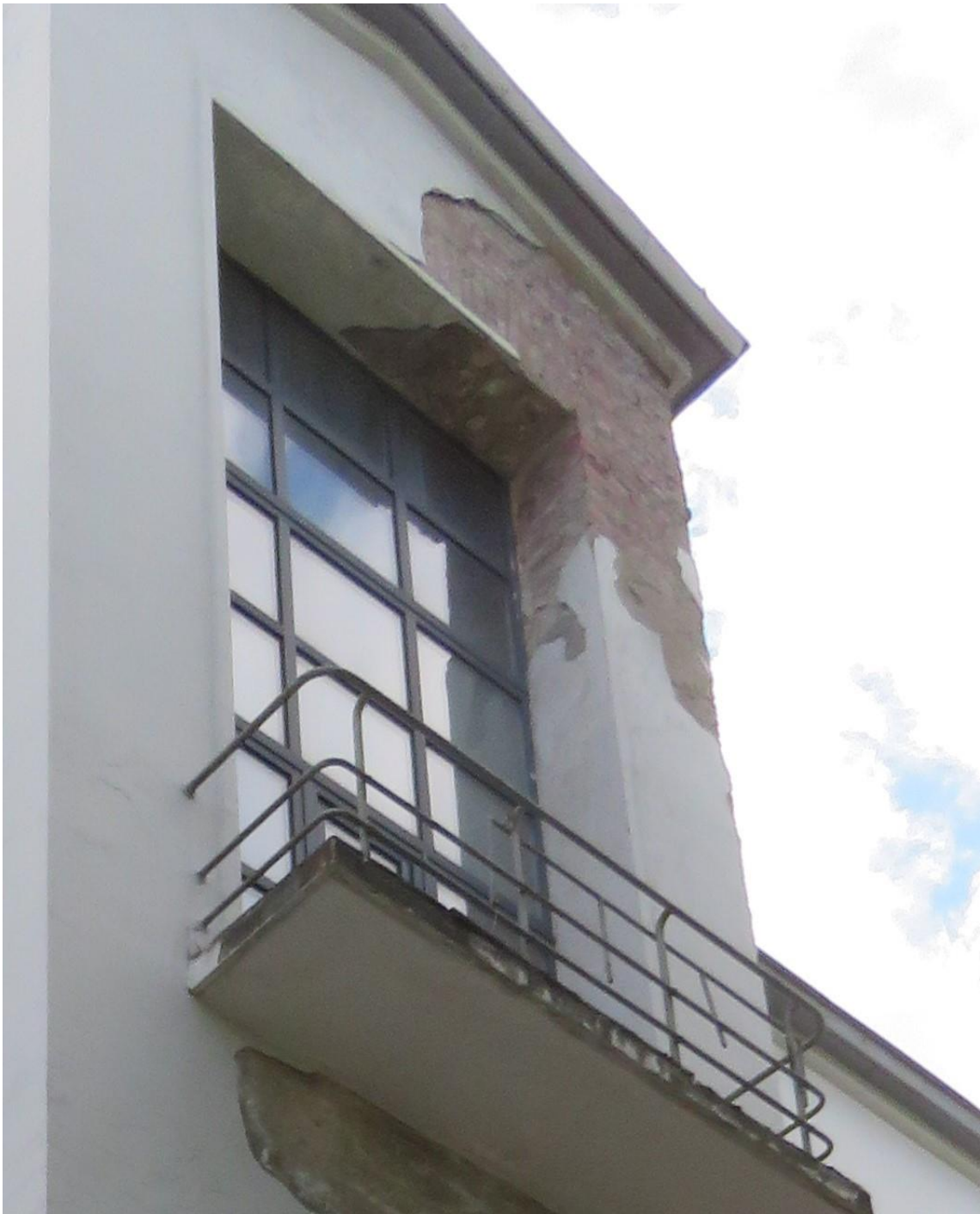
Фото 13. Проем балкона дворового ризалита. Дата съемки: 23.09.2021 г.
