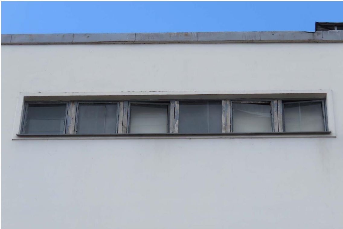
Фото 8. Проемы с ленточным остеклением уличных С-В и Ю-З фасадов. Дата съемки: 23.09.2021 г.
