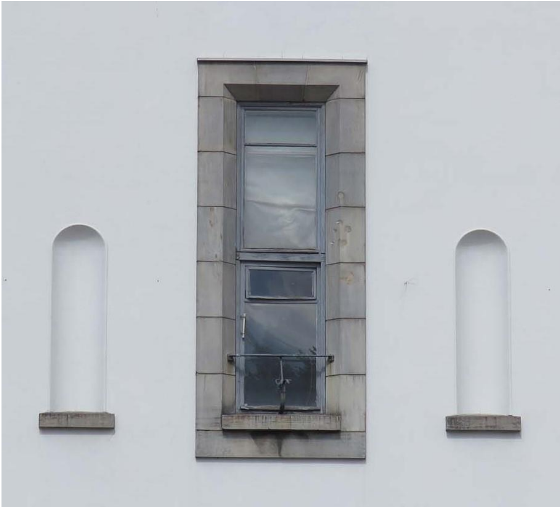
Фото 5. Оконный проем 2-го этажа лицевого Ю–В фасада. Дата съемки: 23.09.2021 г.
