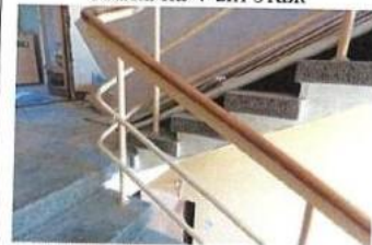
Ограждение лестницы ЛК-1
