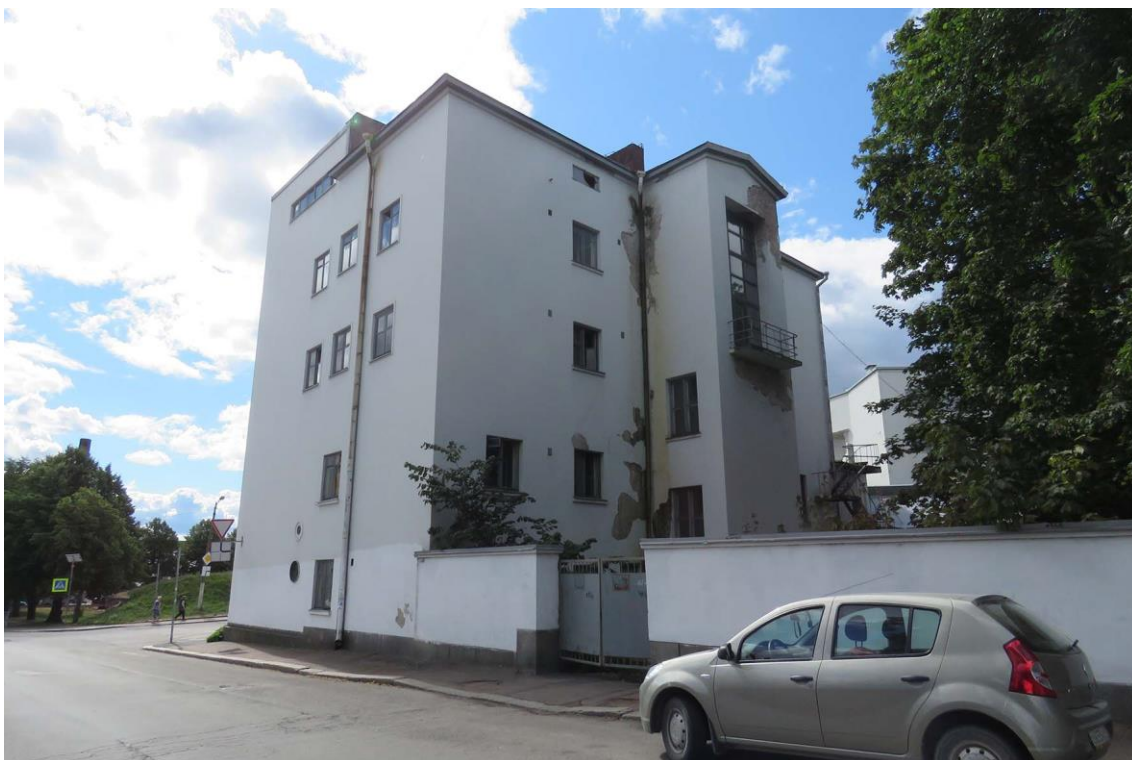
Фото 3 Общий вид здания с севера. Дата съемки: 23.09.2021 г.
