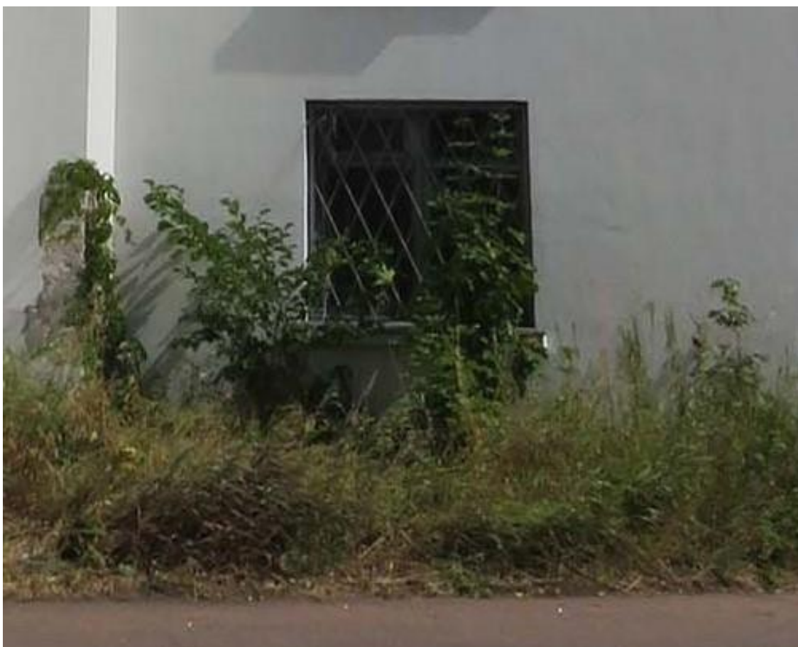
Фото 4. Оконный проем 1-го этажа уличных фасадов. Дата съемки: 23.09.2021 г.
