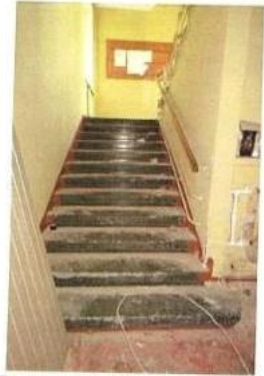
Лестница ЛК-1. Марш 1-го этажа
