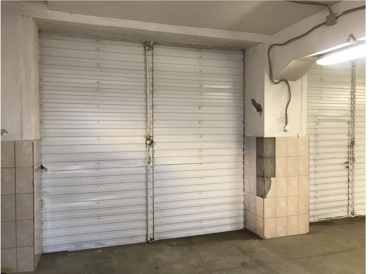
Фото 16. Помещение 1 этажа (в соответствии с планом ПИБ 2017 г. – помещение II, 1)
