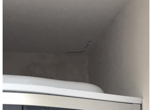
Фото 23, 24. Помещение душевой. Следы протечек на стене. 2 этаж.
