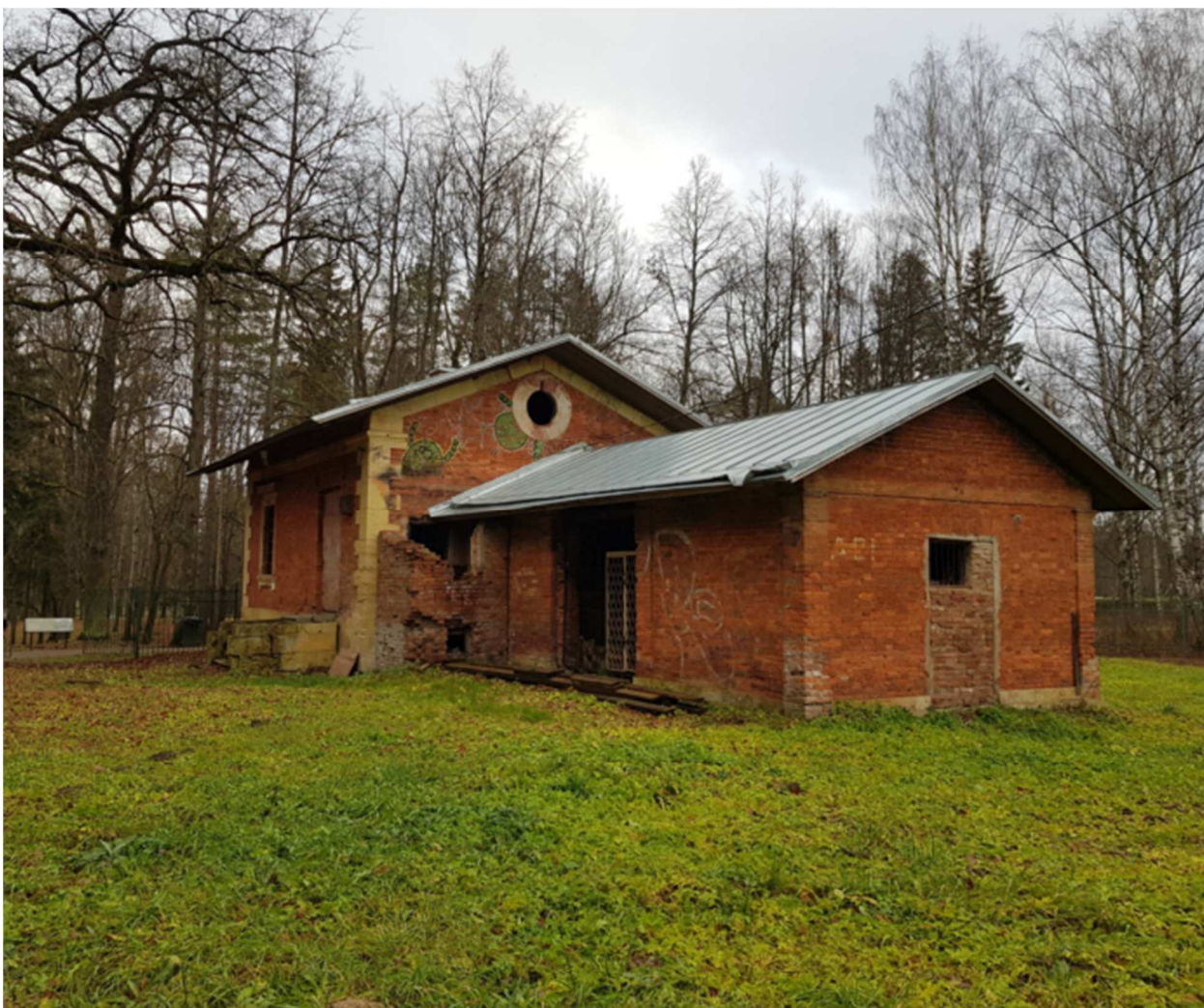
6. Общий вид объекта с юго-запада.
