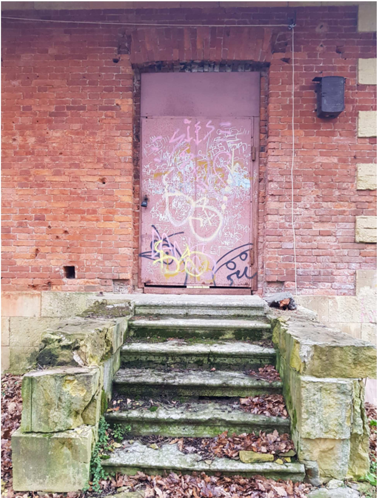
5. Фрагмент северо-западного фасада объекта. Вход с крыльцом.
