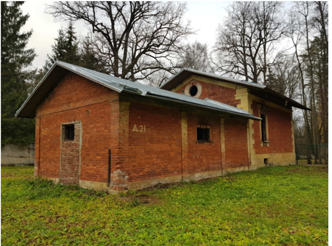
9. Общий вид юго-западного торцевого и юго-восточного фасада.
