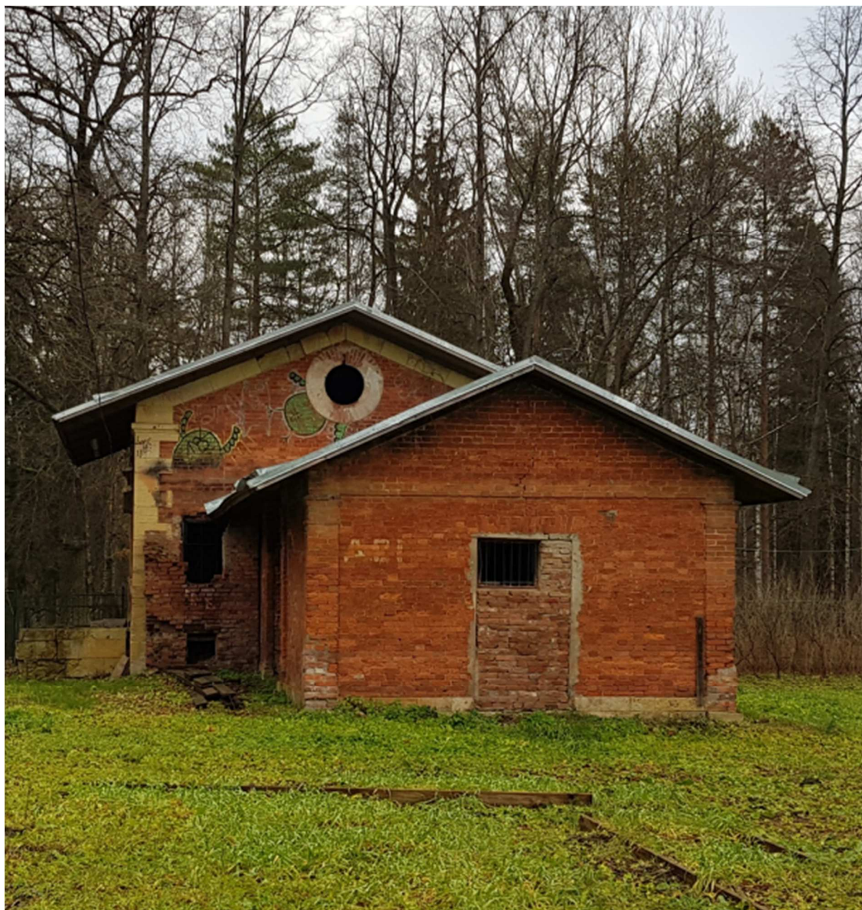
7. Общий вид на объект с юга. Юго-западный торцевой фасад.
