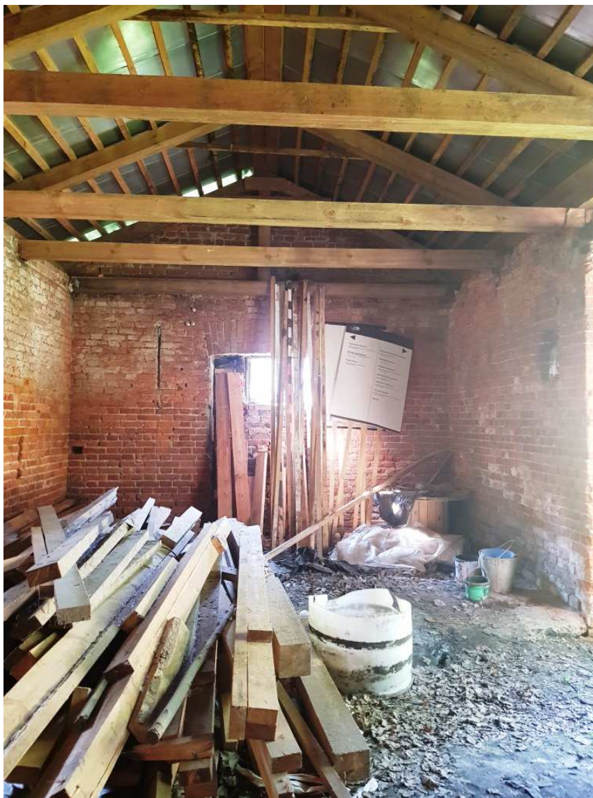
15. Южная часть помещения служебной пристройки.
