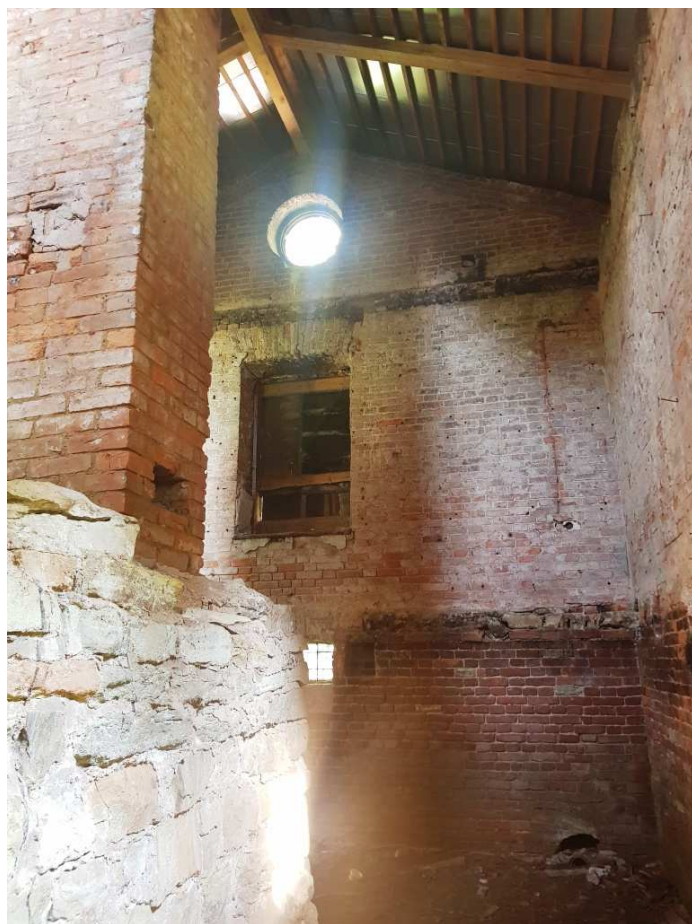
12. Основное помещение караулки. Вид северо-восточной торцевой стены.
