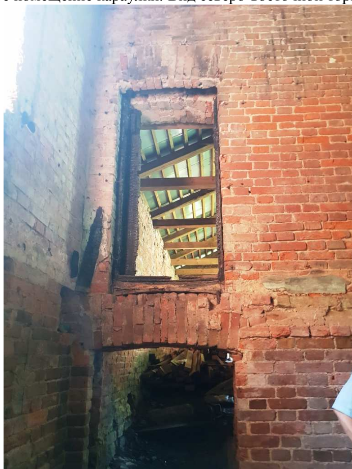
13. Основное помещение караулки. Вид проемов в юго-западной торцевой стене.
