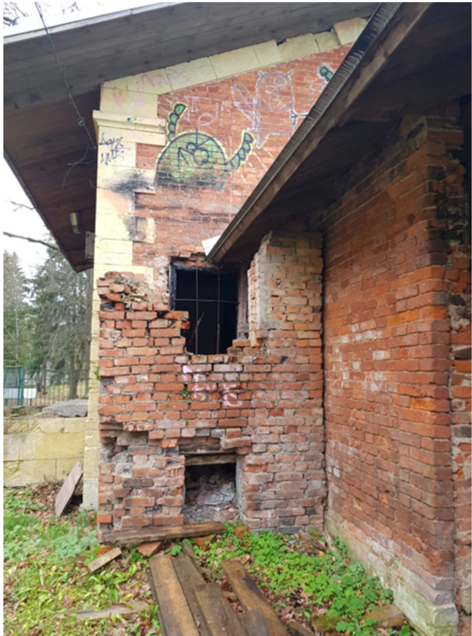
8. Современная пристройка к северо-западному фасаду.
