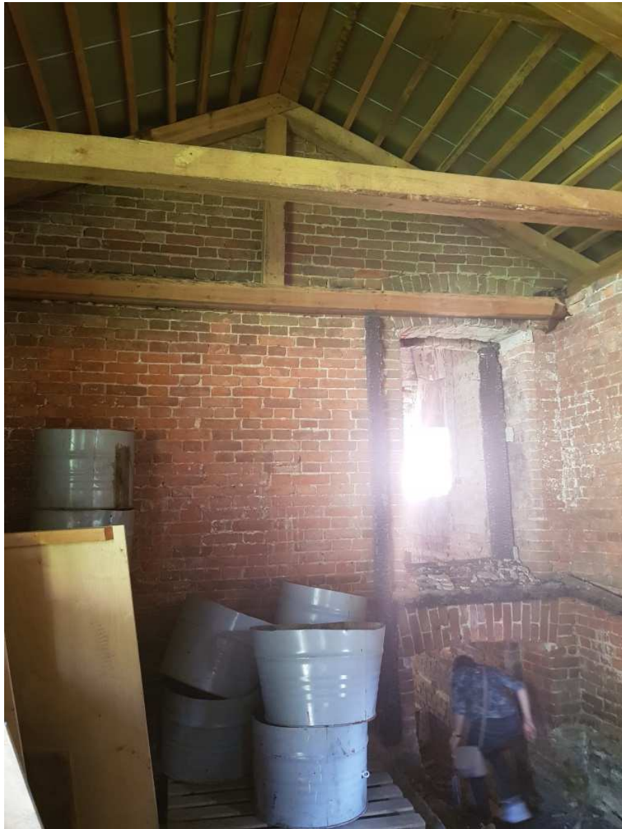
14. Помещение служебной пристройки. Вид проемов в торцевой стене.
