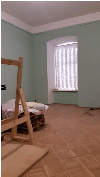
6. «Гатчинский дворец (с Арсенальным и Кухонным каре)», Ленинградская область, Гатчинский муниципальный район, г. Гатчина, Красноармейский пр., д. 1. Центральный корпус. Помещение №4. Общий вид. Фото 29.11.2021г.
