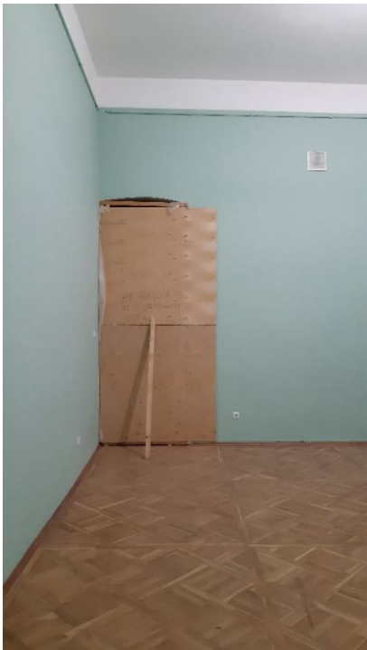
12. «Гатчинский дворец (с Арсенальным и Кухонным каре)», Ленинградская область, Гатчинский муниципальный район, г. Гатчина, Красноармейский пр., д. 1. Центральный корпус. Помещение №3. Общий вид. Фото 29.11.2021г.
