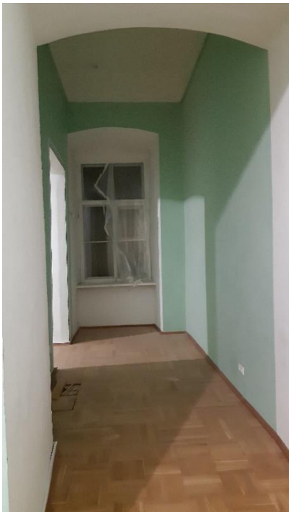
16. «Гатчинский дворец (с Арсенальным и Кухонным каре)», Ленинградская область, Гатчинский муниципальный район, г. Гатчина, Красноармейский пр., д. 1. Центральный корпус. Помещение №6. Общий вид. Фото 29.11.2021г.
