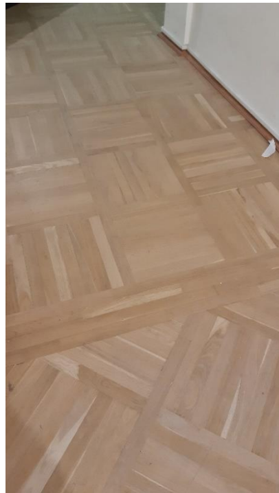
26. «Гатчинский дворец (с Арсенальным и Кухонным каре)», Ленинградская область, Гатчинский муниципальный район, г. Гатчина, Красноармейский пр., д. 1. Центральный корпус. Помещение №1. Фрагмент. Фото 29.11.2021г.
