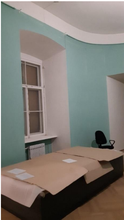
8. «Гатчинский дворец (с Арсенальным и Кухонным каре)», Ленинградская область, Гатчинский муниципальный район, г. Гатчина, Красноармейский пр., д. 1. Центральный корпус. Помещение №2. Общий вид. Фото 29.11.2021г.
