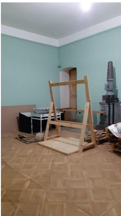
3. «Гатчинский дворец (с Арсенальным и Кухонным каре)», Ленинградская область, Гатчинский муниципальный район, г. Гатчина, Красноармейский пр., д. 1. Центральный корпус. Помещение №4. Общий вид. Фото 29.11.2021г.
