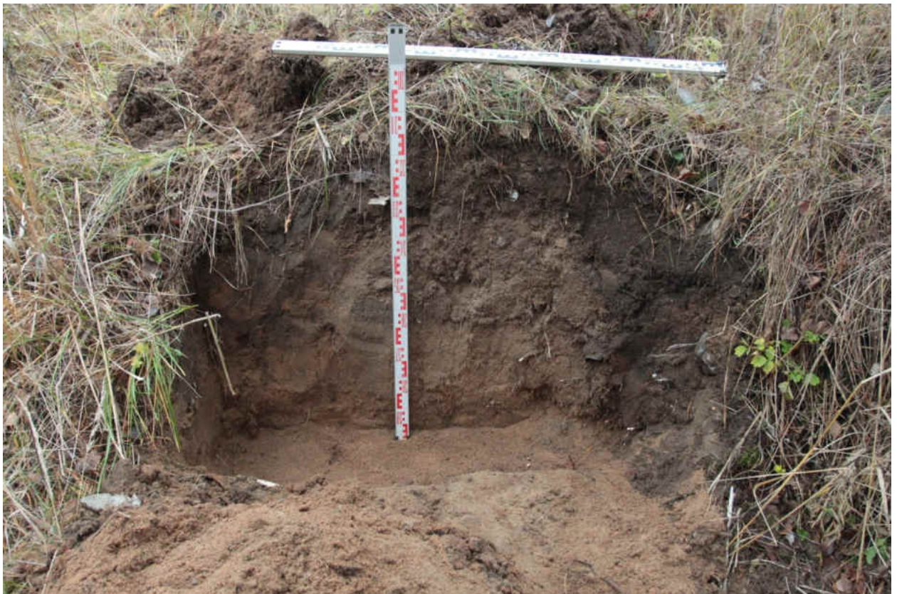
Рис. 241. «Распределительный газопровод по г.п. Свирьстрой Лодейнопольского района Ленинградской обл.» Шурф 39. Северная стенка. Вид на север.
