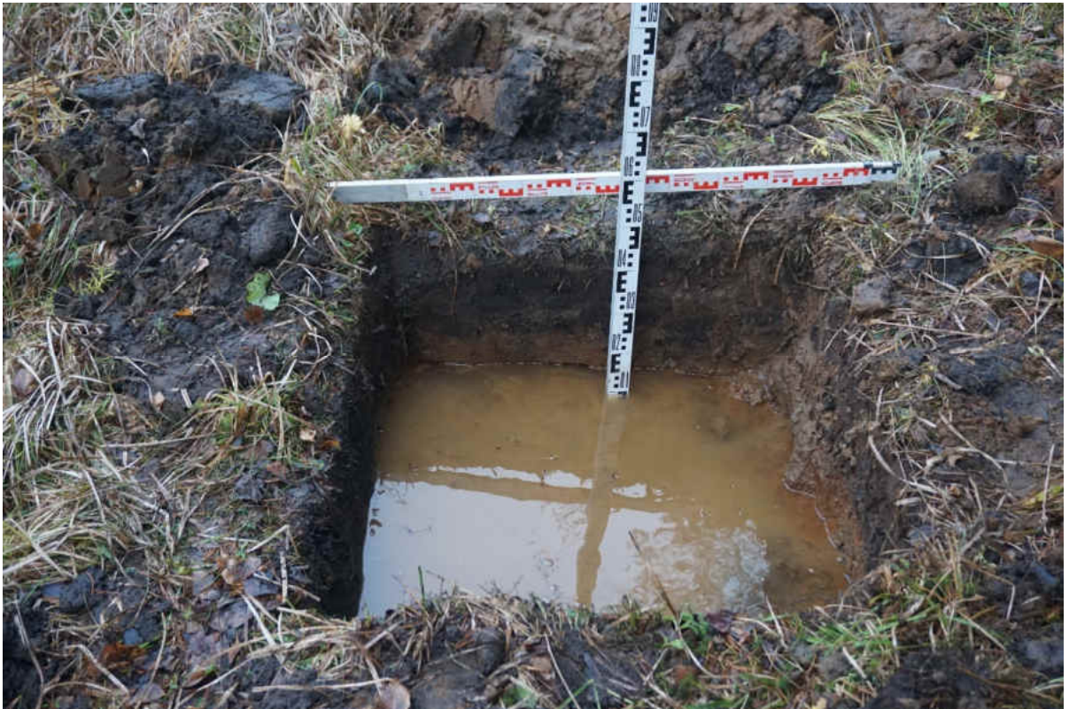
Рис. 274. «Распределительный газопровод по г.п. Свирьстрой Лодейнопольского района Ленинградской обл.» Шурф 46. Общий вид. Вид на север.
