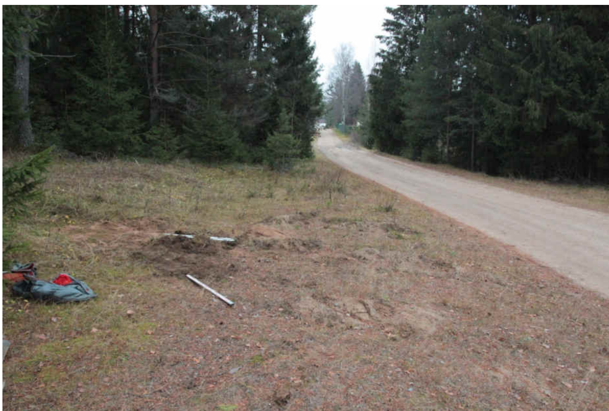
Рис. 247. «Распределительный газопровод по г.п. Свирьстрой Лодейнопольского района Ленинградской обл.» Шурф 40. Рекультивация. Вид на север.
