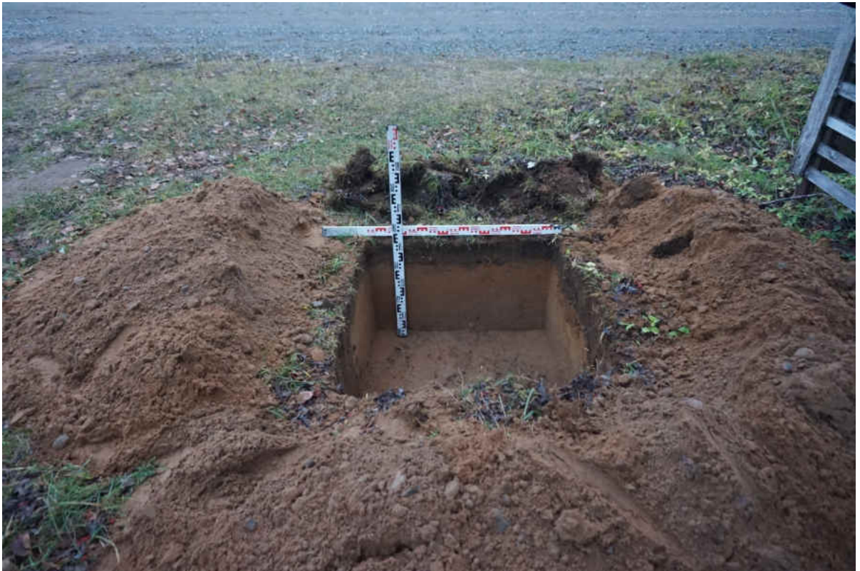
Рис. 288. «Распределительный газопровод по г.п. Свирьстрой Лодейнопольского района Ленинградской обл.» Шурф 49. Общий вид. Вид на север.
