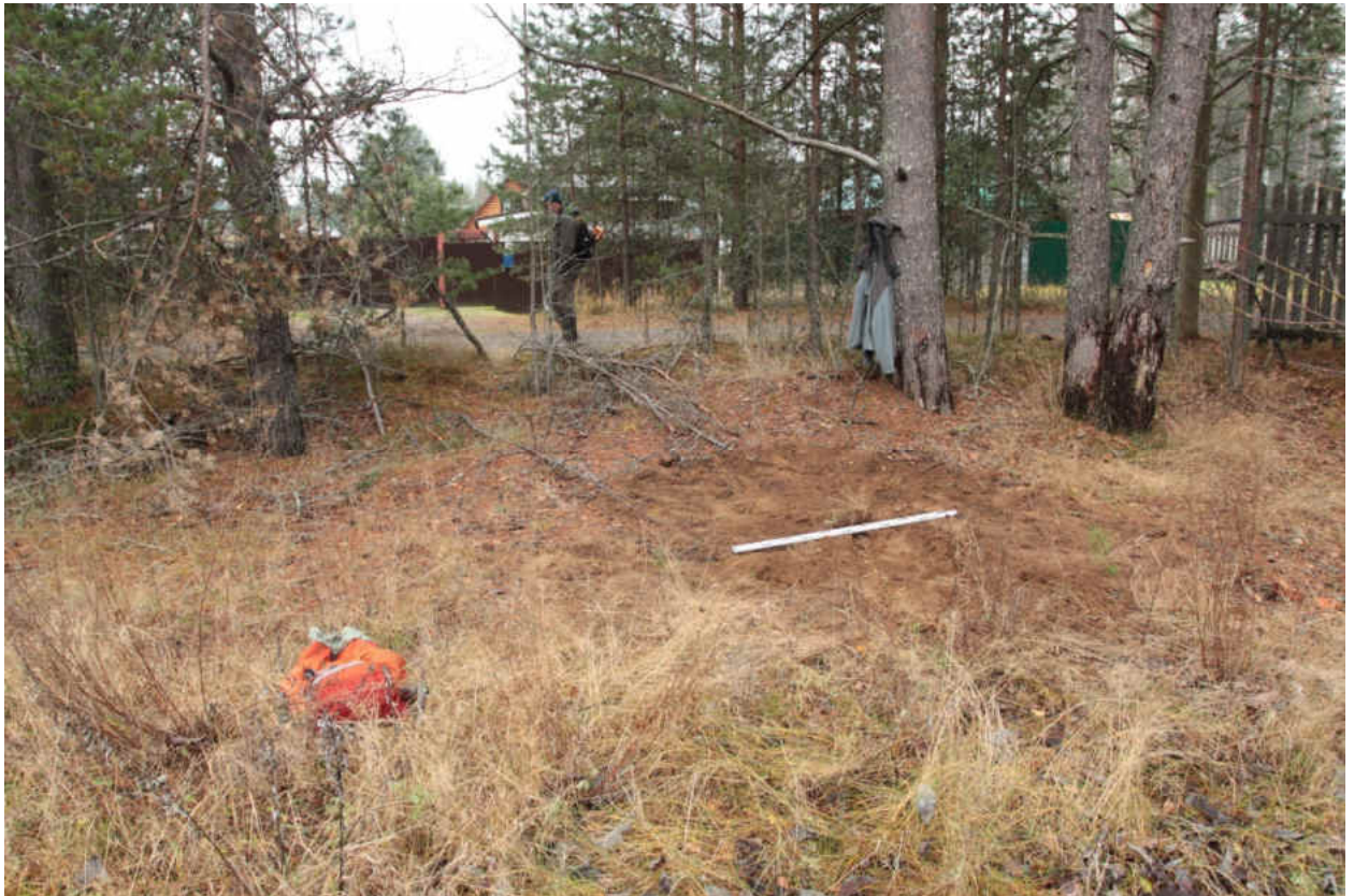
Рис. 182. «Распределительный газопровод по г.п. Свирьстрой Лодейнопольского района Ленинградской обл.» Шурф 27. Рекультивация. Вид на восток.
