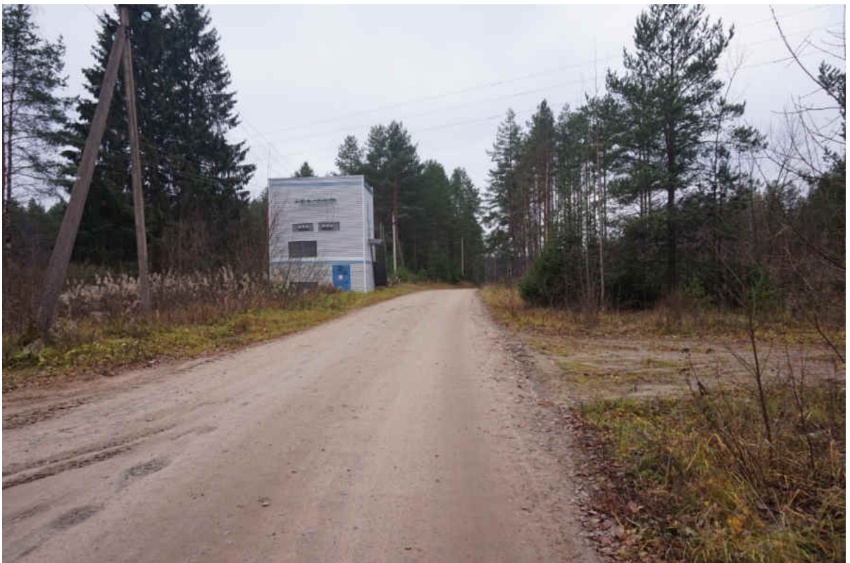
Рис. 18. Ленинградская обл., Лодейнопольский р-н. «Распределительный газопровод по г.п. Свирьстрой». Южный участок обследования, ул. Клинцовая Кара на участке площадки второй террасы, вид на юг
