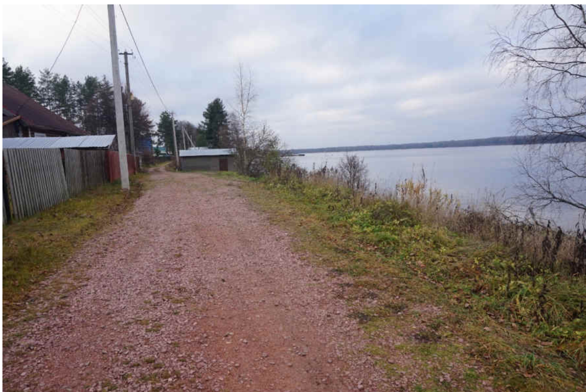
Рис. 36. Ленинградская обл., Лодейнопольский р-н. «Распределительный газопровод по г.п. Свирьстрой». Северный участок обследования, ул. Набережная, берег р. Свирь, вид на юго-запад
