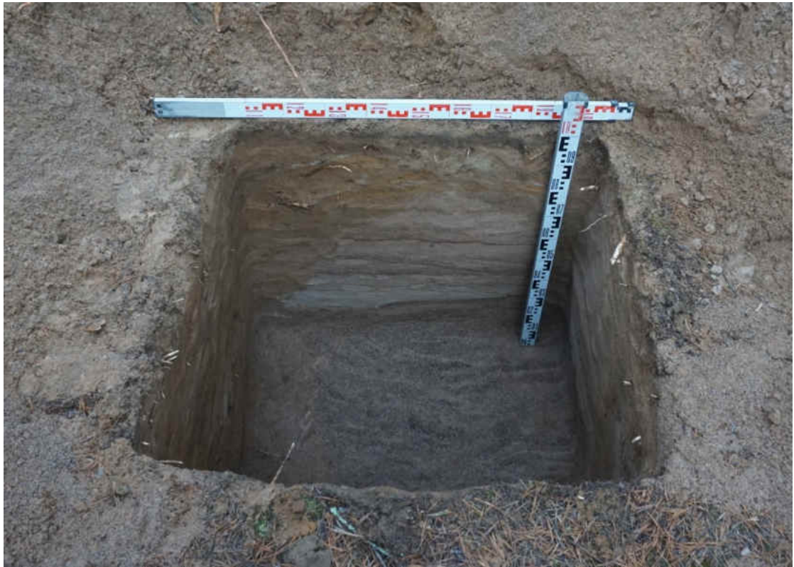
Рис. 170. «Распределительный газопровод по г.п. Свирьстрой Лодейнопольского района Ленинградской обл.» Шурф 25. Материковая поверхность. Вид на север.
