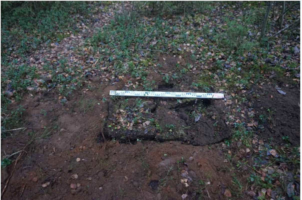
Рис. 286. «Распределительный газопровод по г.п. Свирьстрой Лодейнопольского района Ленинградской обл.» Шурф 48. Рекультивация. Вид на запад.
