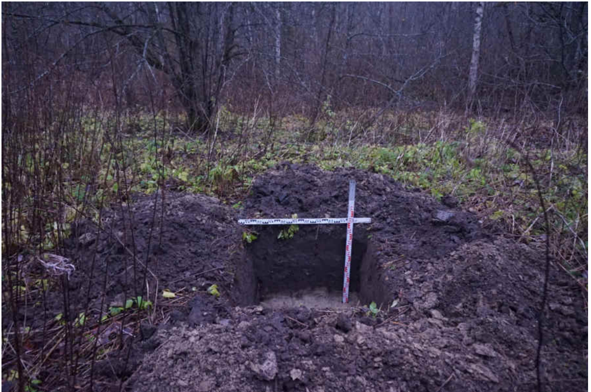
Рис. 101. «Распределительный газопровод по г.п. Свирьстрой Лодейнопольского района Ленинградской обл.» Шурф 12. Общий вид. Вид на запад.
