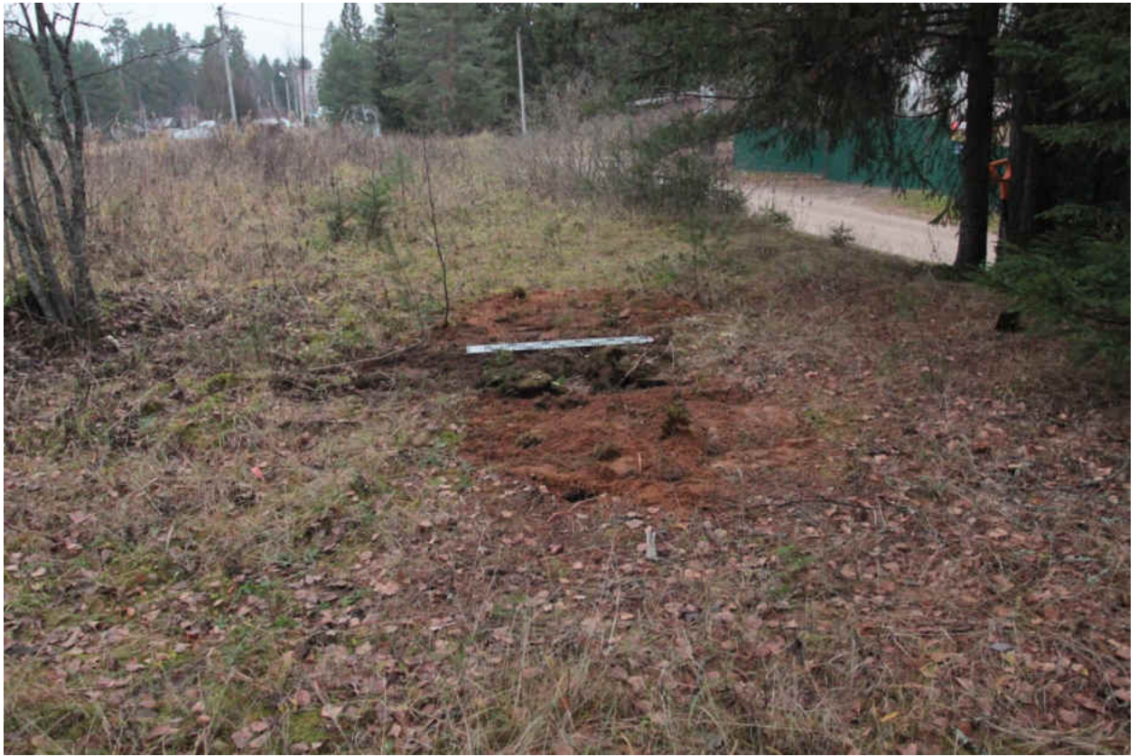
Рис. 238. «Распределительный газопровод по г.п. Свирьстрой Лодейнопольского района Ленинградской обл.» Шурф 38. Рекультивация. Вид на север.
