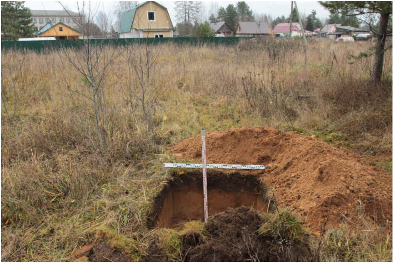
Рис. 174. «Распределительный газопровод по г.п. Свирьстрой Лодейнопольского района Ленинградской обл.» Шурф 26. Общий вид. Вид на восток.
