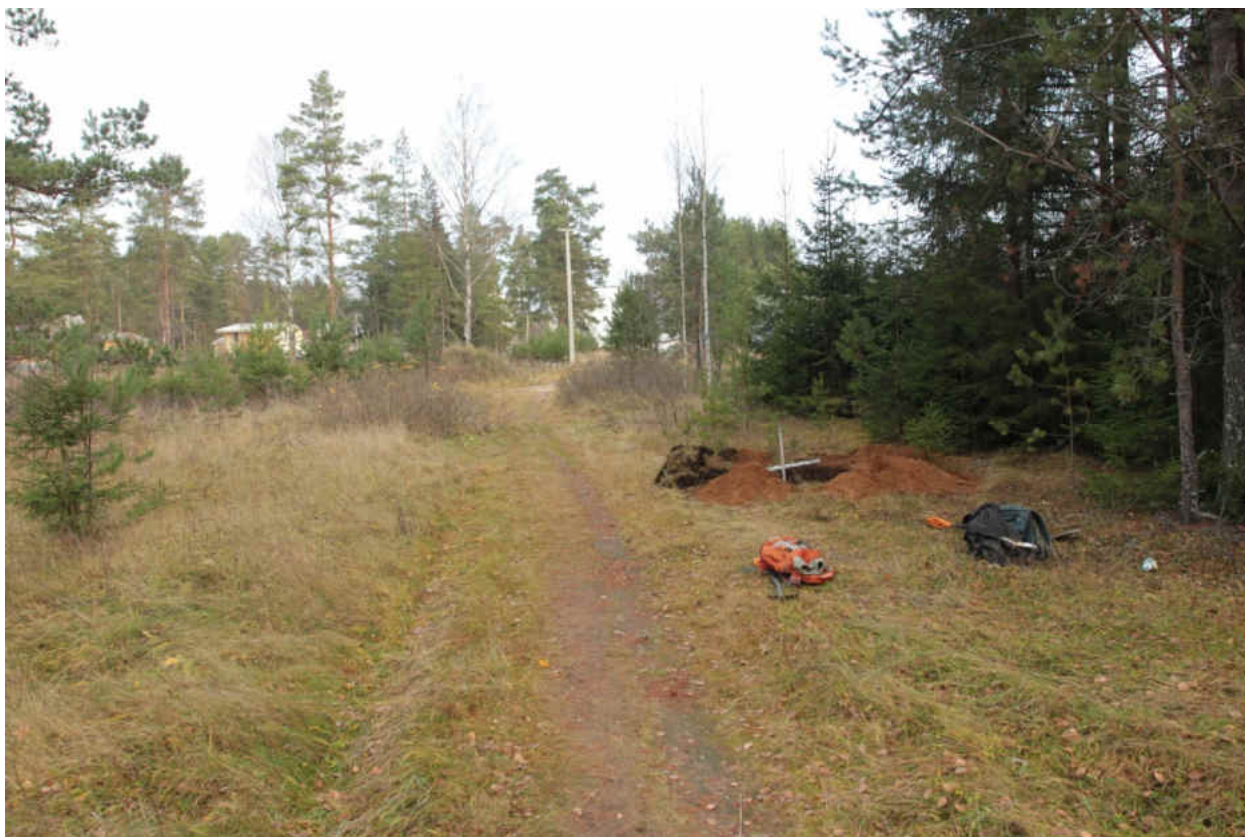
Рис. 253. «Распределительный газопровод по г.п. Свирьстрой Лодейнопольского района Ленинградской обл.» Шурф 42. Общий вид. Вид на север.
