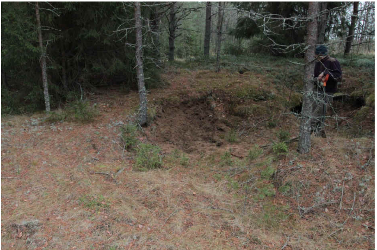
Рис. 251. «Распределительный газопровод по г.п. Свирьстрой Лодейнопольского района Ленинградской обл.» Шурф 41. Рекультивация. Вид на восток.
