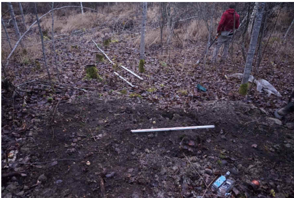
Рис. 94. «Распределительный газопровод по г.п. Свирьстрой Лодейнопольского района Ленинградской обл.» Шурф 10. Рекультивация. Вид на запад.
