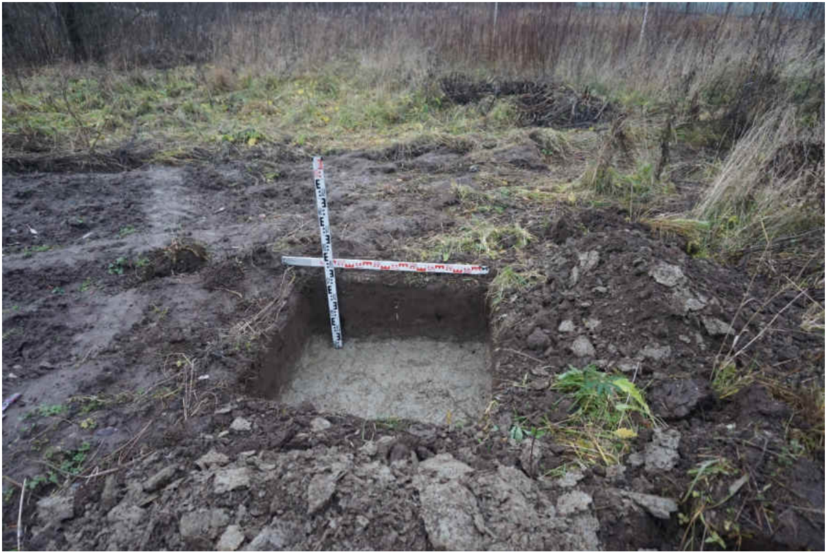
Рис. 71. «Распределительный газопровод по г.п. Свирьстрой Лодейнопольского района Ленинградской обл.» Шурф 6. Общий вид. Вид на запад.
