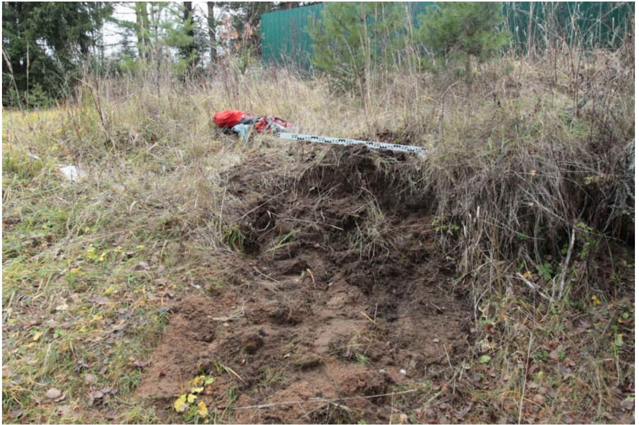
Рис. 242. «Распределительный газопровод по г.п. Свирьстрой Лодейнопольского района Ленинградской обл.» Шурф 39. Рекультивация. Вид на север.
