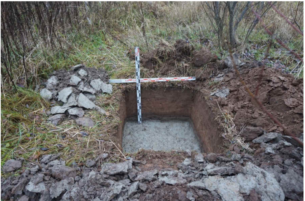
Рис. 128. «Распределительный газопровод по г.п. Свирьстрой Лодейнопольского района Ленинградской обл.» Шурф 17. Общий вид. Вид на запад.
