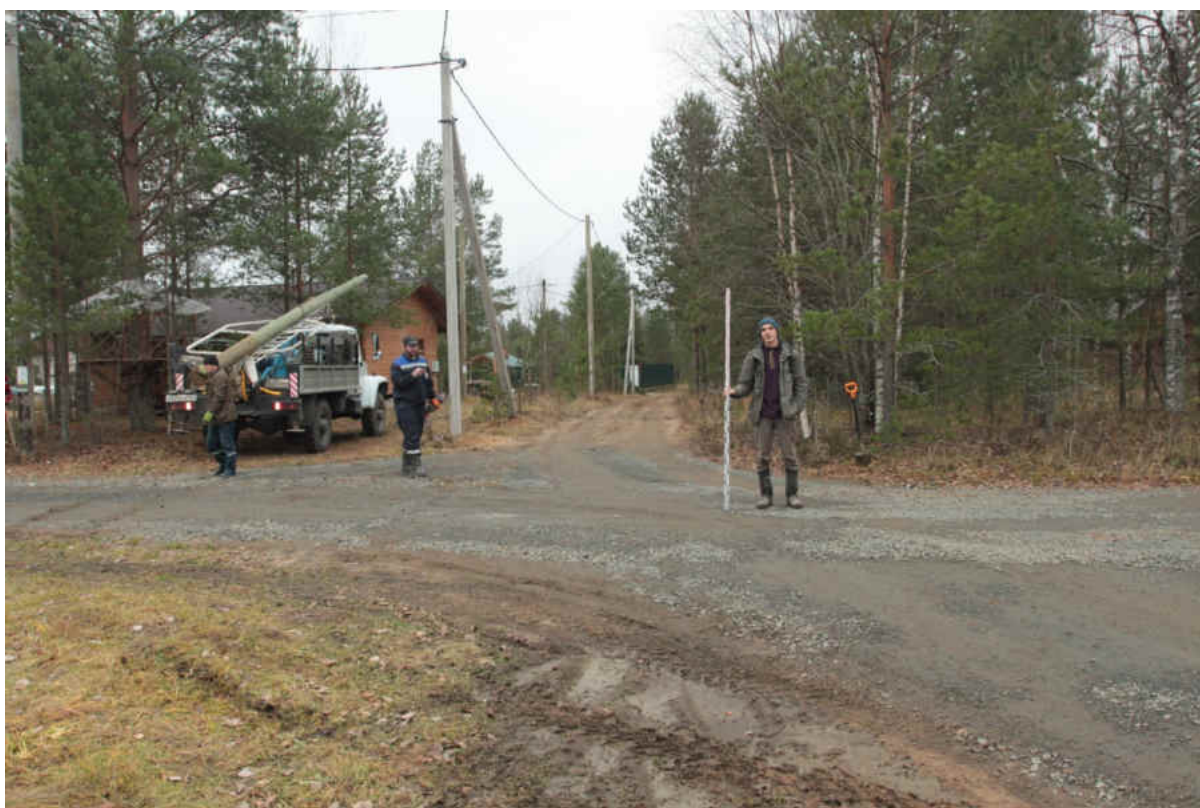
Рис. 22. Ленинградская обл., Лодейнополюский р-н. «Распределительный газопровод по г.п. Свирьстрой». Центральный участок обследования, перекресток ул. Дачной и Сосновой, вид на запад
