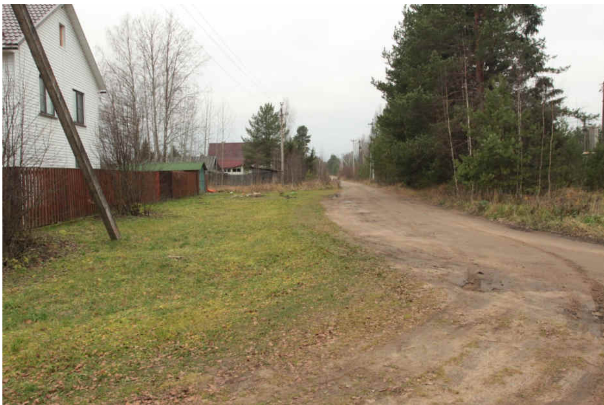
Рис. 26. Ленинградская обл., Лодейнопольский р-н. «Распределительный газопровод по г.п. Свирьстрой». Центральный участок обследования, ул. Коллективная, вид на север
