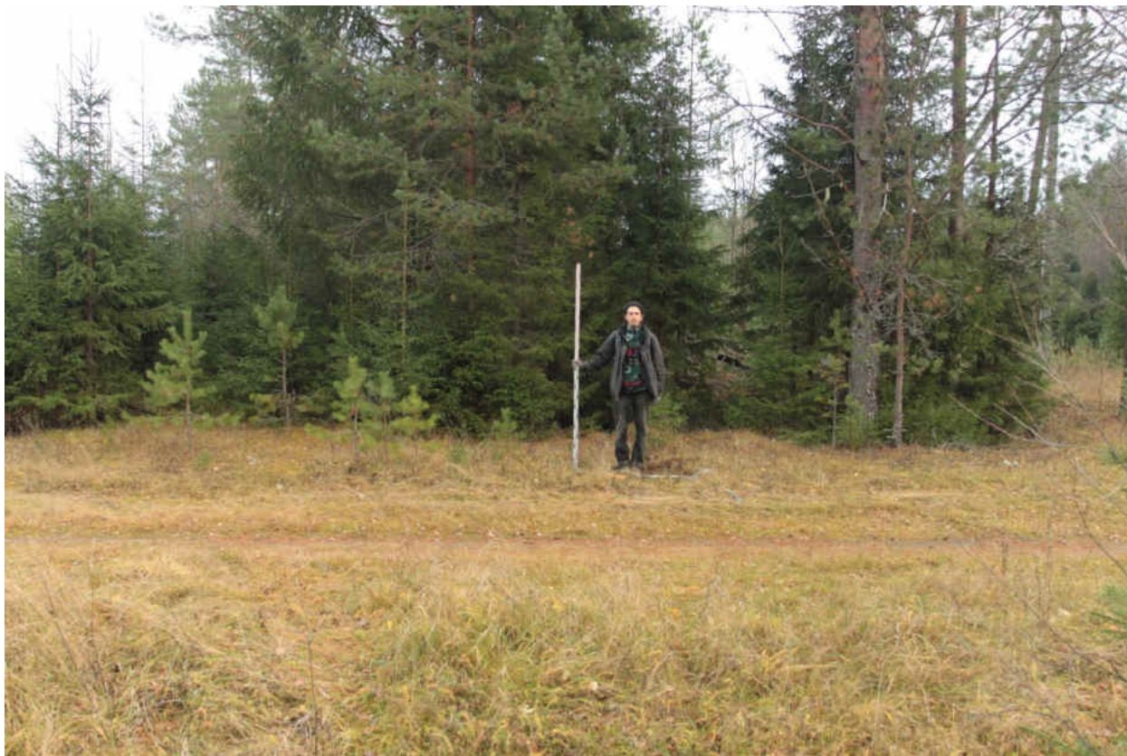
Рис. 252. «Распределительный газопровод по г.п. Свирьстрой Лодейнопольского района Ленинградской обл.» Шурф 42. Общий вид до начала работ. Вид на восток.
