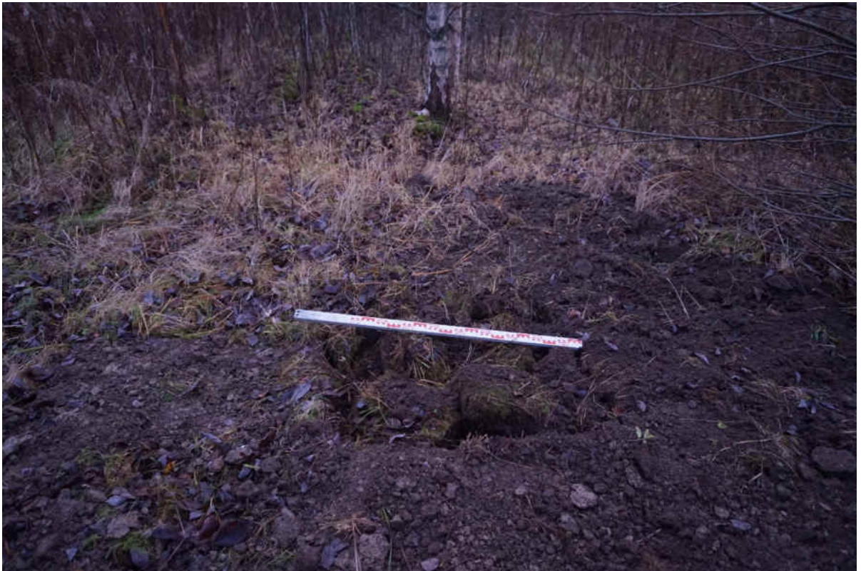
Рис. 99. «Распределительный газопровод по г.п. Свирьстрой Лодейнопольского района Ленинградской обл.» Шурф 11. Рекультивация. Вид на запад.
