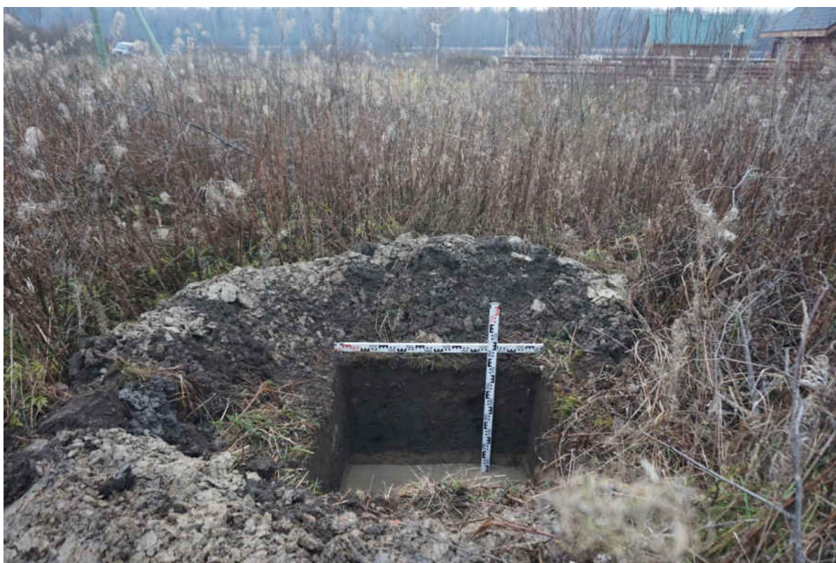
Рис. 46. «Распределительный газопровод по г.п. Свирьстрой Лодейнопольского района Ленинградской обл.» Шурф 1. Общий вид. Вид на запад.
