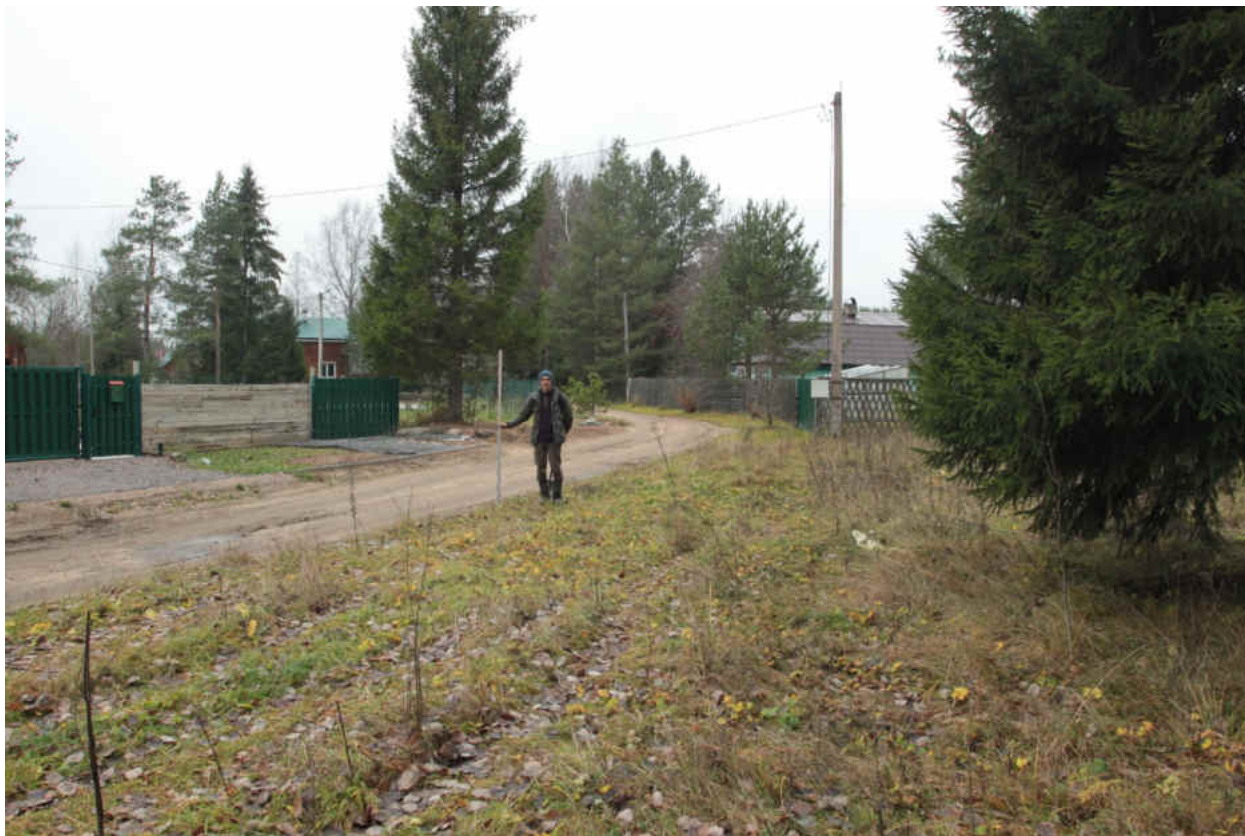
Рис. 27. Ленинградская обл., Лодейнополюский р-н. «Распределительный газопровод по г.п. Свирьстрой». Центральный участок обследования, ул. Лесная, , вид на север
