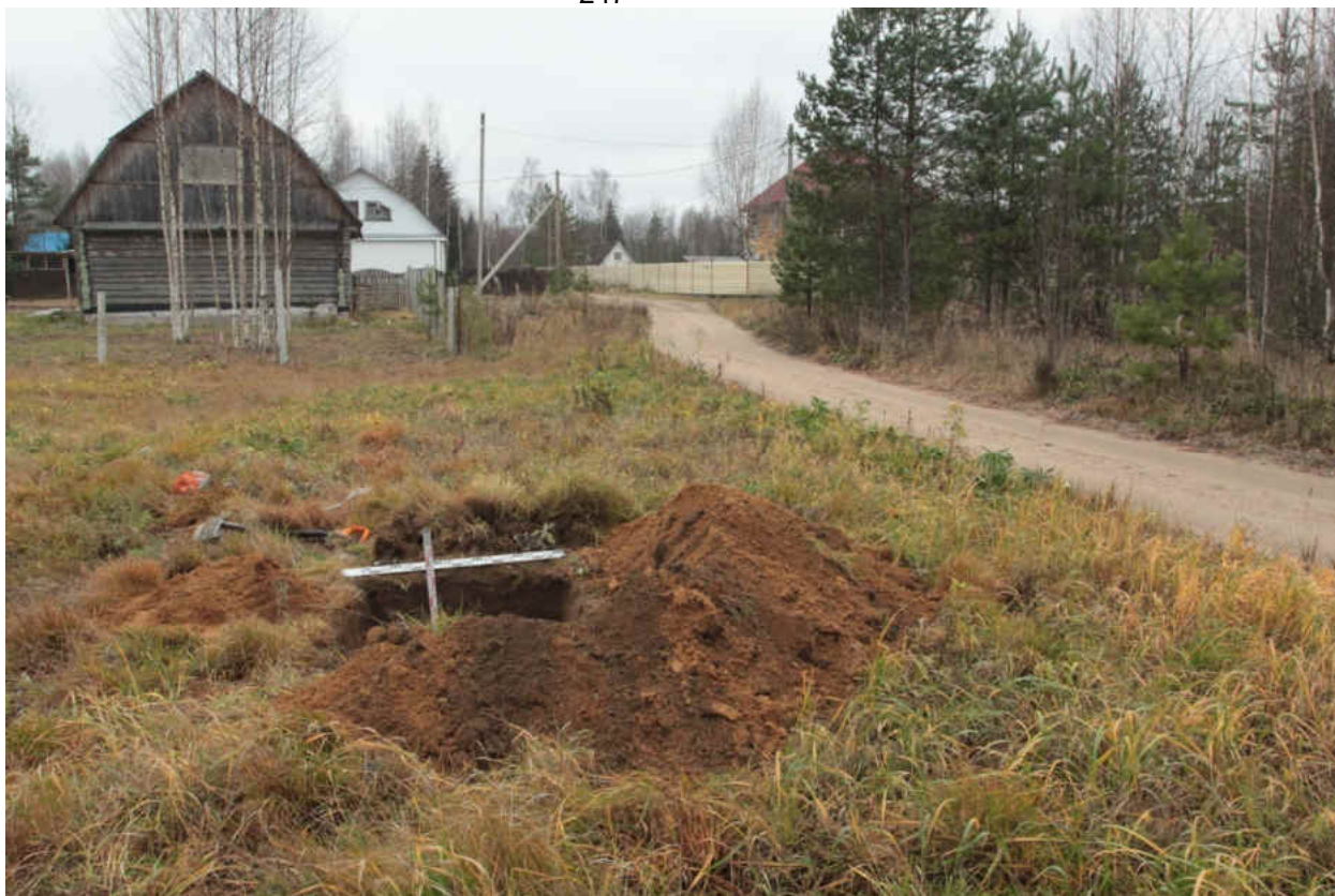
Рис. 200. «Распределительный газопровод по г.п. Свирьстрой Лодейнопольского района Ленинградской обл.» Шурф 31. Общий вид. Вид на запад.
