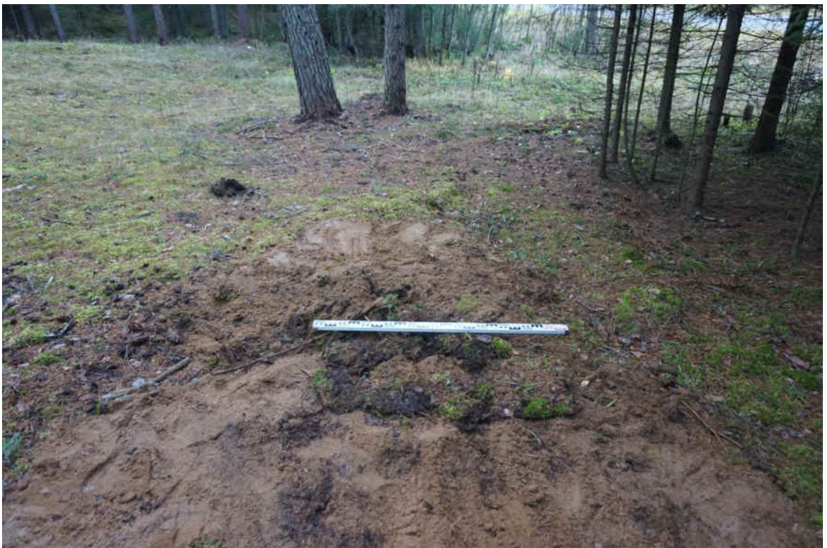
Рис. 271. «Распределительный газопровод по г.п. Свирьстрой Лодейнопольского района Ленинградской обл.» Шурф 45. Рекультивация. Вид на запад.
