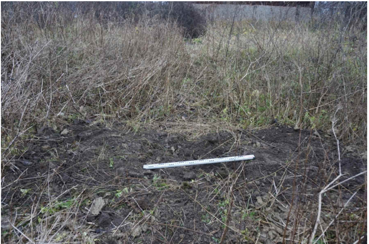
Рис. 136. «Распределительный газопровод по г.п. Свирьстрой Лодейнопольского района Ленинградской обл.» Шурф 18. Рекультивация. Вид на запад.
