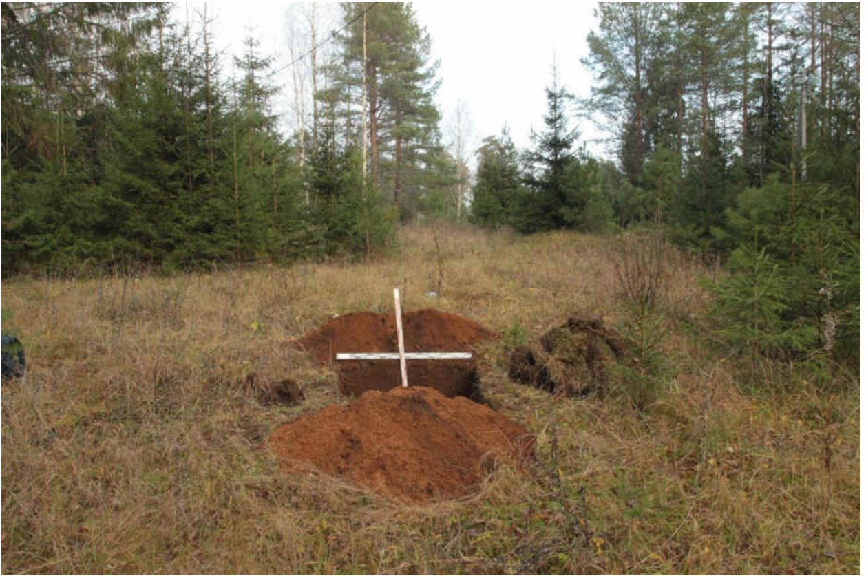
Рис. 258. «Распределительный газопровод по г.п. Свирьстрой Лодейнопольского района Ленинградской обл.» Шурф 43. Общий вид. Вид на север.
