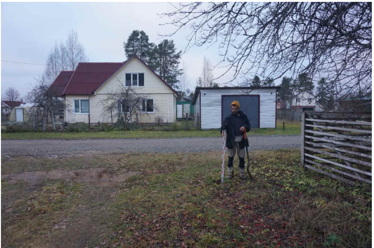
Рис. 287. «Распределительный газопровод по г.п. Свирьстрой Лодейнопольского района Ленинградской обл.» Шурф 49. Общий вид до начала работ. Вид на север.
