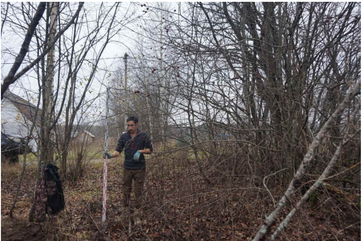
Рис. 122. «Распределительный газопровод по г.п. Свирьстрой Лодейнопольского района Ленинградской обл.» Шурф 16. Общий вид до начала работ. Вид на запад.
