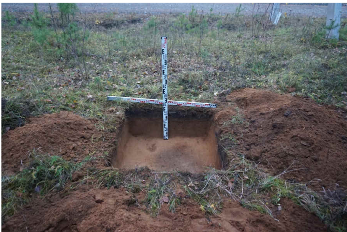
Рис. 293. «Распределительный газопровод по г.п. Свирьстрой Лодейнопольского района Ленинградской обл.» Шурф 50. Общий вид с зачисткой по слою желтого песка и невыбранным пятном серо-коричневого песка. Вид на север.
