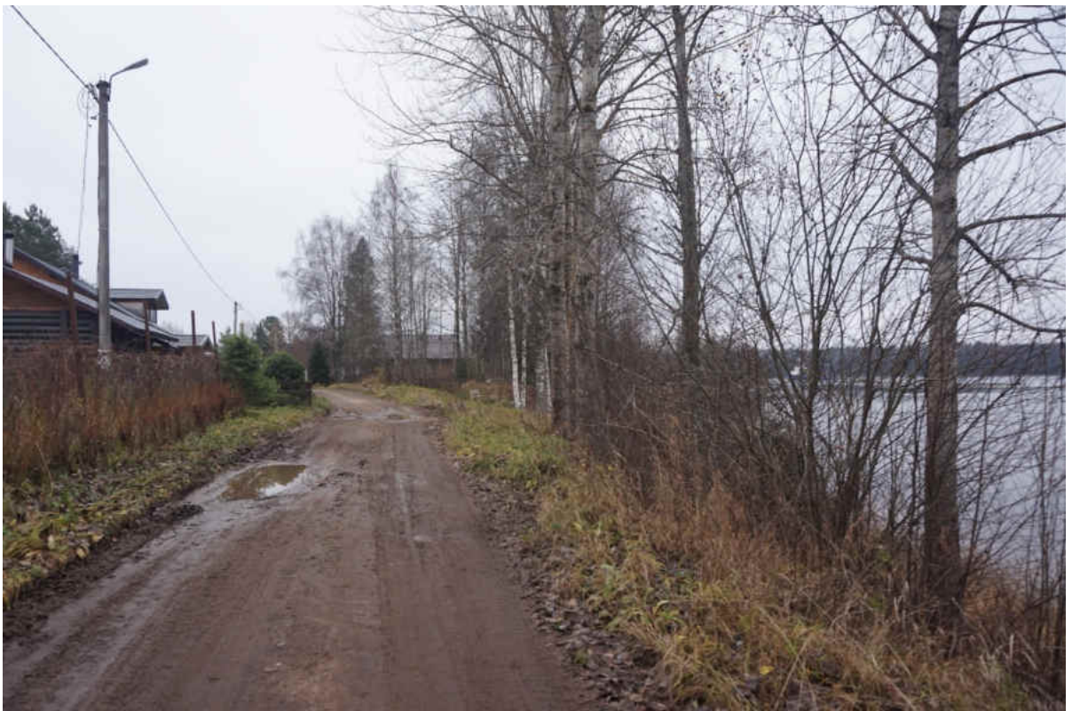
Рис. 14. Ленинградская обл., Лодейнополюский р-н. «Распределительный газопровод по г.п. Свирьстрой». Южный участок обследования, берег р. Свирь у устья р. Деда, вид на юг
