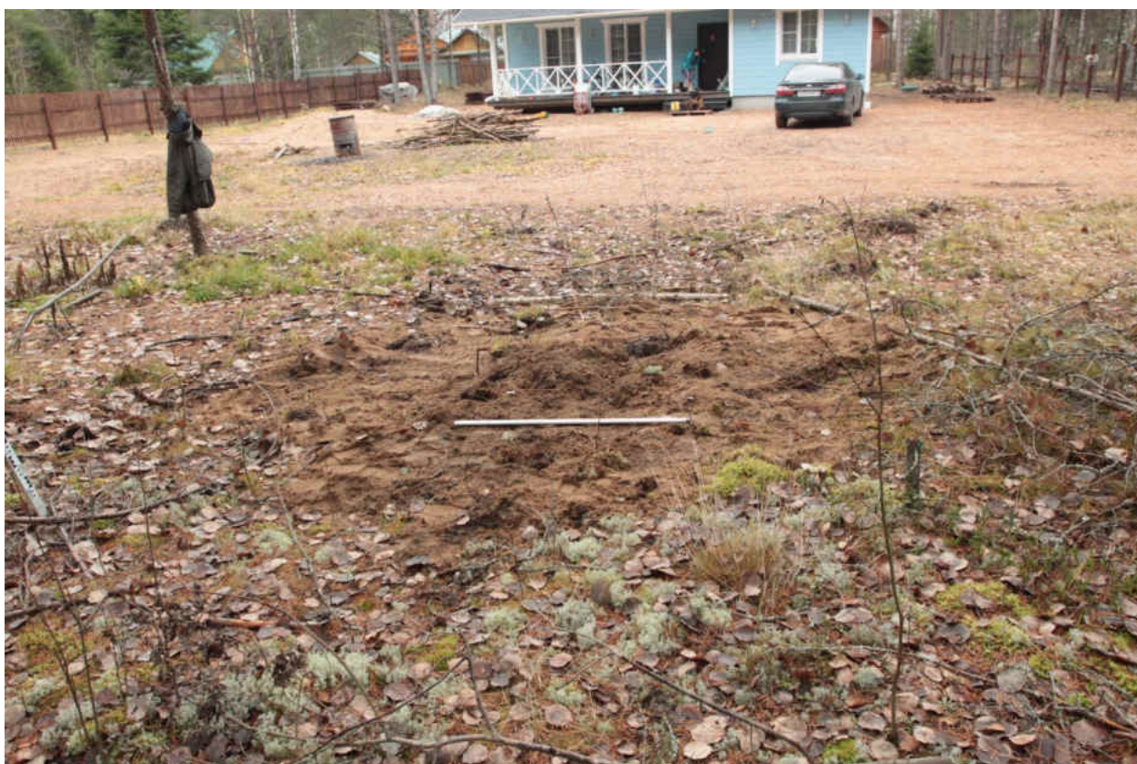
Рис. 187. «Распределительный газопровод по г.п. Свирьстрой Лодейнопольского района Ленинградской обл.» Шурф 28. Рекультивация. Вид на восток.
