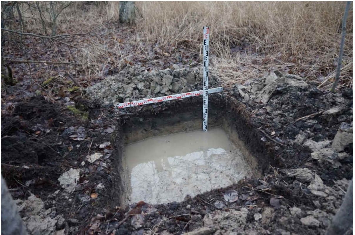
Рис. 81. «Распределительный газопровод по г.п. Свирьстрой Лодейнопольского района Ленинградской обл.» Шурф 8 Общий вид. Вид на запад.
