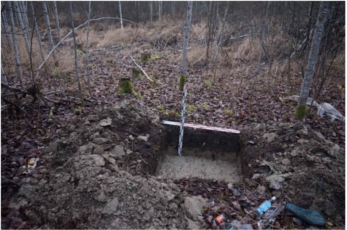
Рис. 91. «Распределительный газопровод по г.п. Свирьстрой Лодейнопольского района Ленинградской обл.» Шурф 10. Общий вид. Вид на запад.
