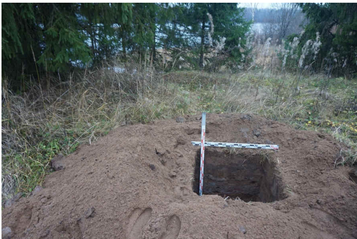
Рис. 148. «Распределительный газопровод по г.п. Свирьстрой Лодейнопольского района Ленинградской обл.» Шурф 21. Общий вид. Вид на запад.
