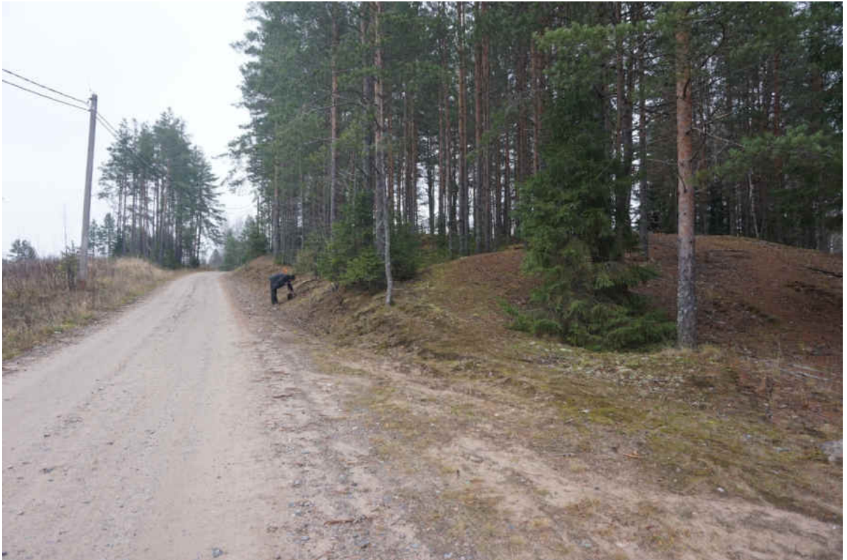
Рис. 17. Ленинградская обл., Лодейнопольский р-н. «Распределительный газопровод по г.п. Свирьстрой». Южный участок обследования, ул. Клинцовая Кара на участке склона второй террасы, вид на север
