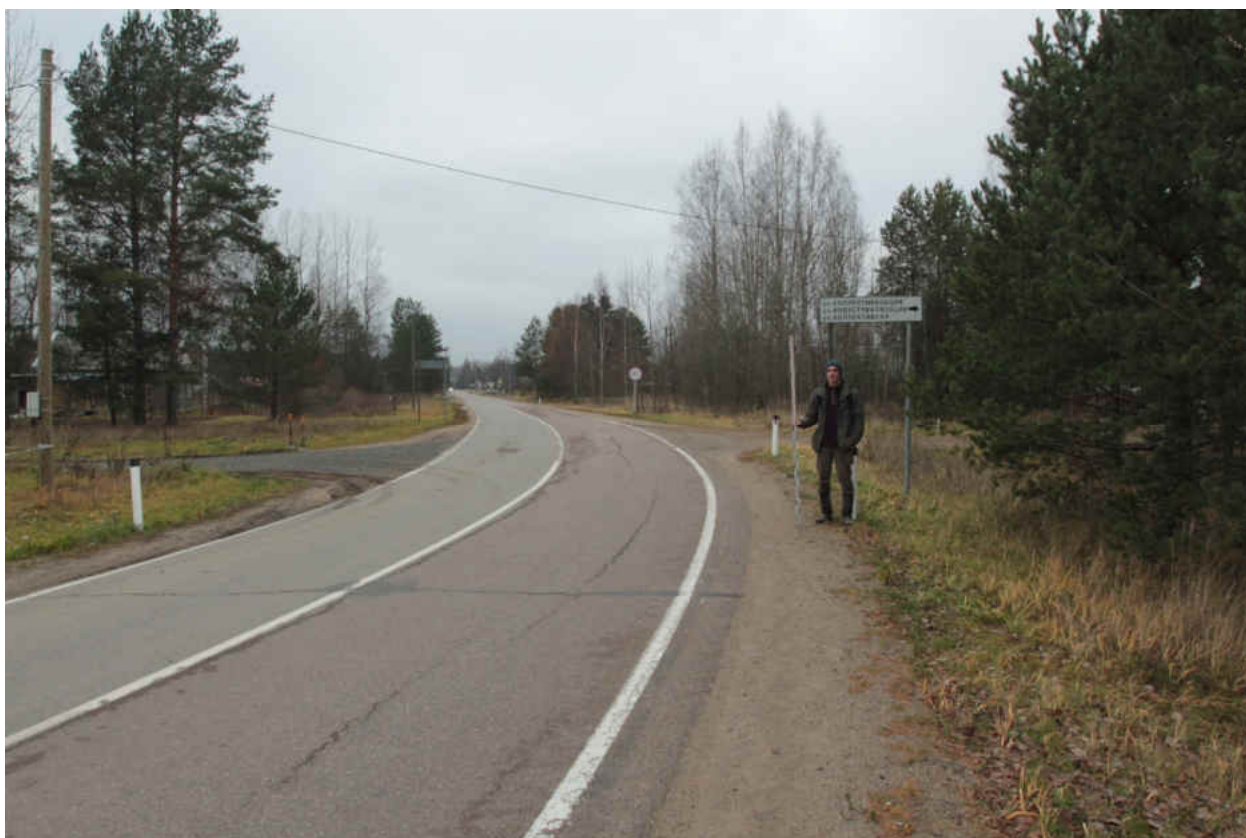
Рис. 24. Ленинградская обл., Лодейнопольский р-н. «Распределительный газопровод по г.п. Свирьстрой». Центральный участок обследования, перекресток ул. Ленина и Коллективизации, вид на север
