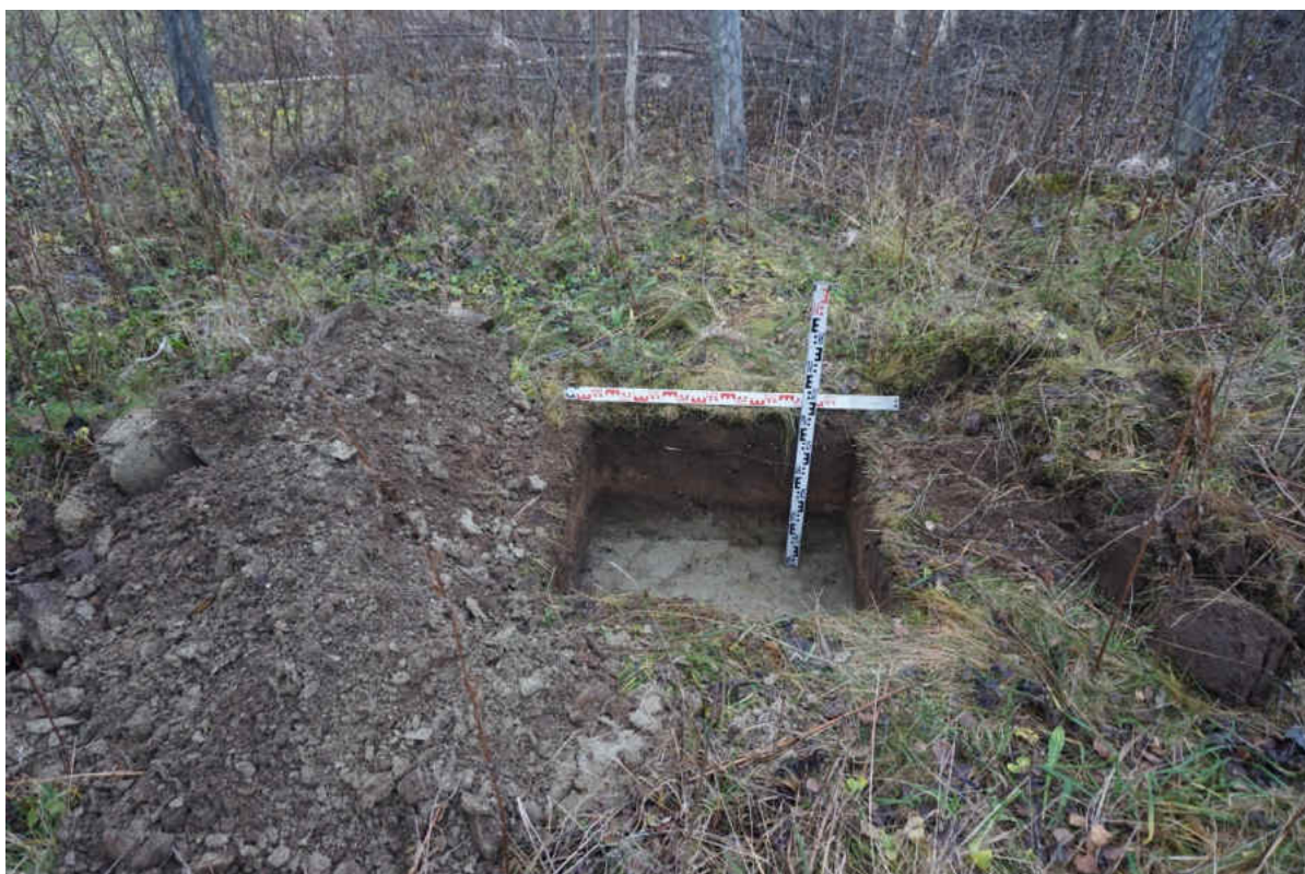
Рис. 138. «Распределительный газопровод по г.п. Свирьстрой Лодейнопольского района Ленинградской обл.» Шурф 19. Общий вид. Вид на запад.
