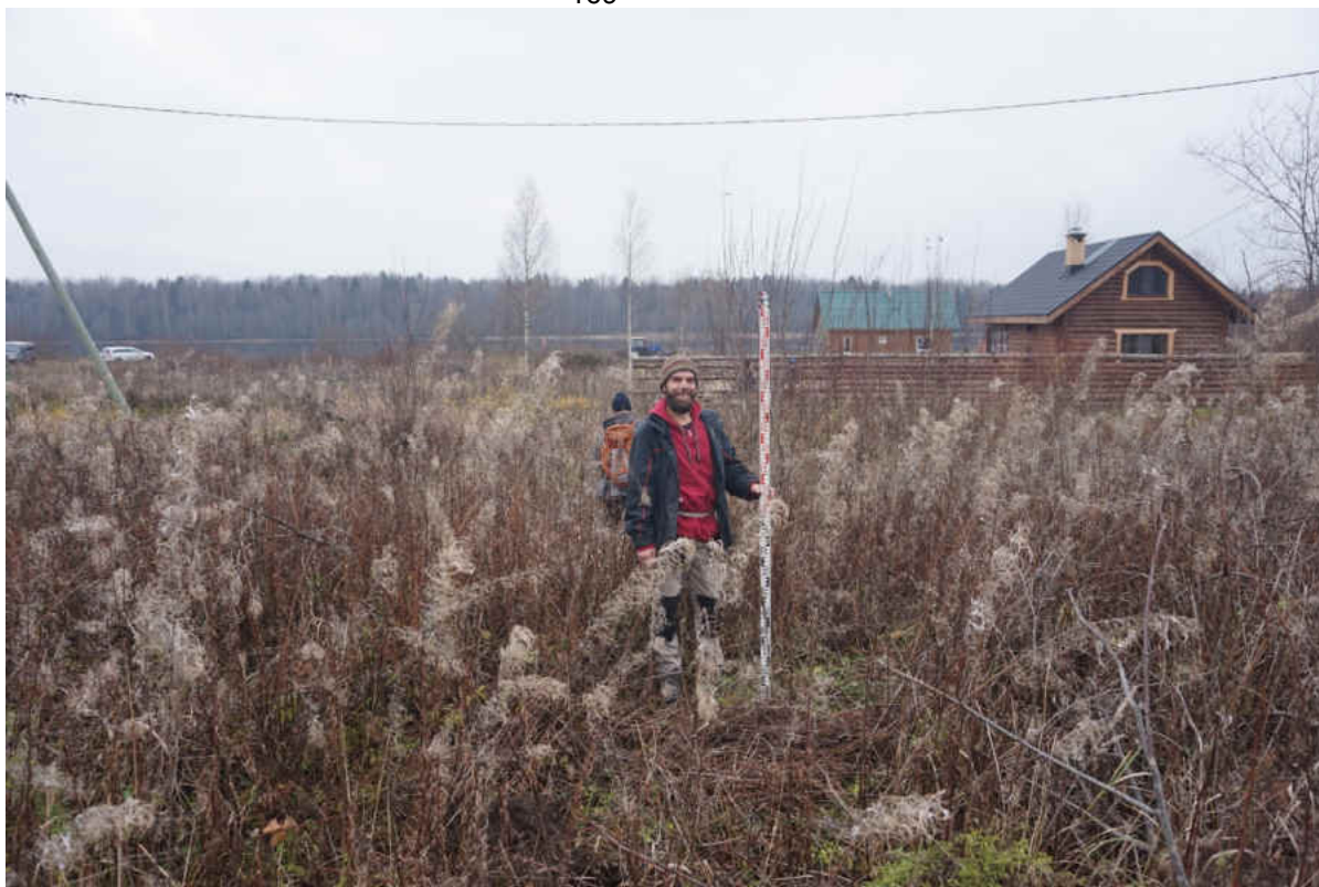
Рис. 45. «Распределительный газопровод по г.п. Свирьстрой Лодейнопольского района Ленинградской обл.» Шурф 1. Общий вид до начала работ. Вид на запад.
