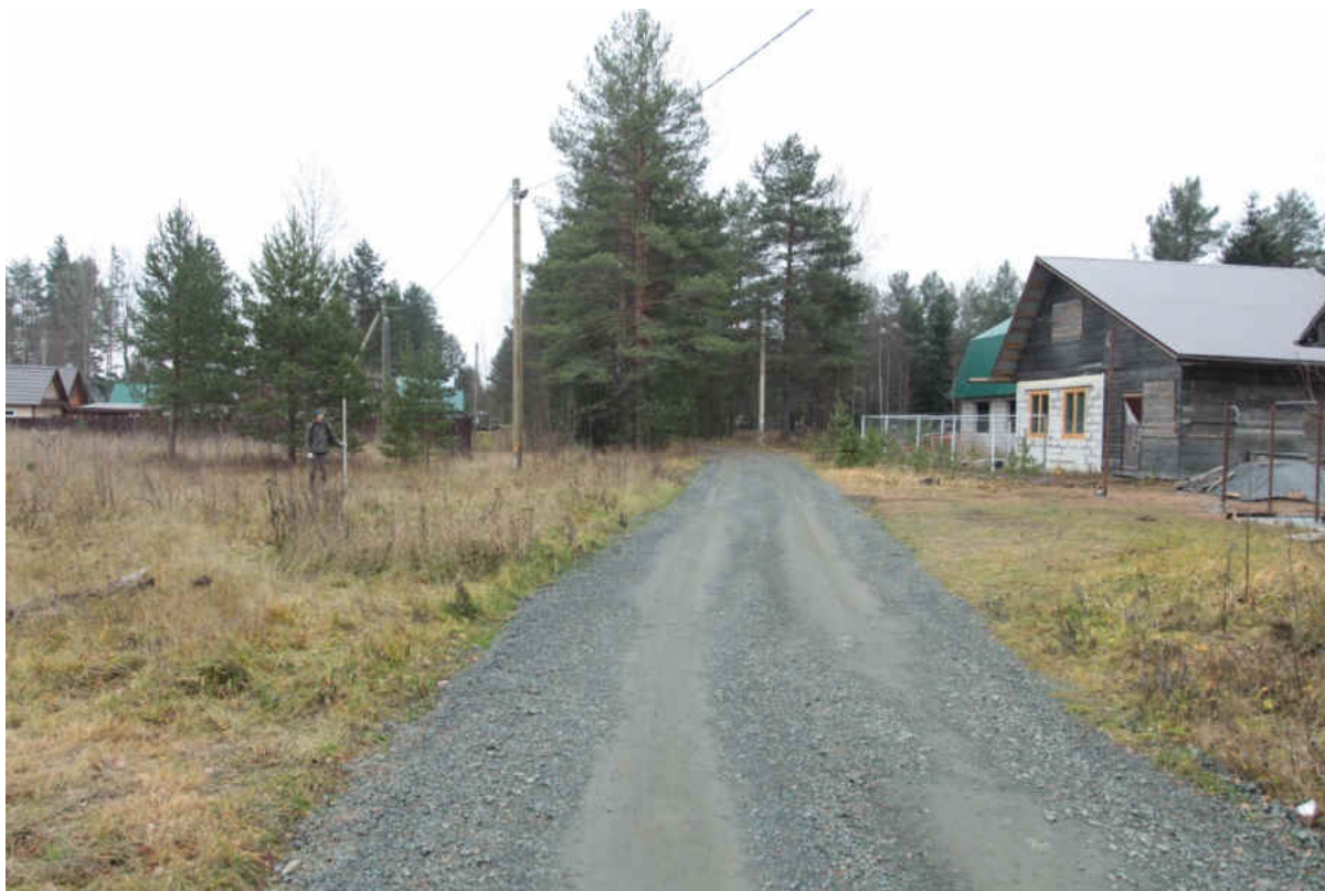
Рис. 21. Ленинградская обл., Лодейнополюский р-н. «Распределительный газопровод по г.п. Свирьстрой». Центральный участок обследования, ул. Дачная, вид на юг
