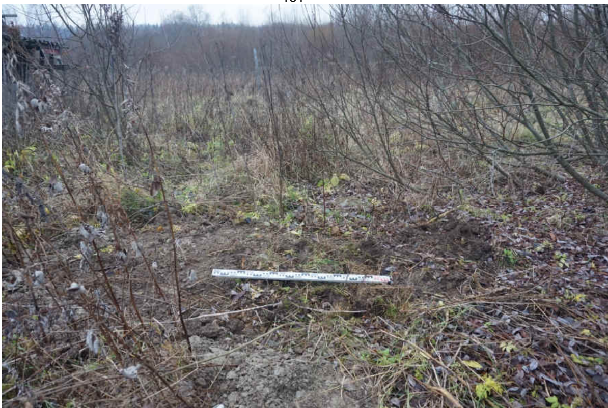
Рис. 69. «Распределительный газопровод по г.п. Свирьстрой Лодейнопольского района Ленинградской обл.» Шурф 5. Рекультивация. Вид на запад.
