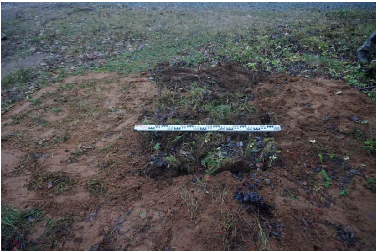
Рис. 291. «Распределительный газопровод по г.п. Свирьстрой Лодейнопольского района Ленинградской обл.» Шурф 49. Рекультивация. Вид на север.
