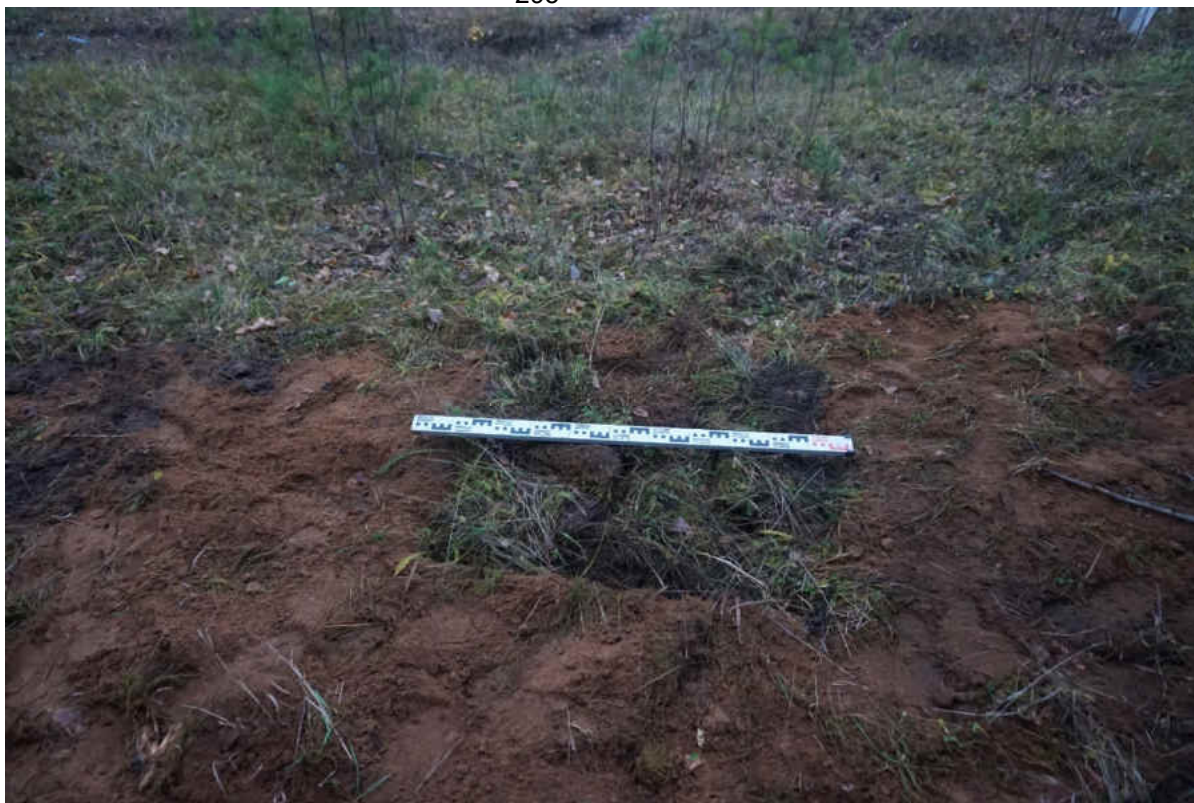
Рис. 296. «Распределительный газопровод по г.п. Свирьстрой Лодейнопольского района Ленинградской обл.» Шурф 50. Рекультивация. Вид на север.
