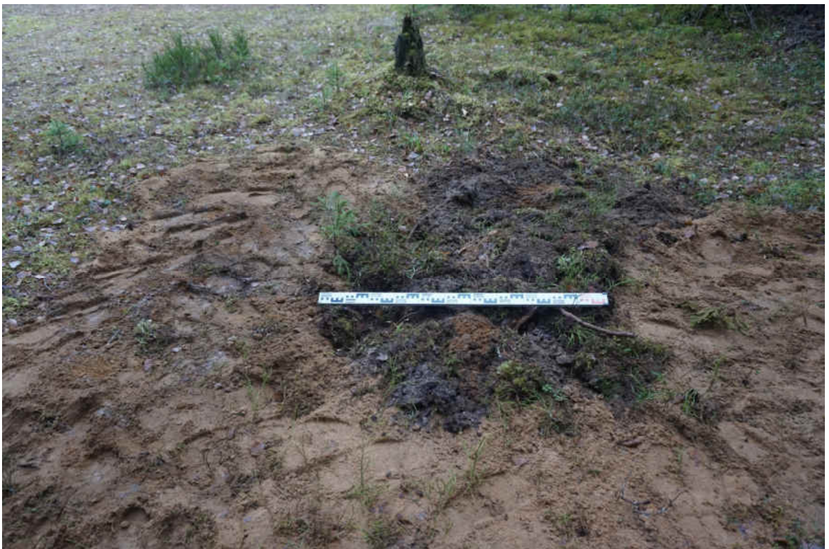
Рис. 331. «Распределительный газопровод по г.п. Свирьстрой Лодейнопольского района Ленинградской обл.» Шурф 57. Рекультивация. Вид на восток.
