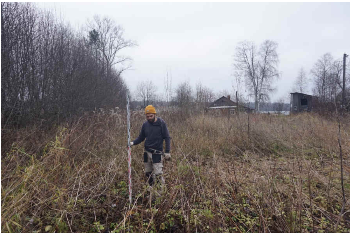
Рис. 142. «Распределительный газопровод по г.п. Свирьстрой Лодейнопольского района Ленинградской обл.» Шурф 20. Общий вид до начала работ. Вид на запад.
