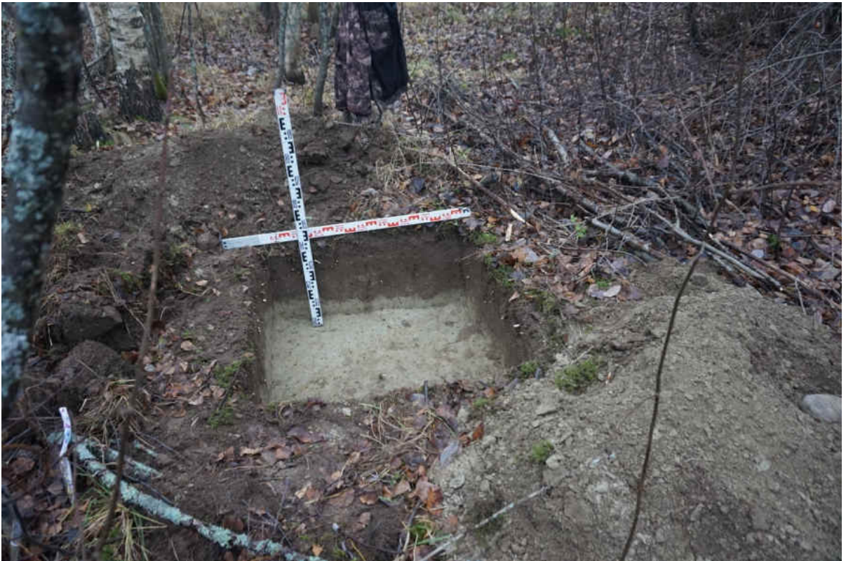
Рис. 123. «Распределительный газопровод по г.п. Свирьстрой Лодейнопольского района Ленинградской обл.» Шурф 16. Общий вид. Вид на запад.
