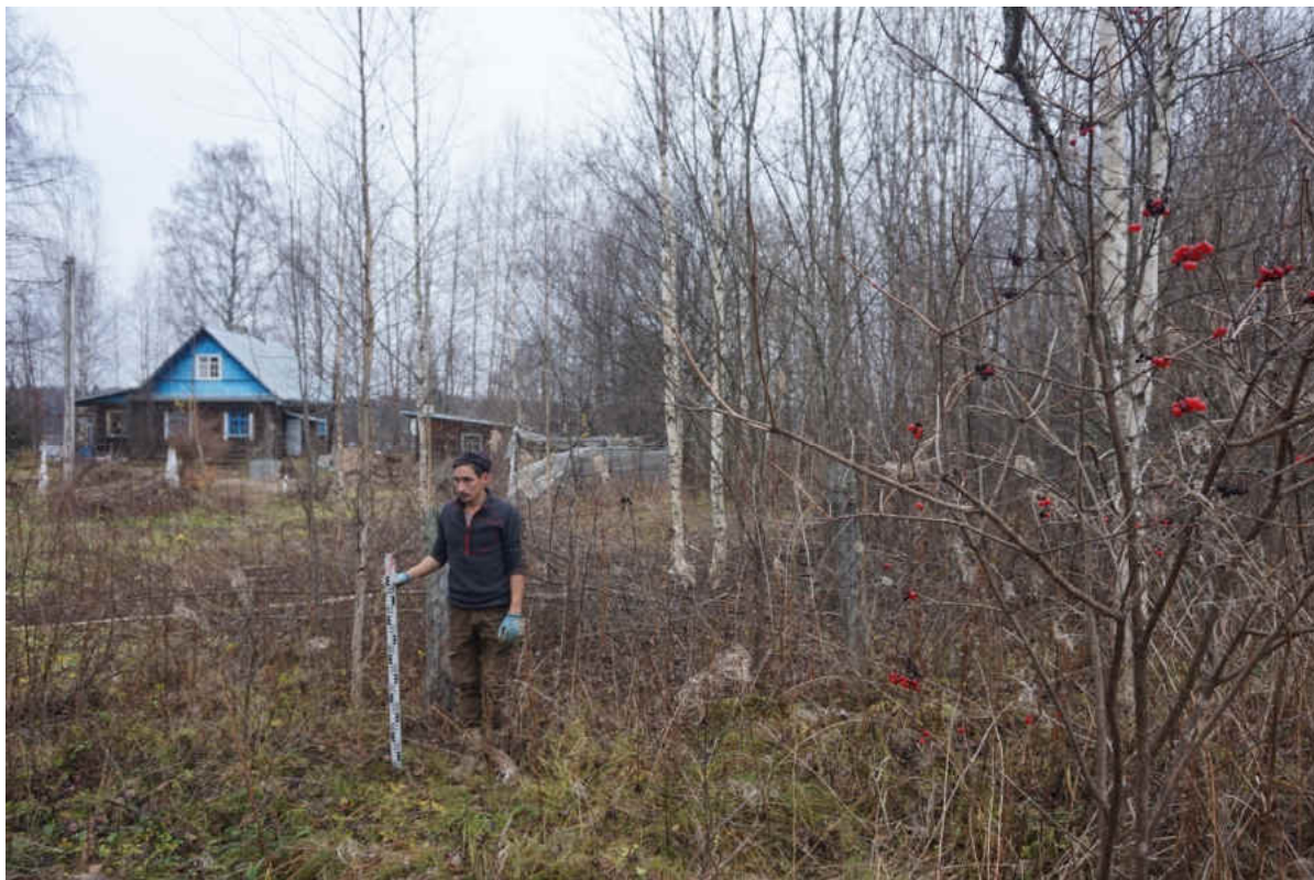
Рис. 137. «Распределительный газопровод по г.п. Свирьстрой Лодейнопольского района Ленинградской обл.» Шурф 19. Общий вид до начала работ. Вид на запад.
