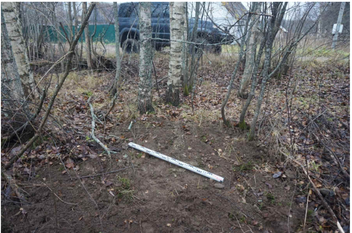
Рис. 126. «Распределительный газопровод по г.п. Свирьстрой Лодейнопольского района Ленинградской обл.» Шурф 16. Рекультивация. Вид на запад.
