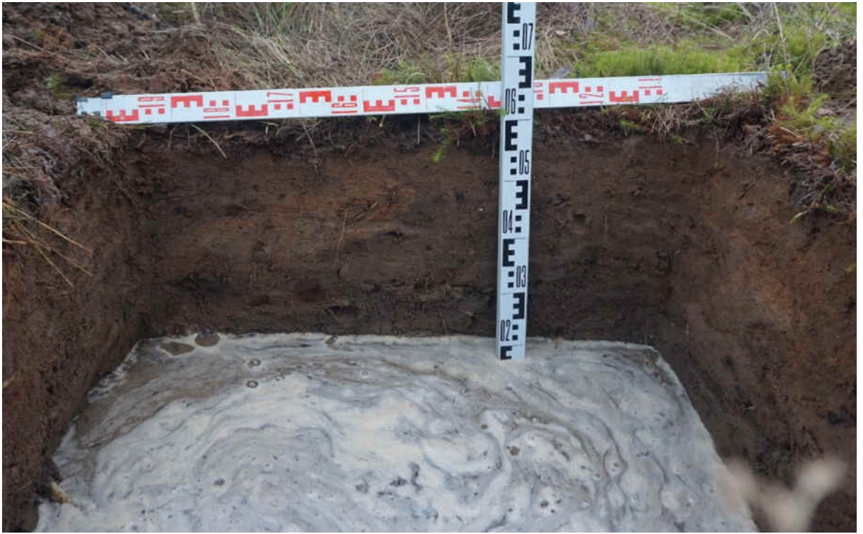
Рис. 280. «Распределительный газопровод по г.п. Свирьстрой Лодейнопольского района Ленинградской обл.» Шурф 47. Западная стенка. Вид на запад.
