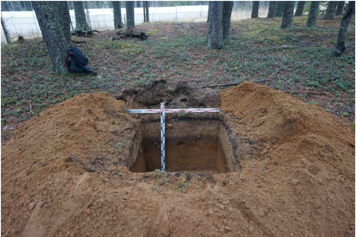
Рис. 164. «Распределительный газопровод по г.п. Свирьстрой Лодейнопольского района Ленинградской обл.» Шурф 24. Общий вид. Вид на запад.
