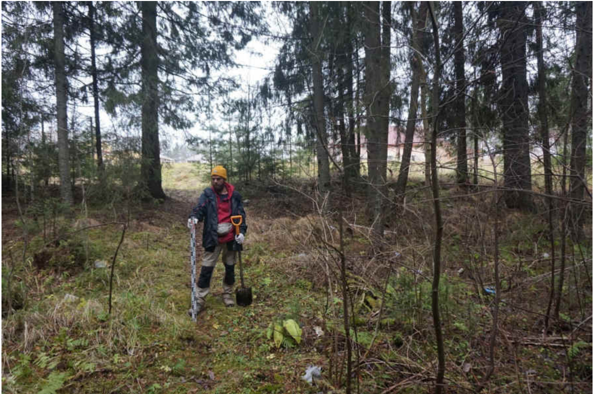
Рис. 262. «Распределительный газопровод по г.п. Свирьстрой Лодейнопольского района Ленинградской обл.» Шурф 44. Общий вид до начала работ. Вид на запад.
