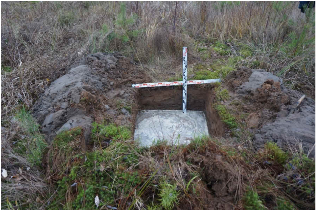
Рис. 278. «Распределительный газопровод по г.п. Свирьстрой Лодейнопольского района Ленинградской обл.» Шурф 47. Общий вид. Вид на запад.
