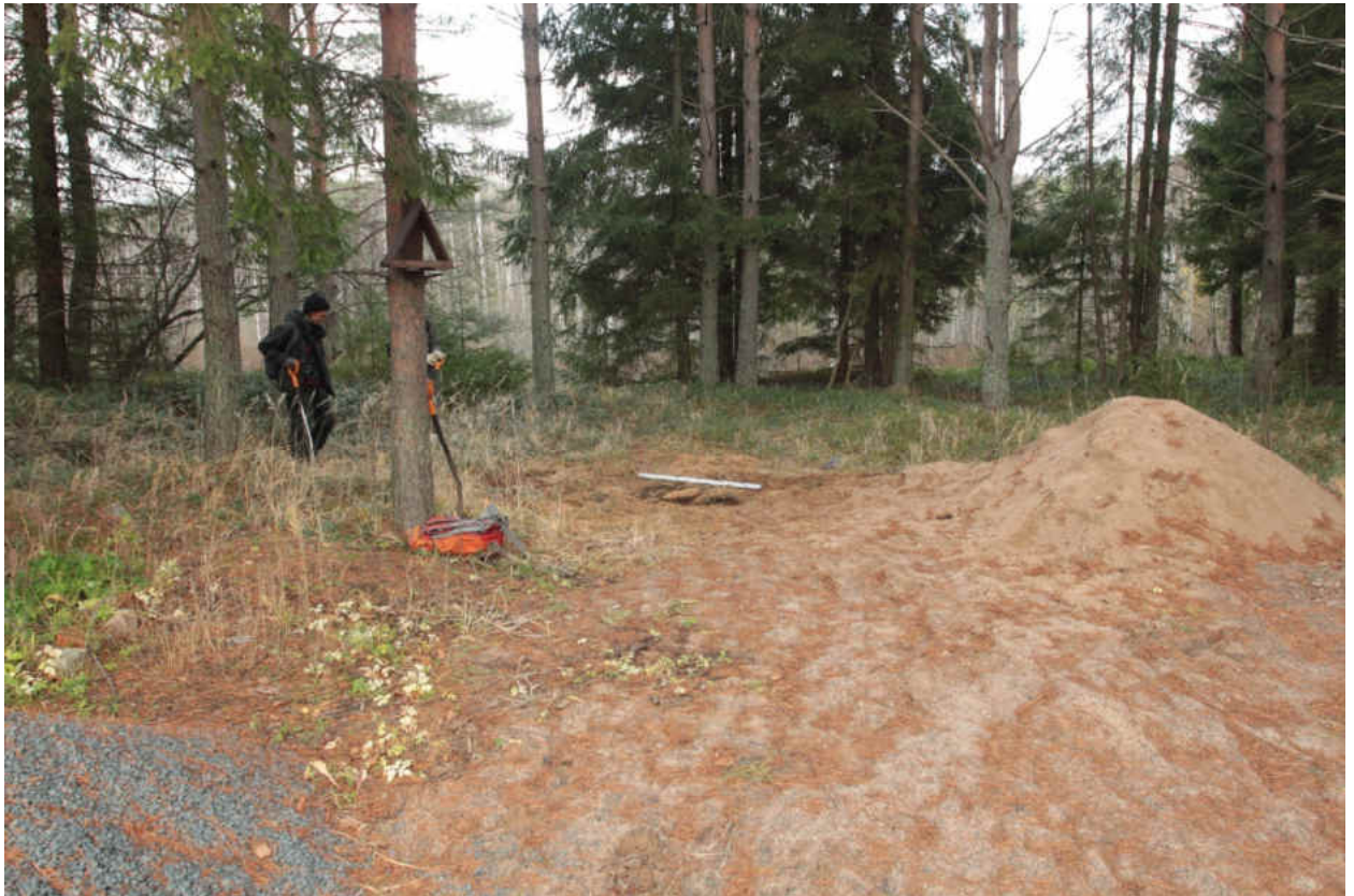
Рис. 218. «Распределительный газопровод по г.п. Свирьстрой Лодейнопольского района Ленинградской обл.» Шурф 34. Рекультивация. Вид на восток.
