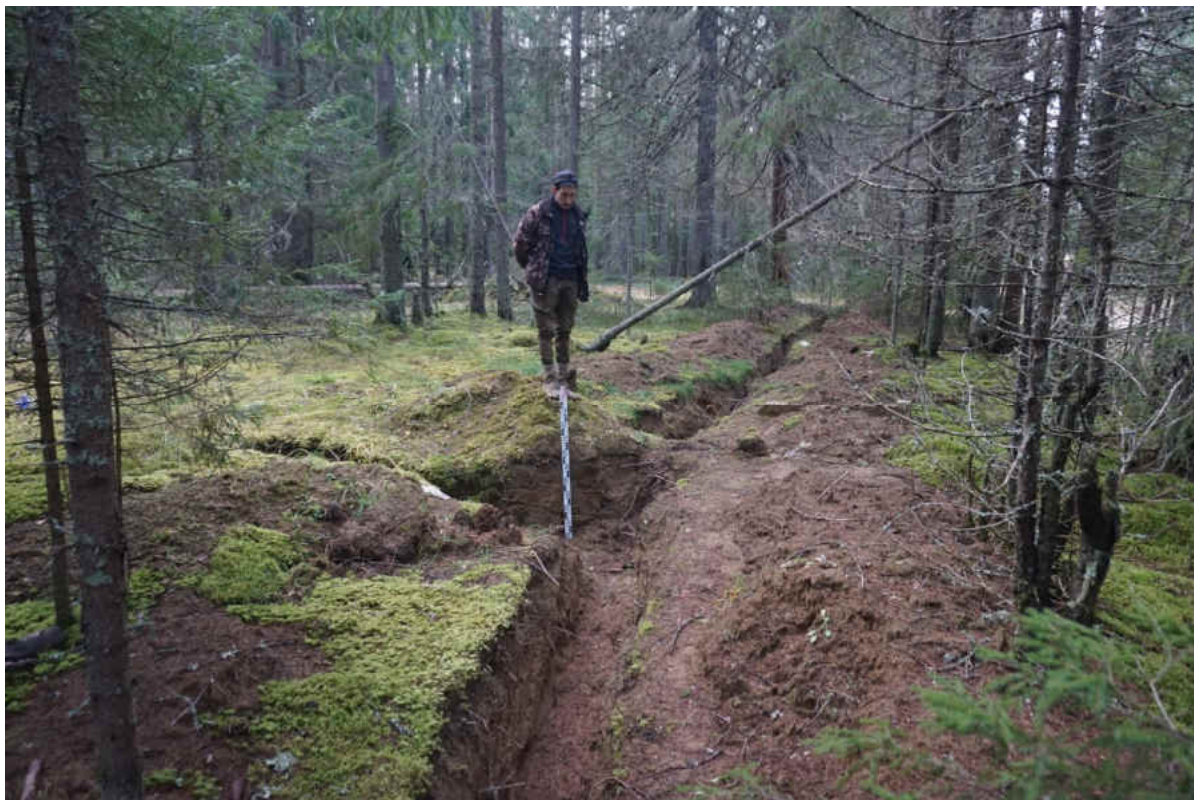
Рис. 332. «Распределительный газопровод по г.п. Свирьстрой Лодейнопольского района Ленинградской обл.» Шурф 58. Общий вид до начала работ. Вид на север.
