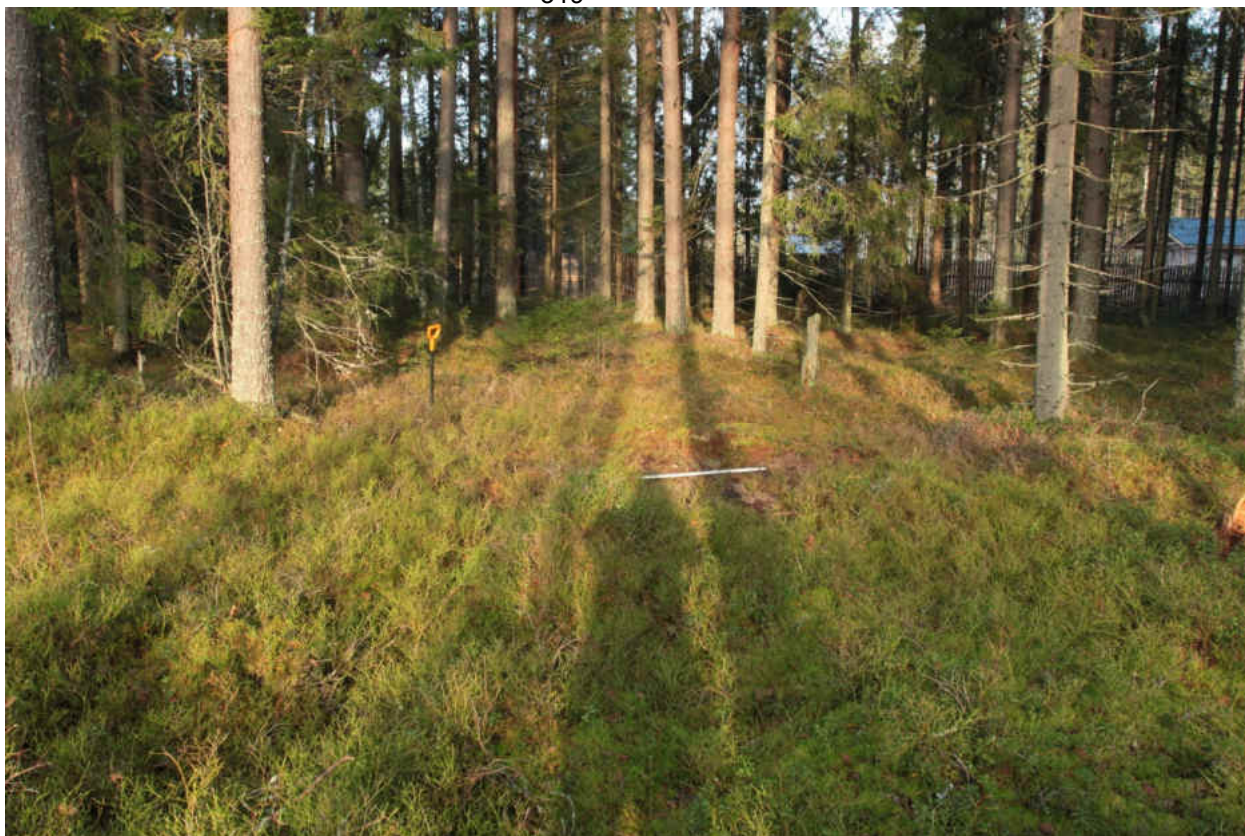
Рис. 344. «Распределительный газопровод по г.п. Свирьстрой Лодейнопольского района Ленинградской обл.» Шурф 60. Рекультивация. Вид на север.
