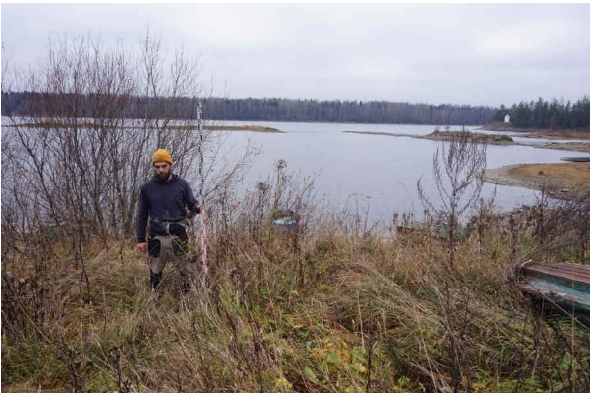
Рис. 153. «Распределительный газопровод по г.п. Свирьстрой Лодейнопольского района Ленинградской обл.» Шурф 22. Общий вид до начала работ. Вид на запад.
