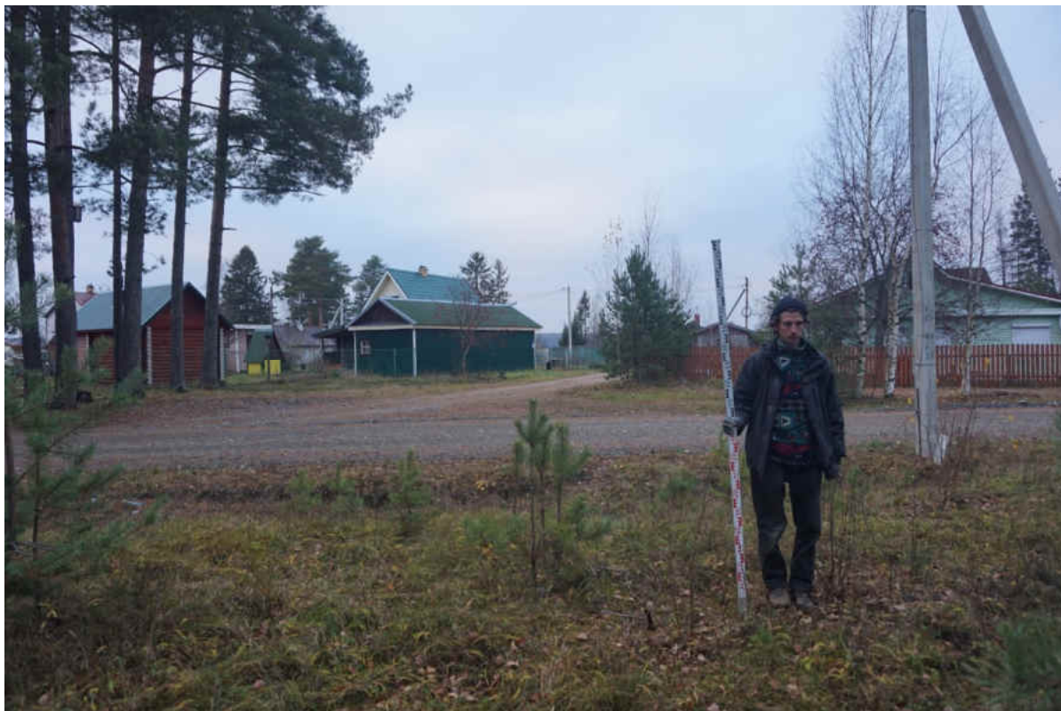
Рис. 292. «Распределительный газопровод по г.п. Свирьстрой Лодейнопольского района Ленинградской обл.» Шурф 50. Общий вид до начала работ. Вид на север.
