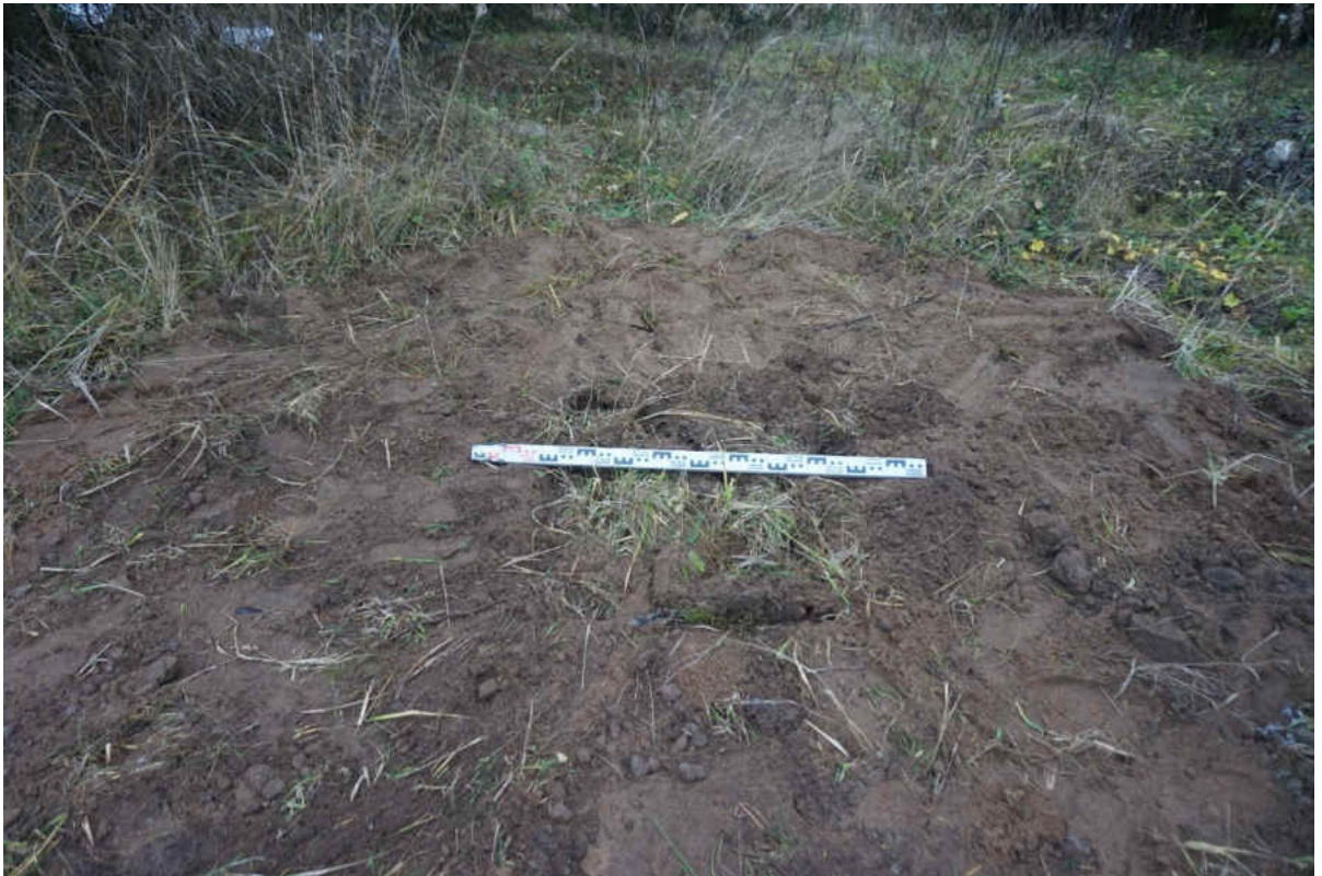
Рис. 152. «Распределительный газопровод по г.п. Свирьстрой Лодейнопольского района Ленинградской обл.» Шурф 21. Рекультивация. Вид на запад.
