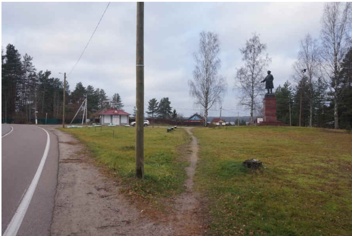
Рис. 33. Ленинградская обл., Лодейнопольский р-н. «Распределительный газопровод по г.п. Свирьстрой». Северный участок обследования, перекресток пр. Кирова и ул. Подпорожской, вид на север
