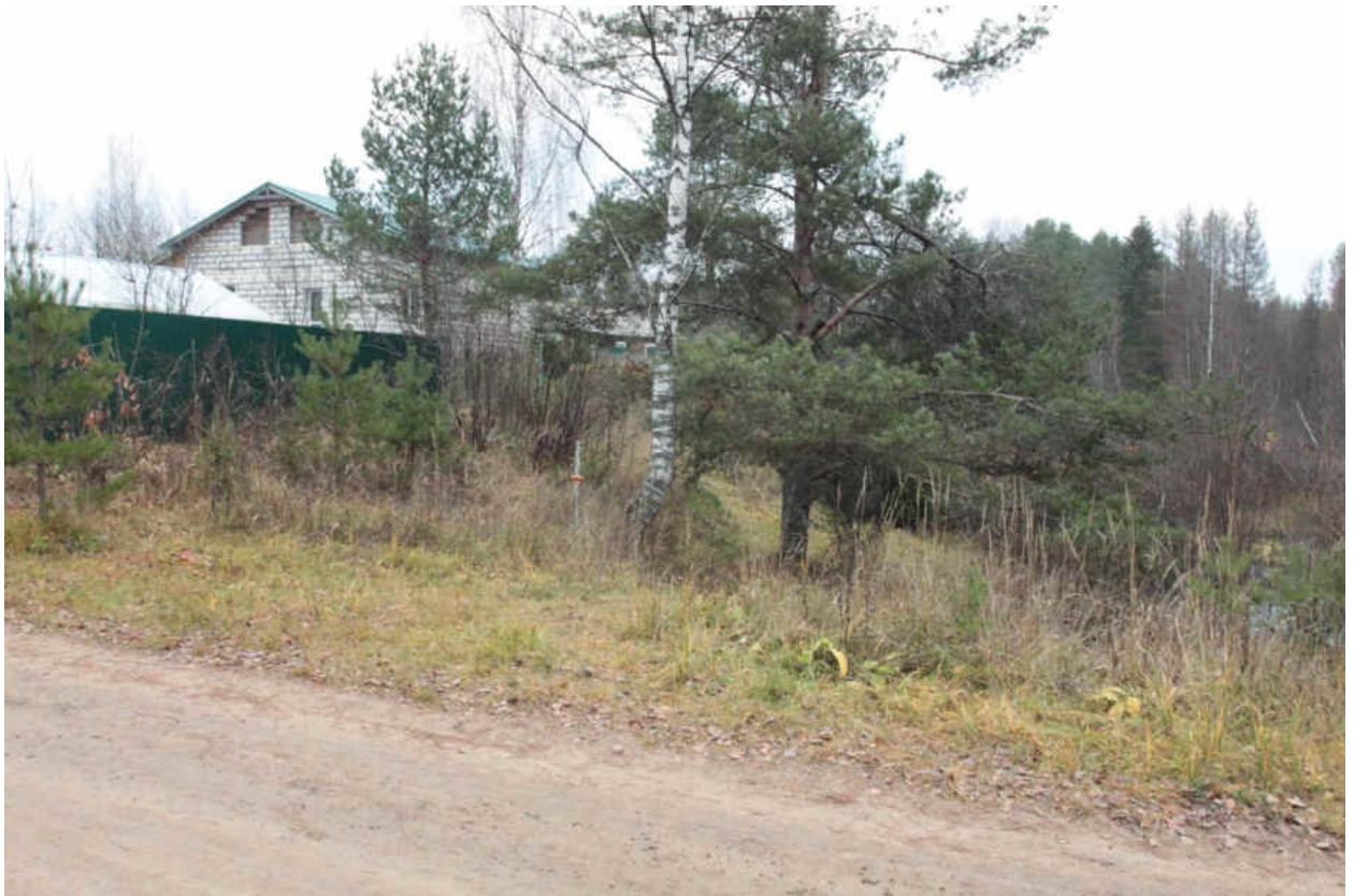
Рис. 239. «Распределительный газопровод по г.п. Свирьстрой Лодейнопольского района Ленинградской обл.» Шурф 39. Общий вид до начала работ. Вид на восток.
