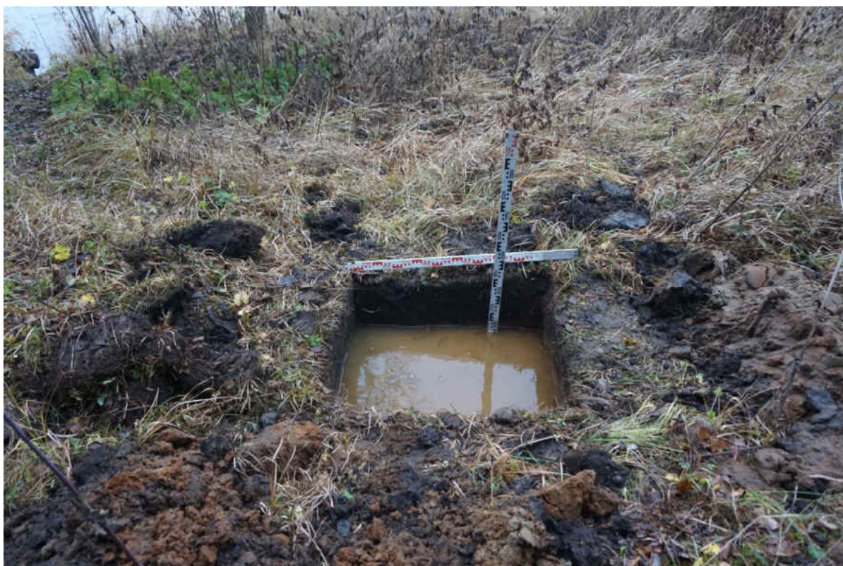
Рис. 273. «Распределительный газопровод по г.п. Свирьстрой Лодейнопольского района Ленинградской обл.» Шурф 46. Общий вид. Вид на запад.
