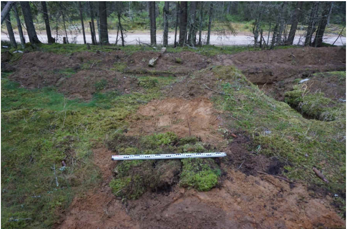
Рис. 311. «Распределительный газопровод по г.п. Свирьстрой Лодейнопольского района Ленинградской обл.» Шурф 53. Рекультивация. Вид на запад.
