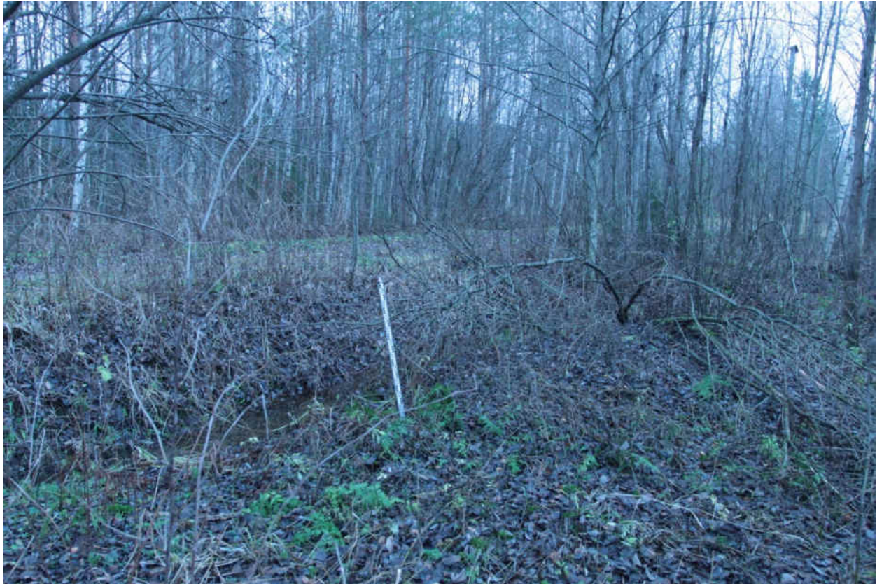
Рис. 105. «Распределительный газопровод по г.п. Свирьстрой Лодейнопольского района Ленинградской обл.» Шурф 13. Общий вид до начала работ. Вид на юго-восток.
