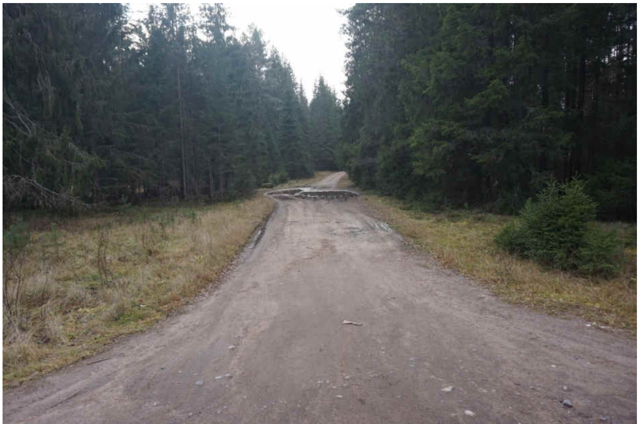
Рис. 42. Ленинградская обл., Лодейнопольский р-н. «Распределительный газопровод по г.п. Свирьстрой». Северный участок обследования, перекресток ул Радченко и Подпорожской, вид на юг
