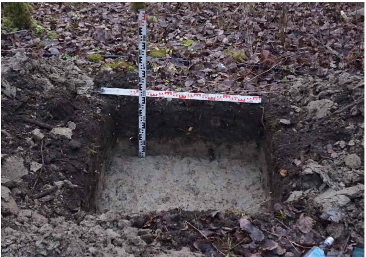
Рис. 92. «Распределительный газопровод по г.п. Свирьстрой Лодейнопольского района Ленинградской обл.» Шурф 10. Материковая поверхность. Вид на запад.
