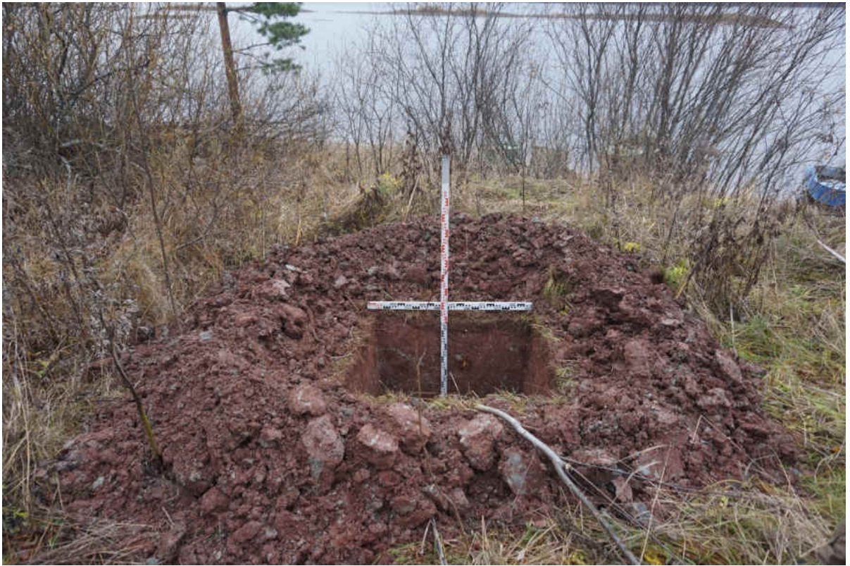
Рис. 154. «Распределительный газопровод по г.п. Свирьстрой Лодейнопольского района Ленинградской обл.» Шурф 22. Общий вид. Вид на запад.
