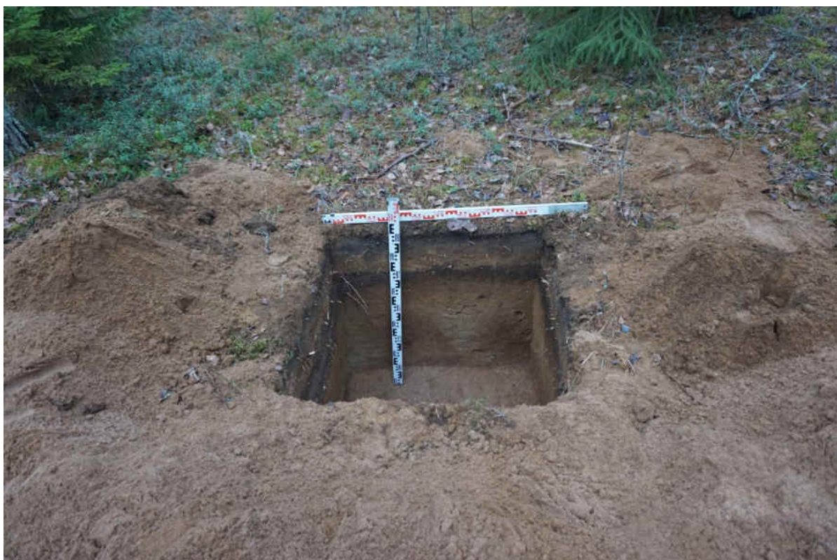
Рис. 159. «Распределительный газопровод по г.п. Свирьстрой Лодейнопольского района Ленинградской обл.» Шурф 23. Общий вид. Вид на запад.
