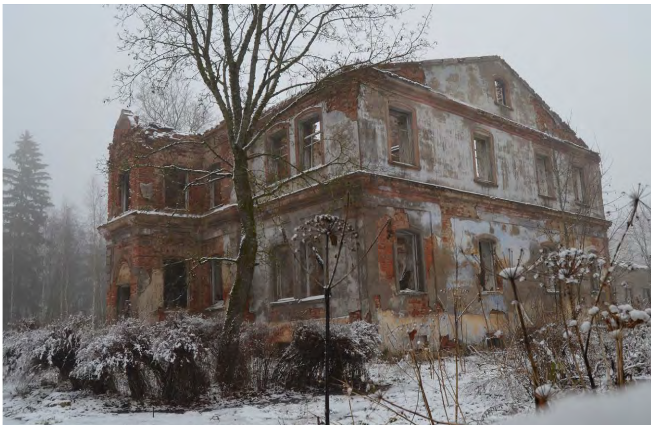
Фото 15. Вид на лицевой фасад усадебного дома. Направление съемки- юго-восток. Дата съемки 16.12.2019. Автор съемки Е.Б. Яковлева.
