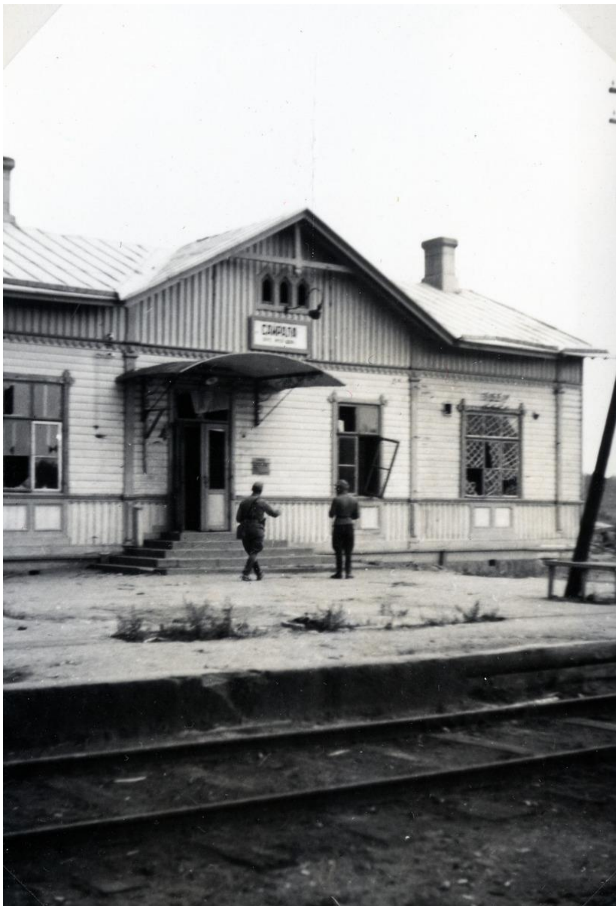
Илл. 13. Вокзал железнодорожной станции «Сайрала». 17.08.1941 г. (источник: http://sa-kuva.fi ).
