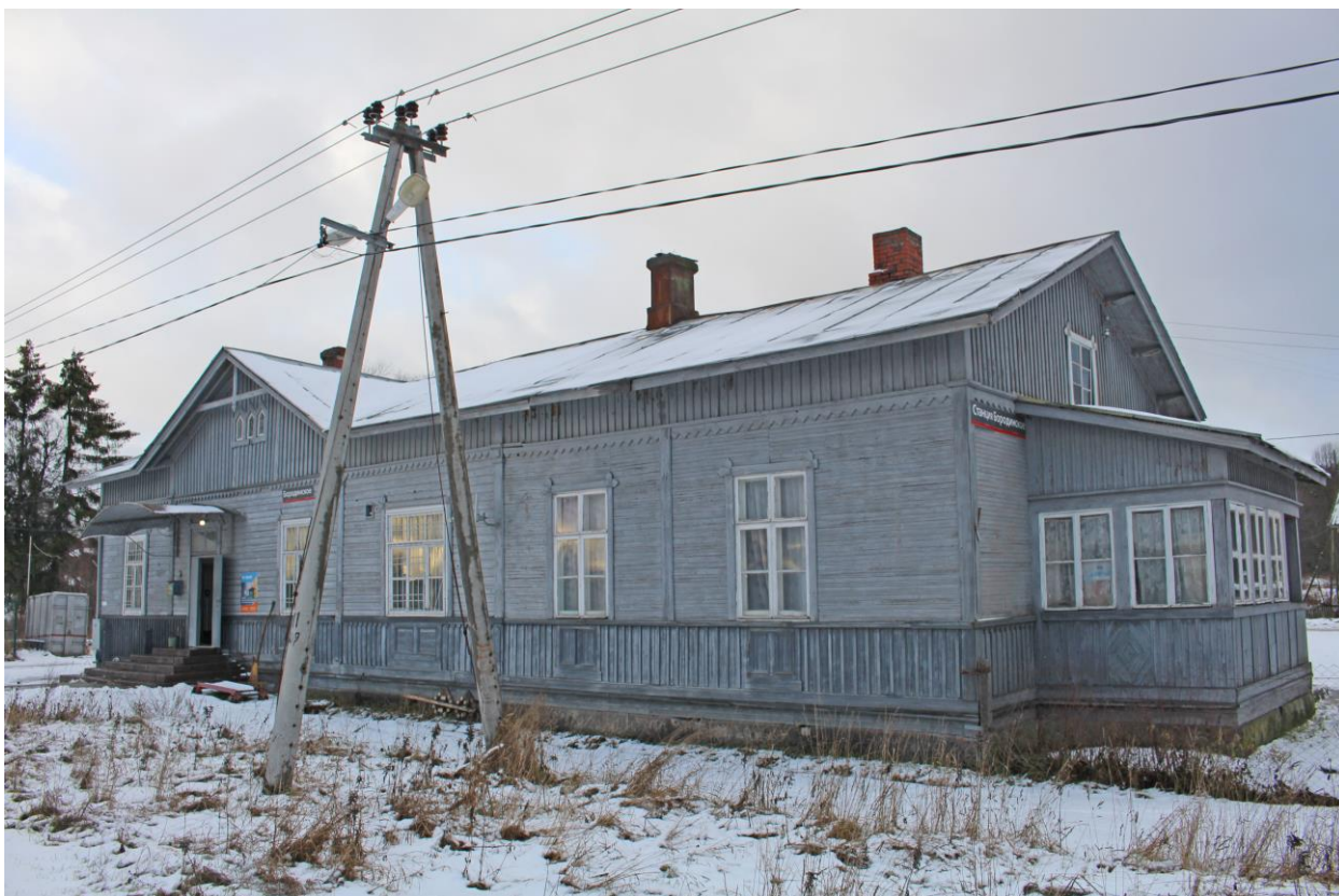
Фото 3. Вид на юго-восточный фасад вокзала железнодорожной станции «Бородинское».
