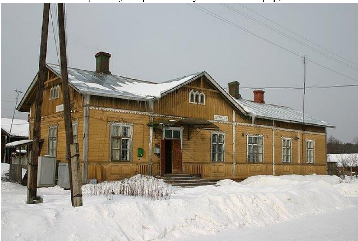
Илл. 16. Вокзал железнодорожной станции «Бородинское». 2006 г. (источник: https://terijoki.spb.ru/railway/rw_dir_hiitola.php ).
