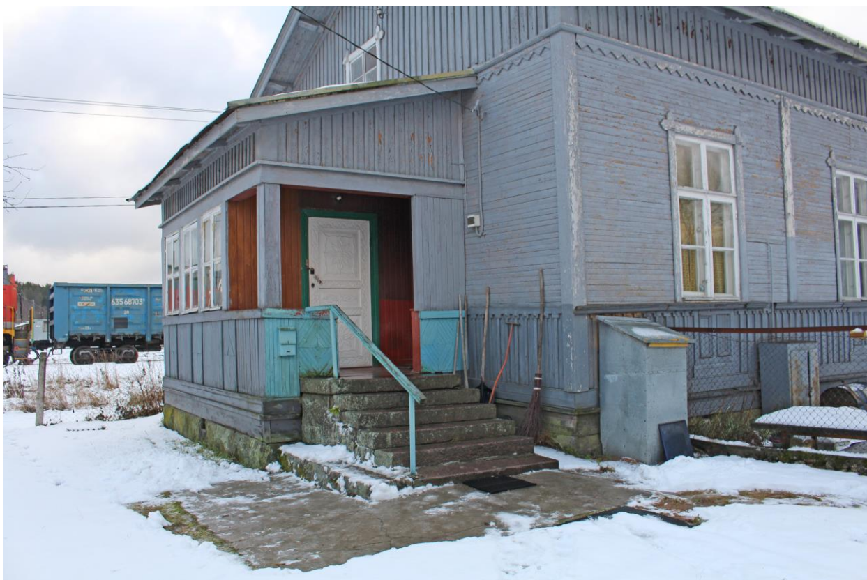
Фото 5. Вид на веранду с северо-восточной стороны вокзала железнодорожной станции «Бородинское».
