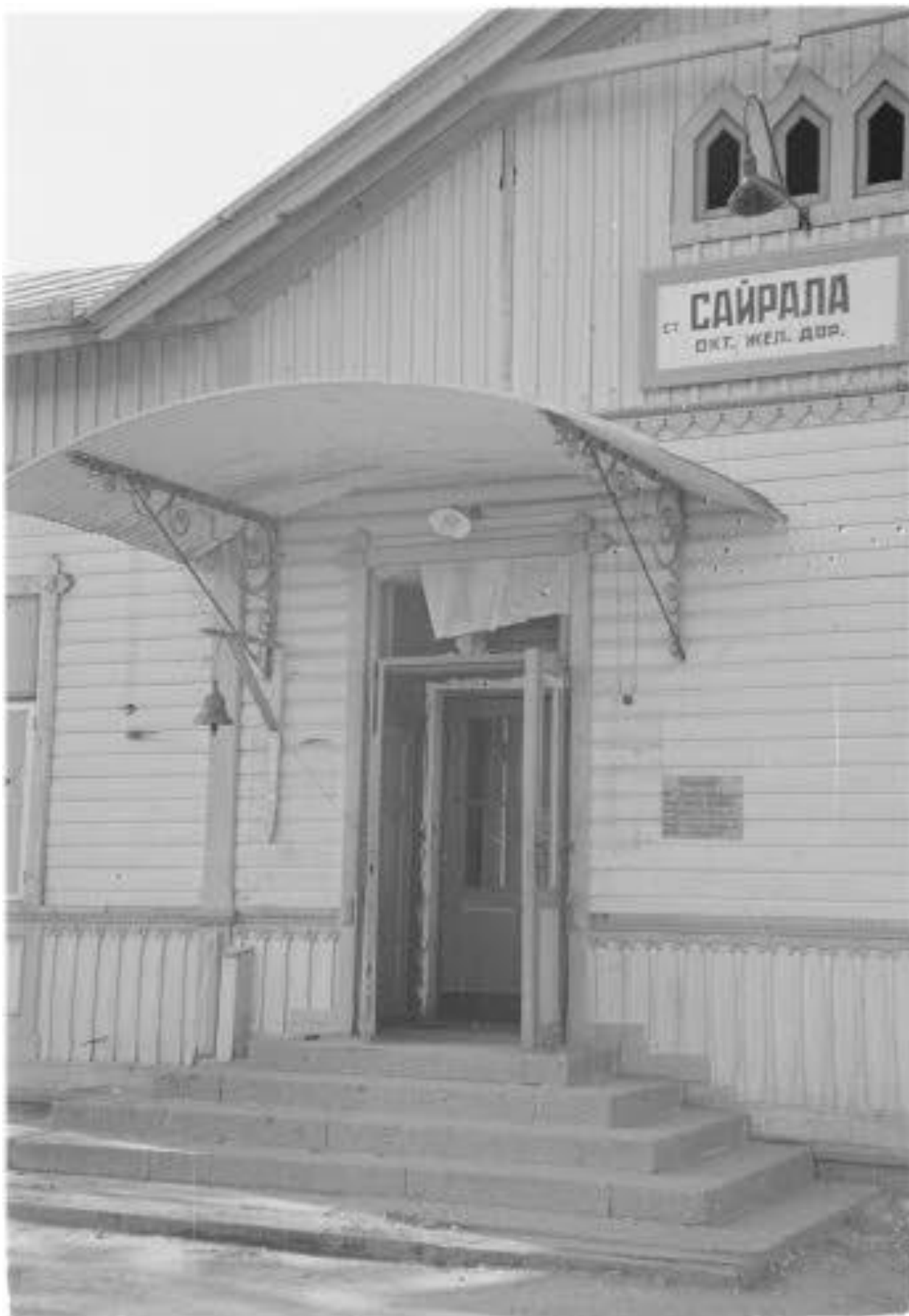
Илл. 14. Вокзал железнодорожной станции «Сайрала». 17.08.1941 г. (источник: http://sa-kuva.fi ).
