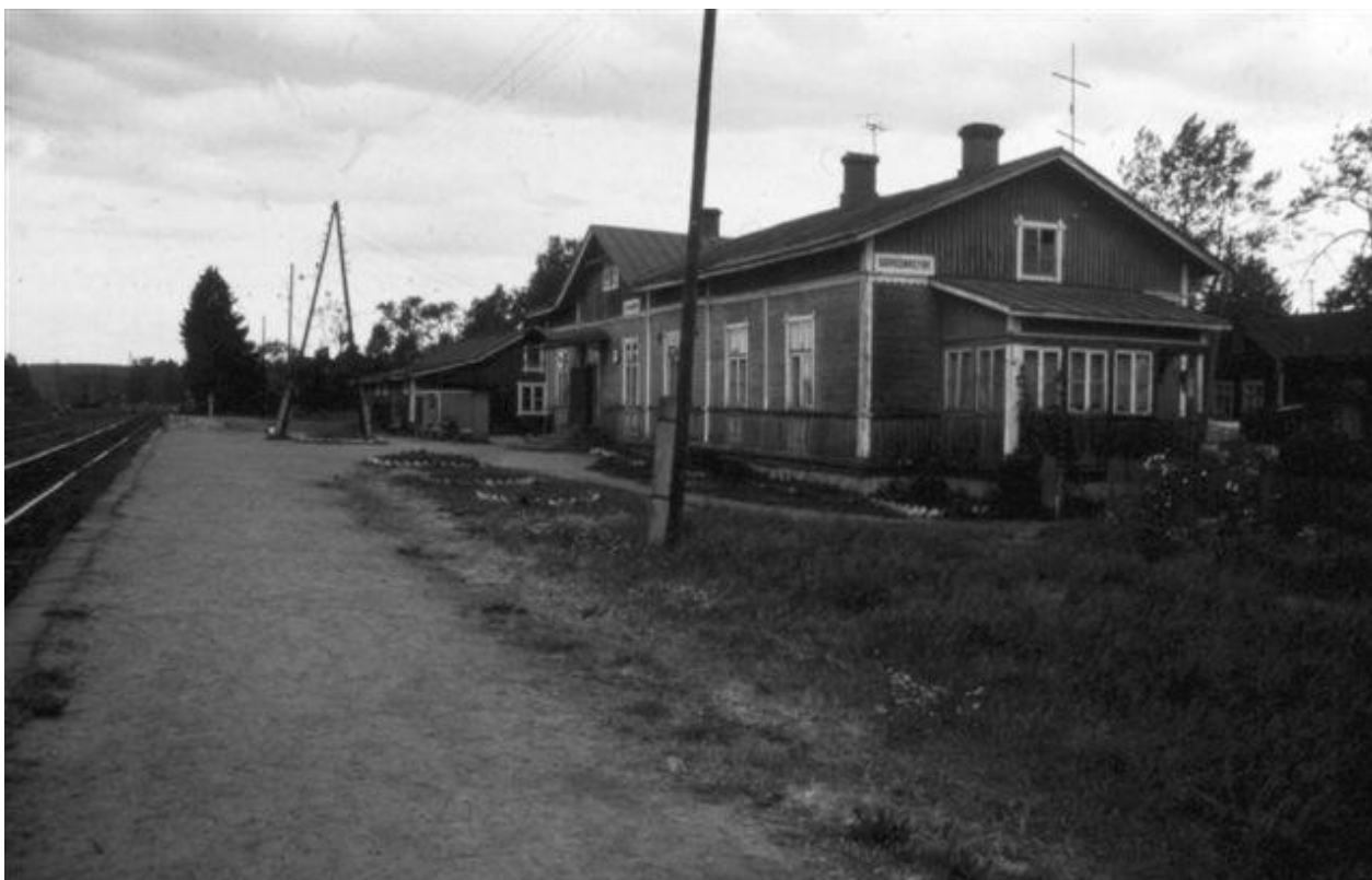
Илл. 15. Вокзал железнодорожной станции «Бородинское». 1992 г. (источник: https://terijoki.spb.ru/railway/rw_dir_hiitola.php ).
