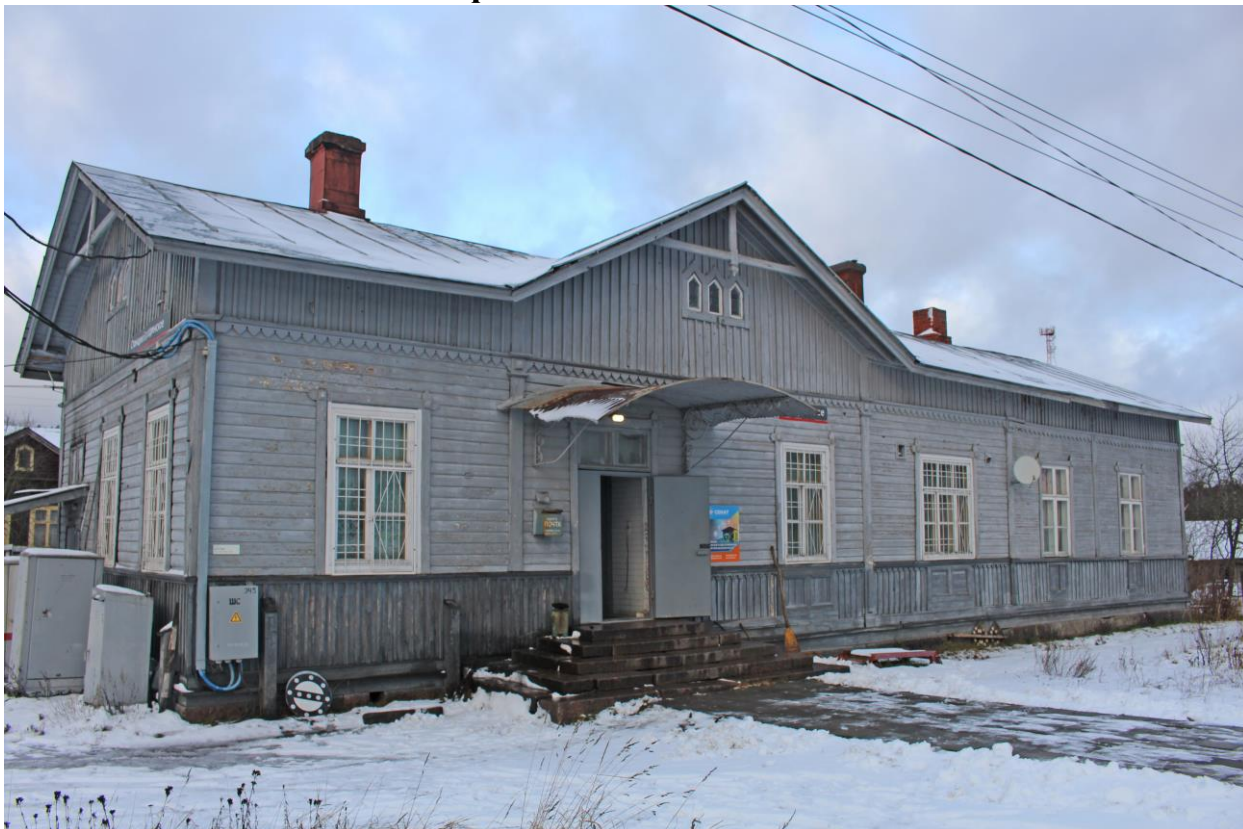
Фото 1. Вид на юго-восточный фасад вокзала железнодорожной станции «Бородинское».
