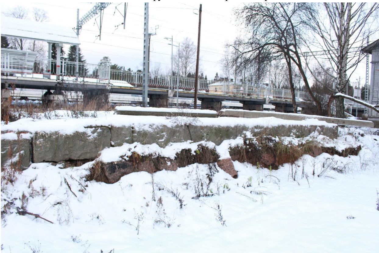
Фото 11. Вид на фундамент товарного сарая с востока.
