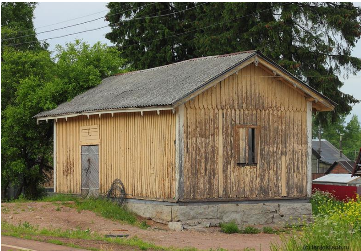
Илл. 14. Железнодорожная станция «Гвардейское»). Товарный сарай в 2013 году (источник: https://terijoki.spb.ru/railway/rw_dir_hiitola.php ).
