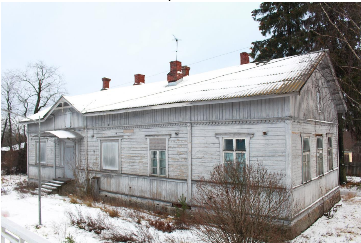
Фото 2. Вид на западный фасад вокзала железнодорожной станции «Гвардейское».
