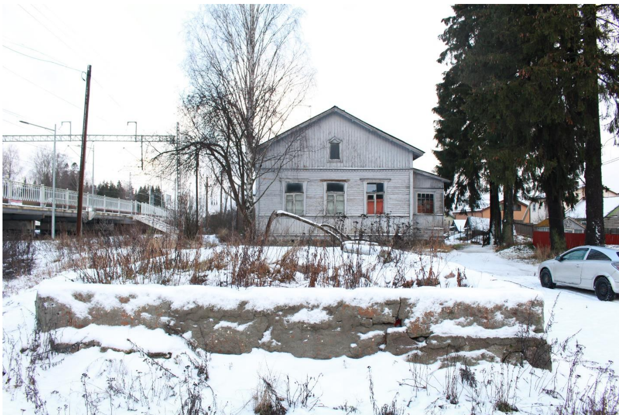
Фото 10. Вид на фундамент товарного сарая с юга.
