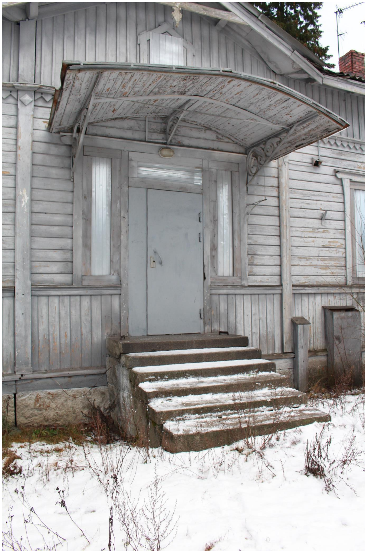
Фото 3. Вид на центральный вход в вокзал железнодорожной станции «Гвардейское».
