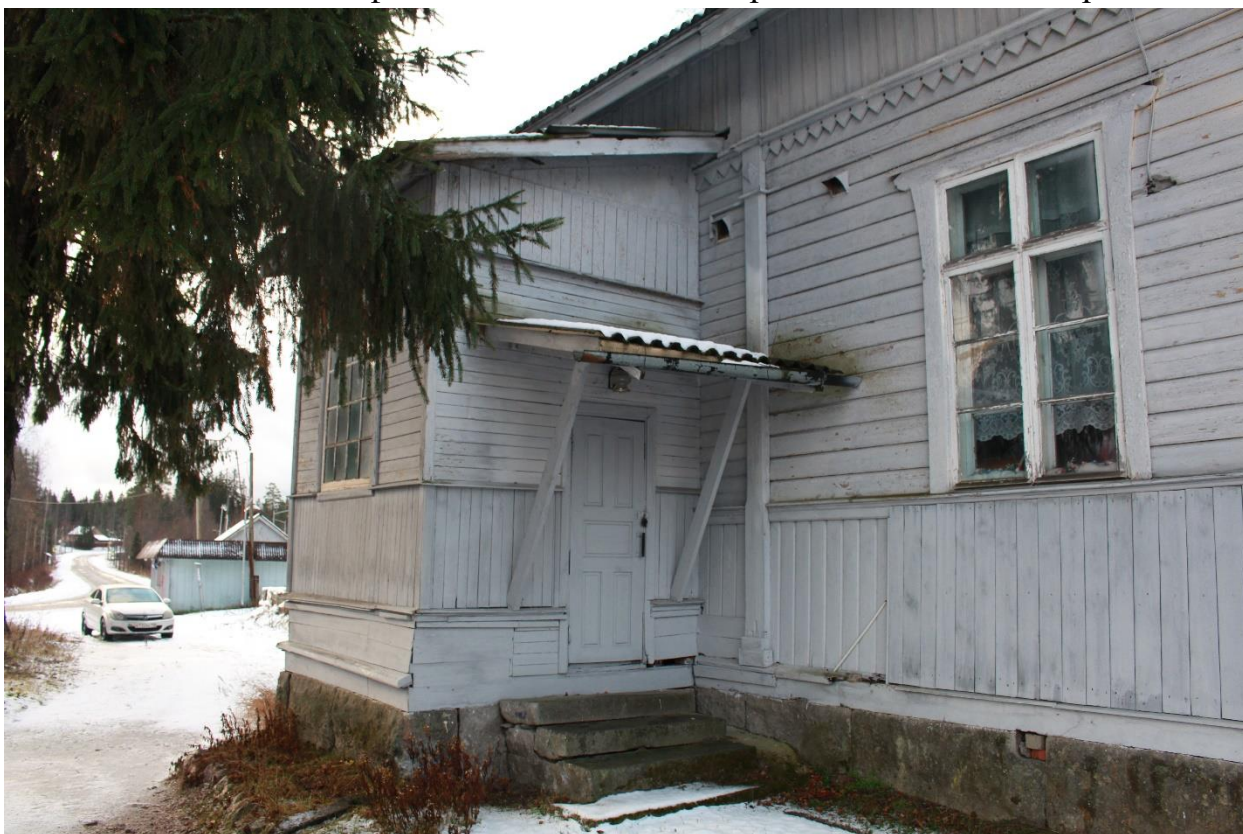
Фото 5. Вид на пристроенный тамбур к юго-восточной части здания вокзала железнодорожной станции «Гвардейское».
