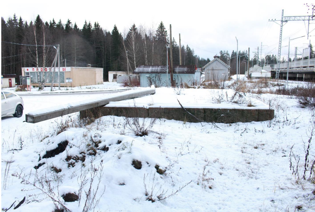
Фото 12. Вид на фундамент товарного сарая с севера.
