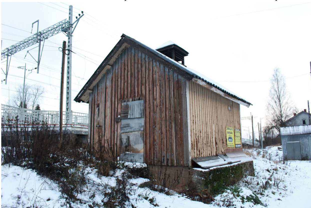
Фото 15. Вид на южный фасад станционной хозяйственной постройки.
