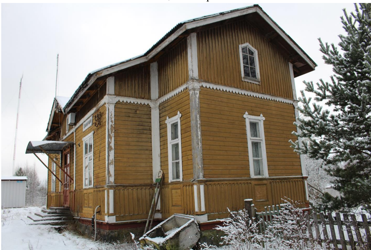
Фото 5. Вид на северный фасад вокзала железнодорожной станции «Оярви».
