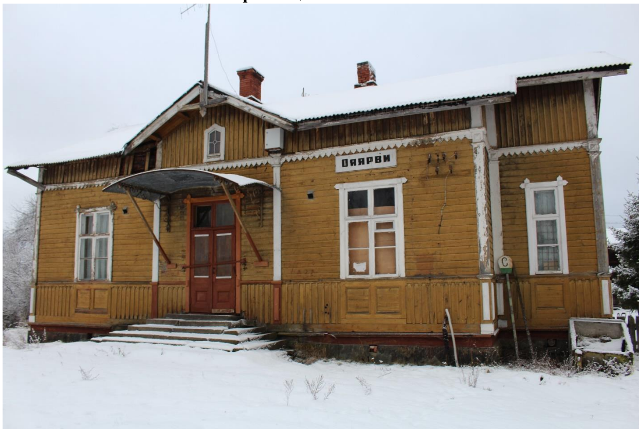
Фото 1. Вид на восточный фасад вокзала железнодорожной станции «Оярви».
