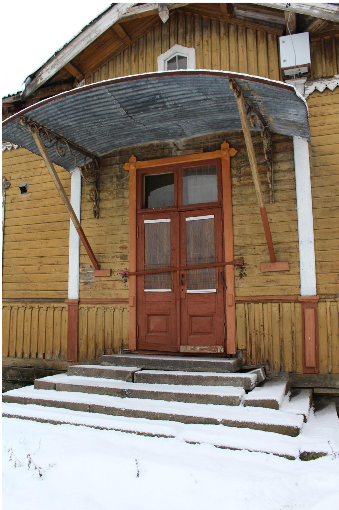
Фото 3. Вид на крыльцо с восточной стороны здания.
