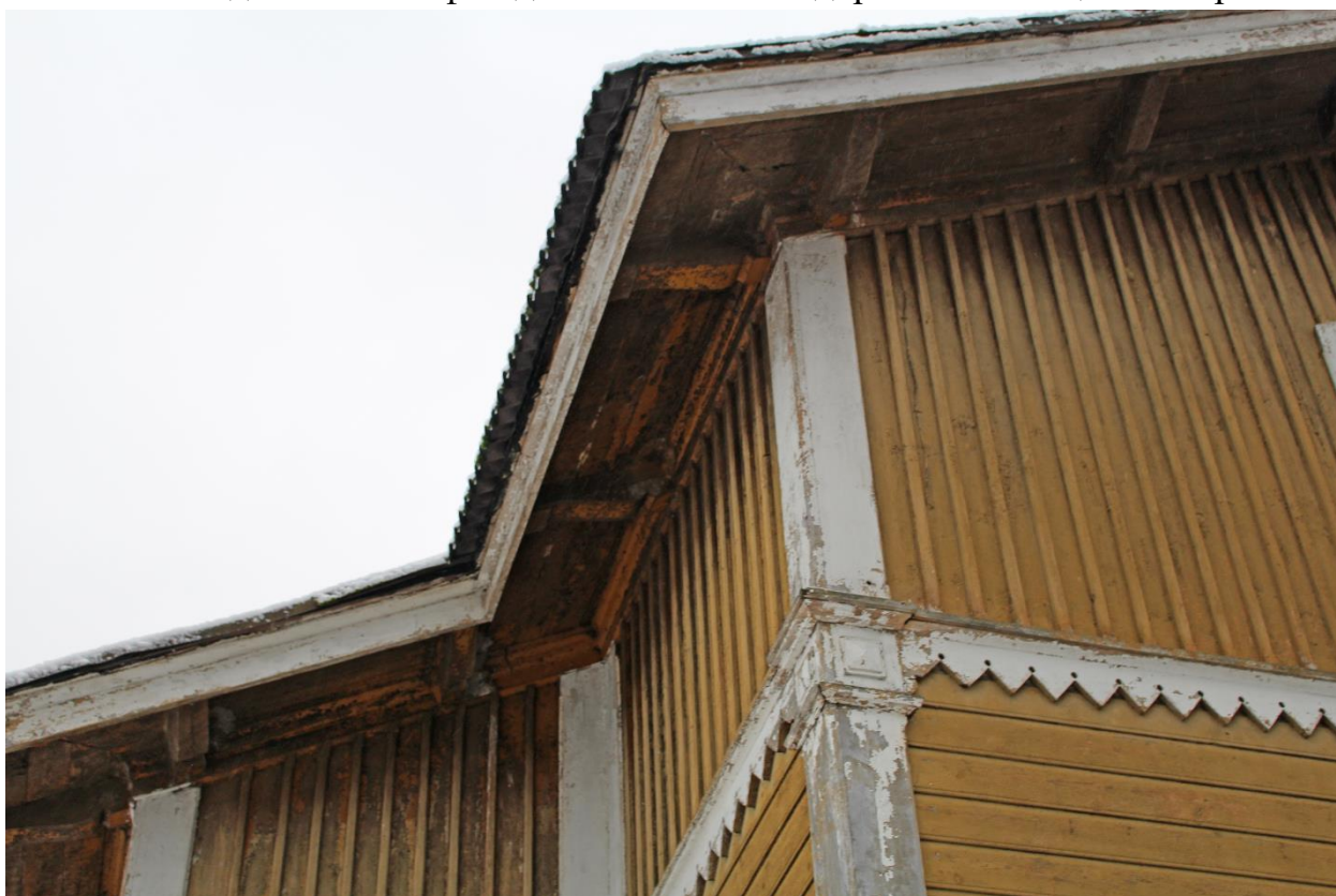
Фото 9. Вид на свесы крыши.
