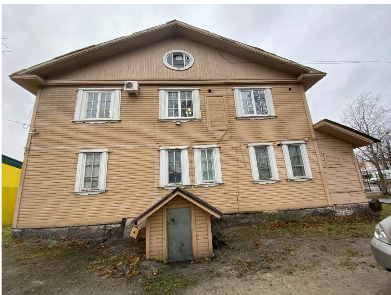
Фото 4. Восточный фасад здания.
