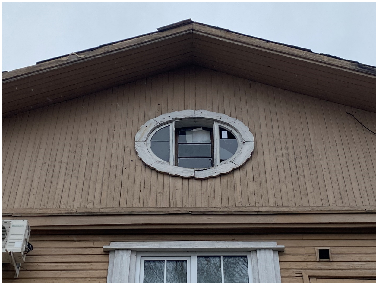
Фото 10. Окно-люкарна восточного фасада в урне чердака, оформленное резным деревянным наличником.
