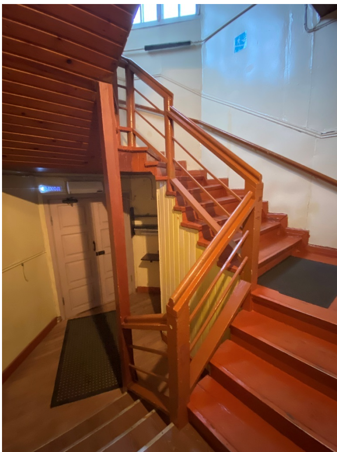
Фото 12. Деревянная лестница в уровне 1-го этажа. Вид с юго-запада.
