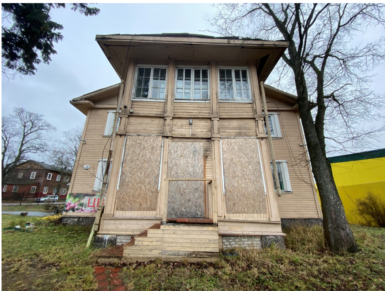
Фото 6. Западный фасад здания.
