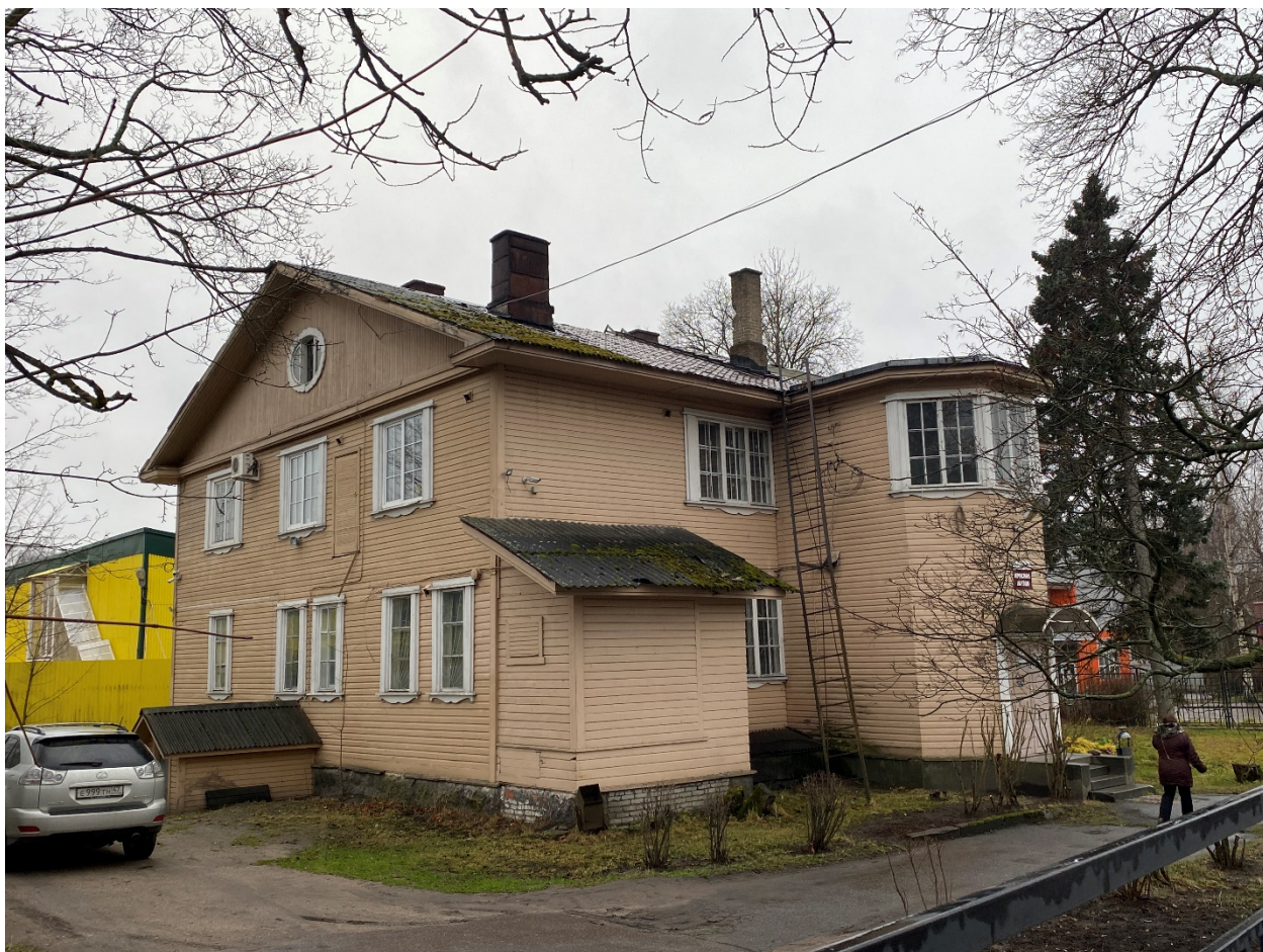
Фото 1. Общий вид выявленного объекта культурного наследия «Жилой дом», расположенного по адресу: Ленинградская область, Приозерский район, г. Приозерск, Советская, 6 / Жуковского, 1.
