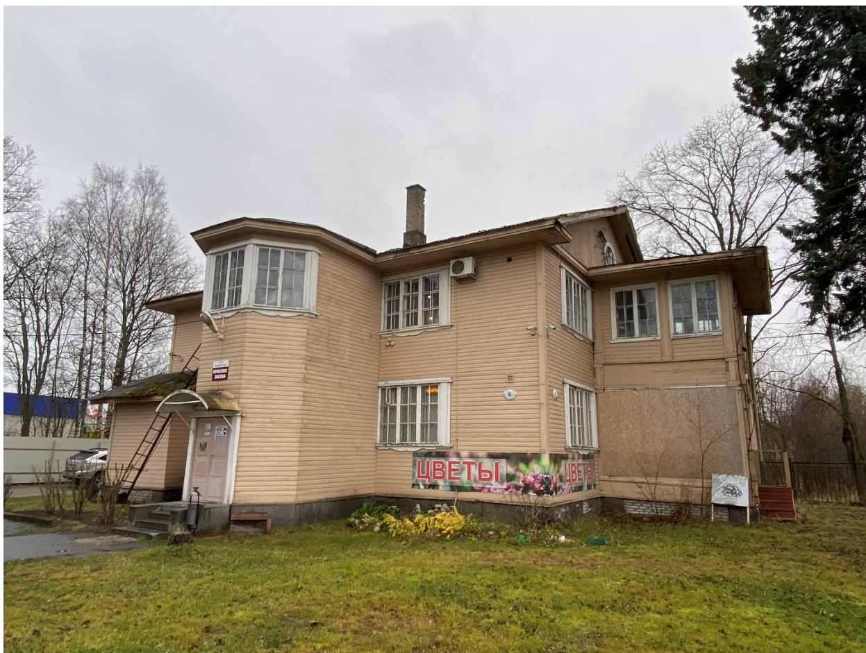
Фото 5. Общий вид объекта с северо-запада.
