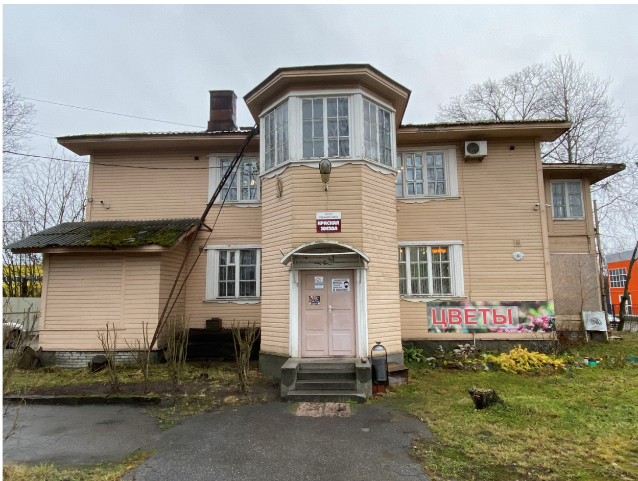
Фото 2. Северный фасад здания.
