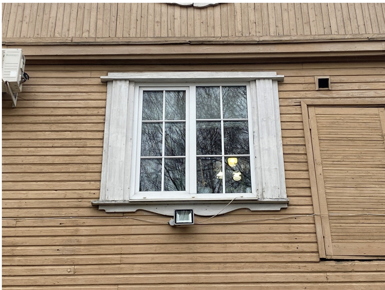
Фото 9. Оконные проемы, оформленные резными деревянными наличниками.
