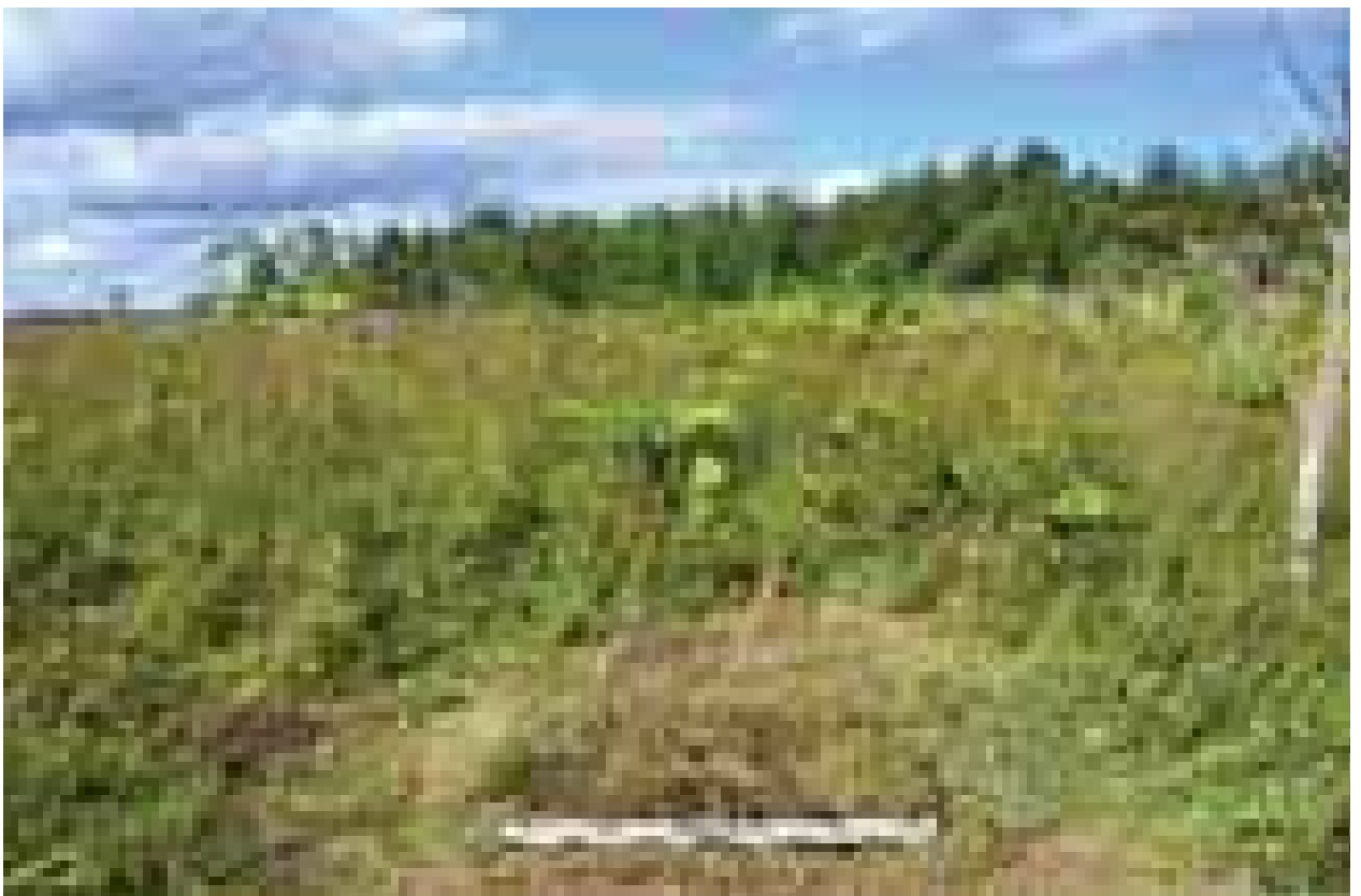
Илл. 176. Ленинградская область. Кингисеппский муниципальный район. «Проектируемое строительство трубопровода метанола от промышленной площадки ООО «ПГ «Фосфорит» до терминала «ЕвроХим терминал Усть-Луга». Шурф №15. Рекультивация. Вид с юга. 387
