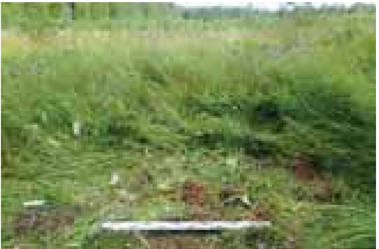
Илл. 275. Ленинградская область. Кингисеппский муниципальный район. «Проектируемое строительство трубопровода метанола от промышленной площадки ООО «ПГ «Фосфорит» до терминала «ЕвроХим терминал Усть-Луга». Шурф №31. Рекультивация. Вид с юга. 437
