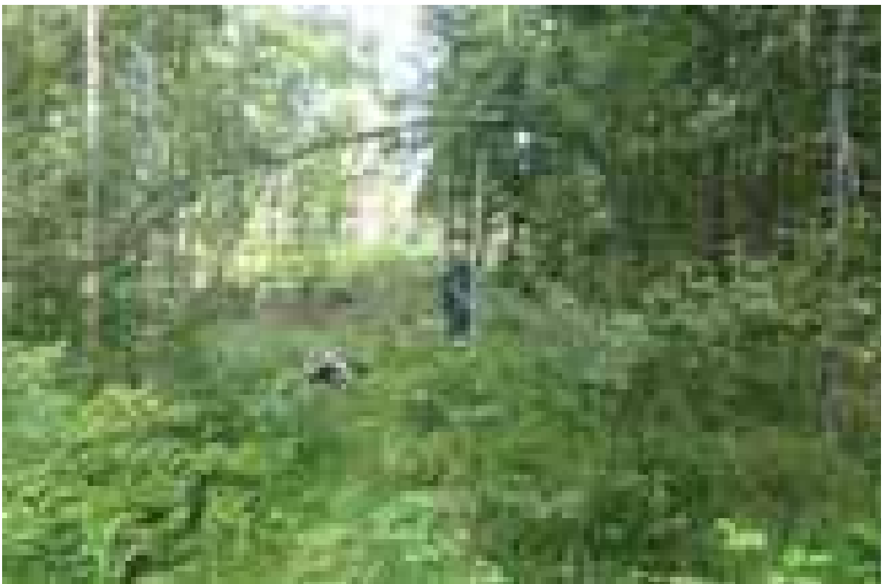
Илл. 350. Ленинградская область. Кингисеппский муниципальный район. «Проектируемое строительство трубопровода метанола от промышленной площадки ООО «ПГ «Фосфорит» до терминала «ЕвроХим терминал Усть-Луга». Шурф №43. Месторасположение. Вид с юга.
