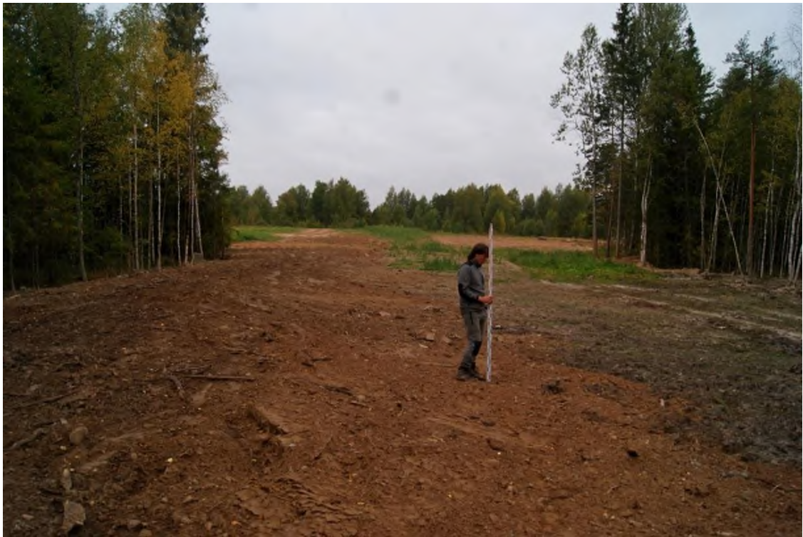
Рис. 206. Объект «Реконструкция ЕСГ Северо-Западного региона для обеспечения транспортировки этансодержащего газа по побережью Балтийского моря» (км 332,0-км 850,0 (до КПЭГ). Ленинградская область. Фотофиксация 2019 г. Комплекс памятников у дер. Городище: «Курганный могильник Бесовы Харчевни», «Курганный и грунтовый могильник Красня Заря». Вид с В на центральную часть памятника.
