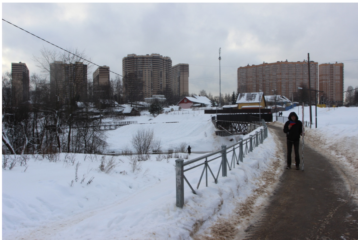
Рис. 27. ВЛ Пискаревка-Девяткино (Девяткинская-2)-2022. Точка фотофиксации 6, вид на запад.
