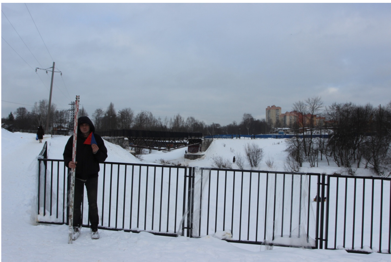
Рис. 29. ВЛ Пискаревка-Девяткино (Девяткинская-2)-2022. Точка фотофиксации 7, вид на север.
