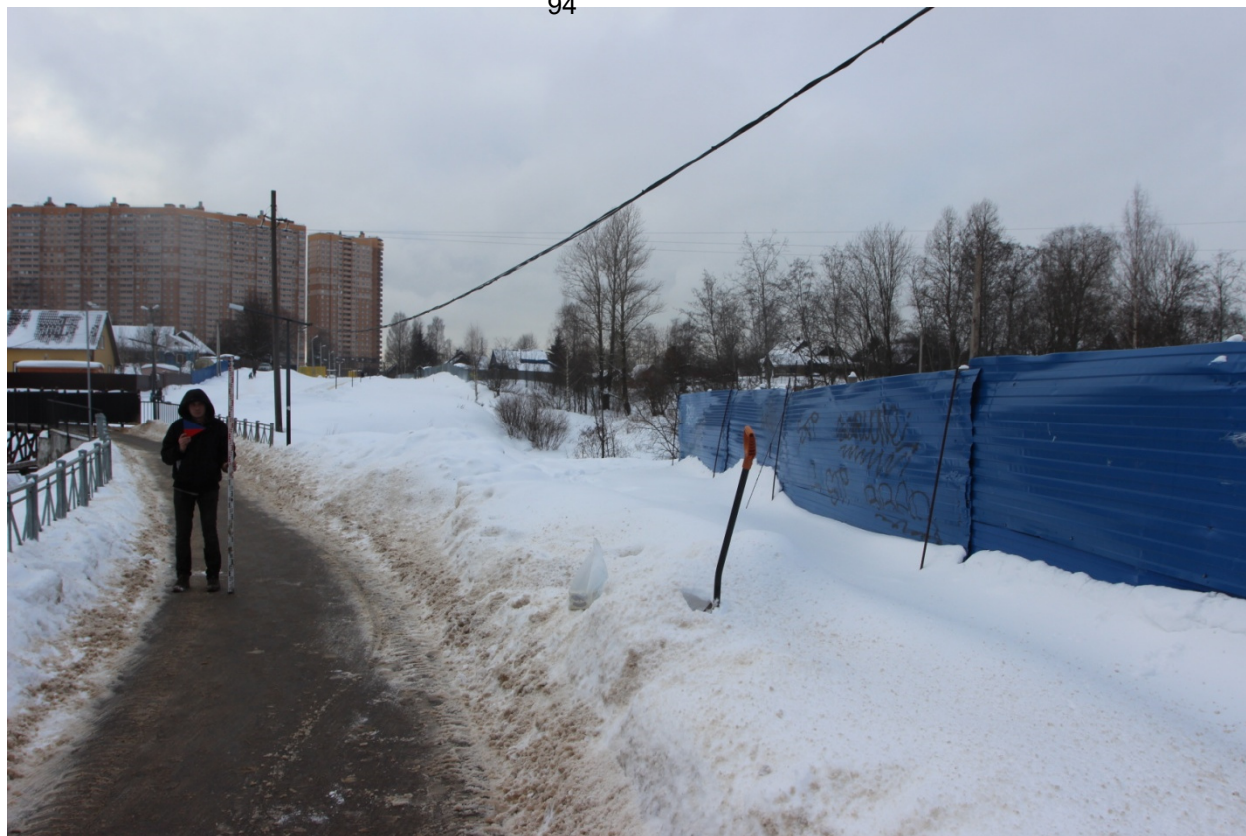
Рис. 26. ВЛ Пискаревка-Девяткино (Девяткинская-2)-2022. Точка фотофиксации 6, вид на запад.
