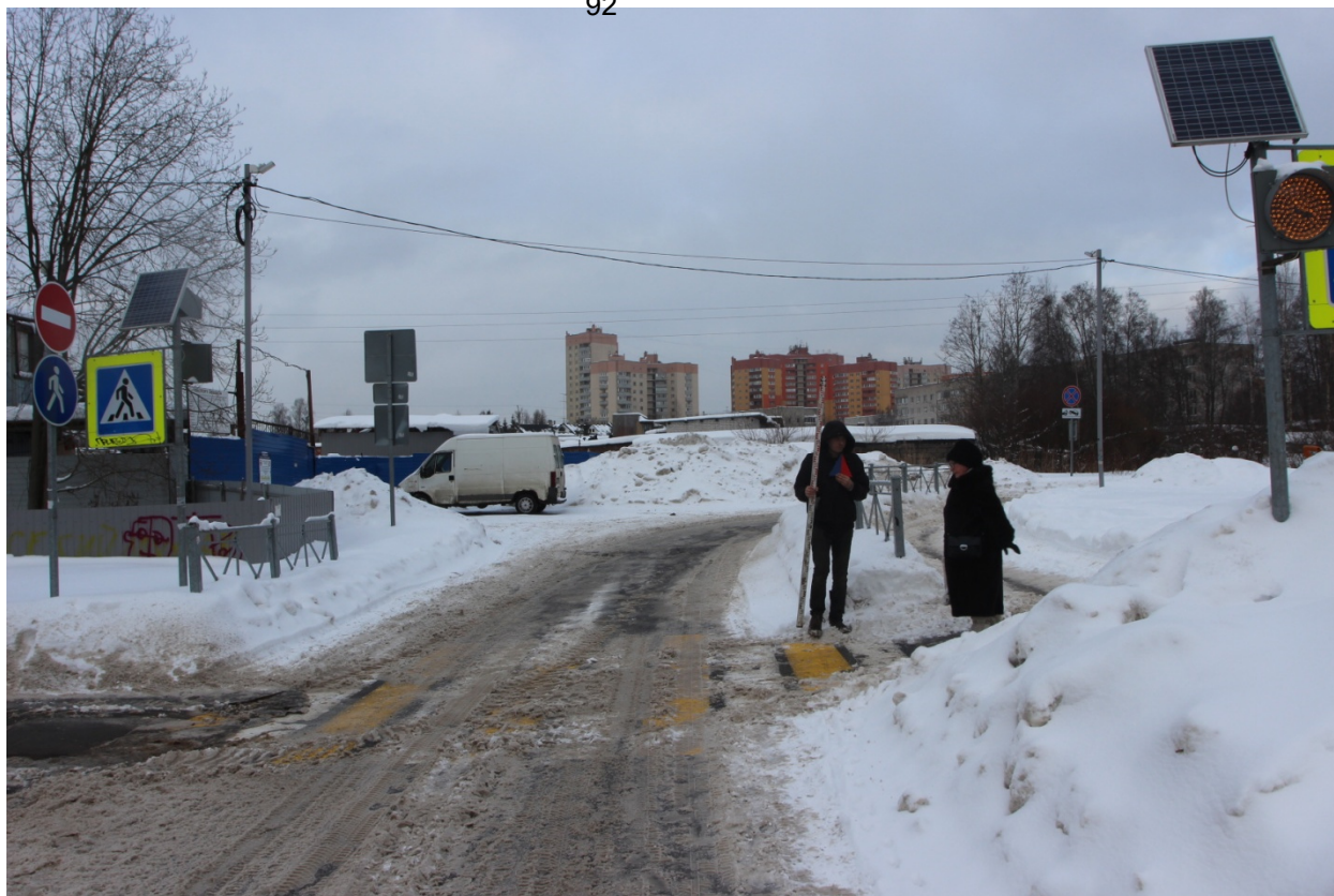
Рис. 22. ВЛ Пискаревка-Девяткино (Девяткинская-2)-2022. Точка фотофиксации 5, вид на север.
