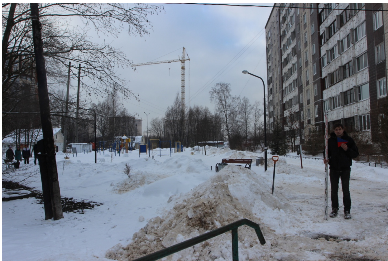
Рис. 21. ВЛ Пискаревка-Девяткино (Девяткинская-2)-2022. Точка фотофиксации 4, вид на запад.
