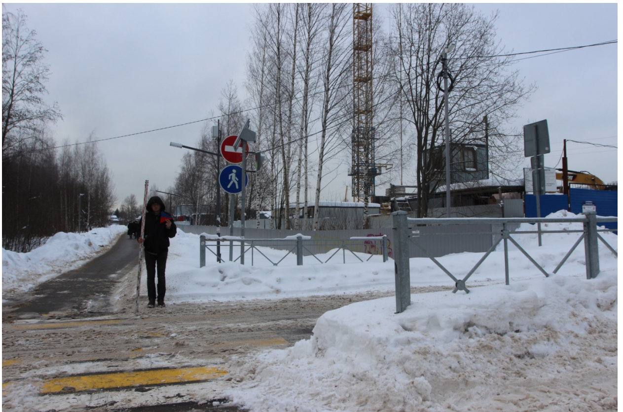
Рис. 25. ВЛ Пискаревка-Девяткино (Девяткинская-2)-2022. Точка фотофиксации 5, вид на запад.
