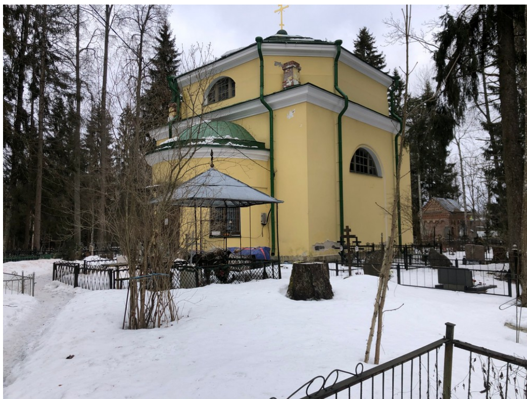
24. Село Рождествено. Вид на церковь Вознесения Господня в сторону северо-востока. 15.03.2021. Фото:Петухова Н.М.
