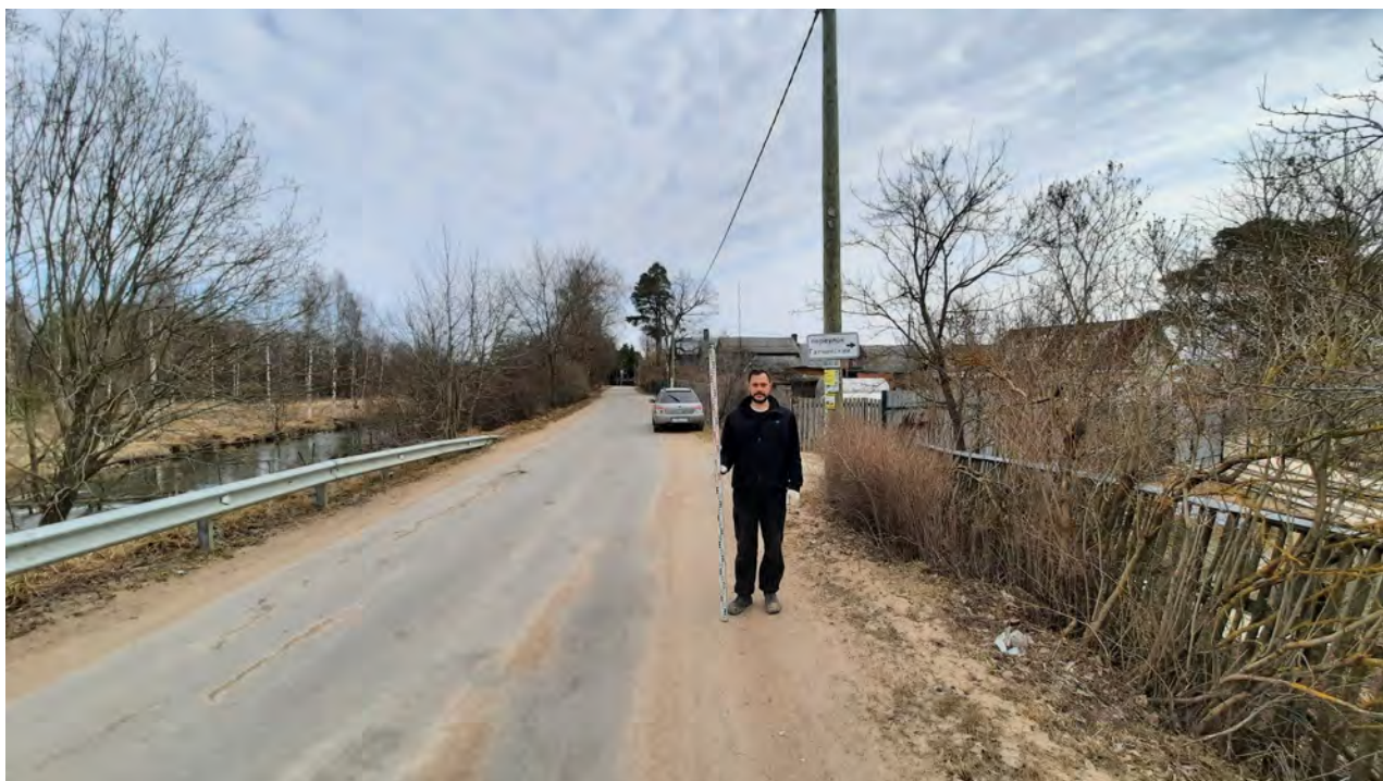
Илл.78. Ленинградская обл, Гатчинский р-н, д. Мыза-Ивановка-2021. Точка фотофиксации 34. Вид с ЮЗ.
