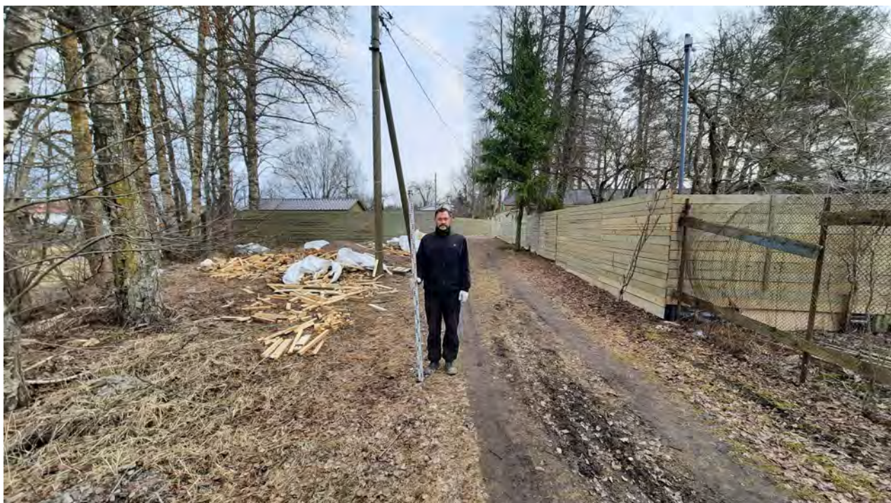
Илл.70. Ленинградская обл, Гатчинский р-н, д. Мыза-Ивановка-2021. Точка фотофиксации 30. Вид с ЮЗ.
