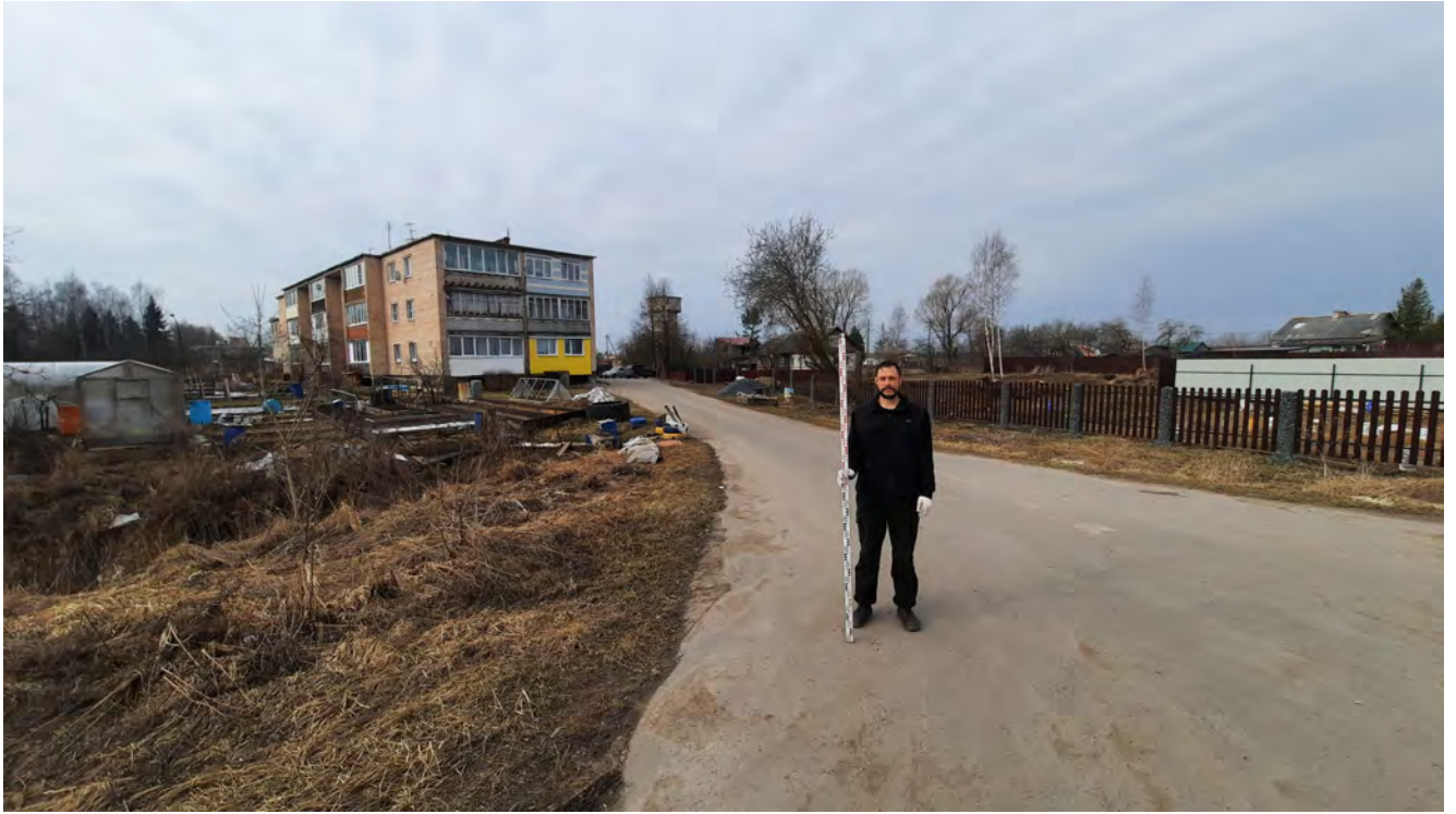
Илл.19. Ленинградская обл., Гатчинский р-н, д. Мыза-Ивановка-2021. Точка фотофиксации 3. Вид с СВ.
