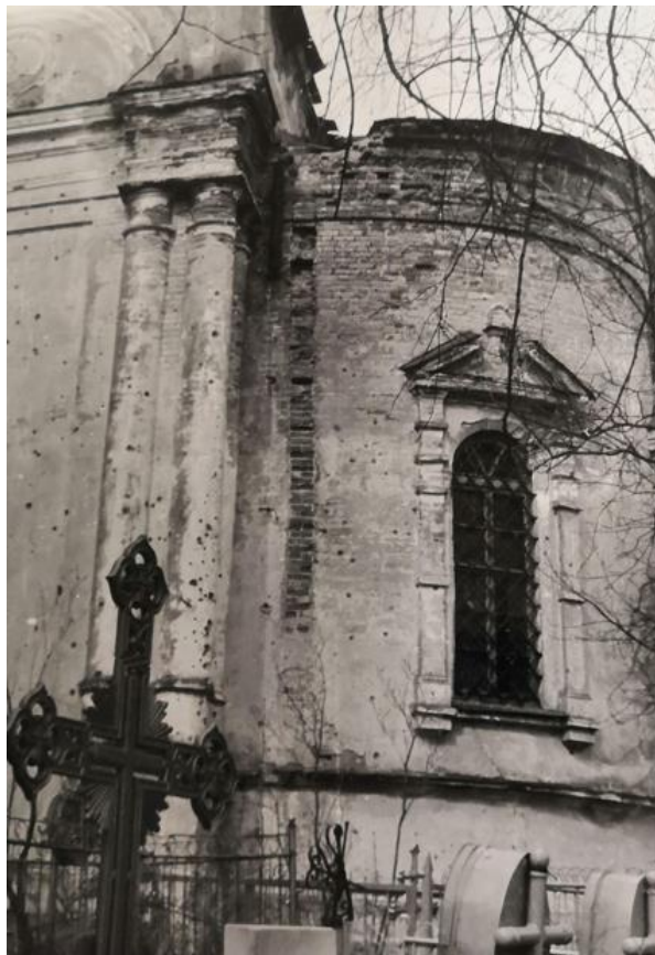
Илл.31. Церковь Иова Многострадального. Фрагмент южного фасада. Примыкание абсиды к основному объему. 1989 г. // Архив Комитета по сохранению культурного наследия Ленинградской области. Д. 699-3.
