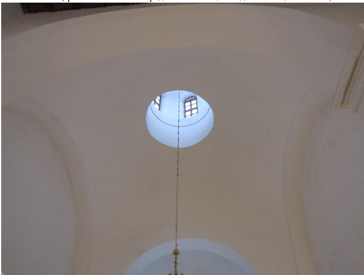
Фото.16. Церковь Иова Многострадального. Вид на своды помещения №3.
