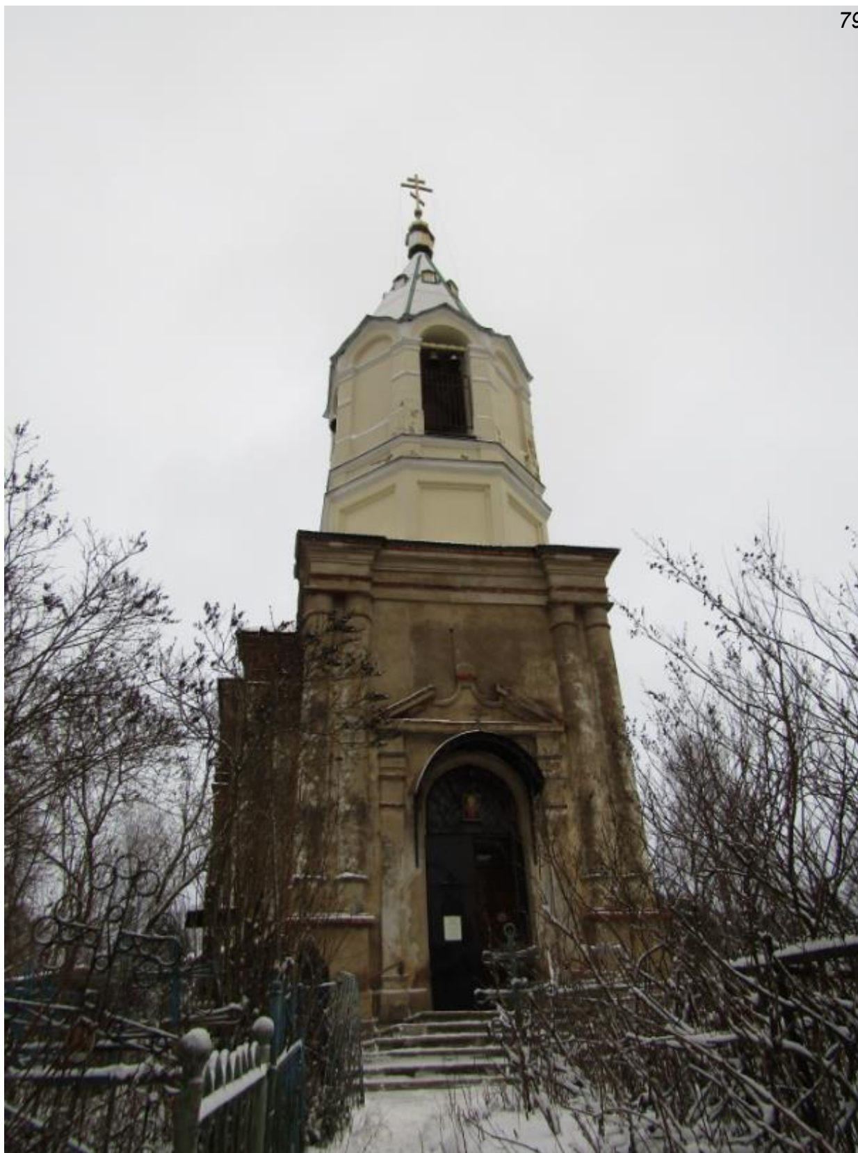
Фото.7. Церковь Иова Многострадального. Западный фасад.
