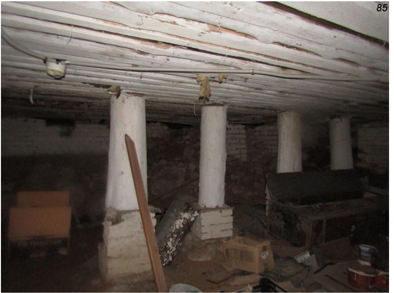
Фото.17. Церковь Иова Многострадального. Вид на подвальные помещения.
