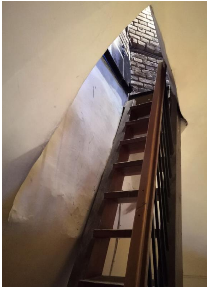
Фото.29. Церковь Иова Многострадального. Вид на лестницу, ведущую на верхний уровень колокольни.
