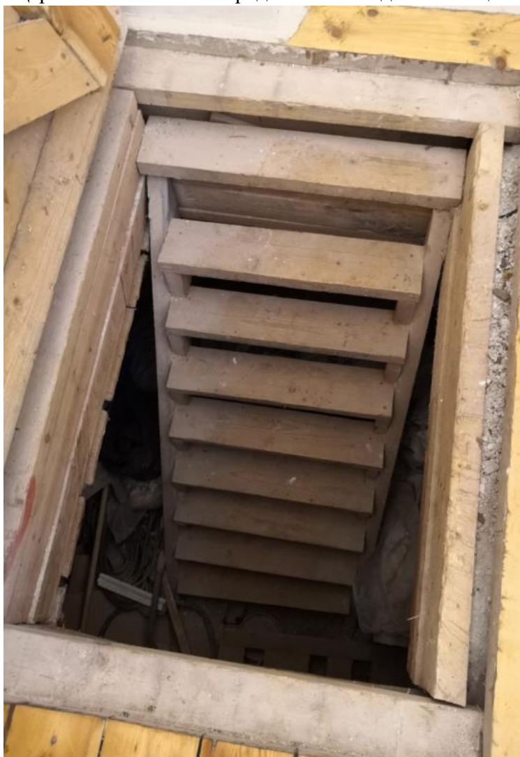
Фото.23. Церковь Иова Многострадального. Вид на вход в подвальные помещения.
