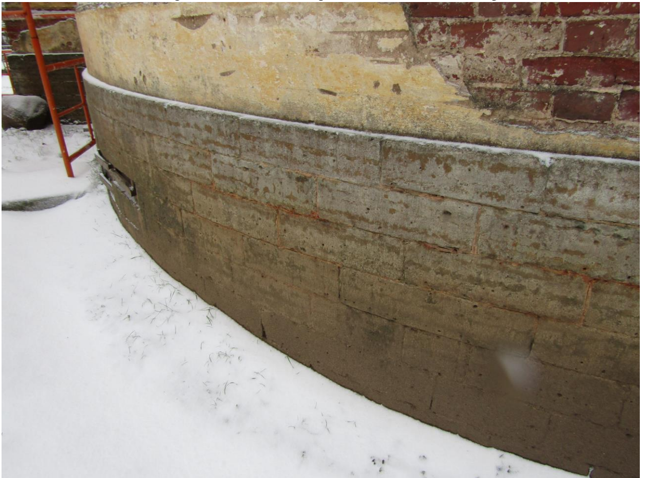
Фото.11. Церковь Иова Многострадального. Цоколь восточного фасада.
