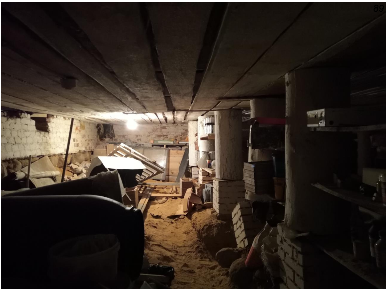
Фото.24. Церковь Иова Многострадального. Вид на подвальные помещения.
