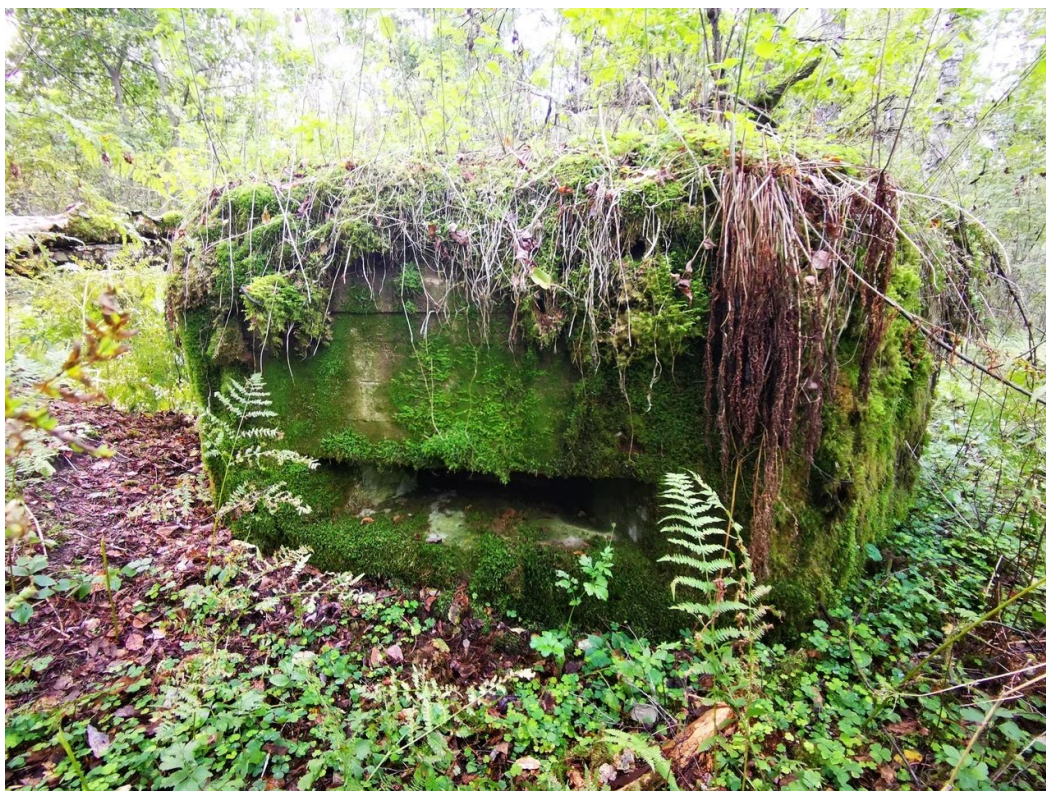
2. Вид на ДОТ со стороны амбразур
