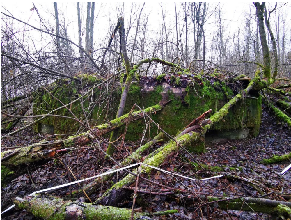
2. Вид на ДОТ со стороны амбразур
