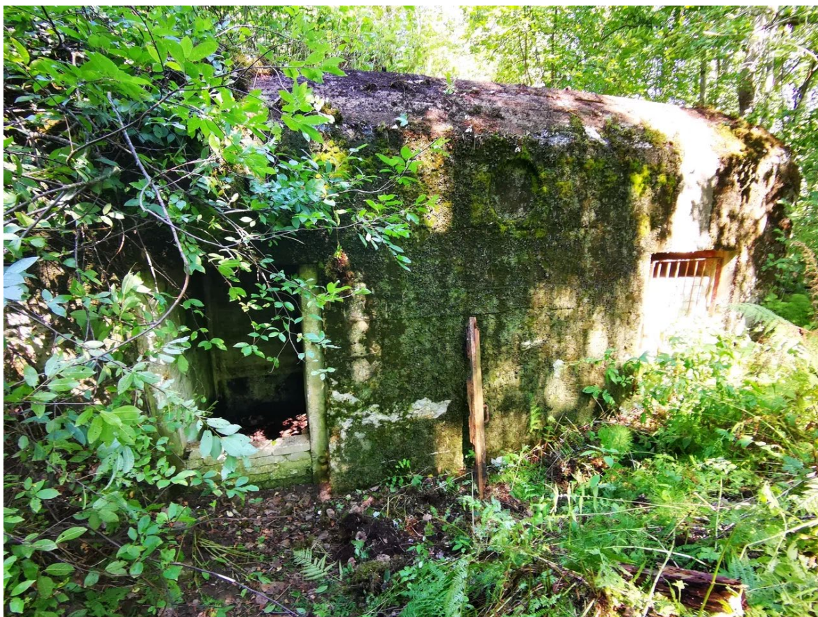
1. Общий вид ДОТ со стороны входа-сквозника.
