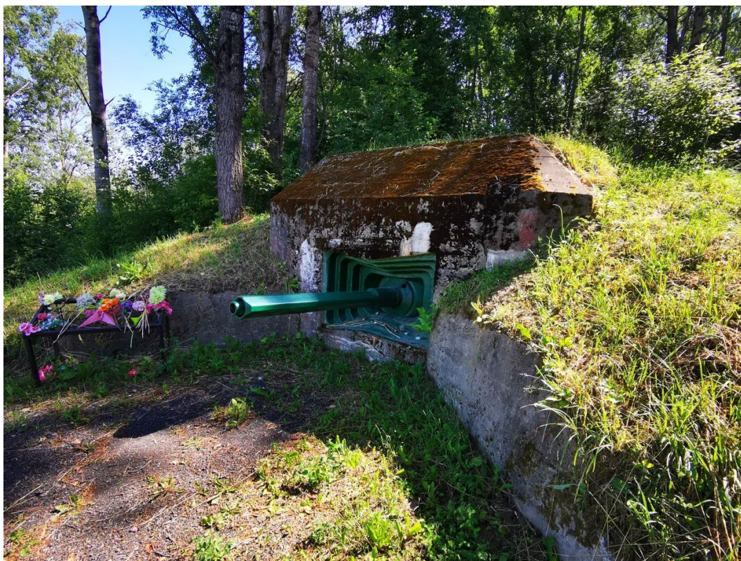
2. Общий вид на ДОТ с северо-запада. Сооружение закрыто и внутренняя съёмка невозможна
