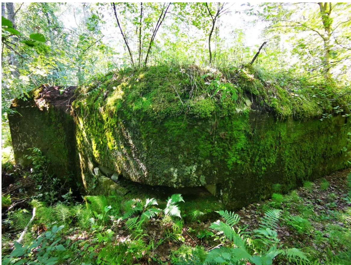
3. Общий вид ДОТ со стороны угловой амбразуры.
