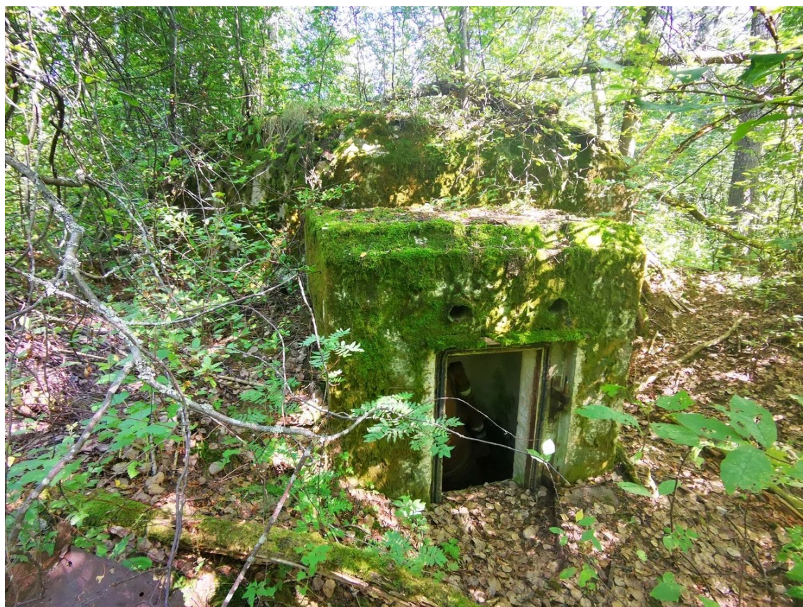
2. Пристройка-тамбур входной группы
