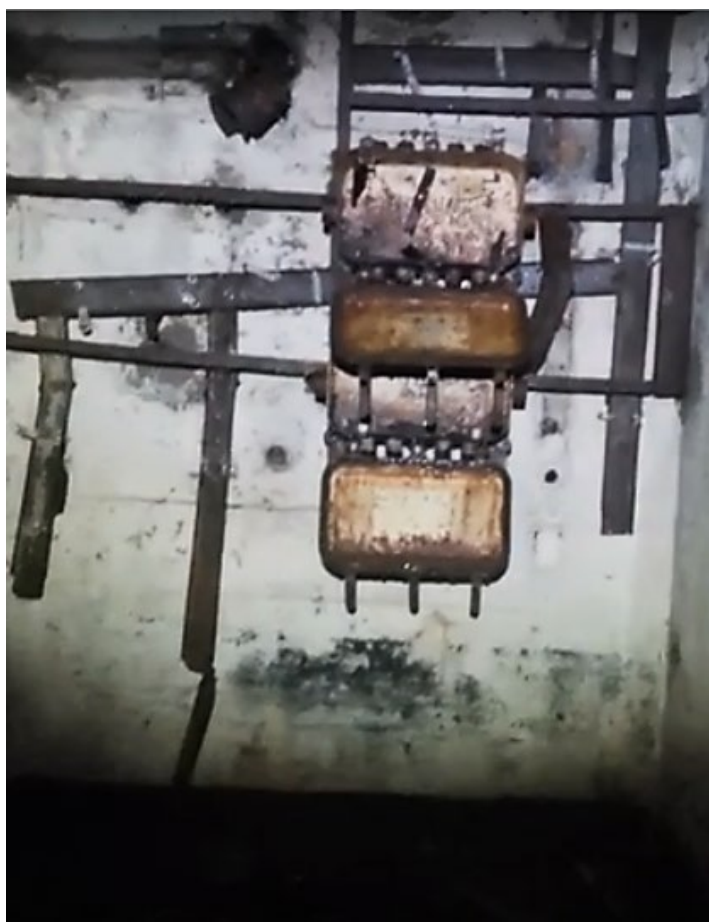
7. Интерьер ДОТ. Фрагменты оборудования.
