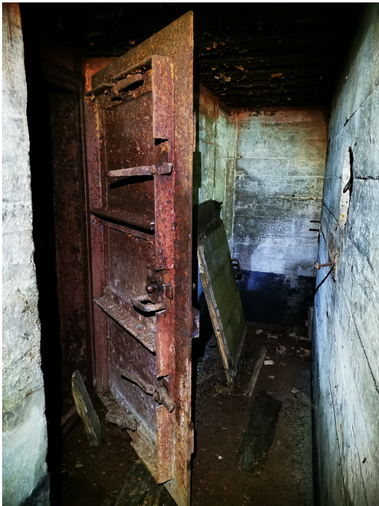
5. Интерьер ДОТ. Коленчатый сквозник и бронированная дверь
