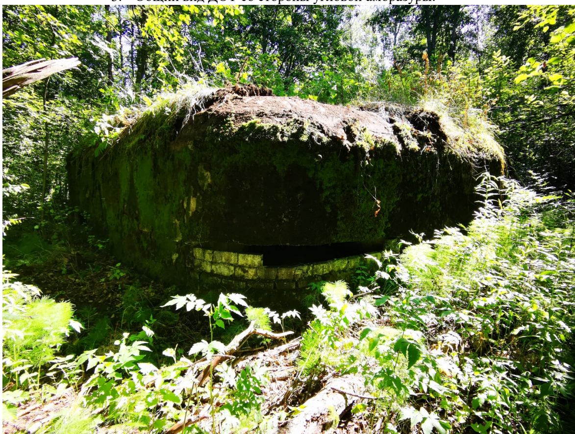
4. Общий вид ДОТ со стороны угловой амбразуры.
