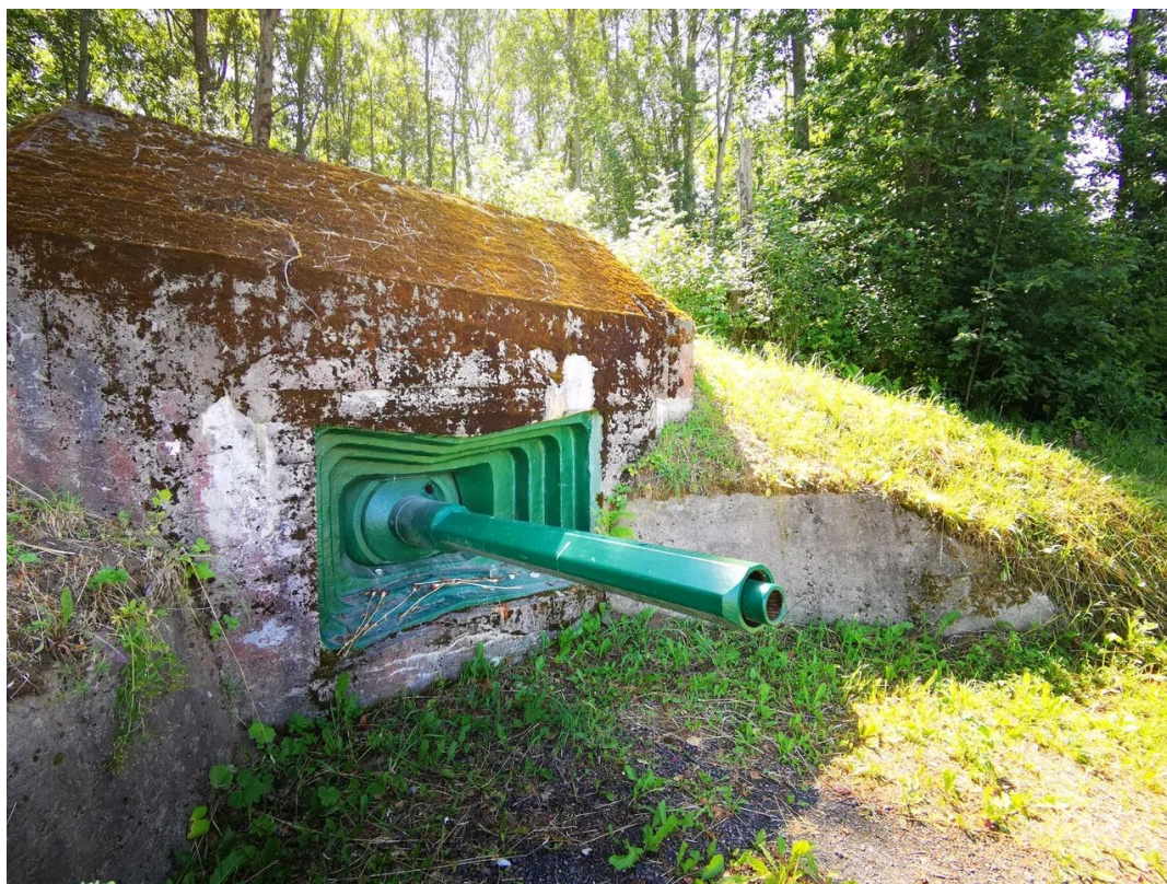
1. Общий вид на ДОТ с северо-востока
