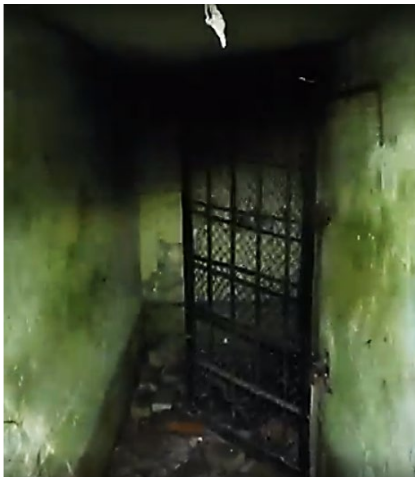
3. Вид на вход в АДОН с противоштурмовой решетчатой дверью
