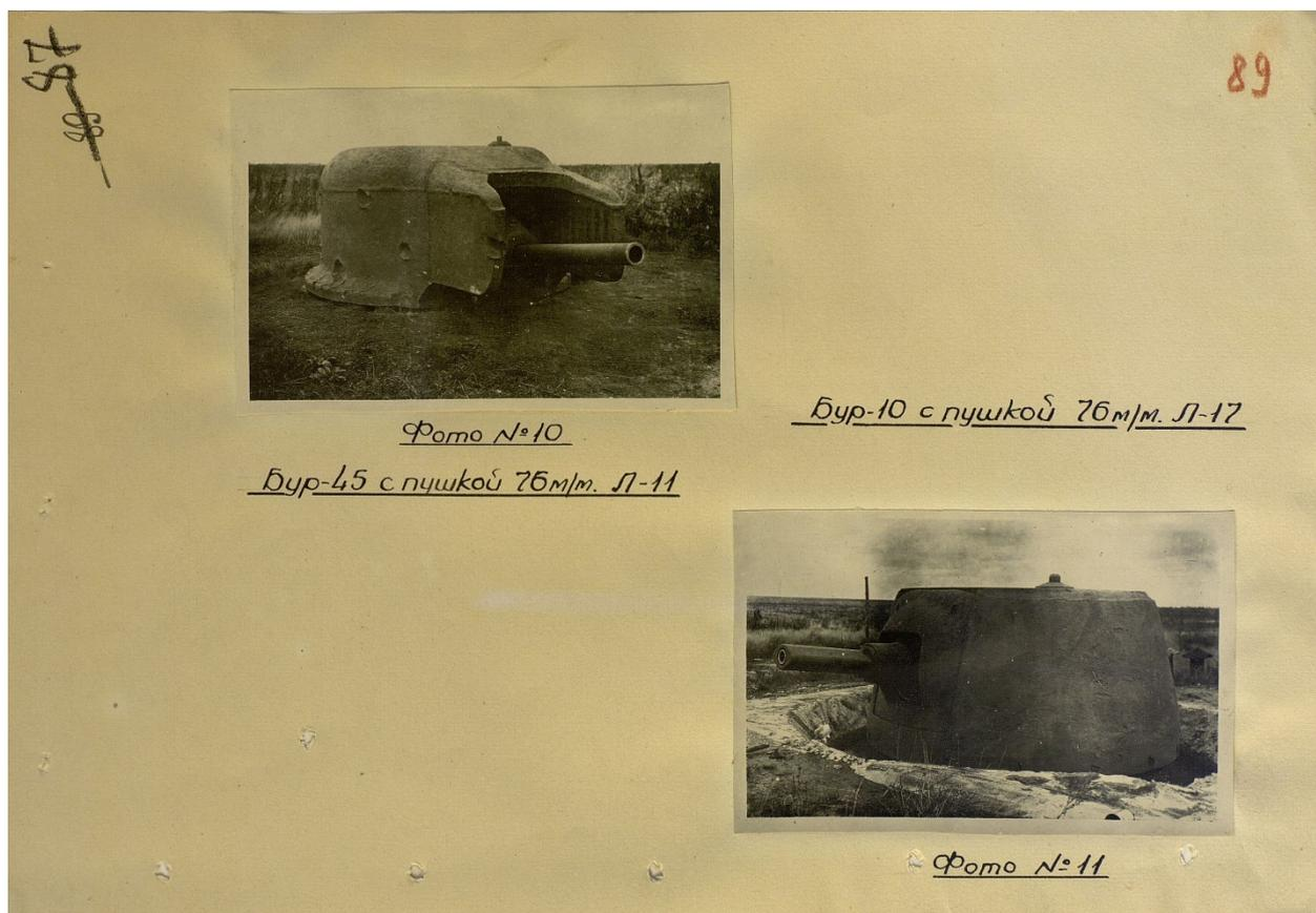
*Экспериментальные бронированные установки для укрепрайонов, построенные и испытанные обстрелом в Карельском укрепленном районе. В годы блокады Ленинграда данные установки стояли на боевом дежурстве на передовой. ЦАМО РФ.*
