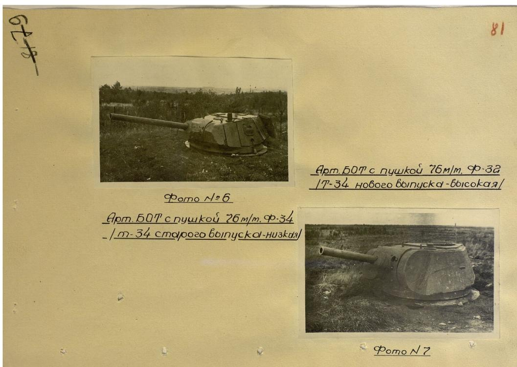
Различные варианты дополнительной брони на башнях от танков Т-28, установленных в Карельском укрепленном районе в качестве танковых огневых точек. Не сохранились. ЦАМО РФ.
