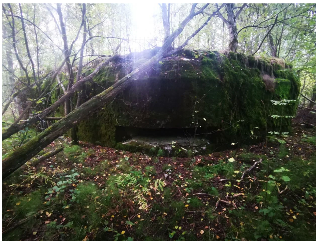
2. Общий вид ДОТ со стороны амбразур
