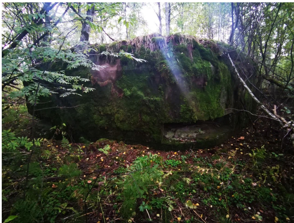
1. Общий вид ДОТ со стороны амбразур
