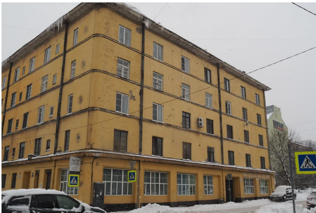
3. «Жилой дом», Ленинградская область, Выборгский район, г. Выборг, ул. Куйбышева, д. 7. Северо-западный фасад. Общий вид. Фото 14.01.2022г.
