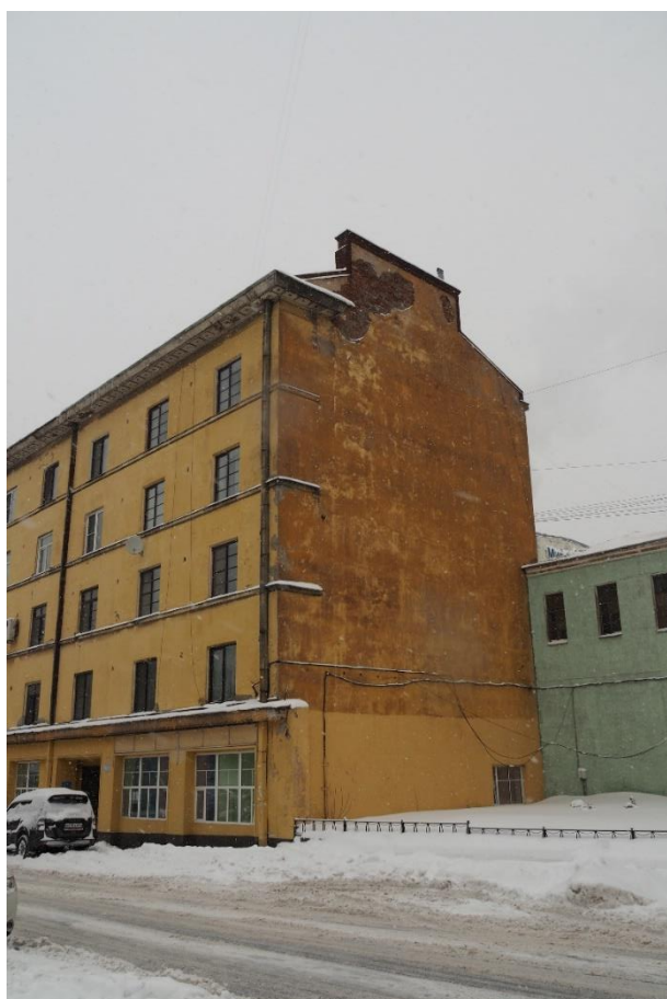
2. «Жилой дом», Ленинградская область, Выборгский район, г. Выборг, ул. Куйбышева, д. 7. Южный фасад. Общий вид. Фото 14.01.2022г.
