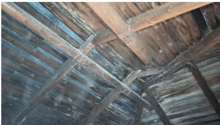
24. «Жилой дом», Ленинградская область, Выборгский район, г. Выборг, ул. Куйбышева, д. 7. Чердак. Фрагмент. Фото 14.01.2022г.
