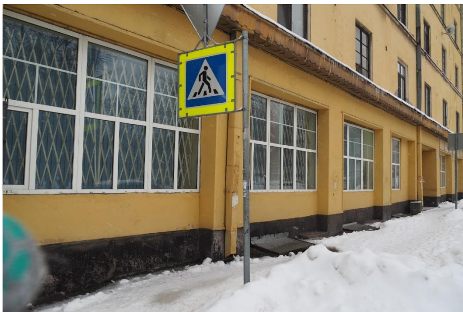
9. «Жилой дом», Ленинградская область, Выборгский район, г. Выборг, ул. Куйбышева, д. 7. Северо-западный фасад. Фрагмент. Фото 14.01.2022г.
