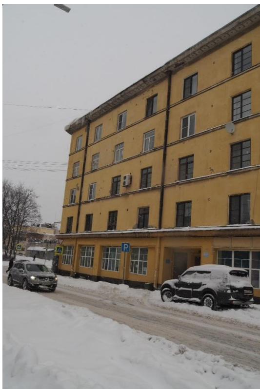
7. «Жилой дом», Ленинградская область, Выборгский район, г. Выборг, ул. Куйбышева, д. 7. Северо-западный фасад. Фрагмент. Фото 14.01.2022г.
