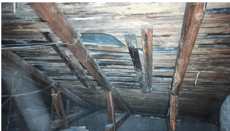
23. «Жилой дом», Ленинградская область, Выборгский район, г. Выборг, ул. Куйбышева, д. 7. Чердак. Фрагмент. Фото 14.01.2022г.
