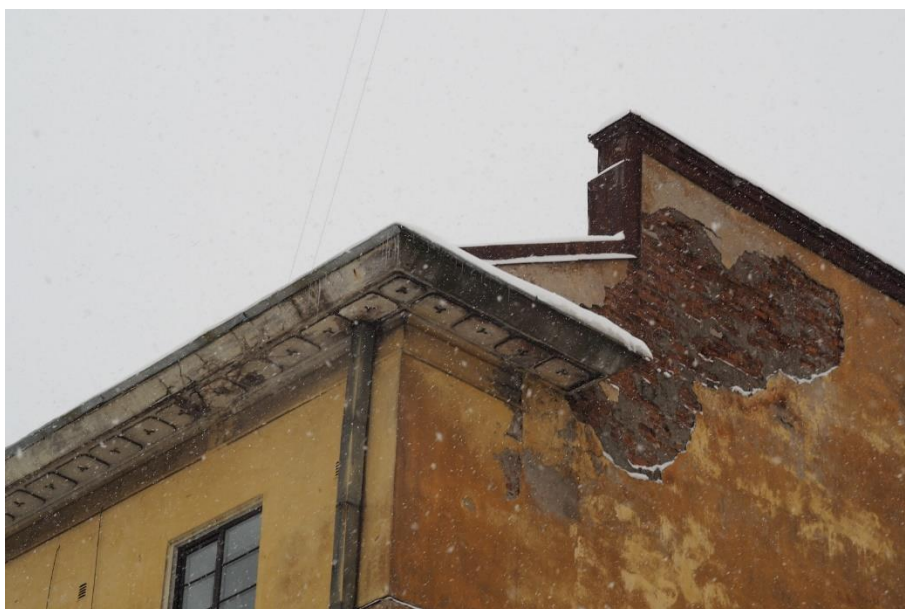
10. «Жилой дом», Ленинградская область, Выборгский район, г. Выборг, ул. Куйбышева, д. 7. Южный фасад. Фрагмент. Фото 14.01.2022г.
