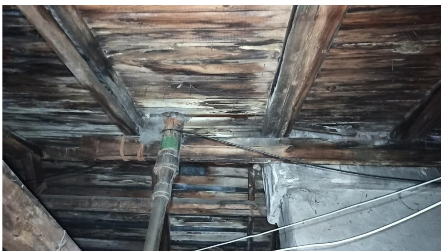
25. «Жилой дом», Ленинградская область, Выборгский район, г. Выборг, ул. Куйбышева, д. 7. Чердак. Фрагмент. Фото 14.01.2022г.
