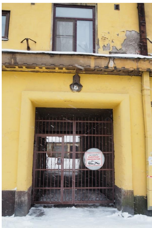
20. «Жилой дом», Ленинградская область, Выборгский район, г. Выборг, ул. Куйбышева, д. 7. Северный фасад. Фрагмент. Фото 14.01.2022г.
