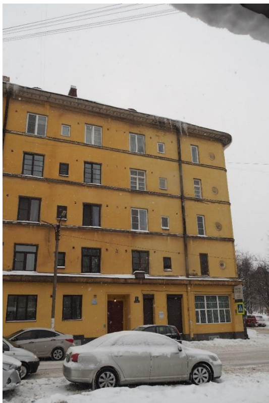
14. «Жилой дом», Ленинградская область, Выборгский район, г. Выборг, ул. Куйбышева, д. 7. Северный фасад. Фрагмент. Фото 14.01.2022г.
