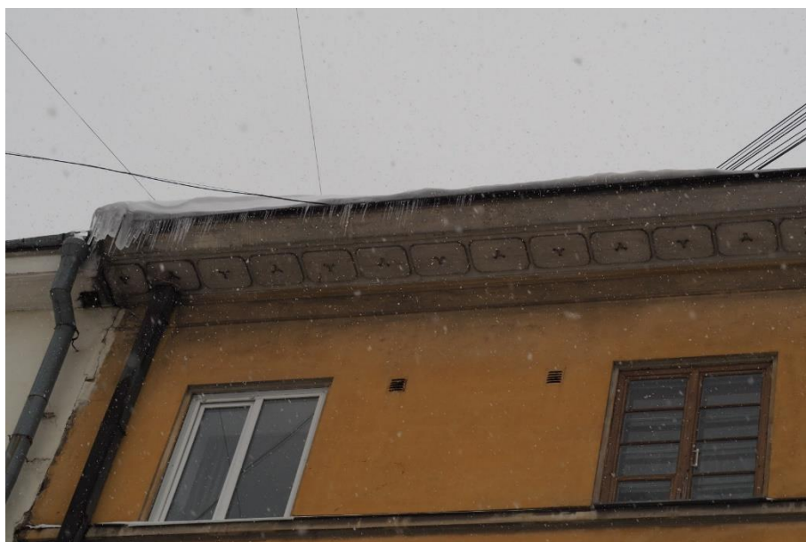
18. «Жилой дом», Ленинградская область, Выборгский район, г. Выборг, ул. Куйбышева, д. 7. Северный фасад. Фрагмент. Фото 14.01.2022г.
