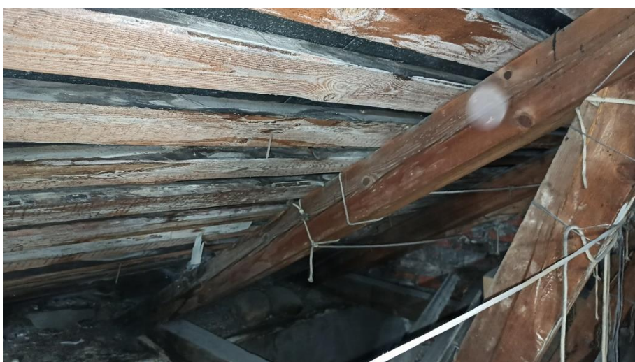
26. «Жилой дом», Ленинградская область, Выборгский район, г. Выборг, ул. Куйбышева, д. 7. Чердак. Фрагмент. Фото 14.01.2022г.
