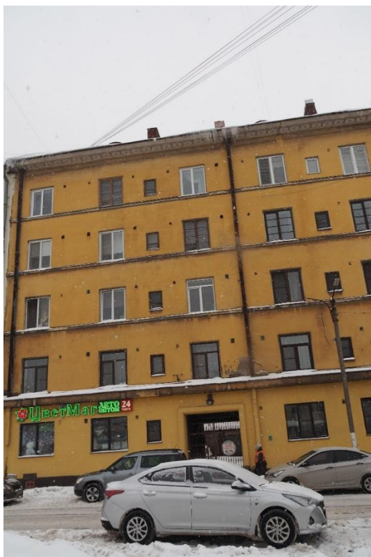
13. «Жилой дом», Ленинградская область, Выборгский район, г. Выборг, ул. Куйбышева, д. 7. Северный фасад. Фрагмент. Фото 14.01.2022г.
