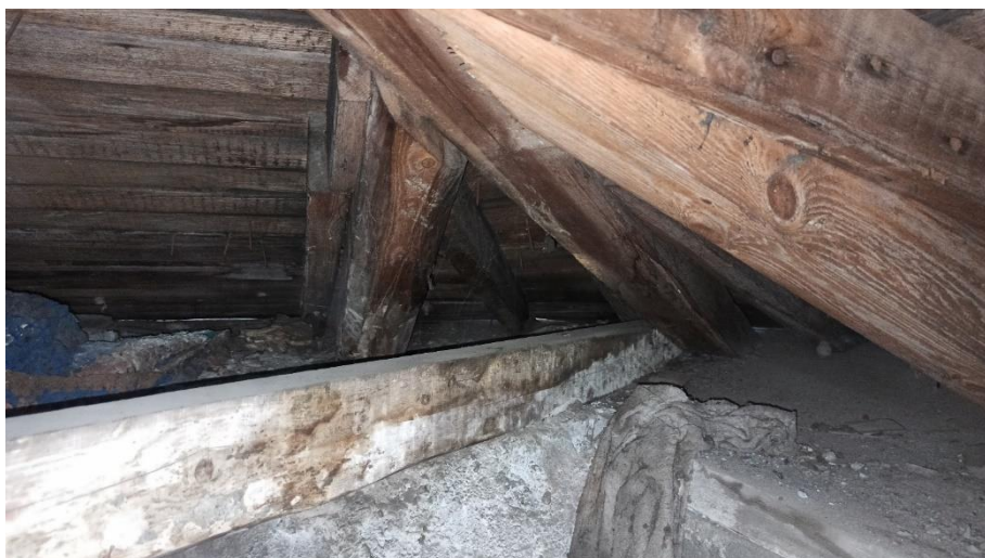
22. «Жилой дом», Ленинградская область, Выборгский район, г. Выборг, ул. Куйбышева, д. 7. Чердак. Фрагмент. Фото 14.01.2022г.
