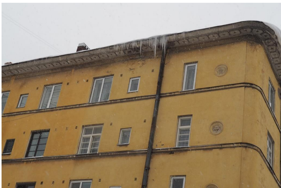
12. «Жилой дом», Ленинградская область, Выборгский район, г. Выборг, ул. Куйбышева, д. 7. Северный фасад. Фрагмент. Фото 14.01.2022г.
