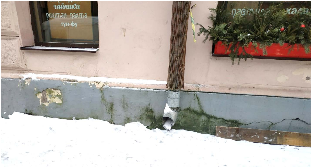
5. Объект культурного наследия регионального значения «Дом А. В. Шушина (Кихльгрена)». Центральная часть фасада по Крепостной ул. Трещины и биопоражения на цоколе, утраты штукатурного покрытия.
