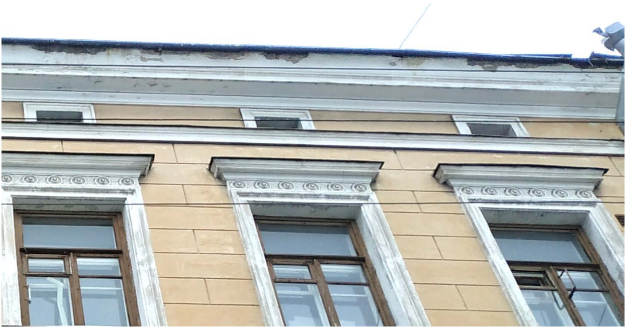
4. Объект культурного наследия регионального значения «Дом А. В. Пушкина (Кихльгрена)». Центральная часть фасада по Крепостной ул. Утраты фрагментов венчающего карниза.
