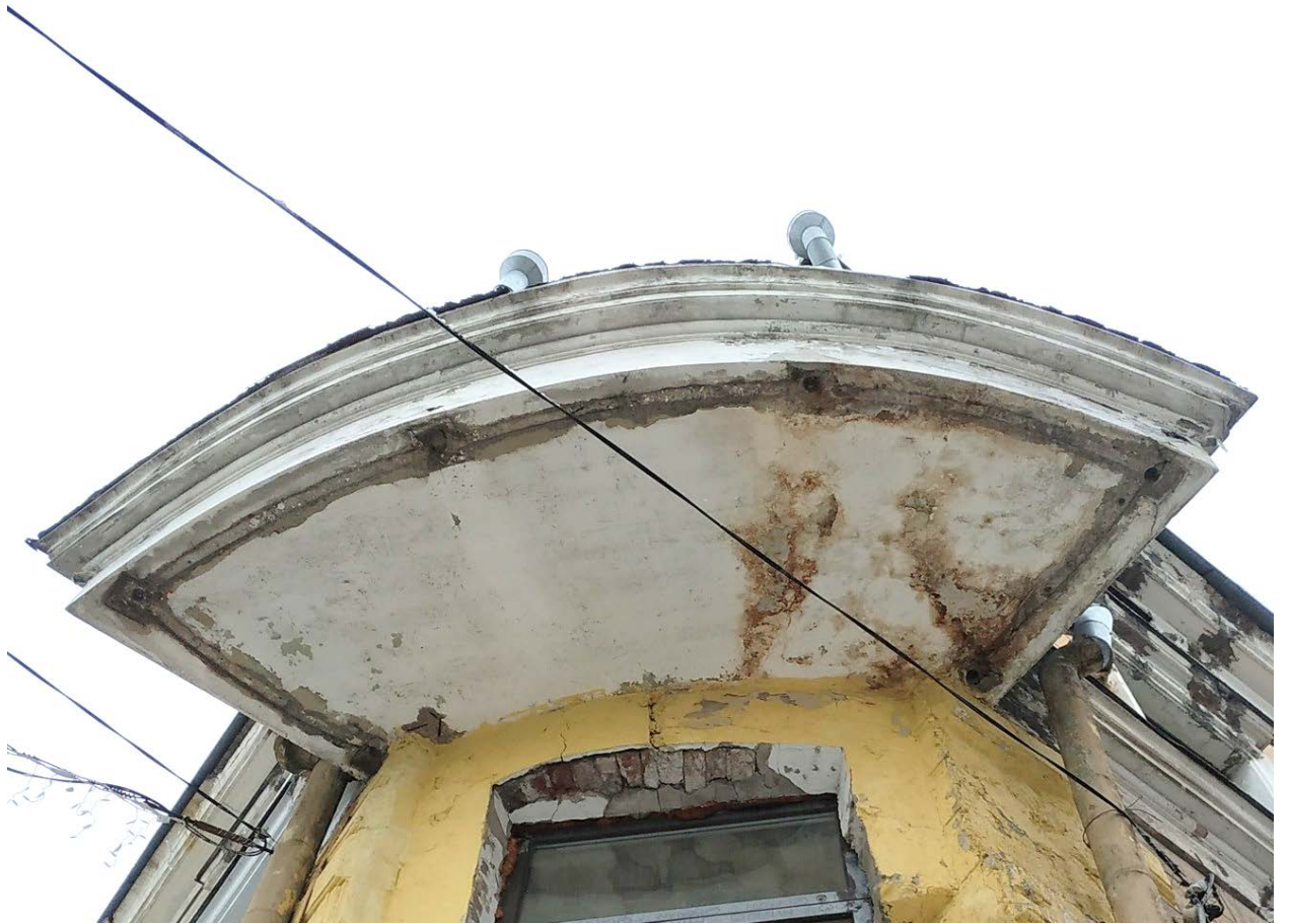
10. Объект культурного наследия регионального значения «Дом А. В. Шушина (Кихлыгрена)». Угловой фасад. На основании балкона 3 этажа – со следами коррозии. Сохранились отверстия крепления столбов утраченного балкона 2 этажа. Наблюдаются сквозные трещины под балконом и на перемычке 2 этажа.
