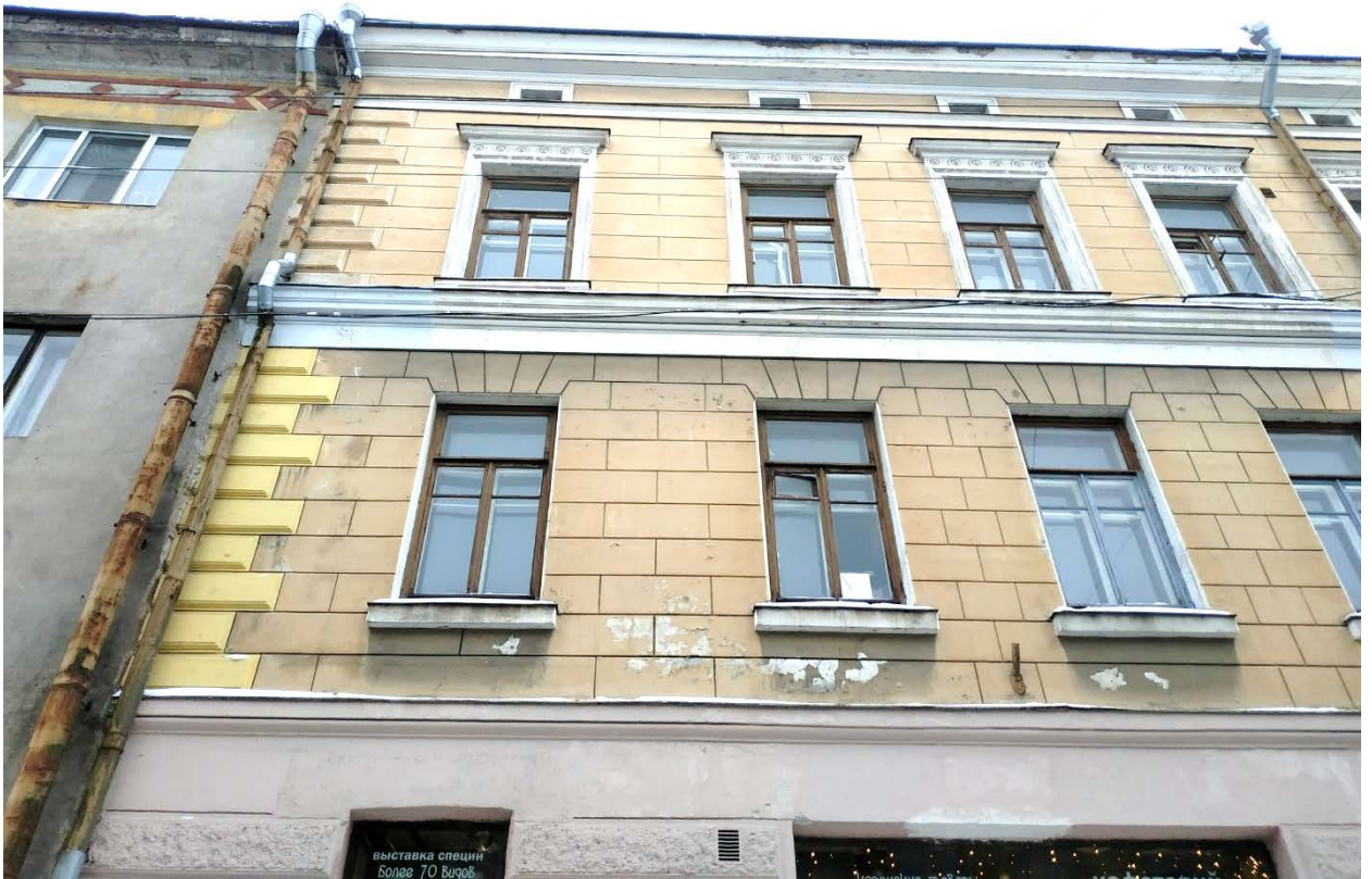
2. Объект культурного наследия регионального значения «Дом А. В. Шушина (Кихльгрена)». Южная часть фасада по Крепостной ул. Наблюдается шелушение и утраты окрасочного слоя, сильное загрязнение фасада, неоднородное окрашивание.
