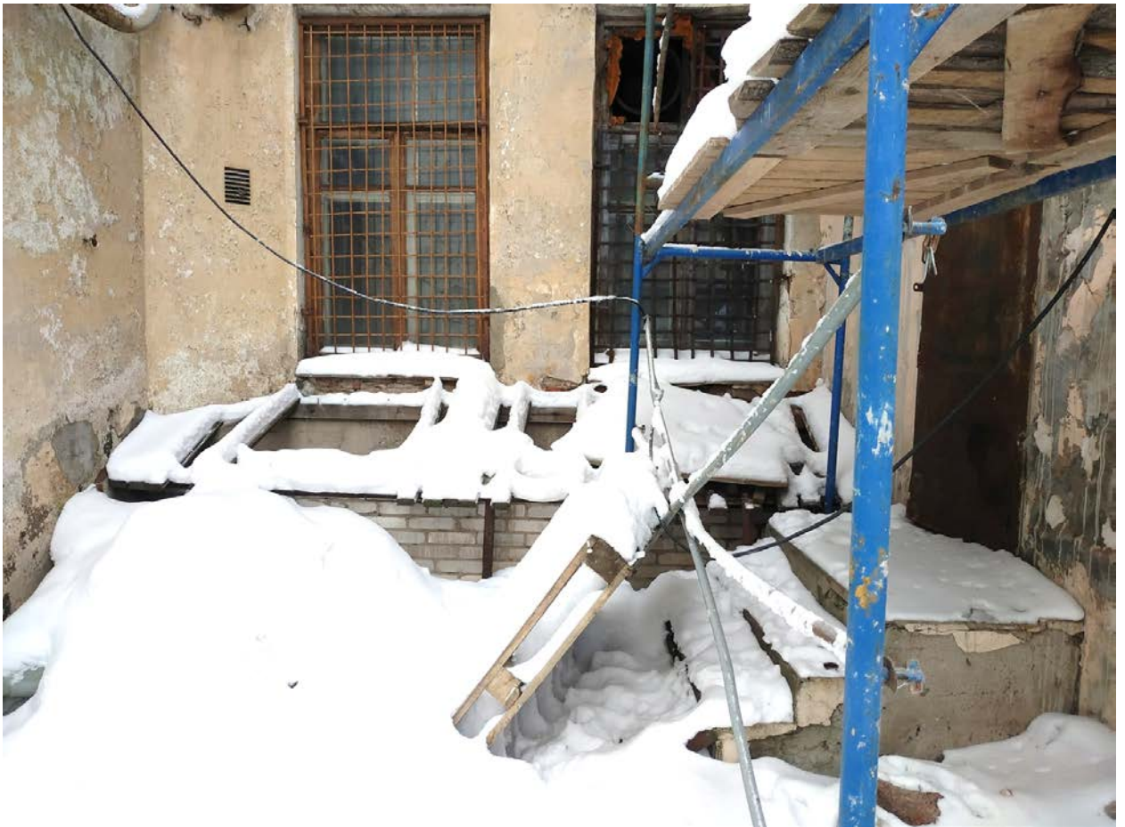
25. Объект культурного наследия регионального значения «Дом А. В. Шушина (Кихльгрена)». Дворовый фасад. Позднее крыльцо (в кадре справа) и пристройка из силикатного кирпича в уровне цокольного этажа (в кадре слева).
