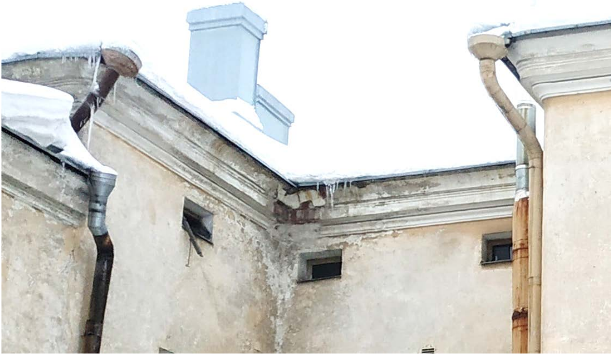
24. Объект культурного наследия регионального значения «Дом А. В. Шушина (Кихлыгрена)». Разрушение карниза со стороны дворового фасада.
