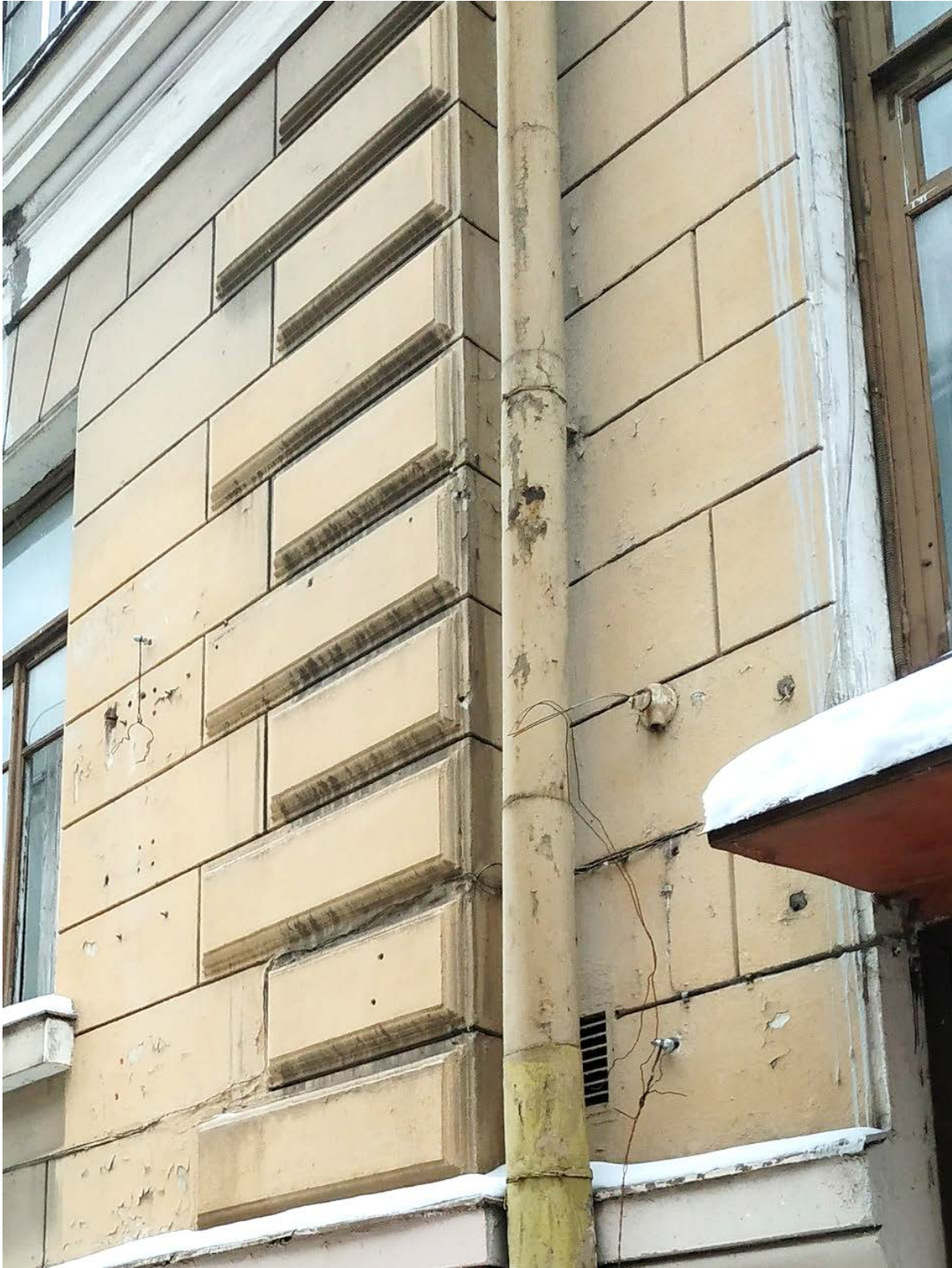
21. Объект культурного наследия регионального значения «Дом А. В. Пушкина (Кихльгрена)». Центральная часть фасада по Красноармейской ул. Наблюдается значительное загрязнение, шелушение окрасочного слоя, многочисленные отверстия - следы монтажа временных конструкций.
