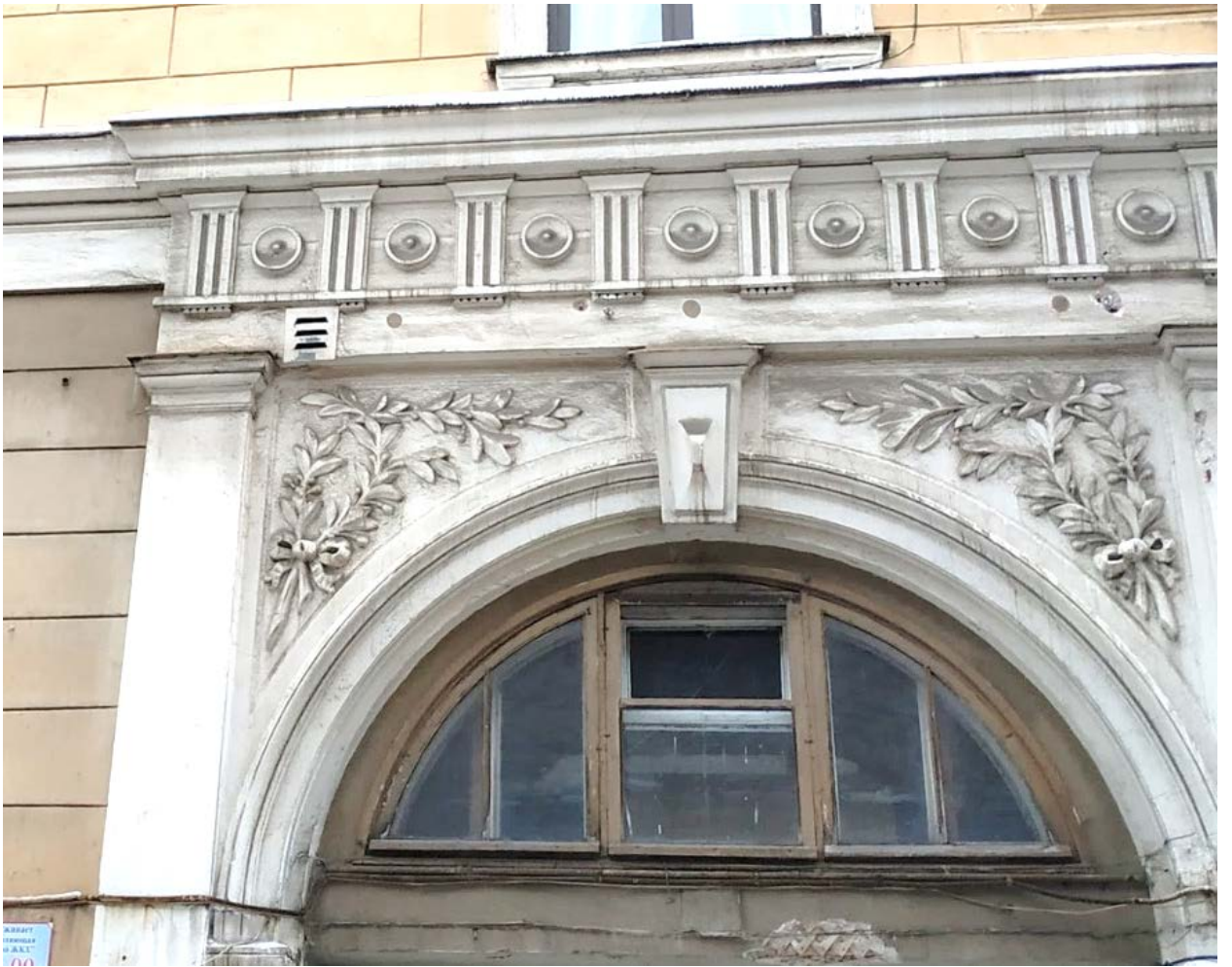
19. Объект культурного наследия регионального значения «Дом А. В. Шушина (Кихльгрена)». Фасад по Красноармейской ул. Лепной декор портала арки (наблюдается сильное загрязнение).
