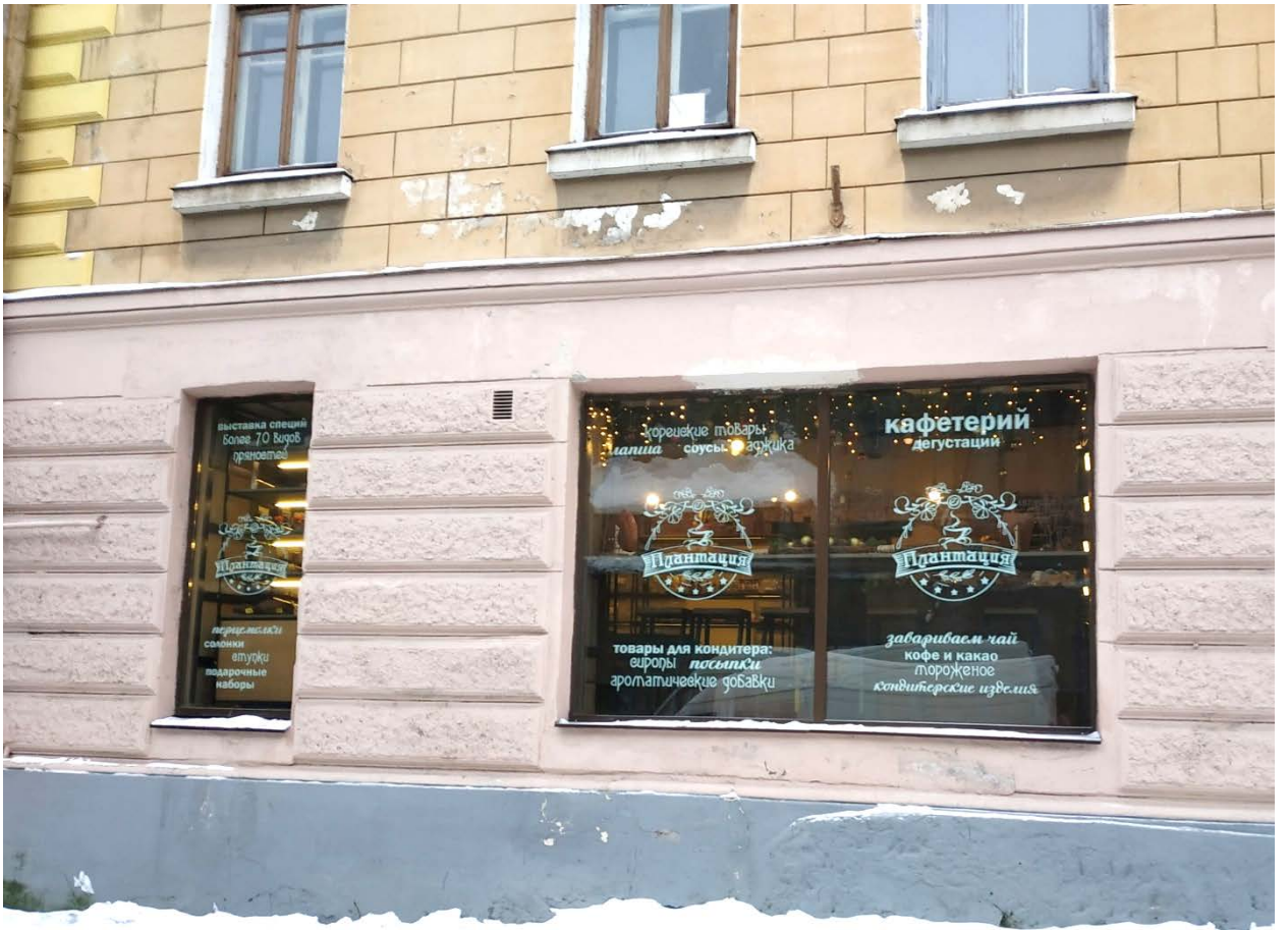
3. Объект культурного наследия регионального значения «Дом А. В. Шушина (Кихльгрена)». Южная часть фасада по Крепостной ул. в уровне 1 этажа.
