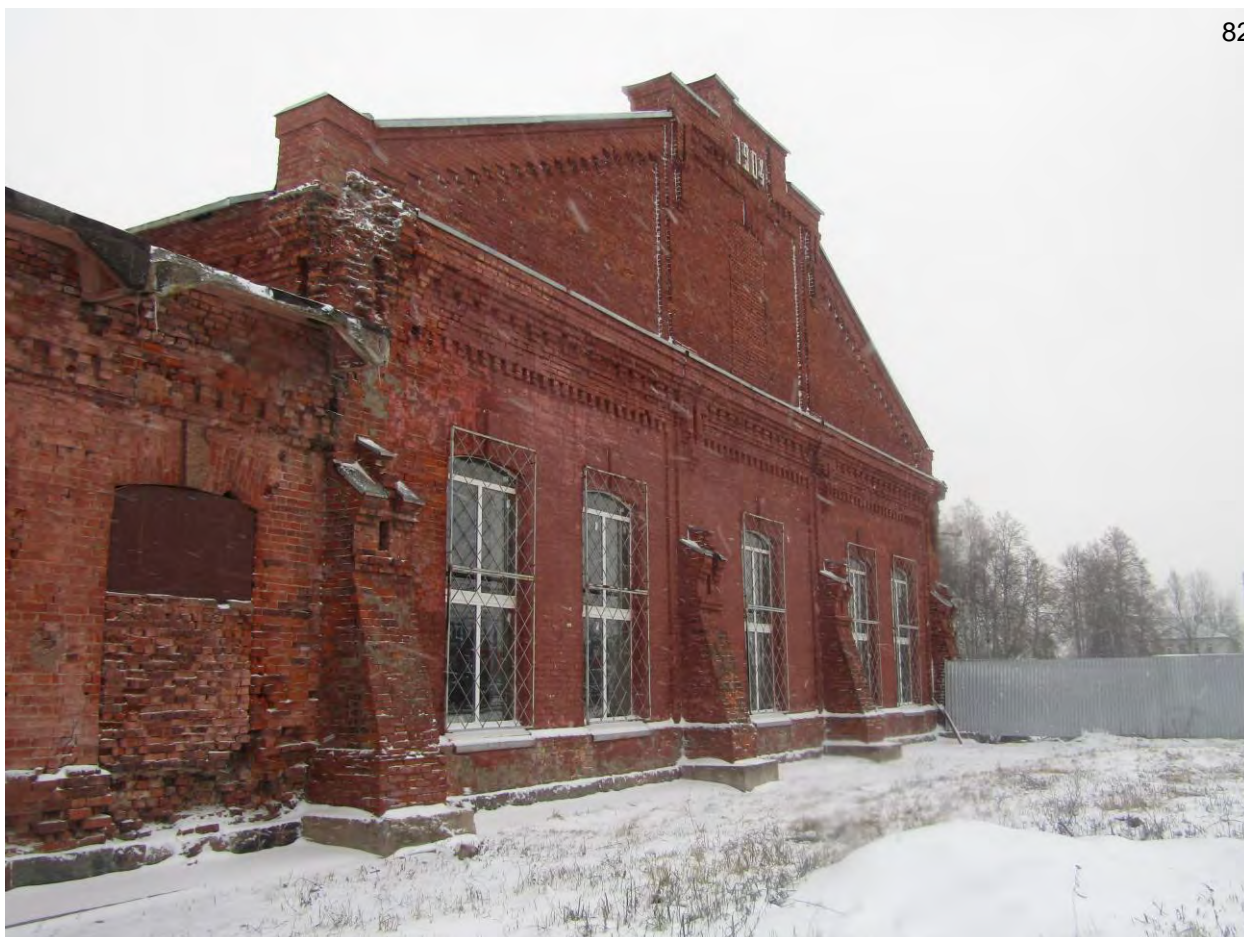
Фото.31. Веерное депо. Вид на торцевой южный фасад. Фрагмент.
