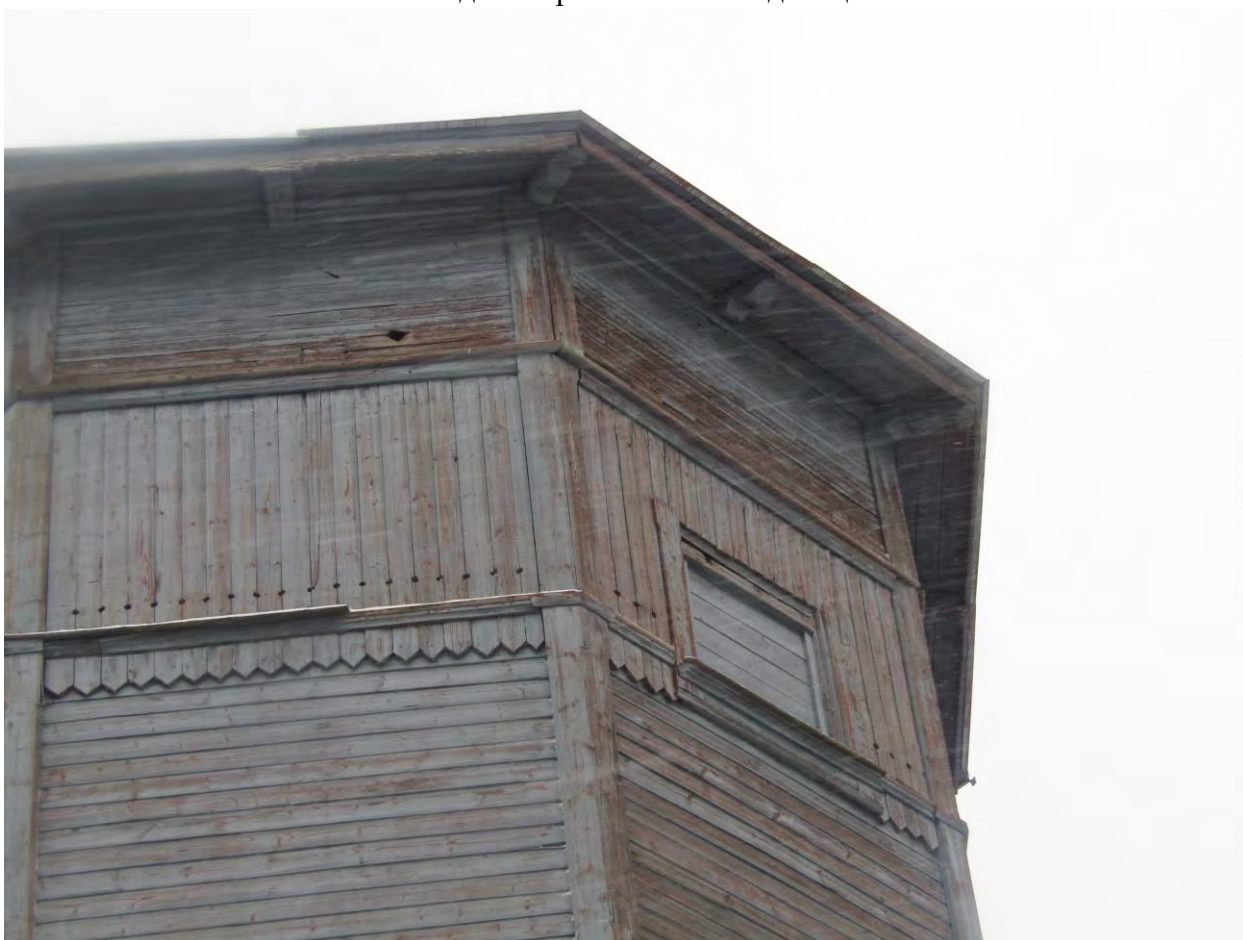
Фото.47. Водонапорная башня. Вид на карниз.
