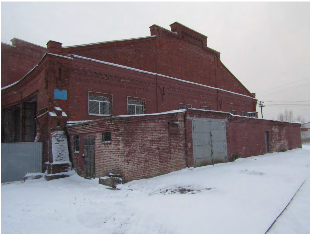
Фото.1. Веерное депо. Северо-восточный торцевой фасад.
