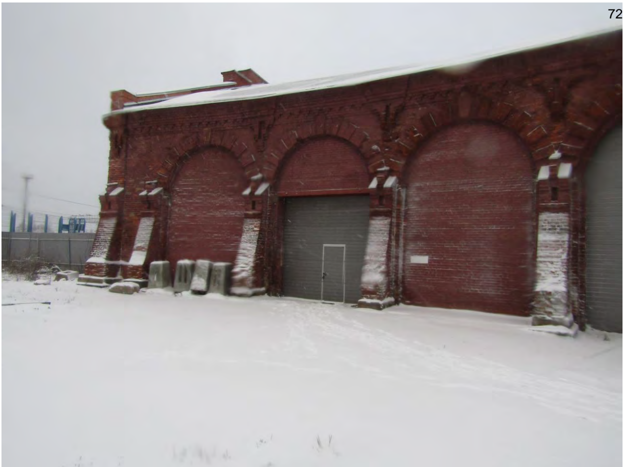
Фото.11. Веерное депо. Вид на юго-восточный фасад. Фрагмент.
