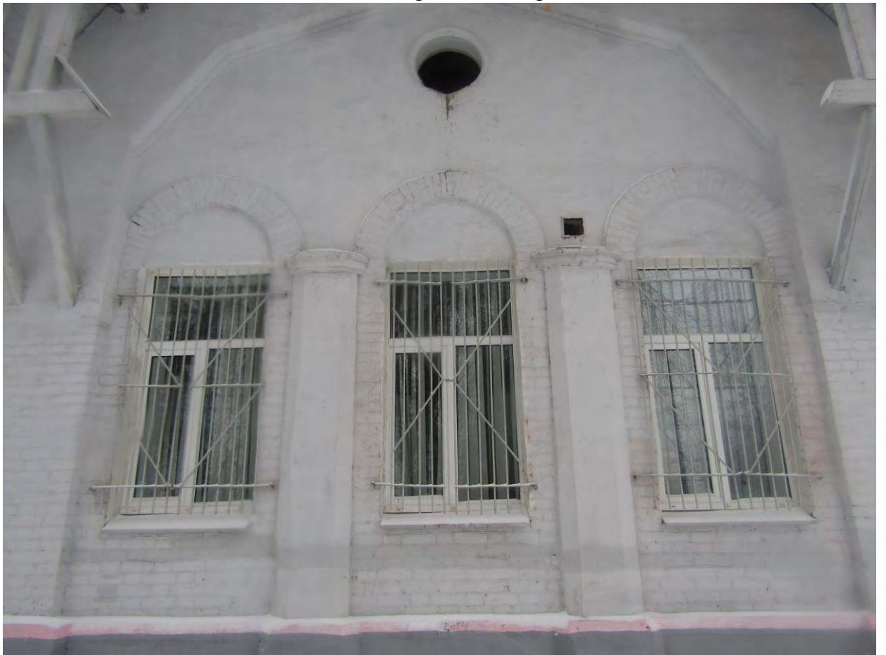
Фото.62. Контора. Южный фасад. Фрагмент.
