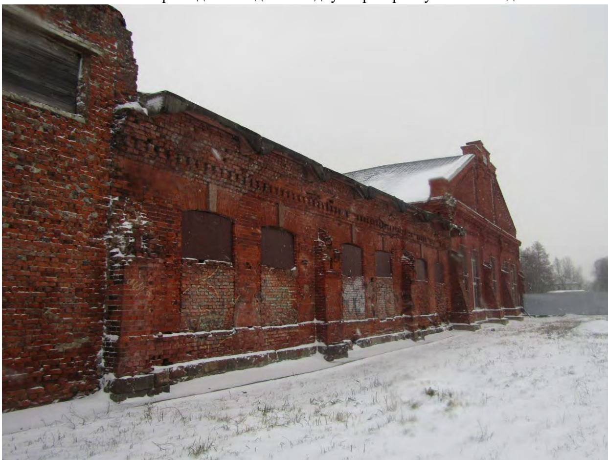
Фото.30. Веерное депо. Вид на торцевой южный фасад.
