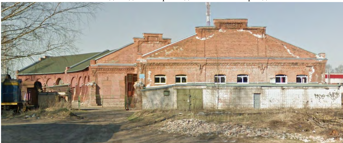
Илл.31. Вид на здание веерного депо. Восточный фасад. 2013 г.
