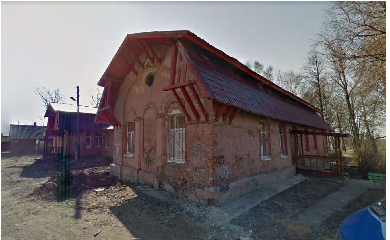
Илл.23. Вид на здание конторы. Северный фасад. 2013 г.
