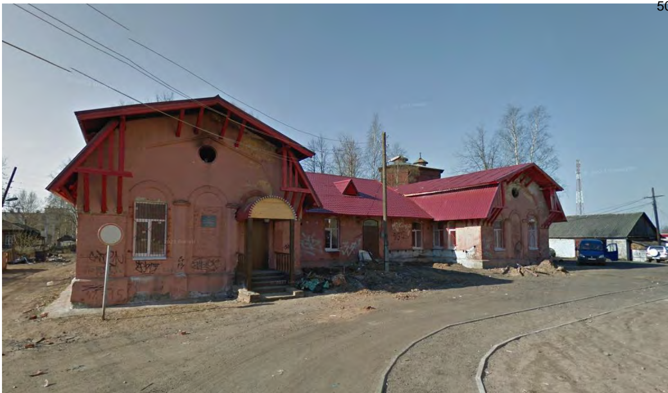
Илл.26. Вид на здание конторы. Северный фасад. 2013 г.
