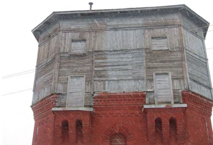
Фото.41. Водонапорная башня. Южный фасад, фрагмент.
