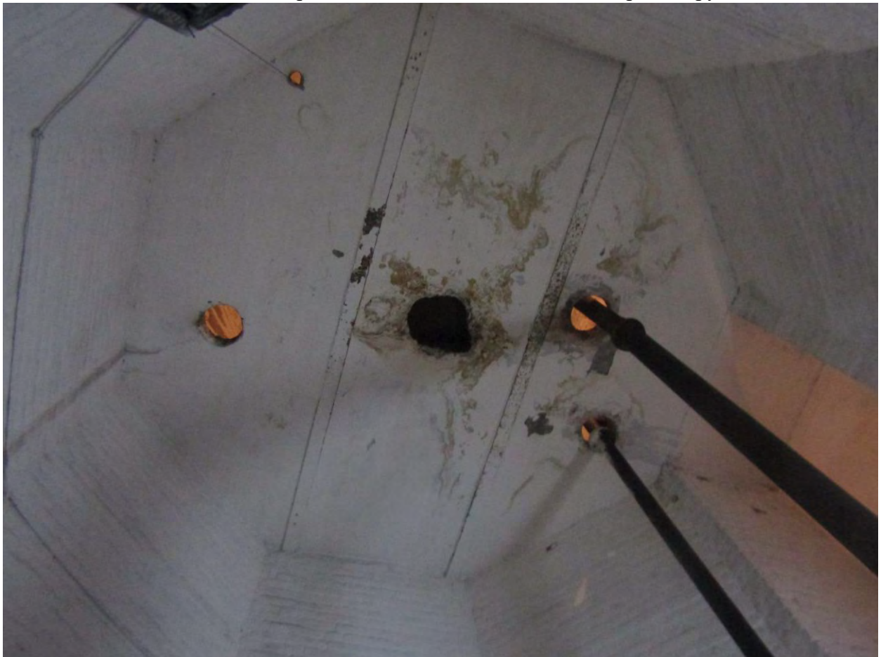
Фото.49. Водонапорная башня. Вид на помещение первого яруса. Перекрытие.
