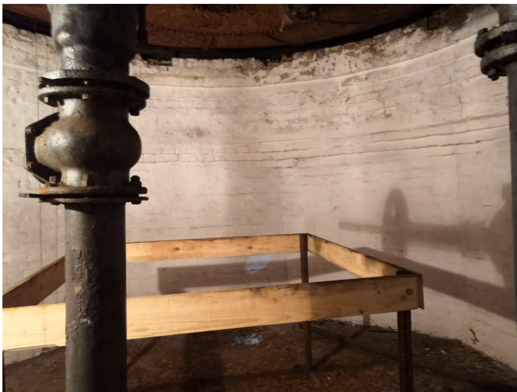
Фото.52. Водонапорная башня. Вид на помещение среднего яруса.
