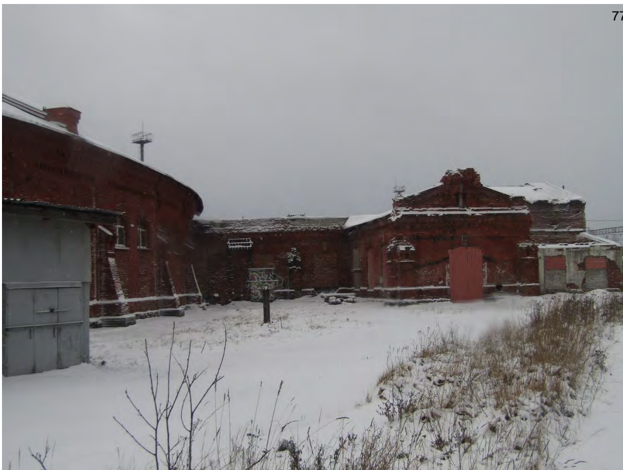
Фото.21. Всерное депо. Вид на здание с севера.
