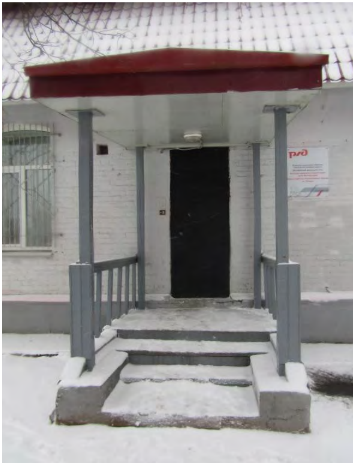
Фото.70. Контора. Вид на западный фасад.
