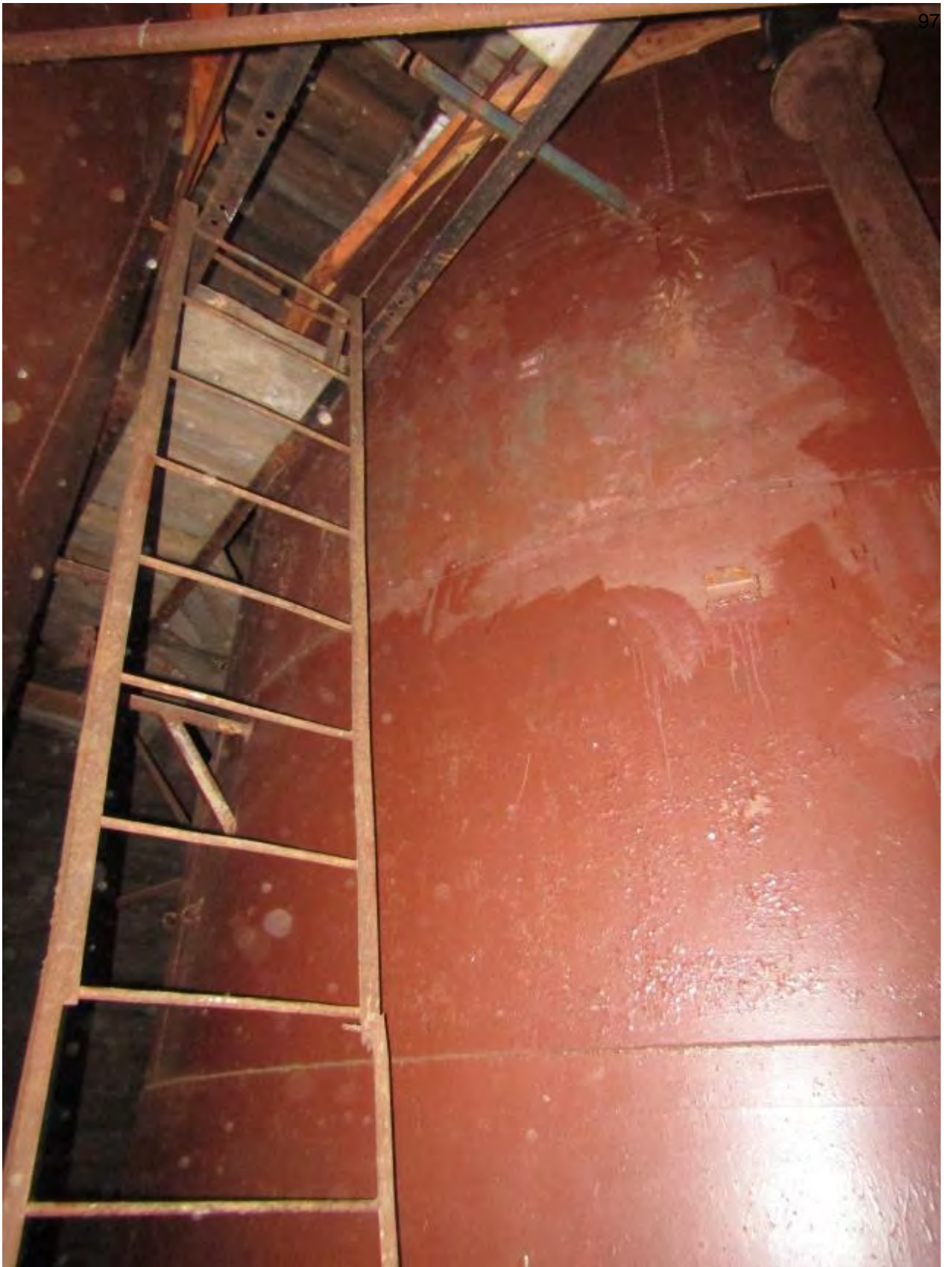
Фото.57. Водонапорная башня. Верхний ярус. Вид на баки и стропильную систему.
