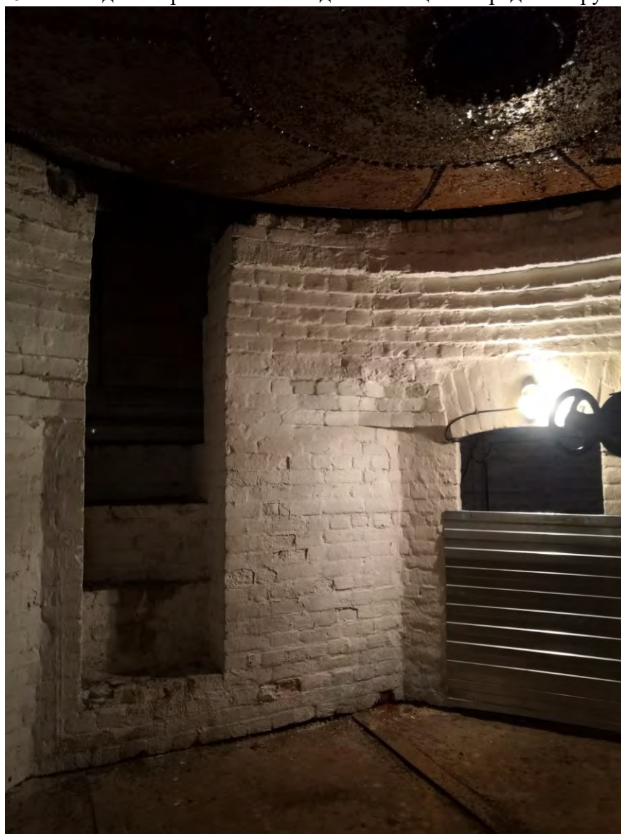
Фото.53. Водонапорная башня. Вид на помещение среднего яруса.
