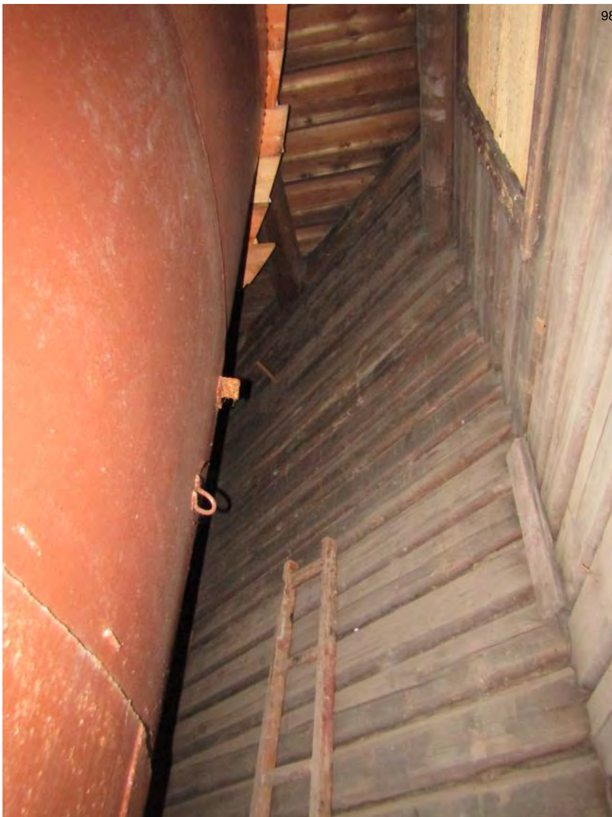
Фото.58. Водонапорная башня. Верхний ярус. Вид на стены и стропильную систему.
