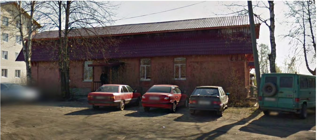
Илл.28. Вид на здание конторы. Западный фасад. 2013 г.
