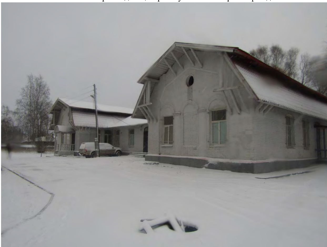
Фото.68. Контора. Вид с северо-запада.
