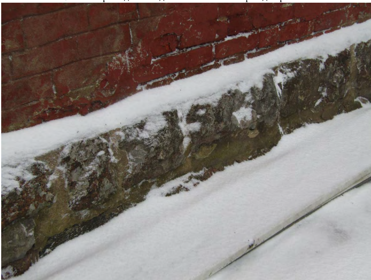
Фото.8. Веерное депо. Вид на юго-восточный фасад. Фрагмент цоколя.
