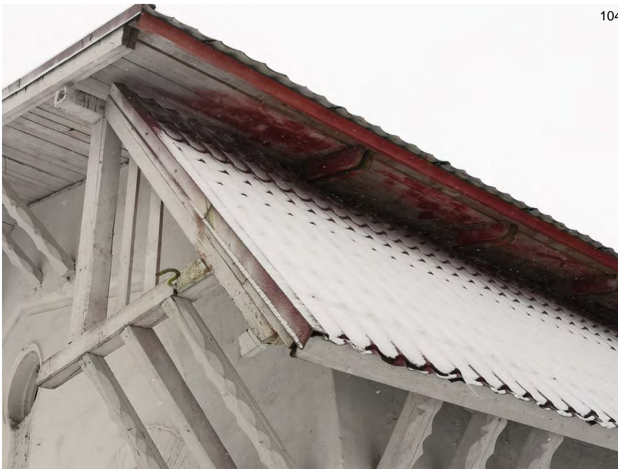
Фото.69. Контора. Вид на кровлю.
