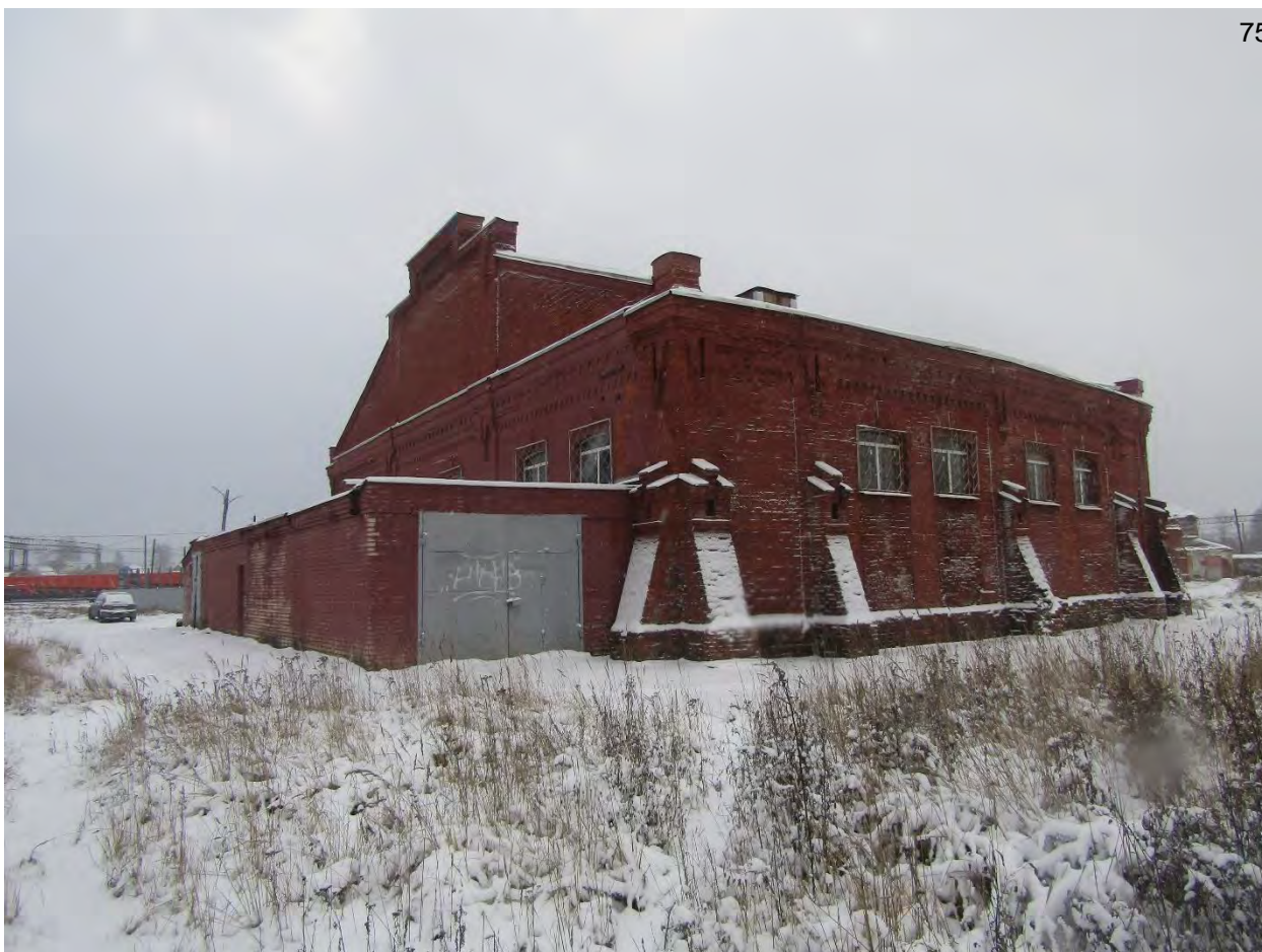
Фото.17. Вверное депо. Северо-западный фасад. Фрагмент.
