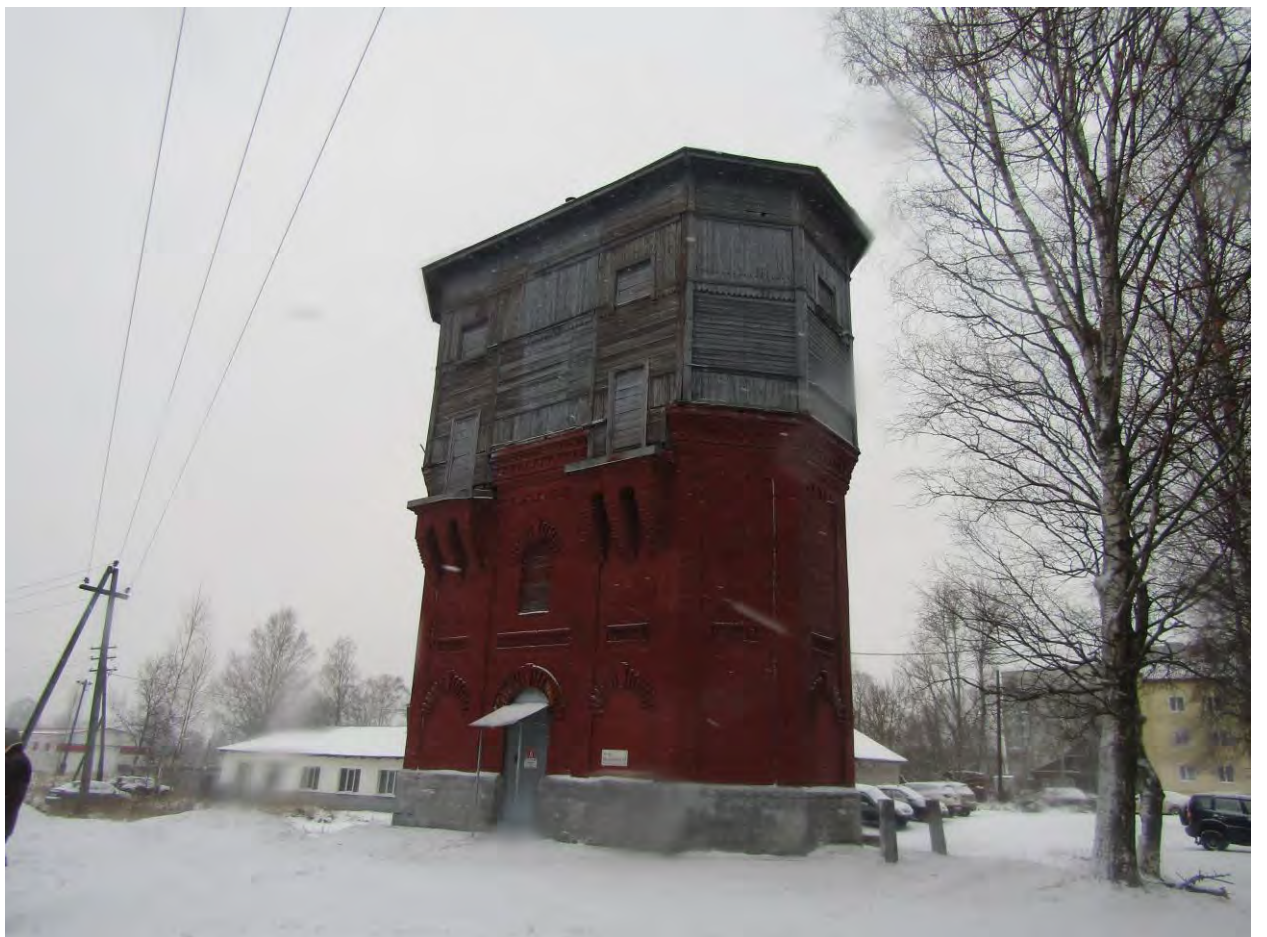
Фото.40. Водонапорная башня. Вид с юго-востока.
