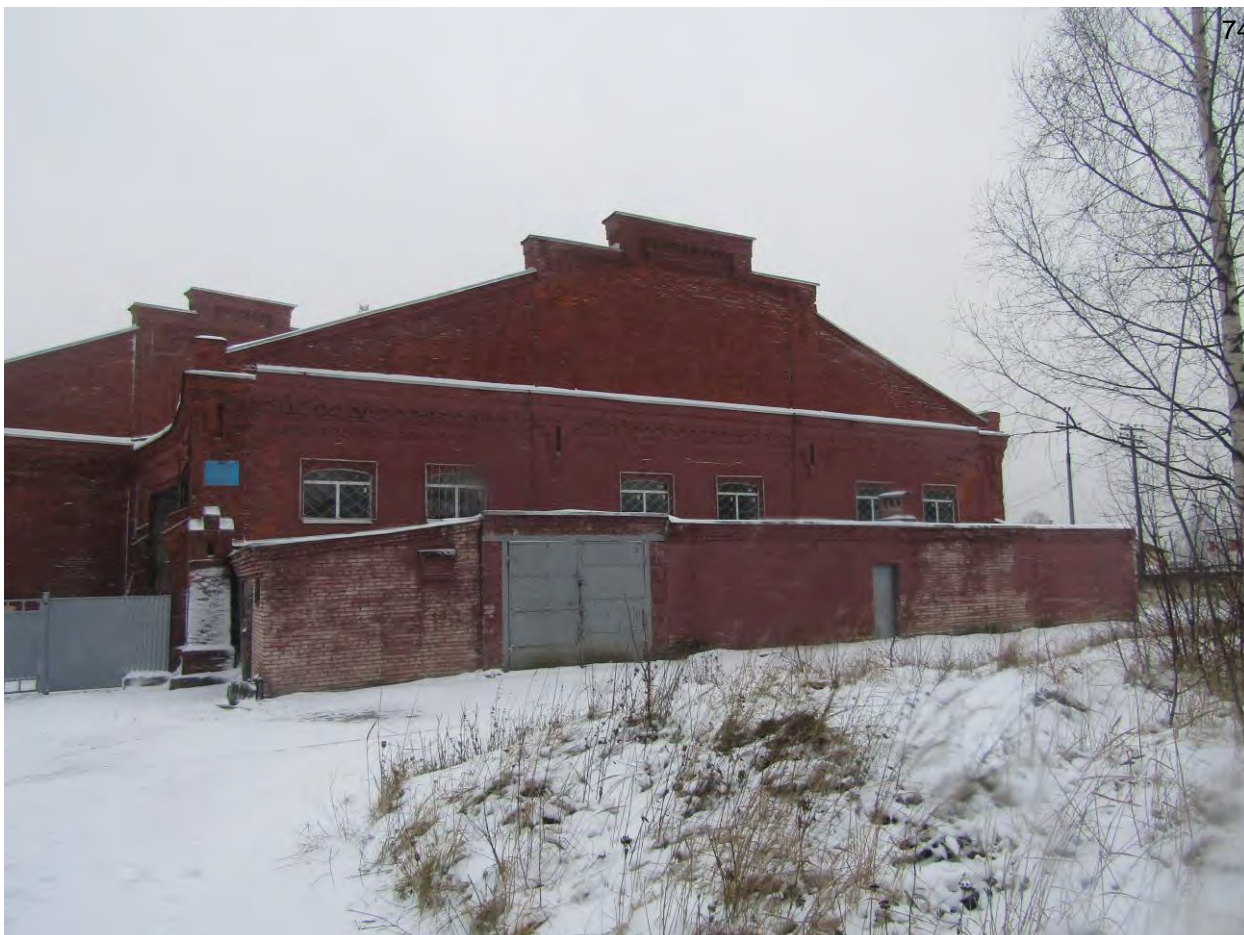
Фото.15. Веерное депо. Общий вид на торцевой фасад с северо-востока.
