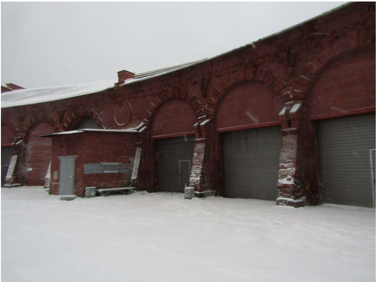
Фото.9. Веерное депо. Вид на юго-восточный фасад. Фрагмент.
