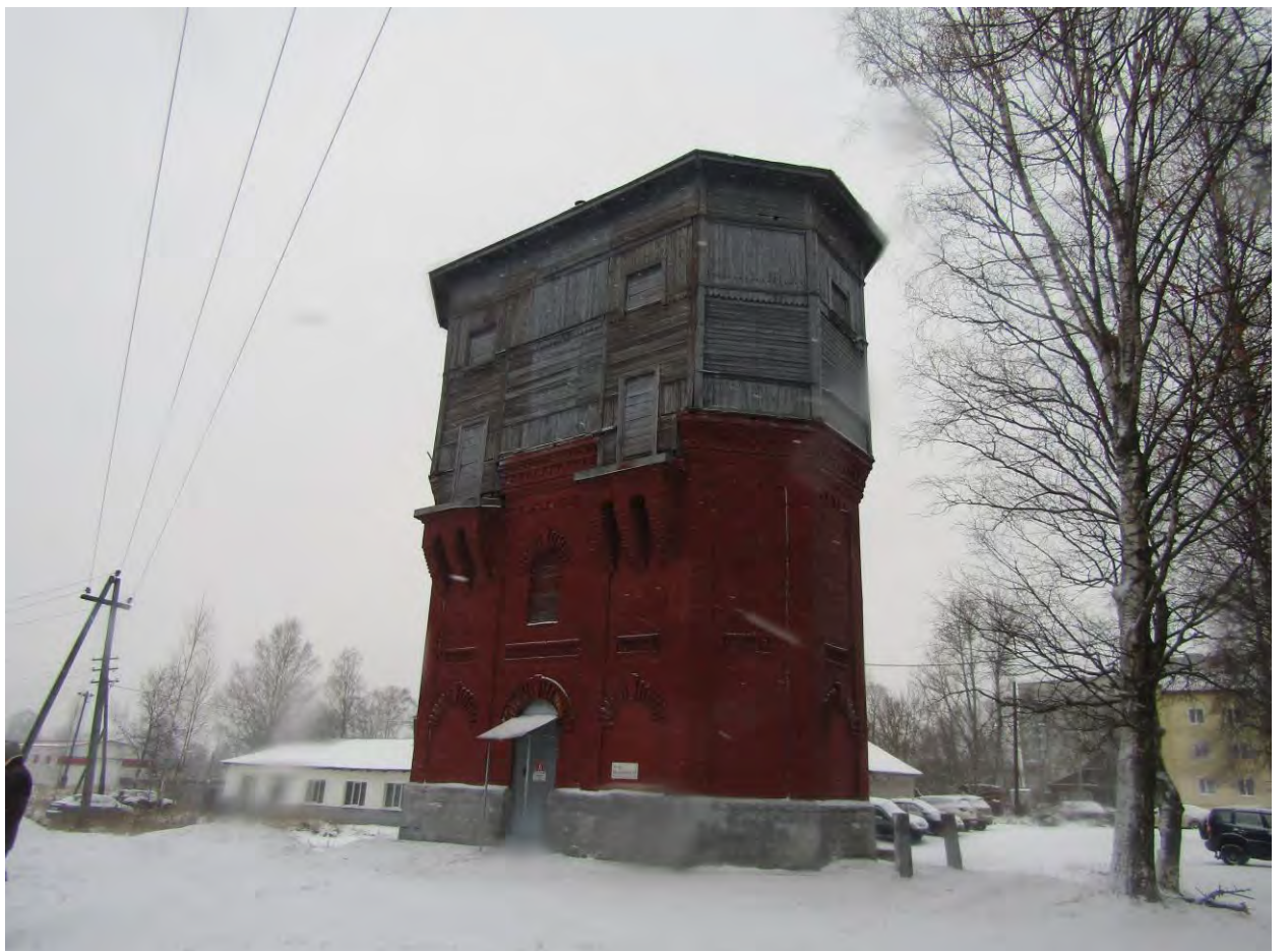
Фото.40. Водонапорная башня. Вид с юго-востока.
