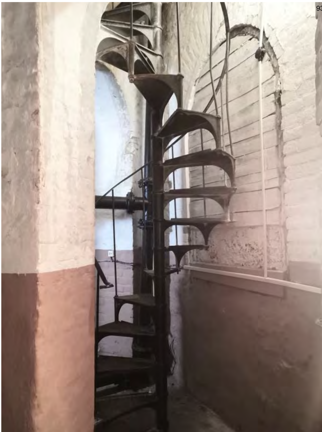
Фото.51. Водонапорная башня. Вид на помещение первого яруса. Винтовая лестница.
