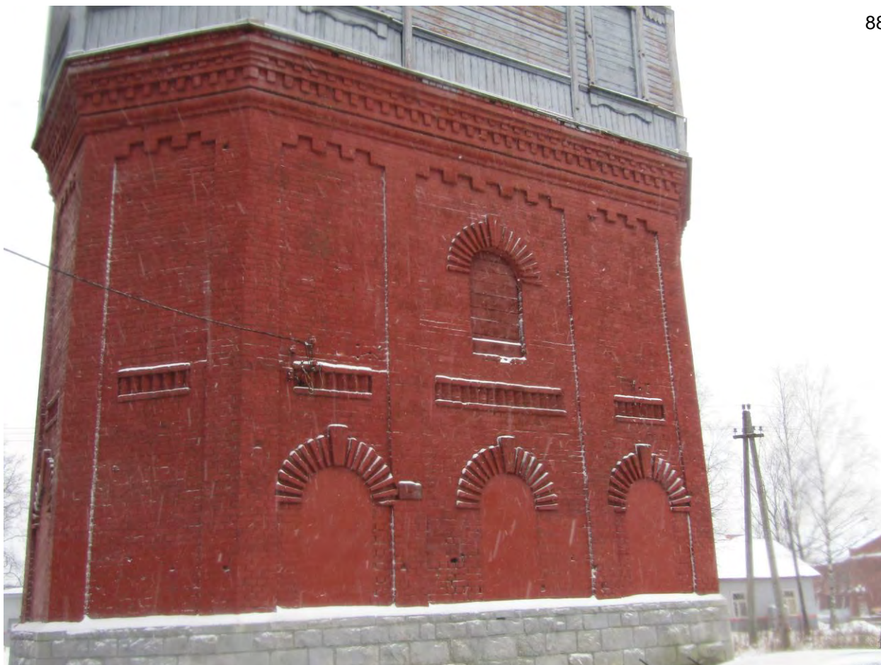
Фото.43. Водонапорная башня. Северный фасад, фрагмент.
