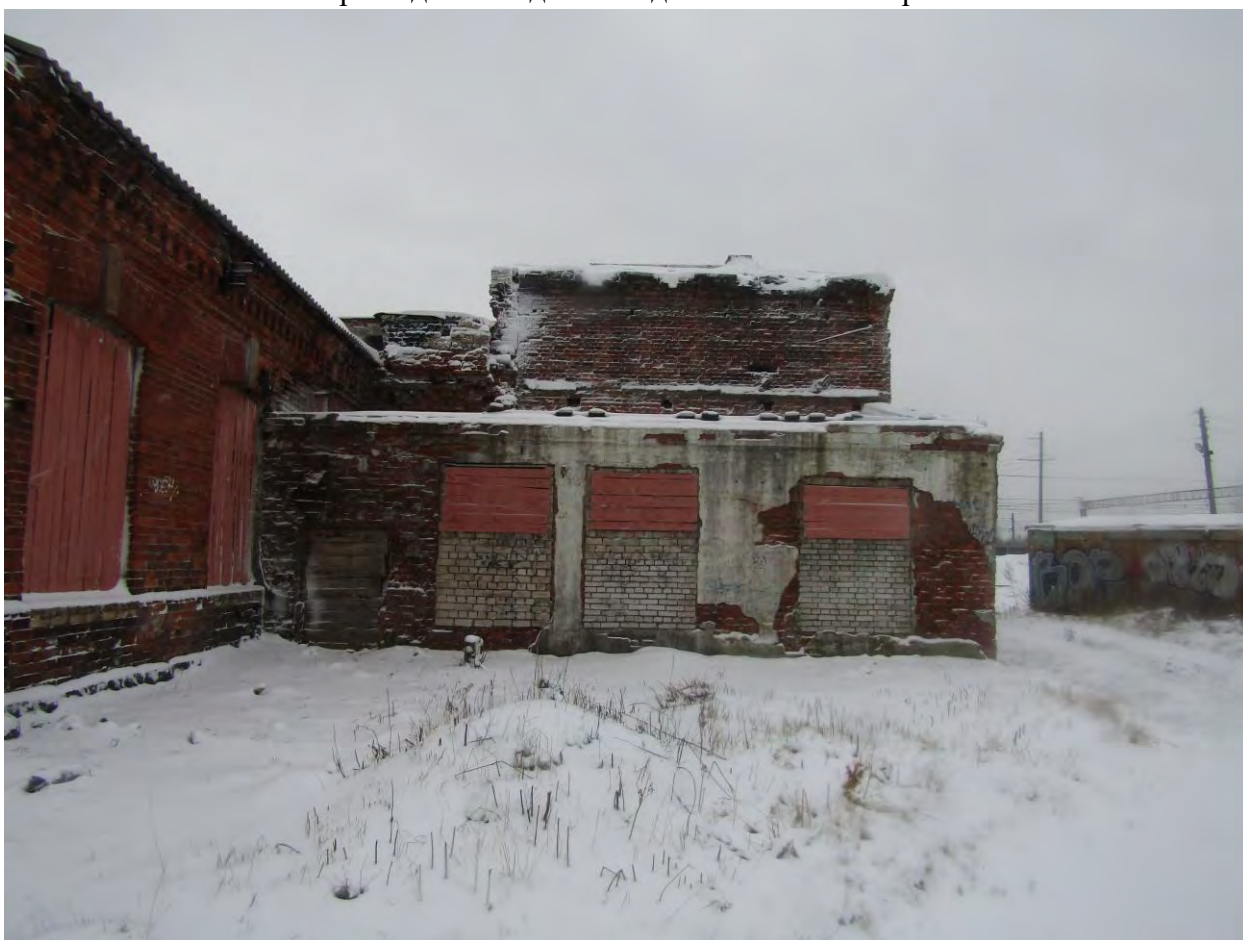
Фото.26. Веерное депо. Вид на западную пристройку с севера.
