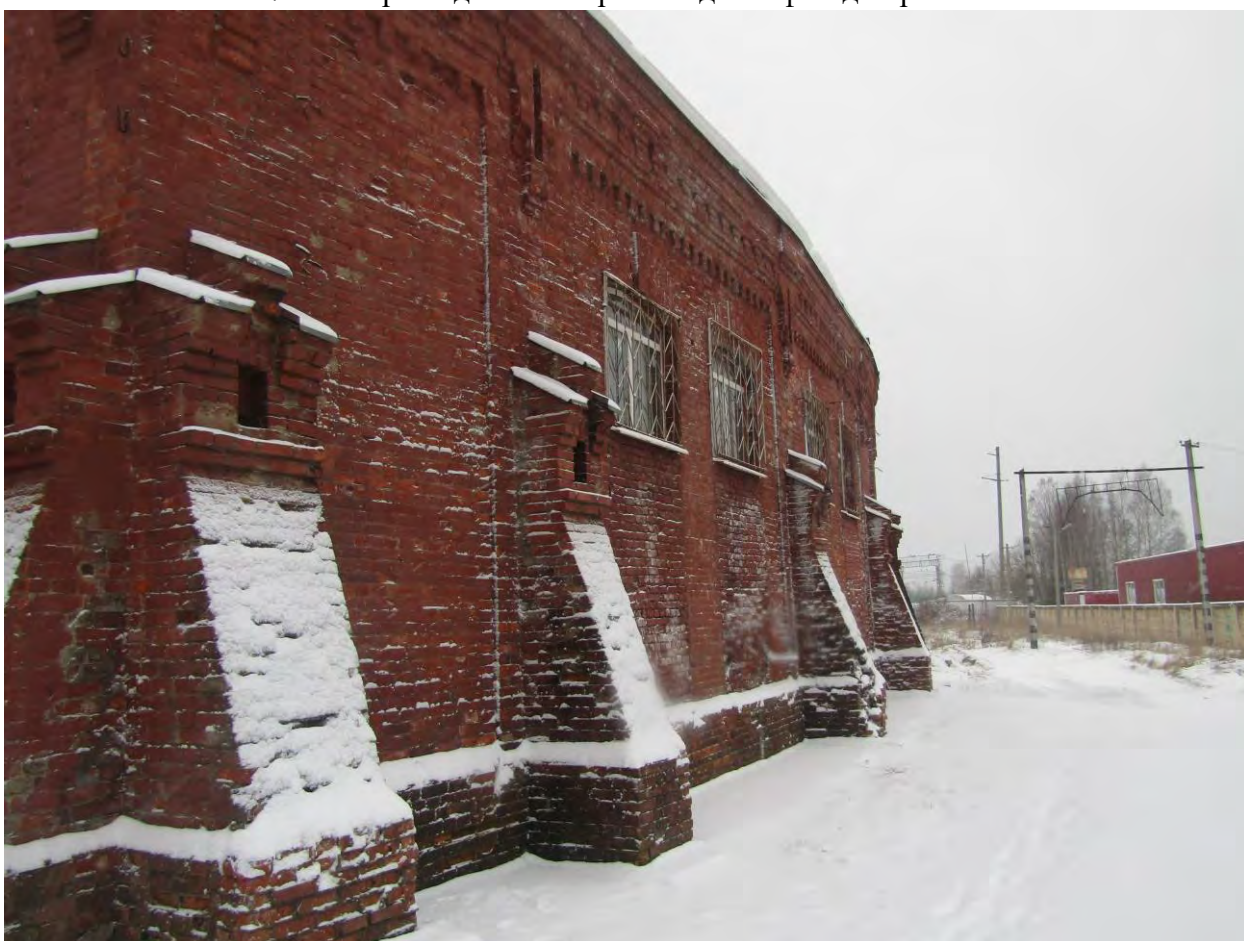
Фото.18. Вверное депо. Северо-западный фасад. Фрагмент.
