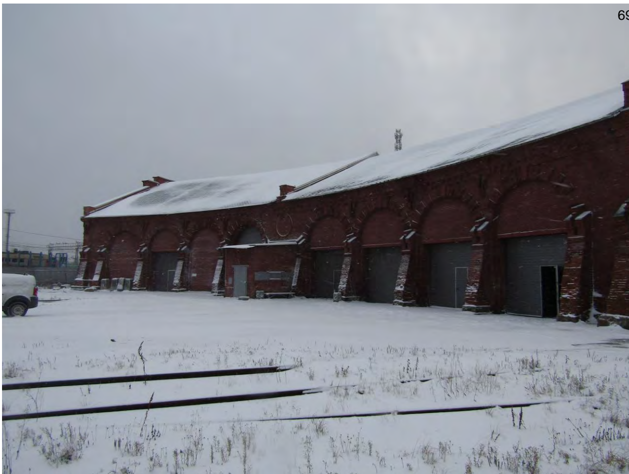
Фото.5. Веерное депо. Вид на юго-восточный фасад. Фрагмент.
