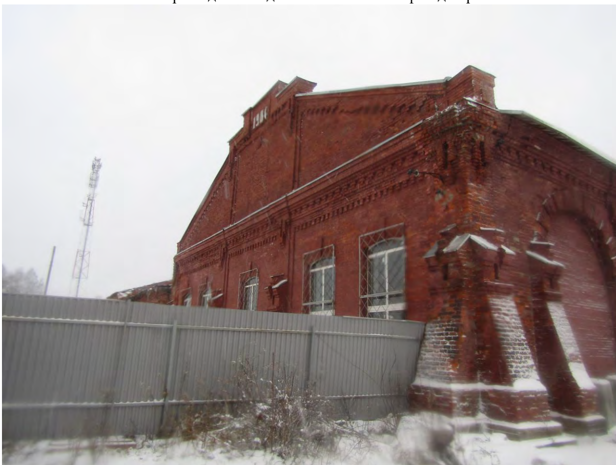
Фото.12. Веерное депо. Вид на южный фасад.
