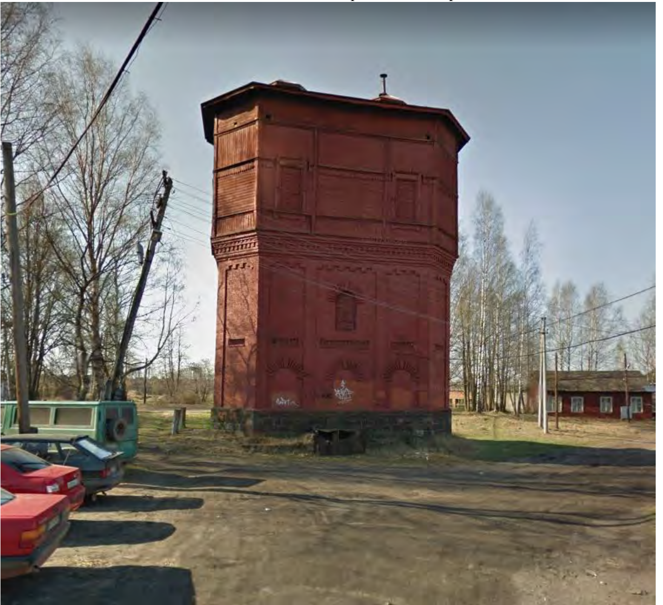
Илл.29. Вид на здание водонапорной башни. Северный фасад. 2013 г.
