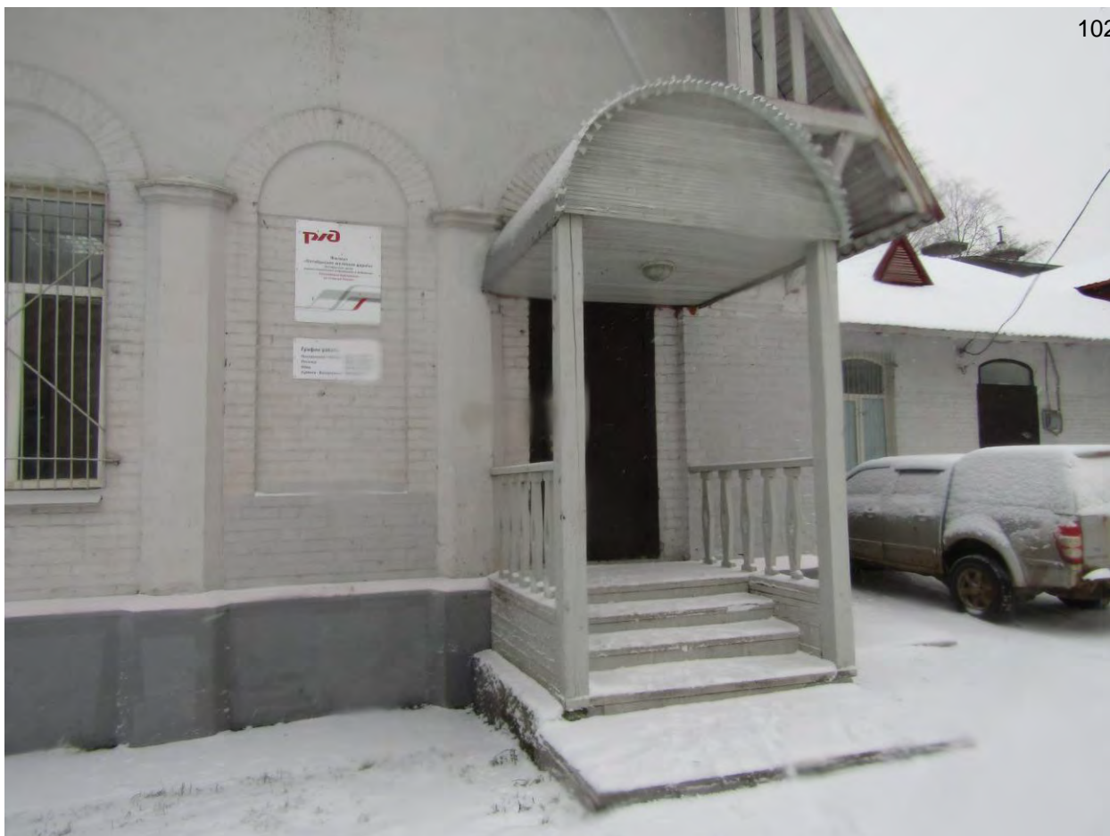
Фото.65. Контора. Вид на северный вход.
