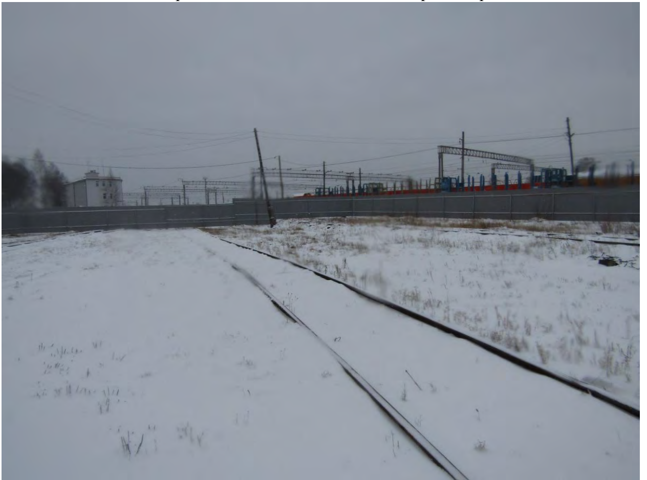
Фото.10. Веерное депо. Вид на прилегающую территорию.
