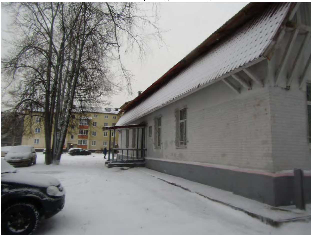
Фото.60. Контора. Вид на западный фасад.
