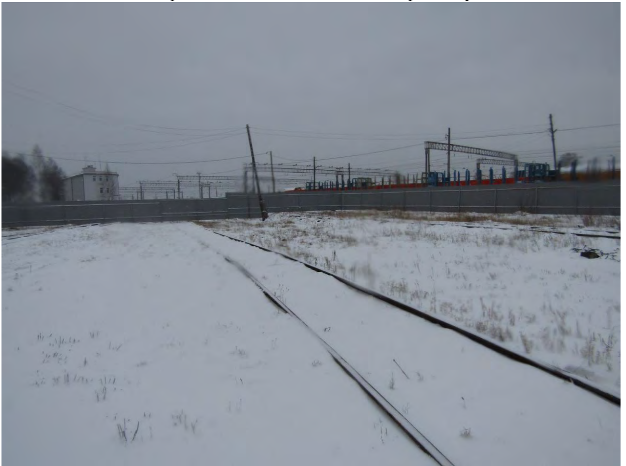
Фото.10. Веерное депо. Вид на прилегающую территорию.
