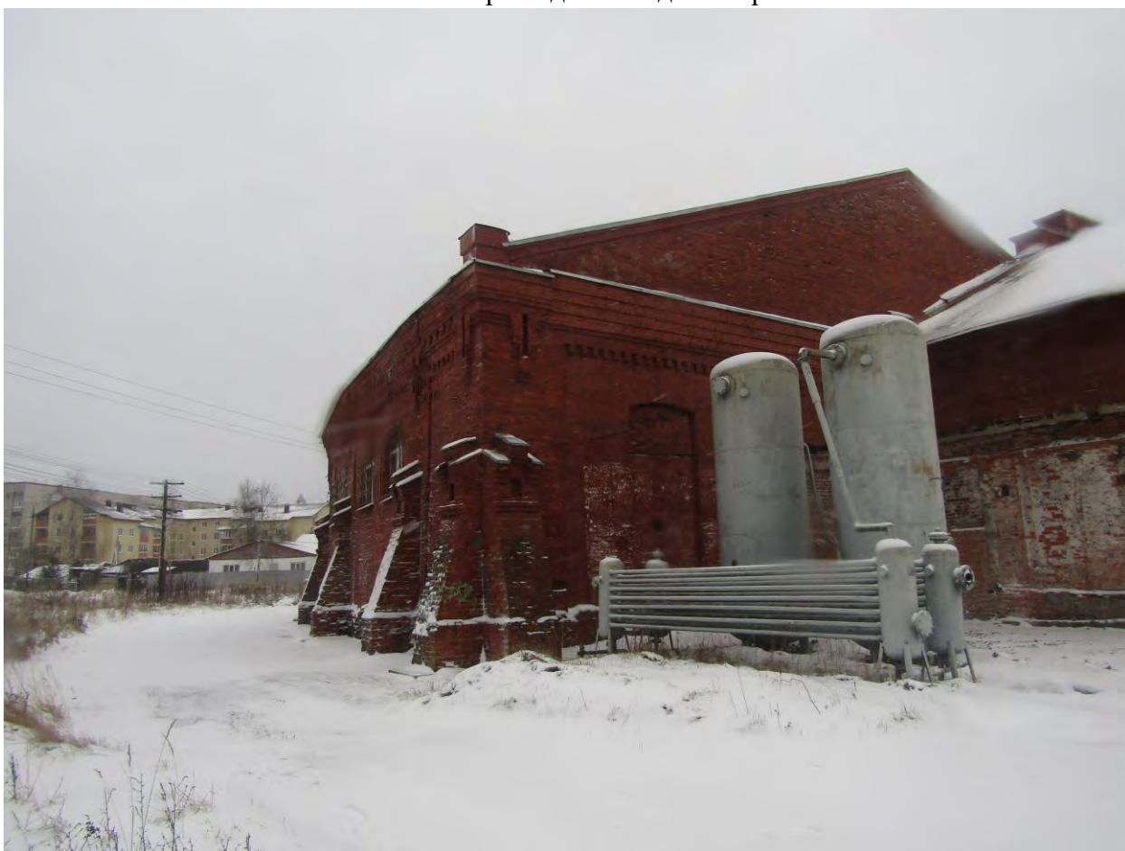
Фото.20. Веерное депо. Северо-западный фасад. Фрагмент.
