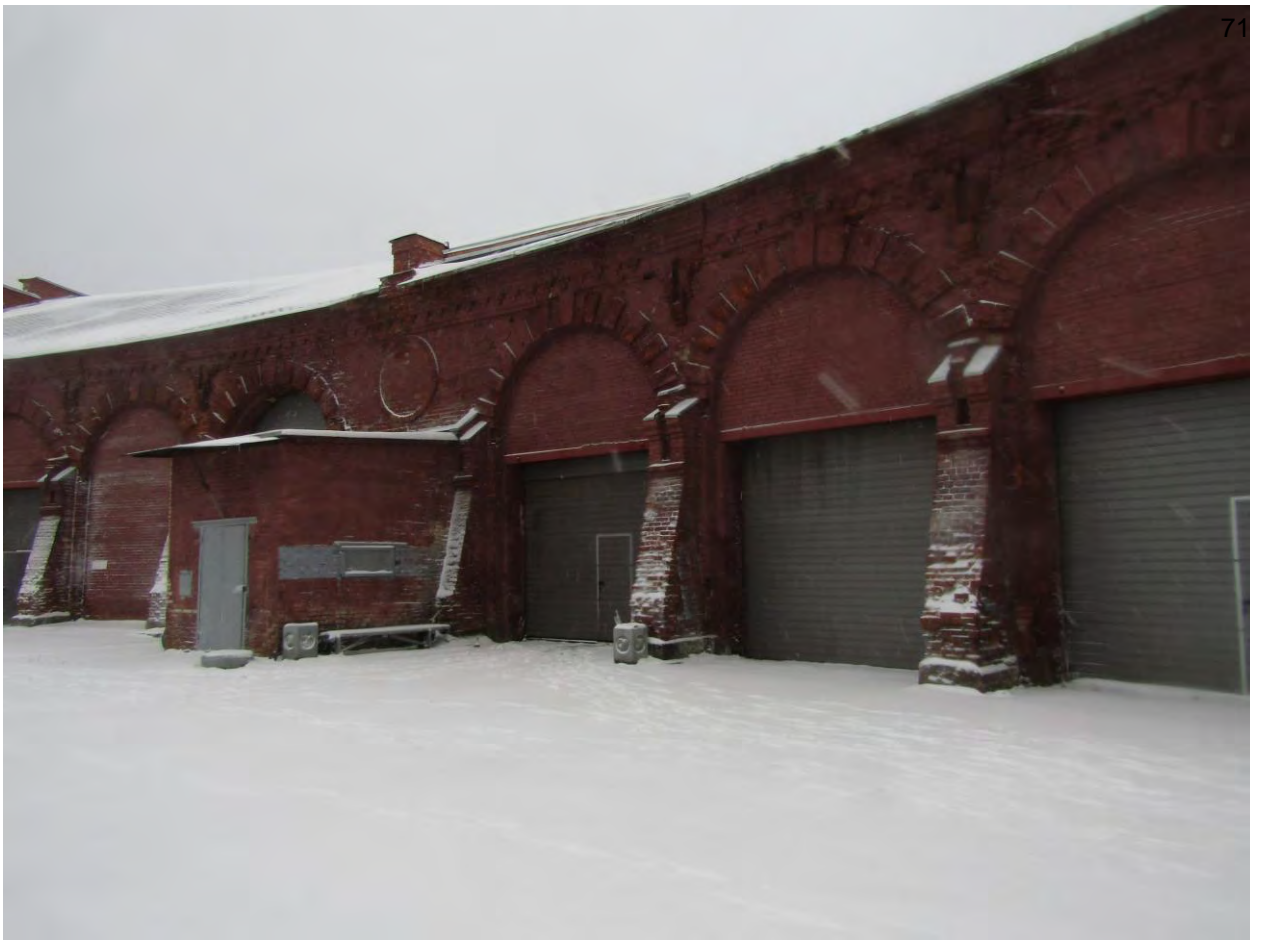
Фото.9. Веерное депо. Вид на юго-восточный фасад. Фрагмент.
