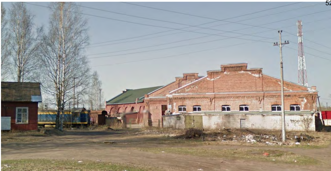
Илл.30. Вид на здание веерного депо. Восточный фасад. 2013 г.
