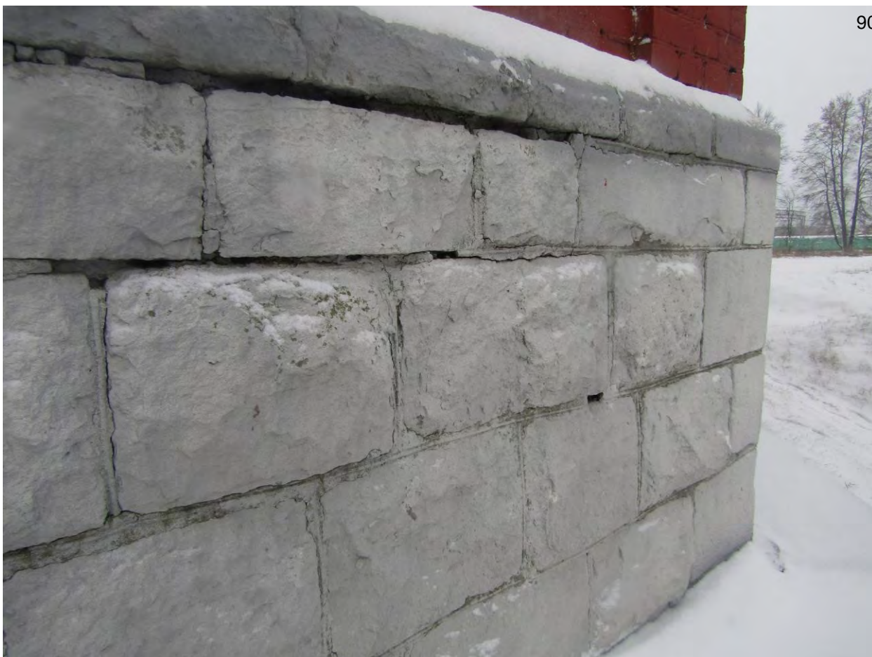
Фото.46. Водонапорная башня. Вид на цоколь.
