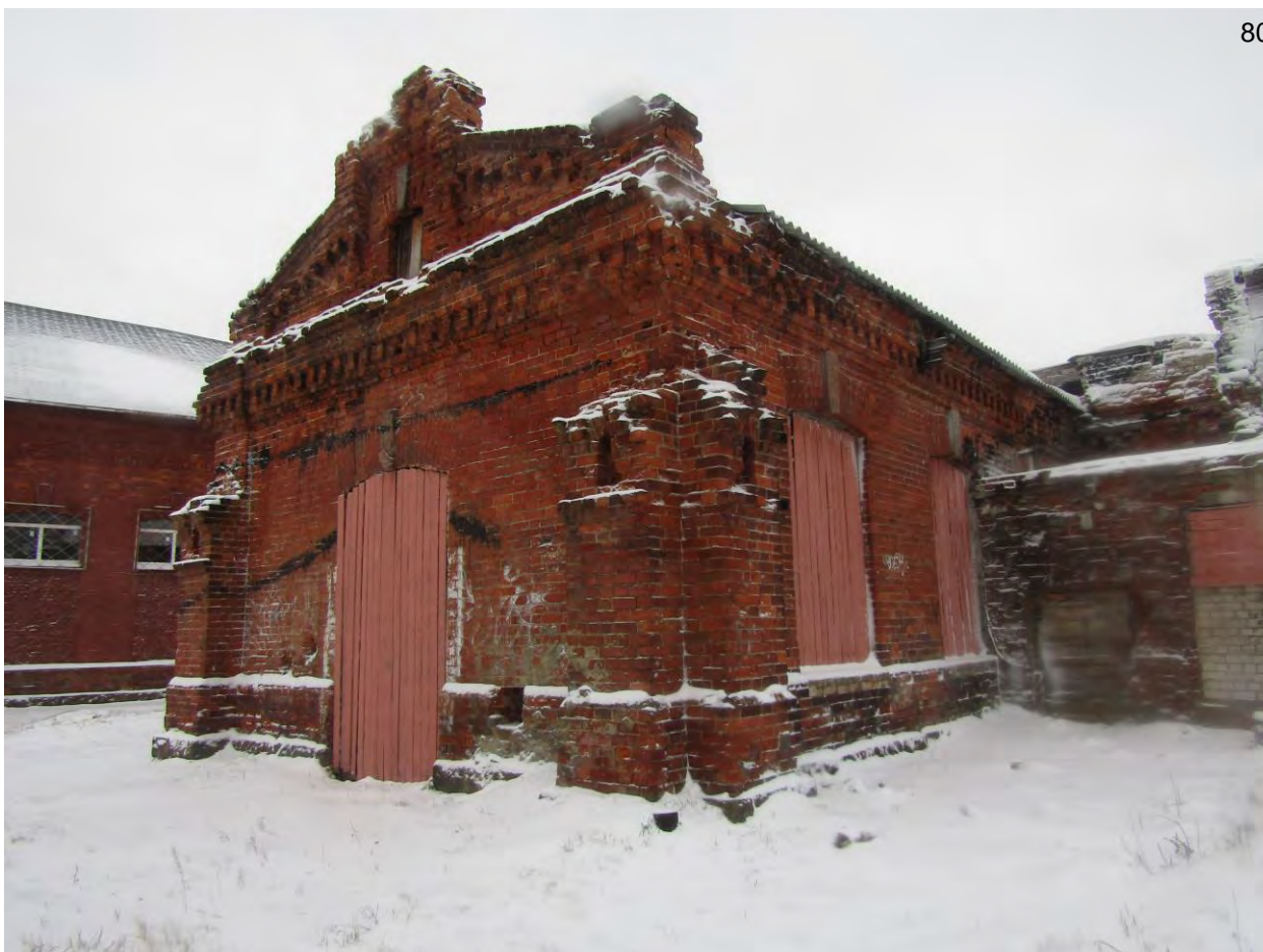
Фото.27. Веерное депо. Вид на западный объем с северо-запада.
