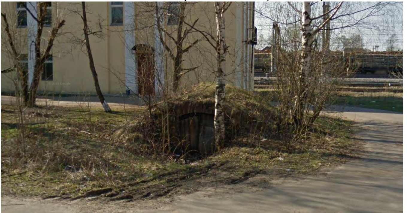
Илл.33. Вид на ледник. Северный фасад. 2013 г.
