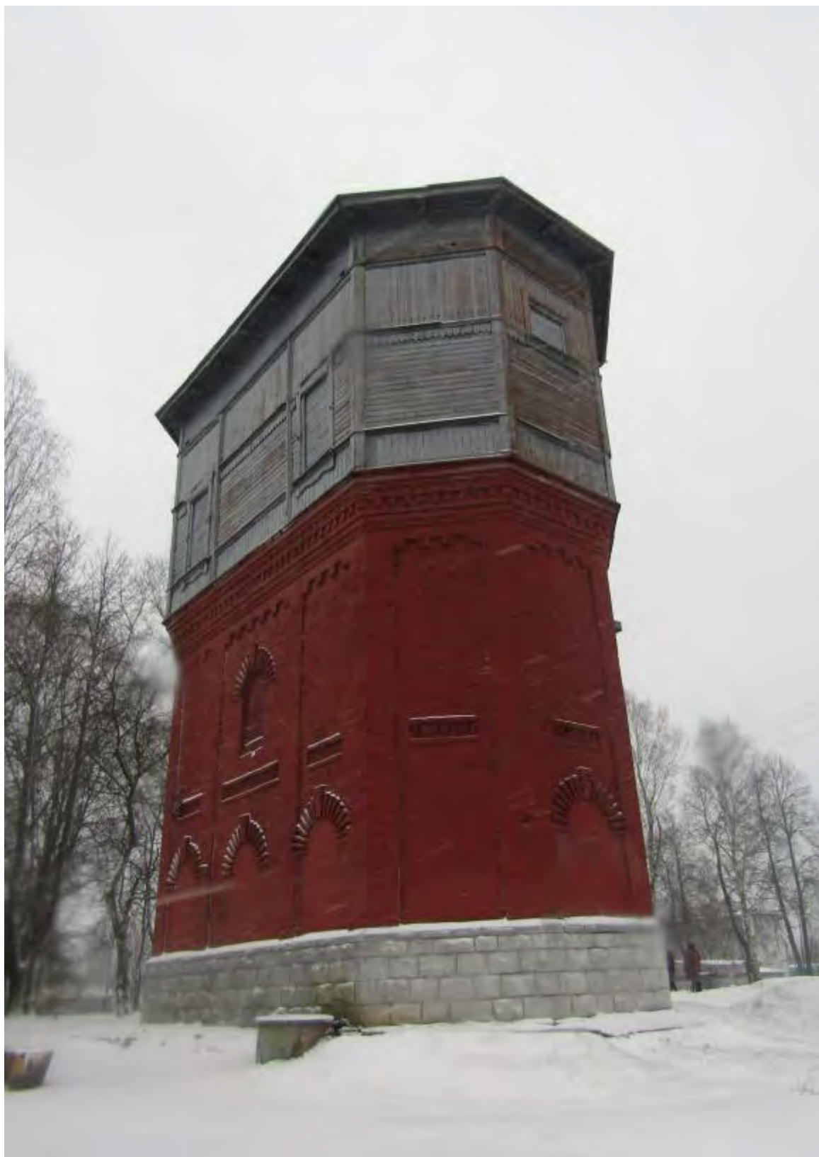
Фото.45. Водонапорная башня. Вид с северо-запада.
