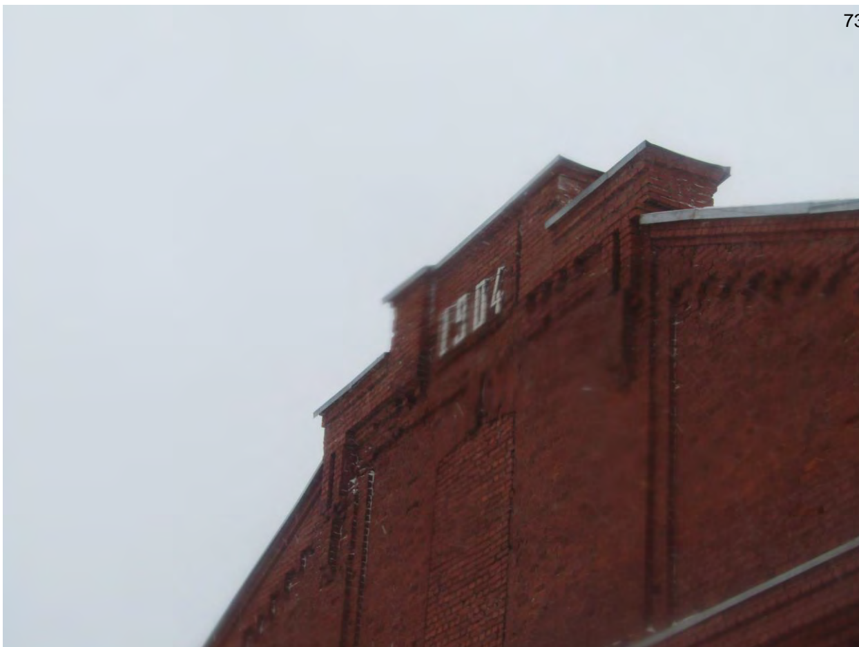
Фото.13. Веерное депо. Вид на южный фасад. Фрагмент.
