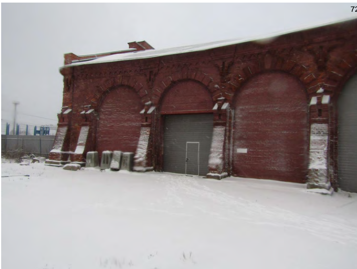
Фото.11. Веерное депо. Вид на юго-восточный фасад. Фрагмент.
