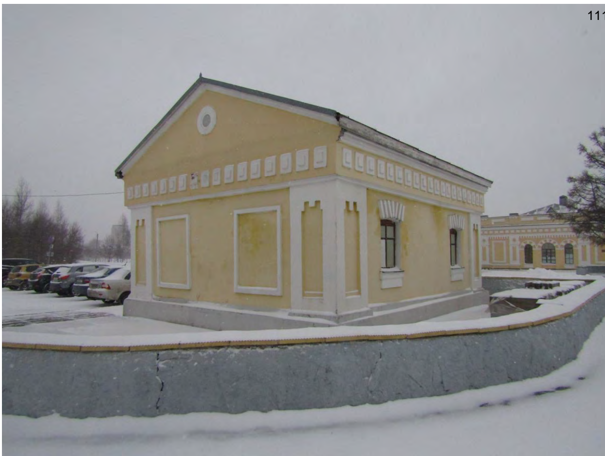
Фото.78. Здание служб. Вид с юго-запада.
