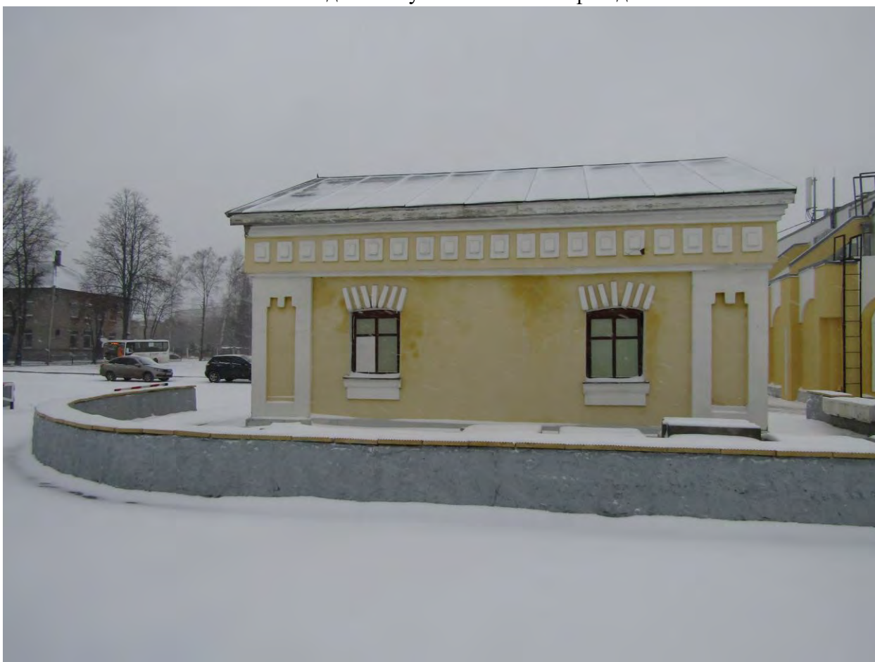
Фото.77. Здание служб. Южный фасад.
