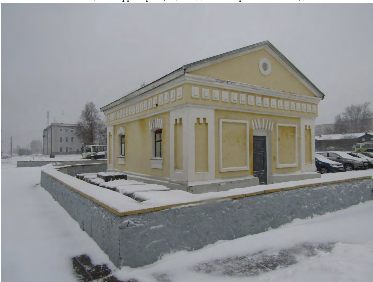
Фото.75. Здание служб. Вид с юго-востока.
