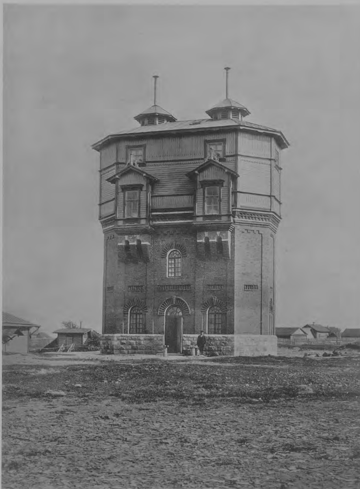
Водоемное здание на 2 бака.
