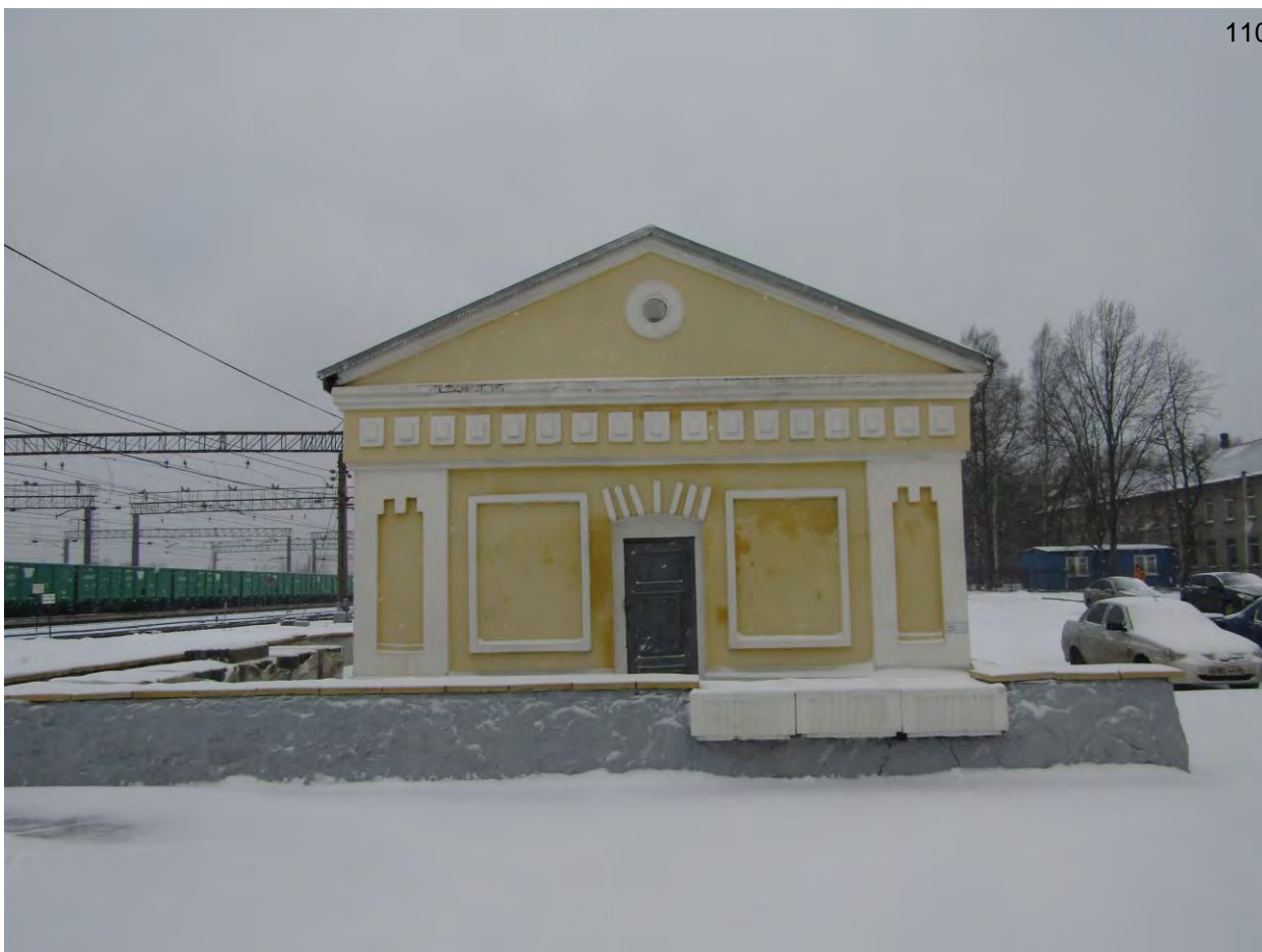
Фото.76. Здание служб. Восточный фасад.
