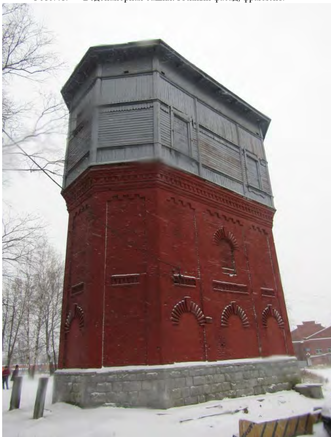
Фото.42. Водонапорная башня. Вид с северо-востока.
