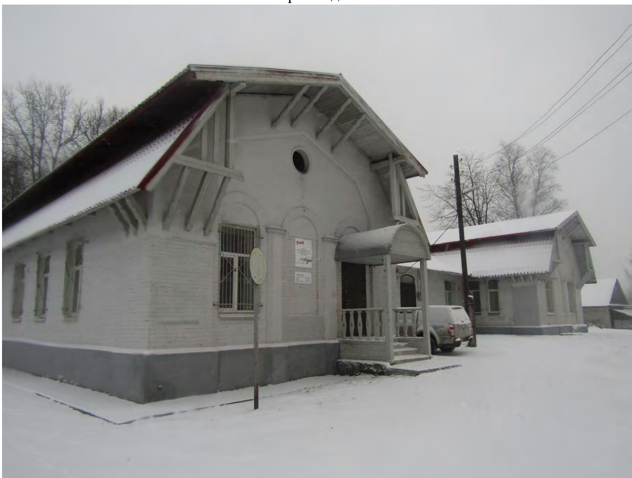
Фото.64. Контора. Вид с северо-востока.
