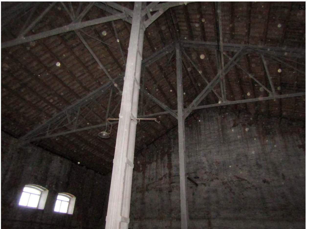
Фото.33. Веерное депо. Общий вид на помещение 1 (южное). Фермы.
