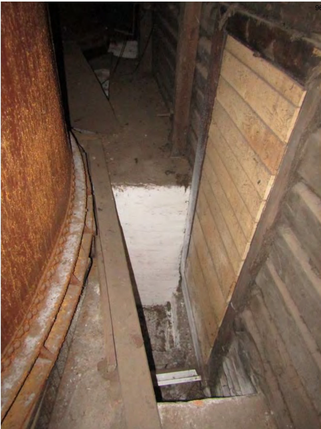
Фото.56. Водонапорная башня. Верхний ярус. Вид на заложённый дверной проем.
