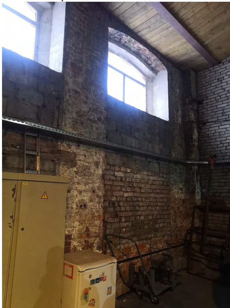
Фото.36. Веерное депо. Общий вид на помещение 7. Оуонные проемы.
