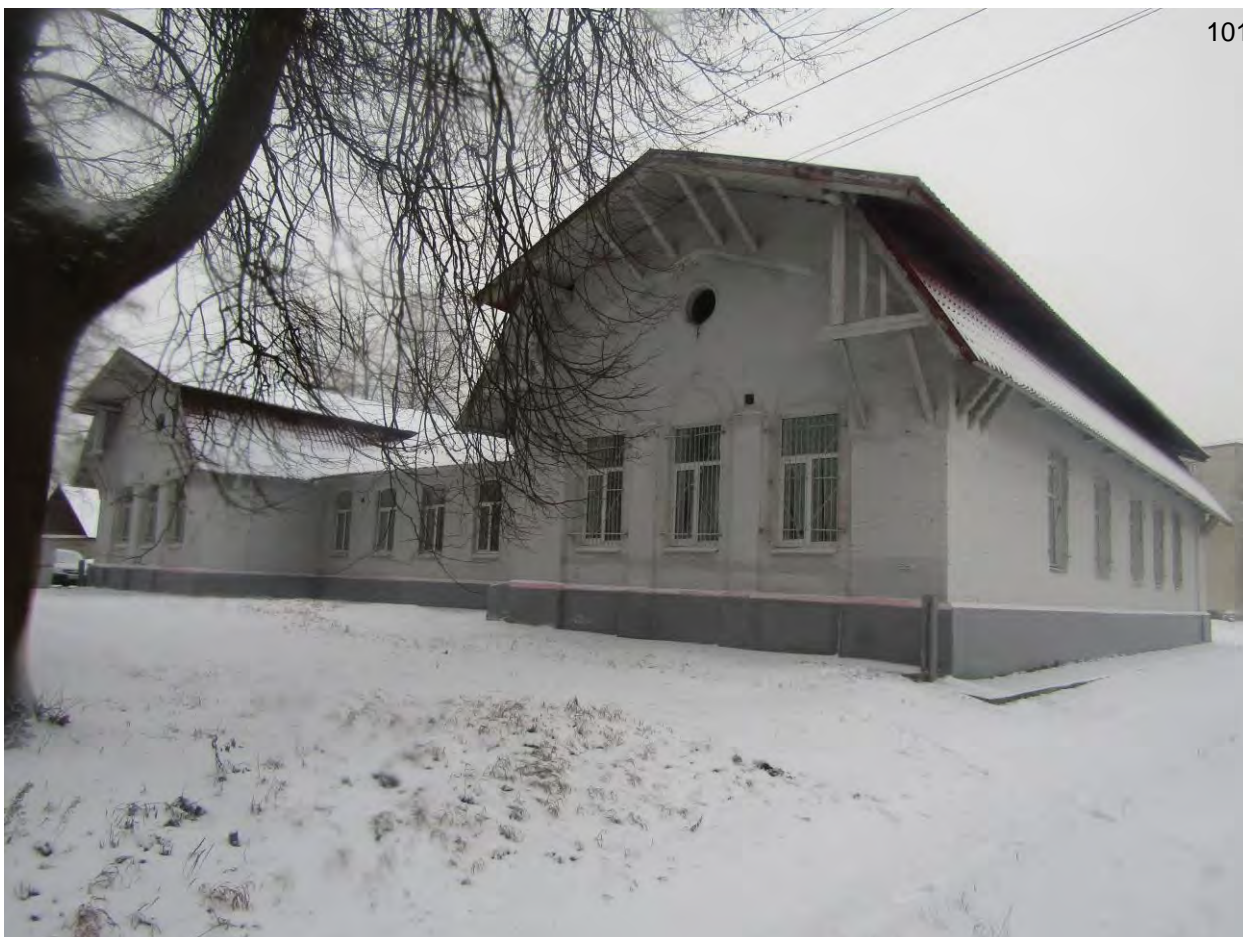
Фото.63. Контора. Вид с юго-востока.
