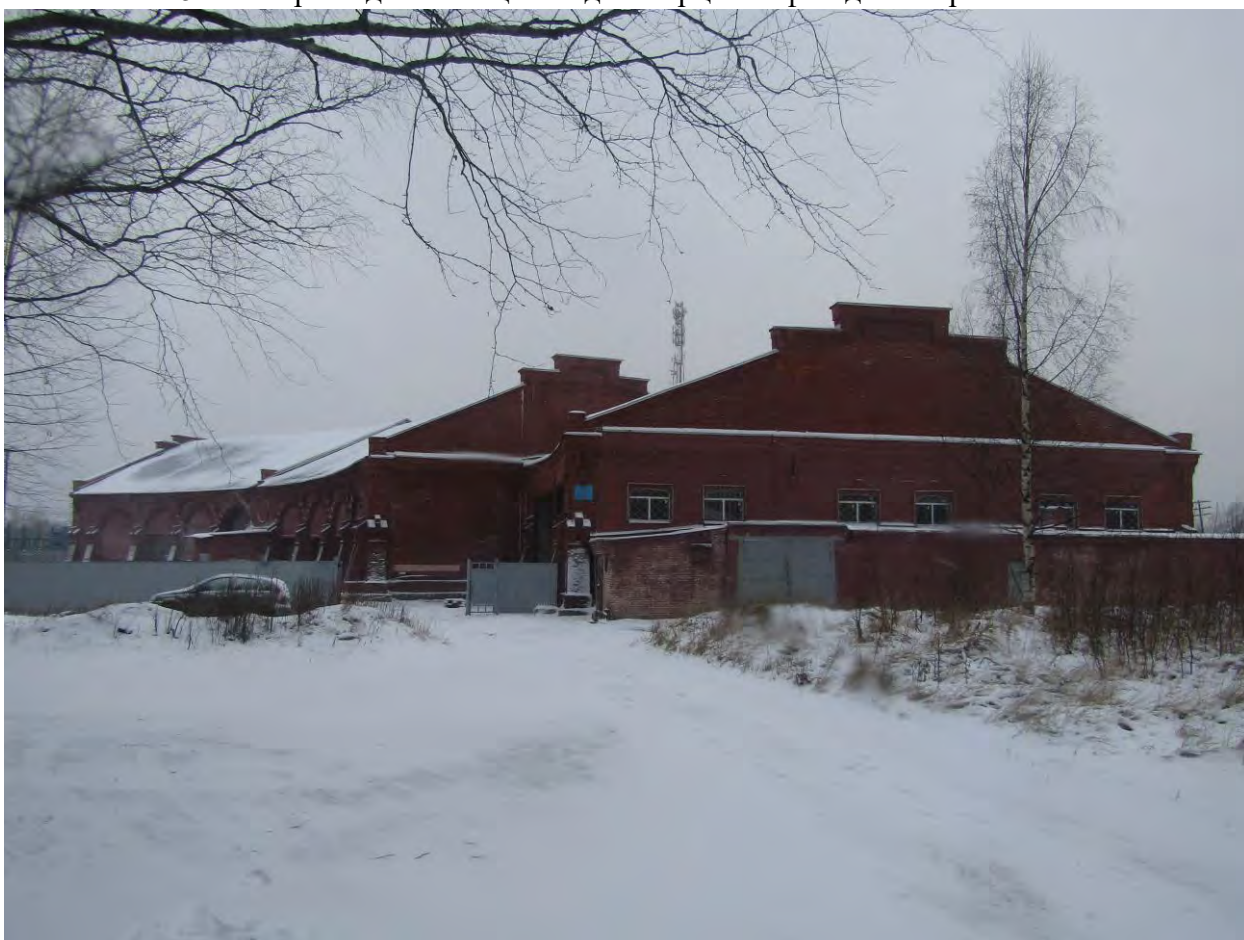
Фото.16. Веерное депо. Общий вид на здание с северо-востока.
