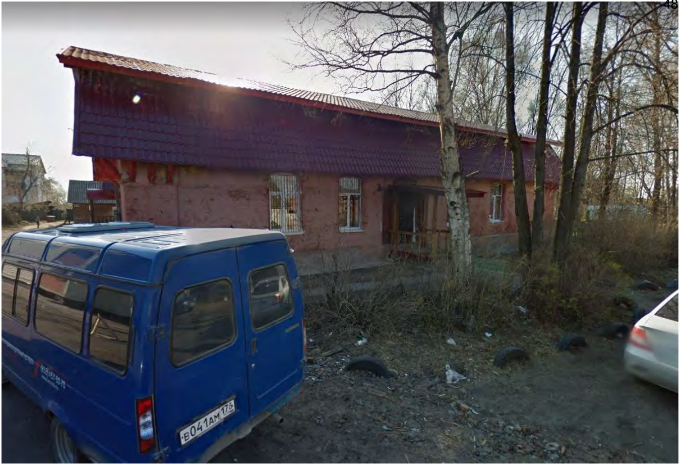
Илл.22. Вид на здание конторы. Восточный фасад. 2013 г.
