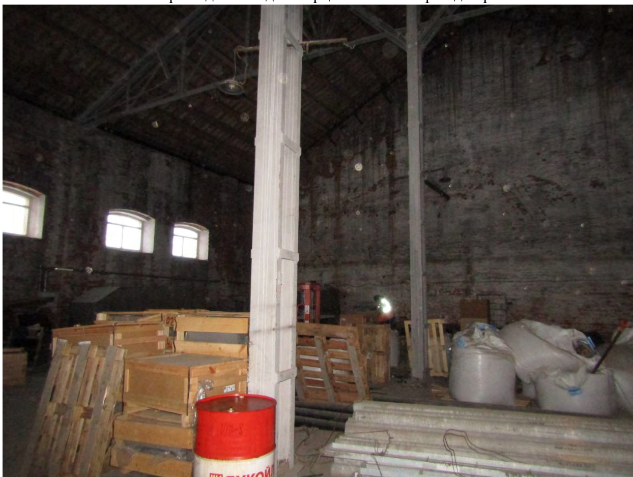
Фото.32. Веерное депо. Общий вид на помещение 1 (южное).
