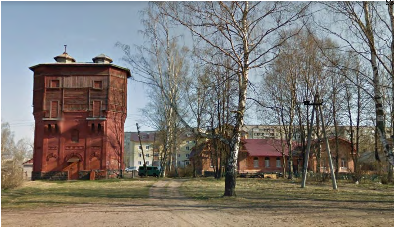
Илл.32. Вид на здание водонапорной башни и конторы. Южный фасад. 2013 г.
