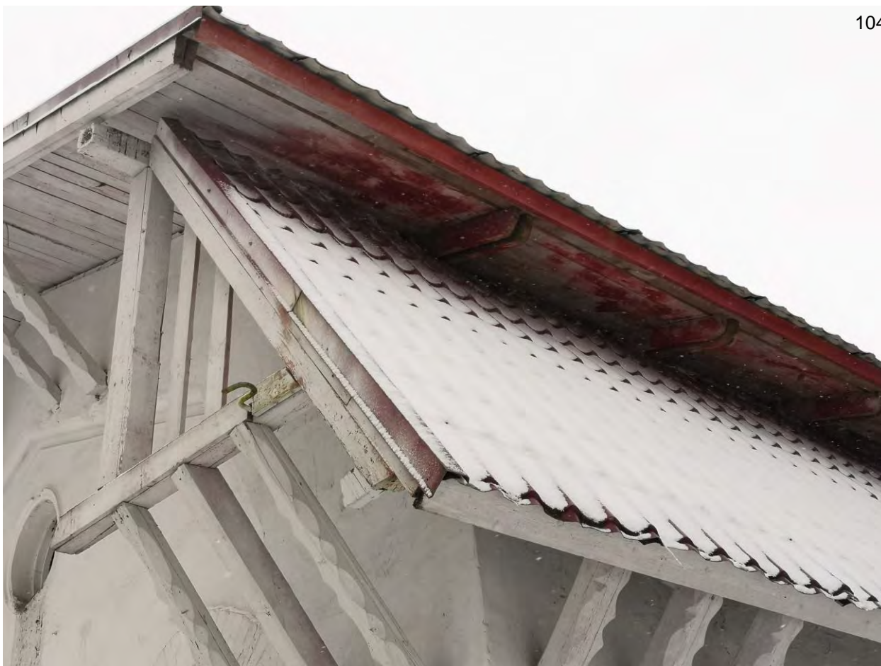
Фото.69. Контора. Вид на кровлю.
