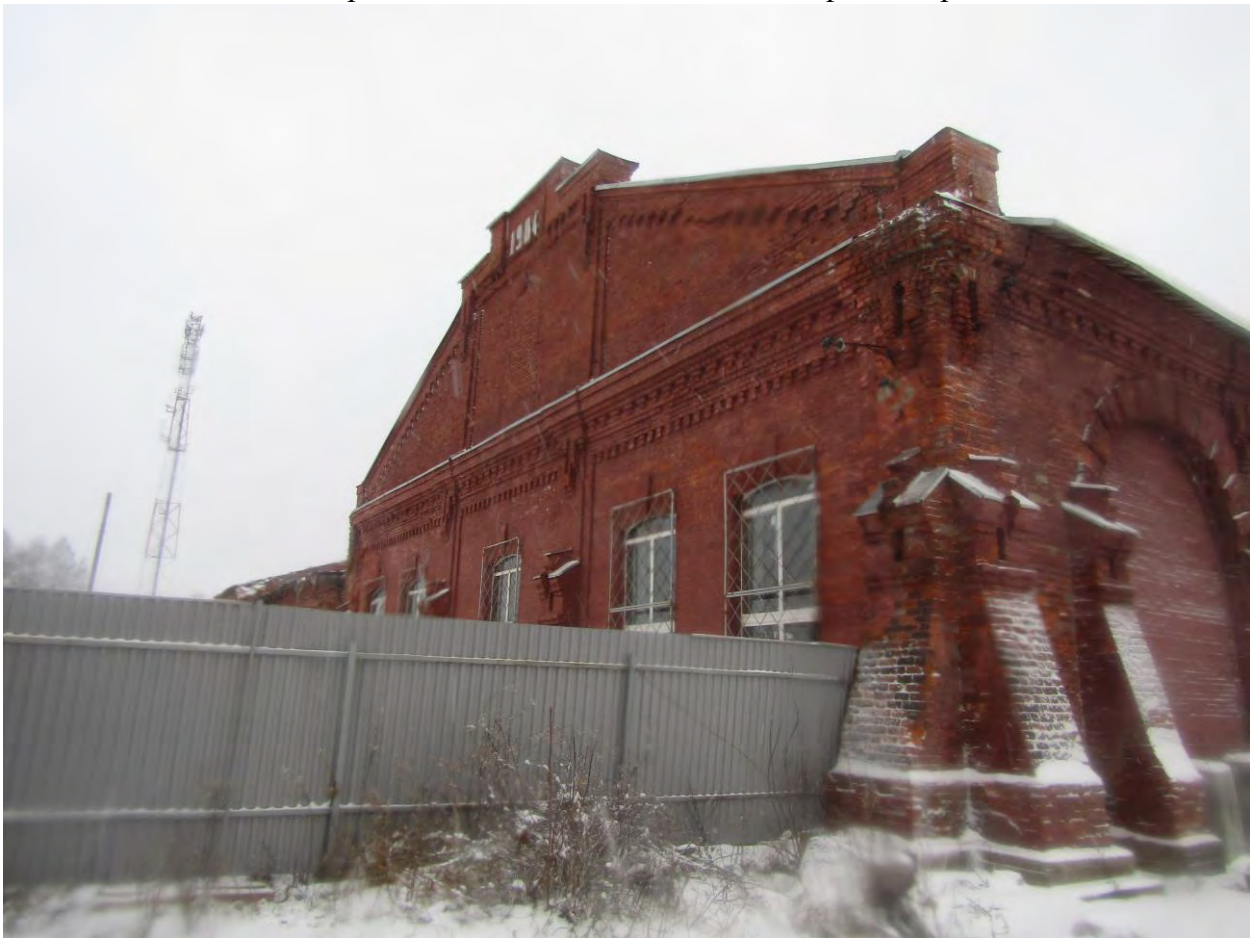
Фото.12. Веерное депо. Вид на южный фасад.
