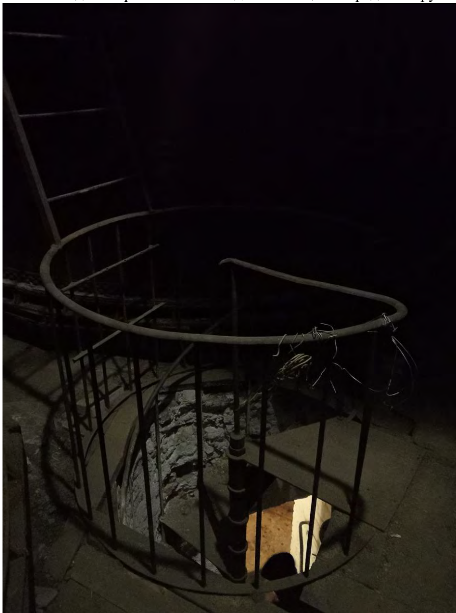
Фото.55. Водонапорная башня. Верхний ярус. Вид на винтовую лестницу.
