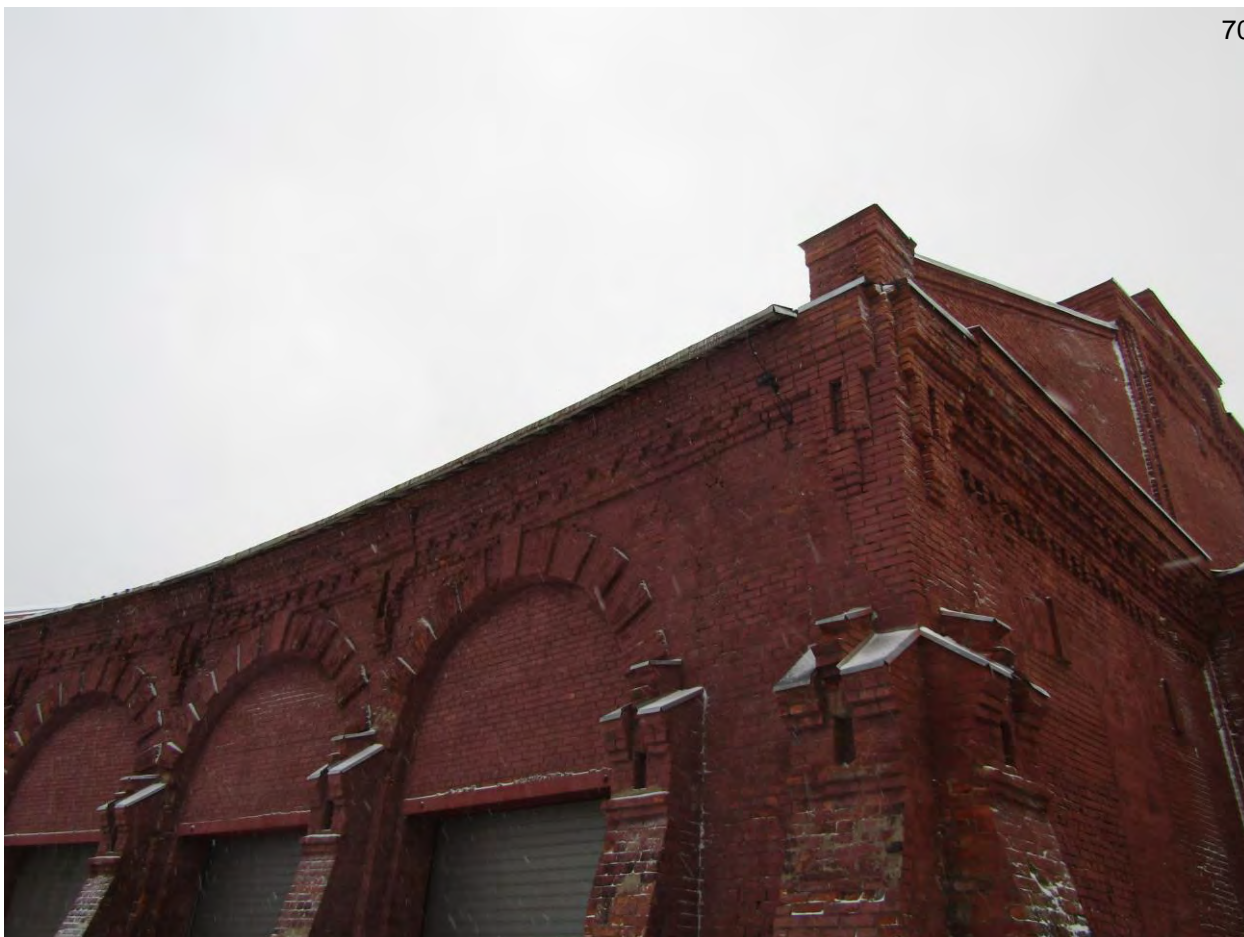
Фото.7. Веерное депо. Вид на юго-восточный фасад. Фрагмент.
