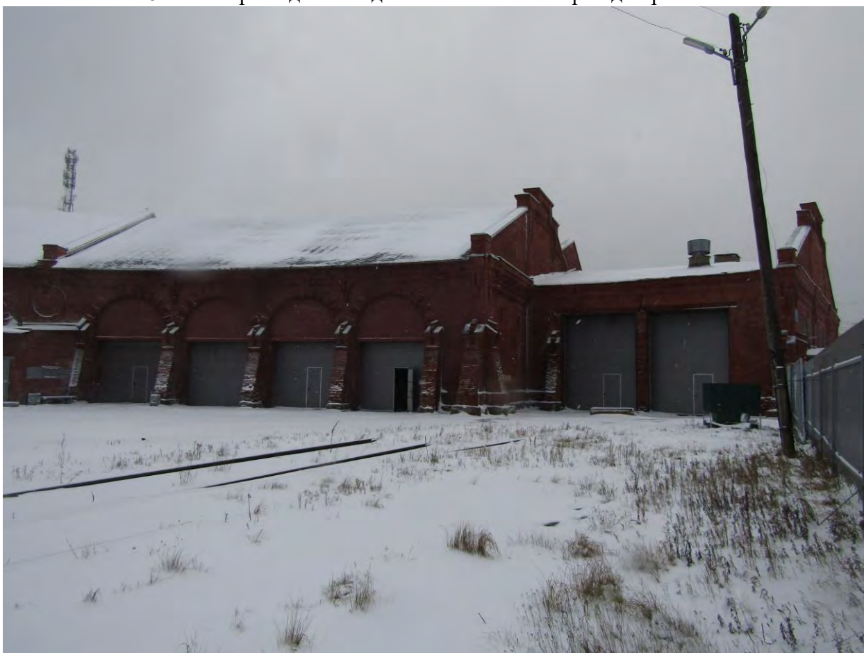
Фото.6. Веерное депо. Вид на юго-восточный фасад. Фрагмент.
