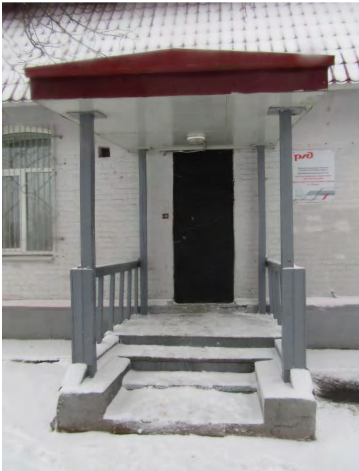
Фото.70. Контора. Вид на западный фасад.
