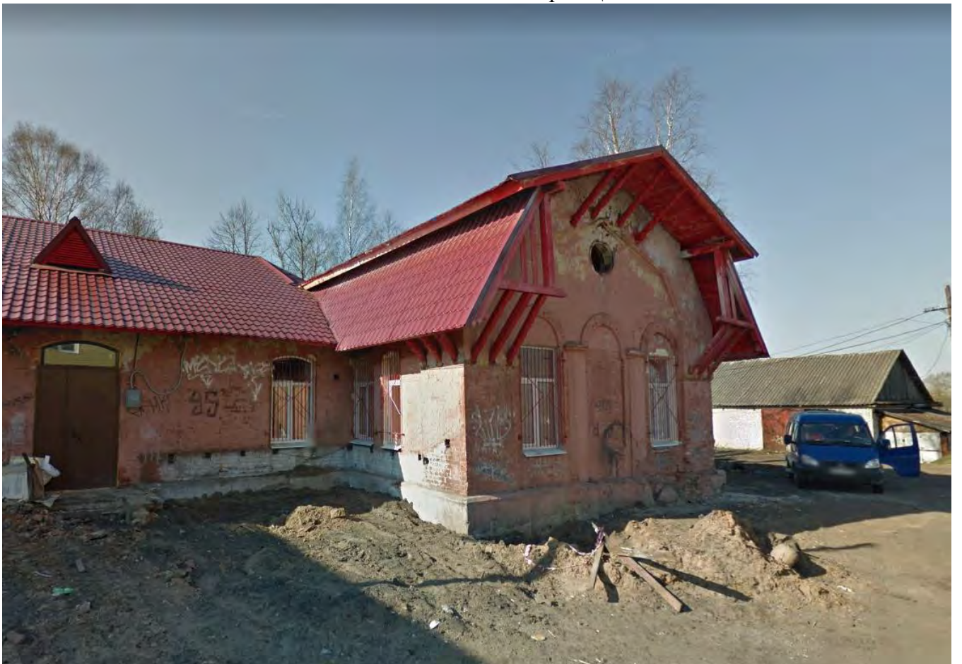
Илл.25. Вид на здание конторы. Северный фасад. 2013 г.
