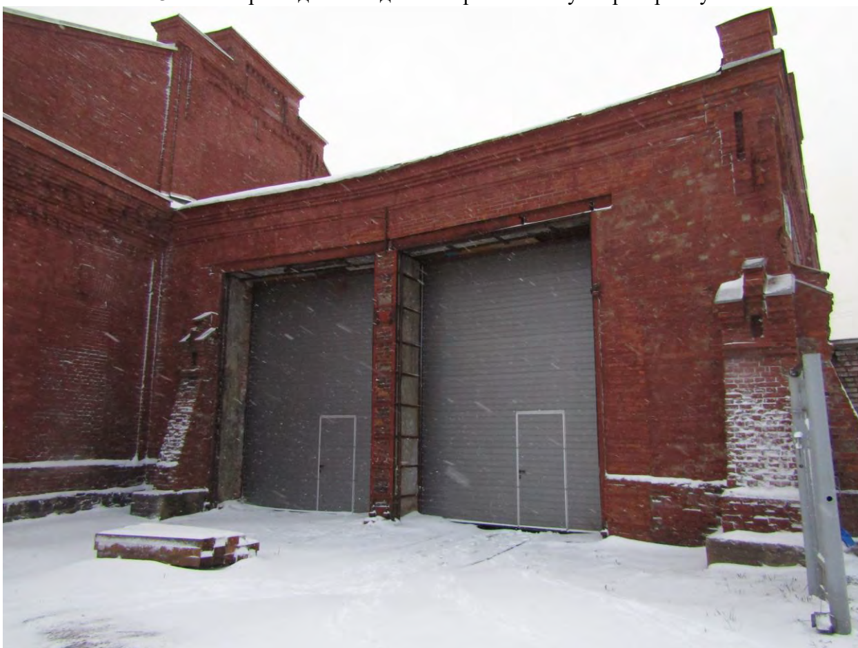
Фото.4. Веерное депо. Вид на юго-восточный фасад. Фрагмент.
