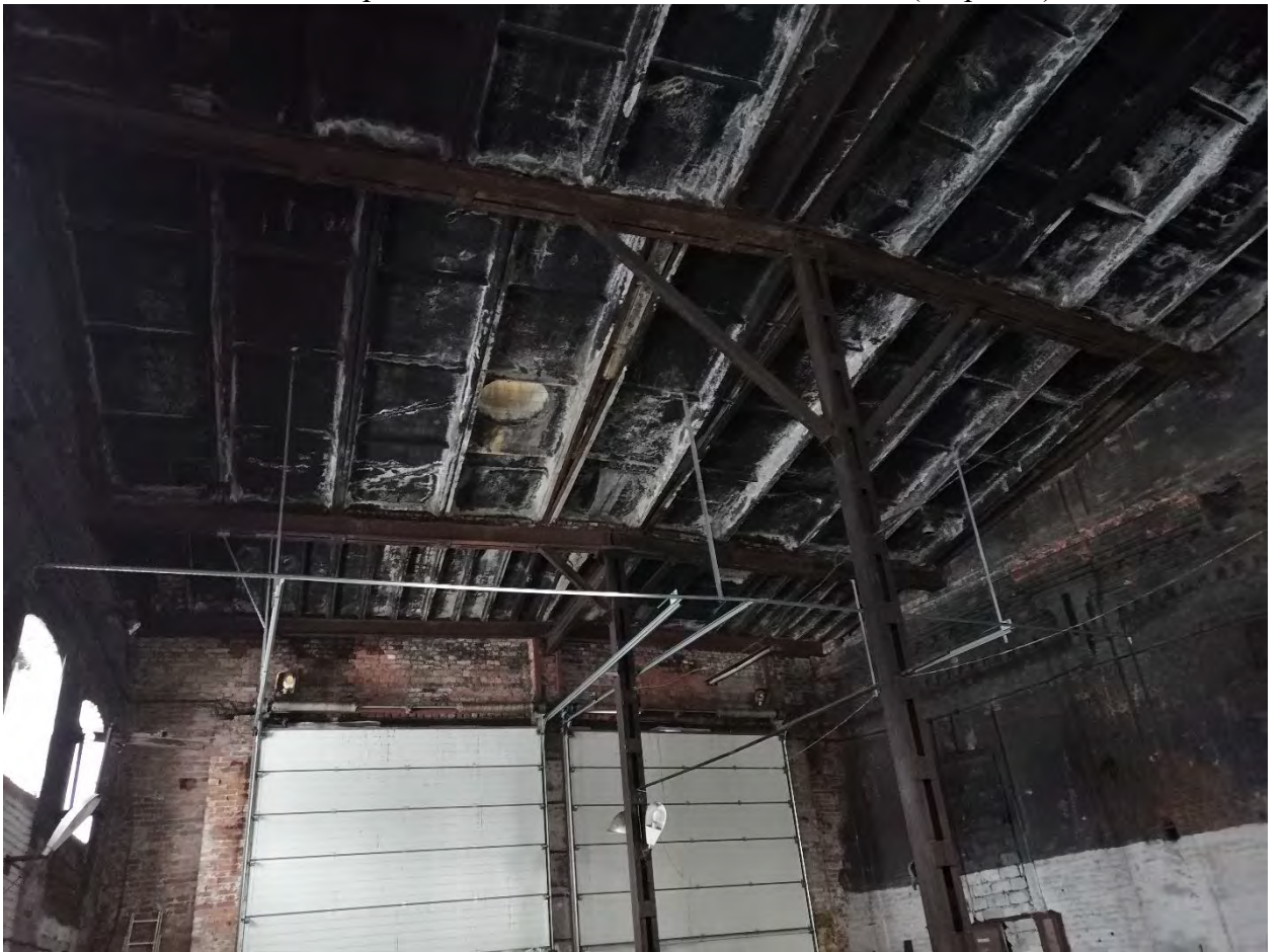
Фото.38. Веерное депо. Общий вид на помещение 1 (северное). Фермы.
