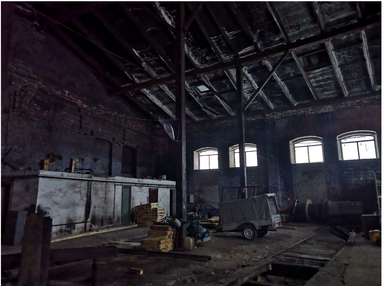
Фото.37. Веерное депо. Общий вид на помещение 1 (северное).
