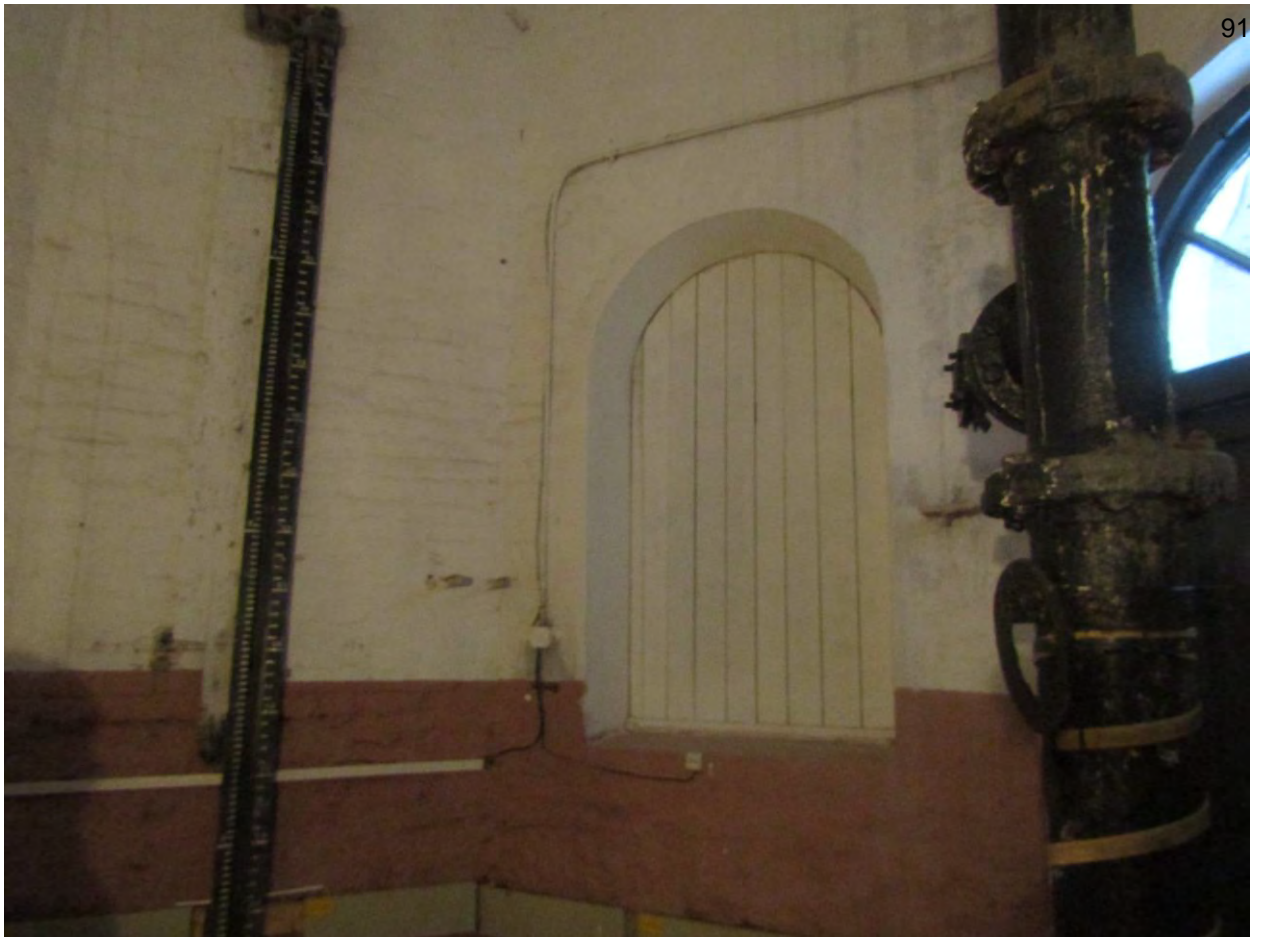
Фото.48. Водонапорная башня. Вид на помещение первого яруса.
