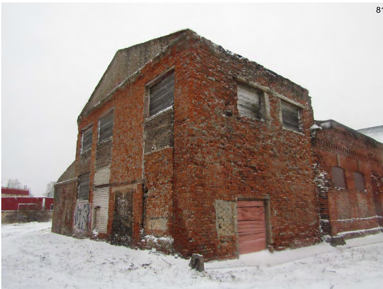
Фото.29. Веерное депо. Вид на западную пристройку с юго-запада.
