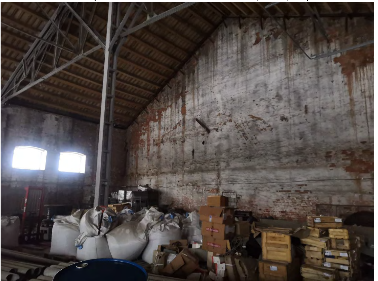
Фото.34. Веерное депо. Общий вид на помещение 1 (южное).
