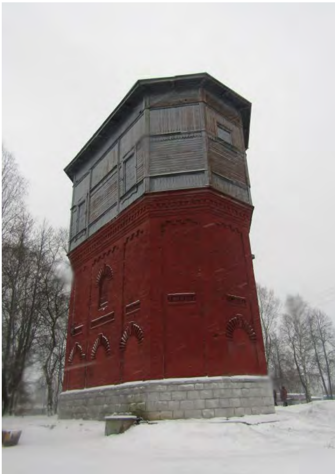
Фото.45. Водонапорная башня. Вид с северо-запада.
