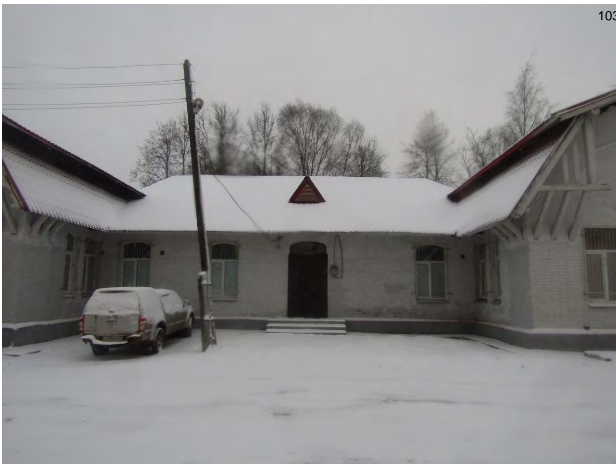
Фото.67. Контора. Вид на центральную часть северного фасада.
