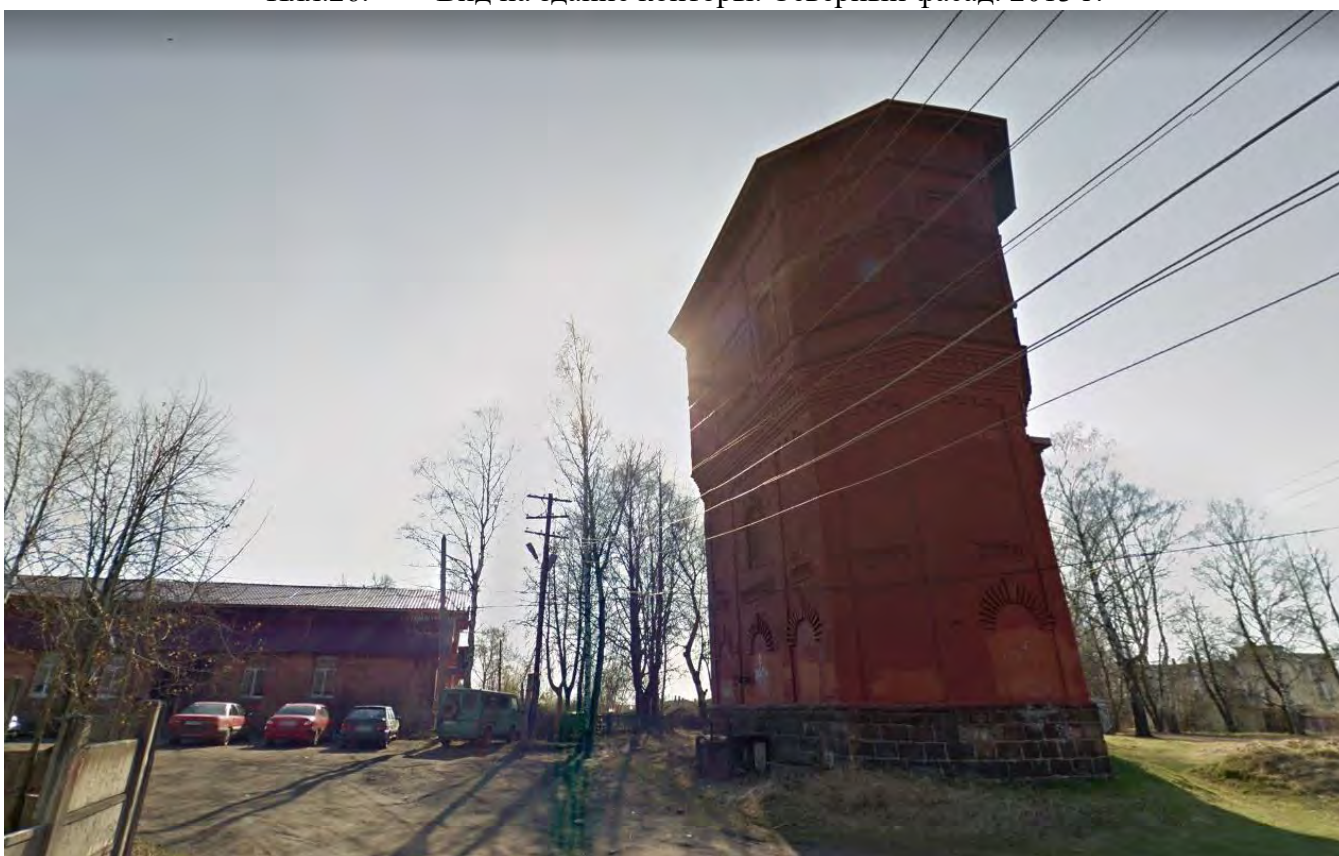
Илл.27. Вид на здание водонапорной башни. Западный фасад. 2013 г.
