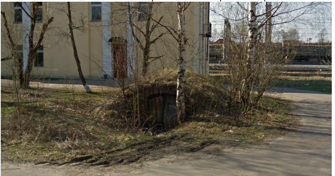
Илл.33. Вид на ледник. Северный фасад. 2013 г.
