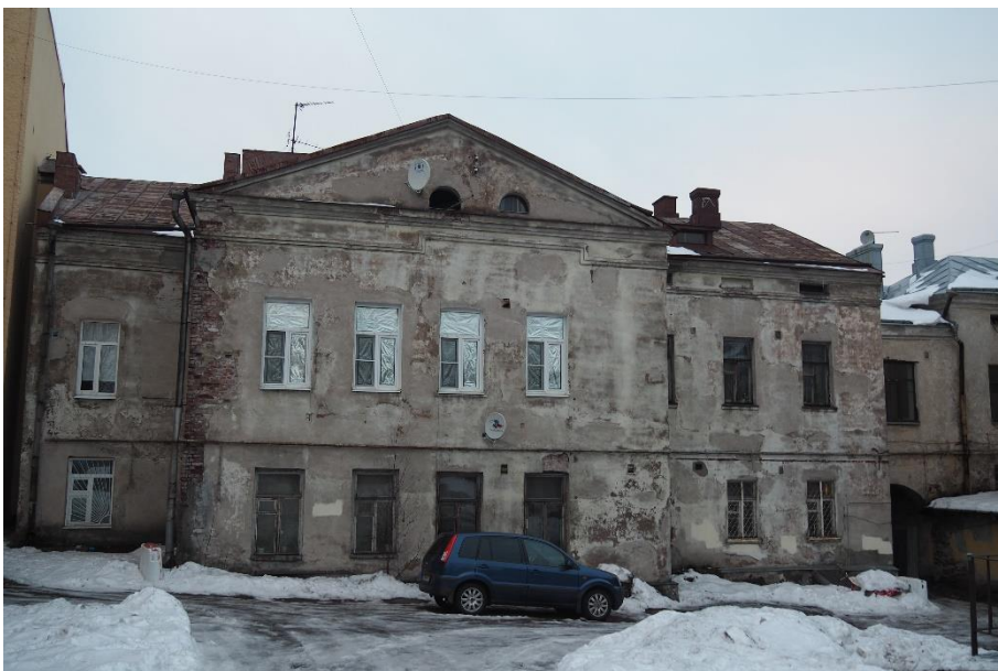
10. «Жилой дом А.В. Шушина», Ленинградская область, Выборгский район, г. Выборг, ул. Красноармейская, д. 9. Дворовый фасад. Общий вид. Фото 30.11.2021г.
