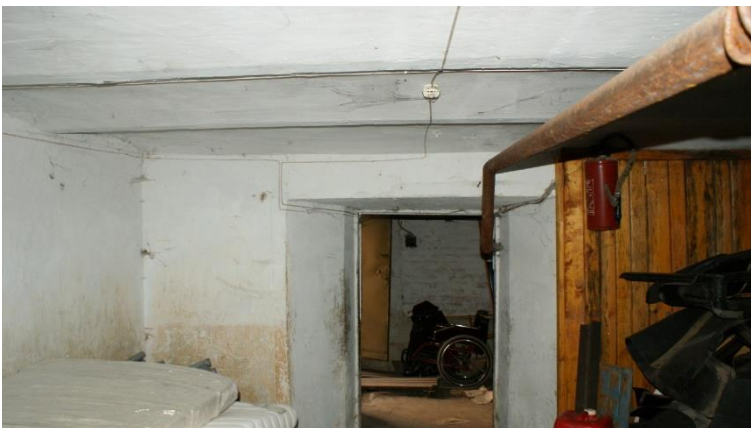
17. «Жилой дом А.В. Шушина», Ленинградская область, Выборгский район, г. Выборг, ул. Красноармейская, д. 9. Подвал. Общий вид. Фото 30.11.2021г.
