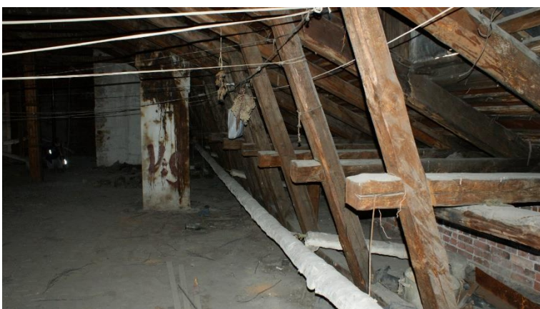
19. «Жилой дом А.В. Шушина», Ленинградская область, Выборгский район, г. Выборг, ул. Красноармейская, д. 9. Чердак. Общий вид. Фото 30.11.2021г.
