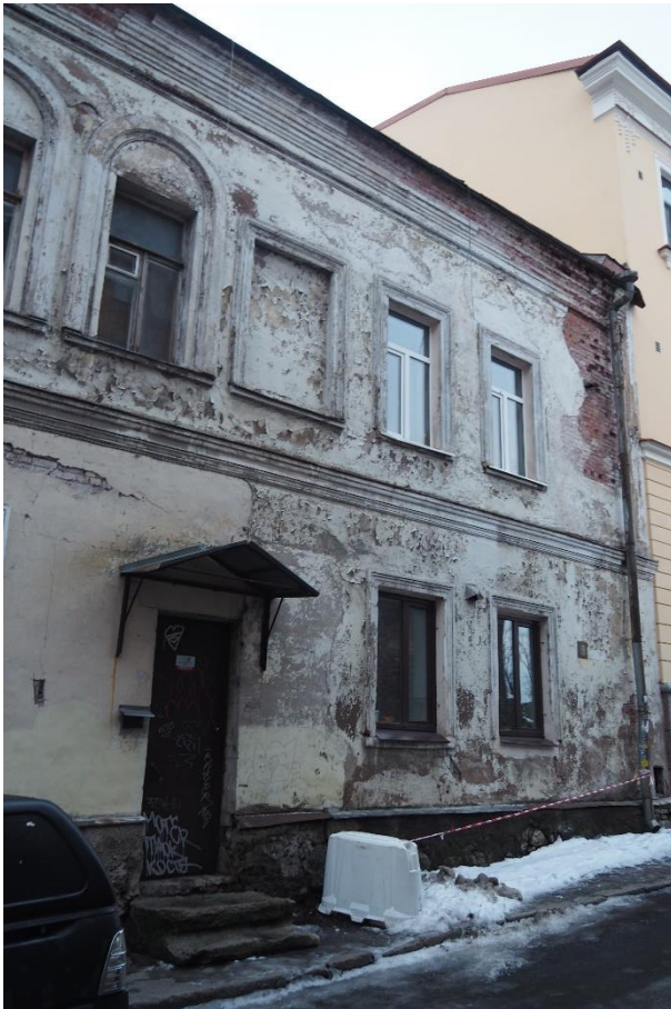
4. «Жилой дом А.В. Шушина», Ленинградская область, Выборгский район, г. Выборг, ул. Красноармейская, д. 9. Северо-западный фасад. Фрагмент. Фото 30.11.2021г.
