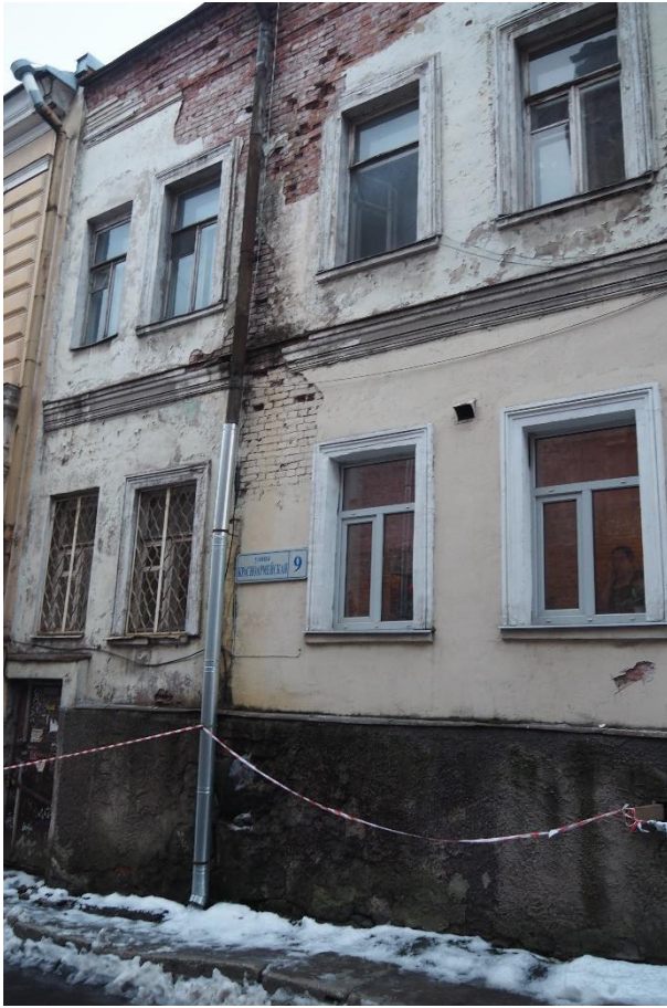
7. «Жилой дом А.В. Шушина», Ленинградская область, Выборгский район, г. Выборг, ул. Красноармейская, д. 9. Северо-западный фасад. Фрагмент. Фото 30.11.2021г.
