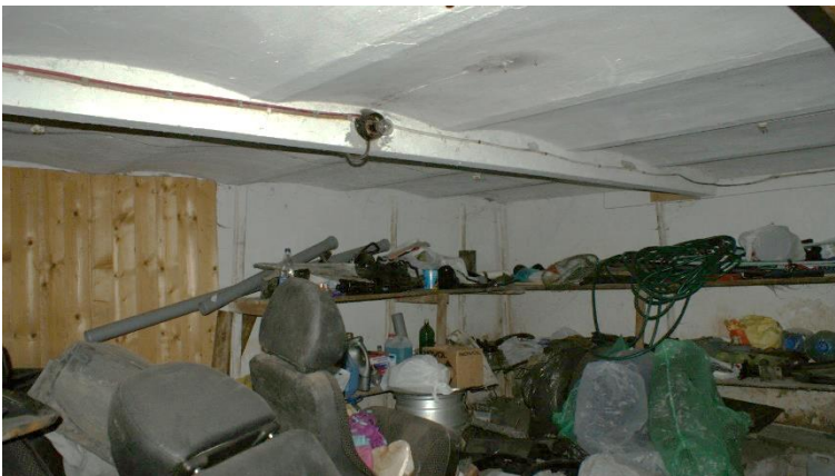
16. «Жилой дом А.В. Шушина», Ленинградская область, Выборгский район, г. Выборг, ул. Красноармейская, д. 9. Подвал. Общий вид. Фото 30.11.2021г.
