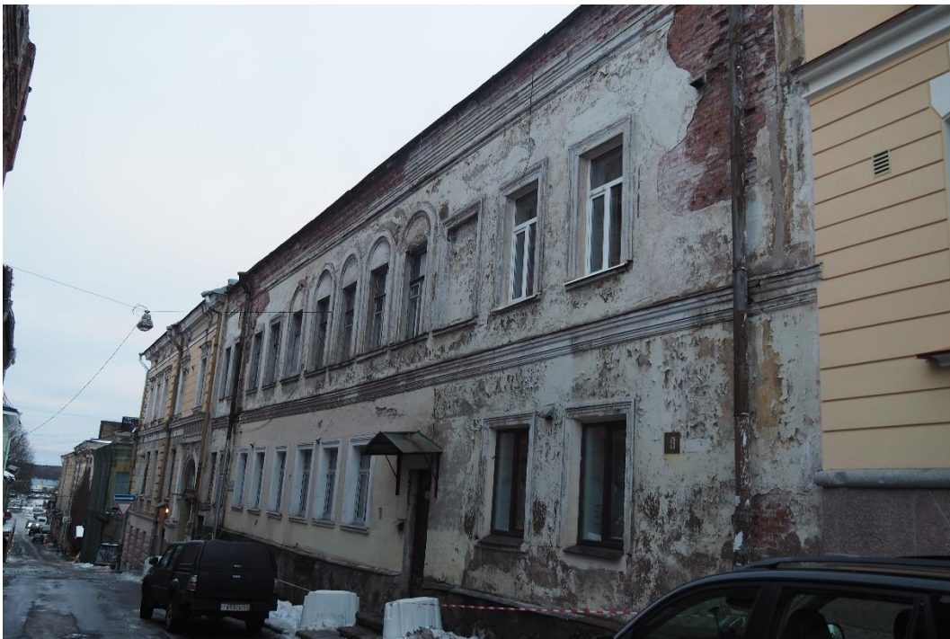
2. «Жилой дом А.В. Шушина», Ленинградская область, Выборгский район, г. Выборг, ул. Красноармейская, д. 9. Северо-западный фасад. Общий вид. Фото 30.11.2021г.
