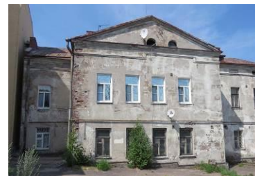
Дворовый Ю-В фасад
