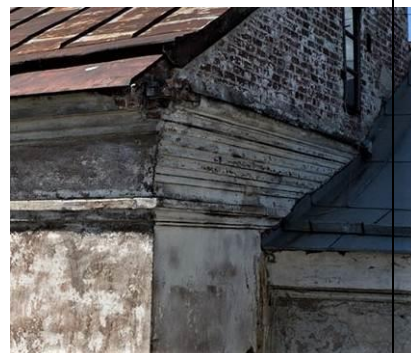
Венчающий карниз (уличный С-З и боковой С-В фасады основного объема здания)
