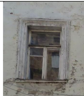
Оформление оконного проема 2-го этажа (уличный С-З фасад)
