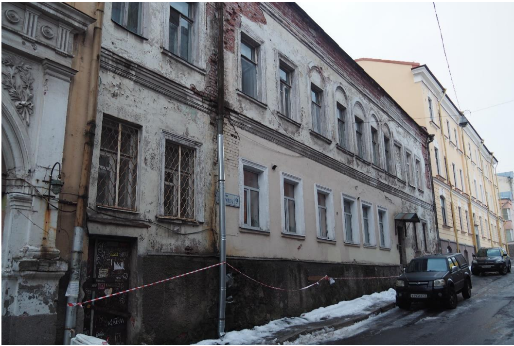
1. «Жилой дом А.В. Шушина», Ленинградская область, Выборгский район, г. Выборг, ул. Красноармейская, д. 9. Северо-западный фасад. Общий вид. Фото 30.11.2021г.
