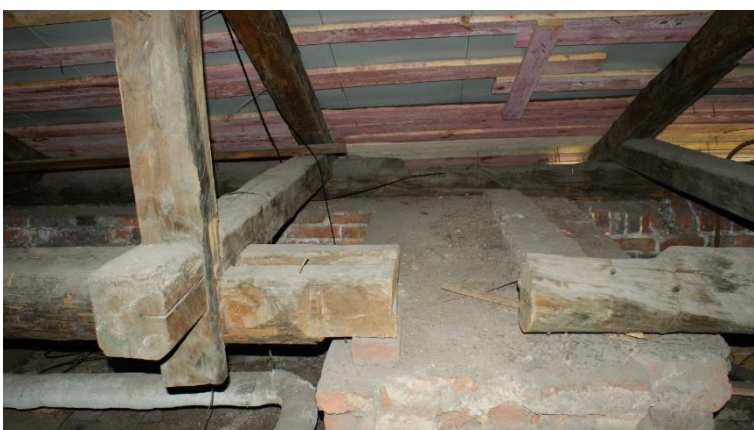
24. «Жилой дом б.М. Хакман», Ленинградская область, Выборгский район, г. Выборг, ул. Красноармейская, д. 14. Чердак. Фрагмент. Фото 30.11.2021г.
