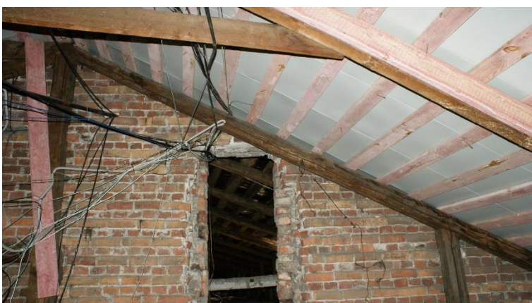
25. «Жилой дом б.М. Хакман», Ленинградская область, Выборгский район, г. Выборг, ул. Красноармейская, д. 14. Чердак. Фрагмент. Фото 30.11.2021г.
