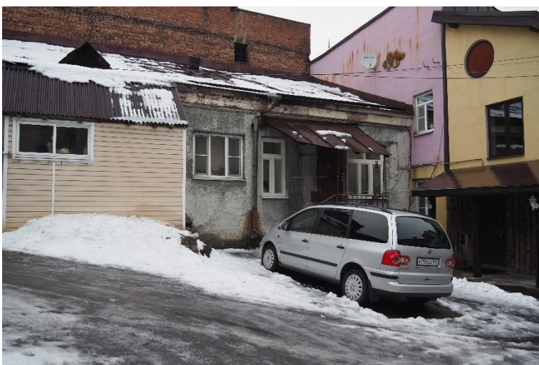
15. «Жилой дом б.М. Хакман», Ленинградская область, Выборгский район, г. Выборг, ул. Красноармейская, д. 14. Дворовый фасад. Фрагмент. Фото 30.11.2021г.
