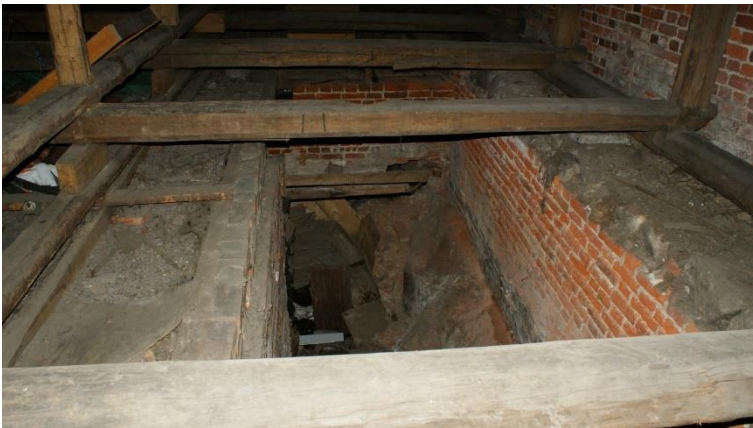
27. «Жилой дом б.М. Хакман», Ленинградская область, Выборгский район, г. Выборг, ул. Красноармейская, д. 14. Чердак. Фрагмент. Фото 30.11.2021г.
