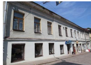
Лицевой Ю-В фасад
