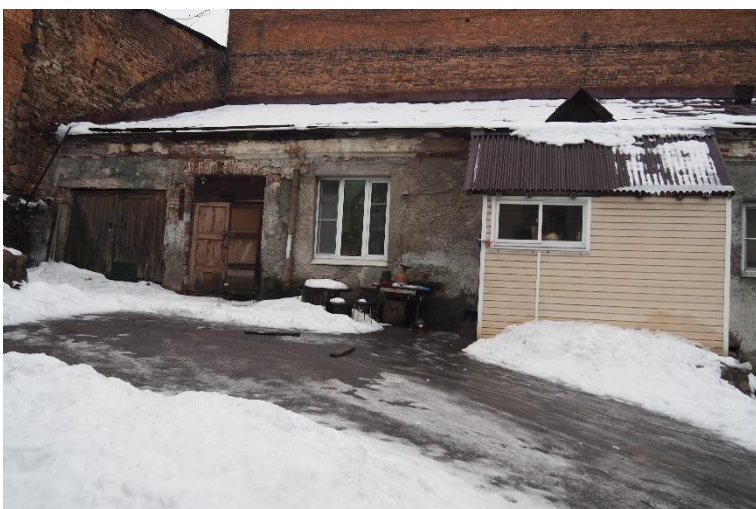
14. «Жилой дом б.М. Хакман», Ленинградская область, Выборгский район, г. Выборг, ул. Красноармейская, д. 14. Дворовый фасад. Фрагмент. Фото 30.11.2021г.
