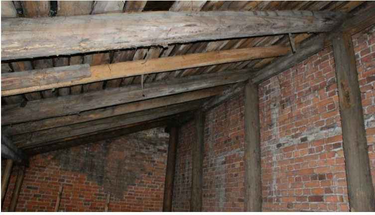
26. «Жилой дом б.М. Хакман», Ленинградская область, Выборгский район, г. Выборг, ул. Красноармейская, д. 14. Чердак. Фрагмент. Фото 30.11.2021г.
