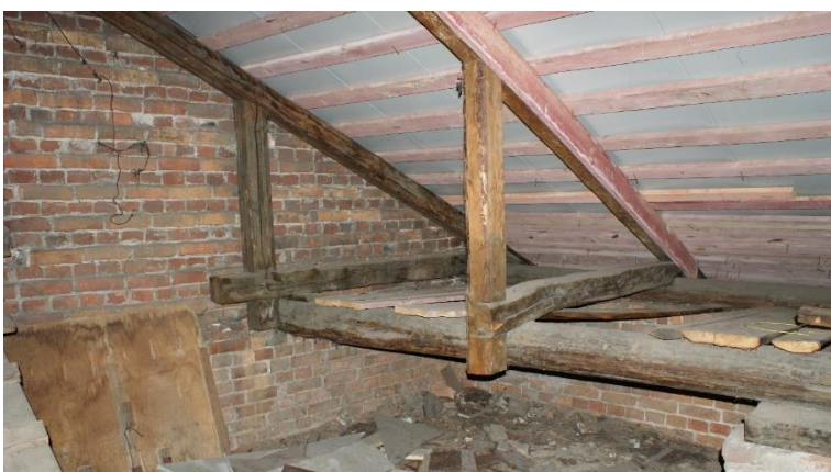
21. «Жилой дом б.М. Хакман», Ленинградская область, Выборгский район, г. Выборг, ул. Красноармейская, д. 14. Чердак. Фрагмент. Фото 30.11.2021г.
