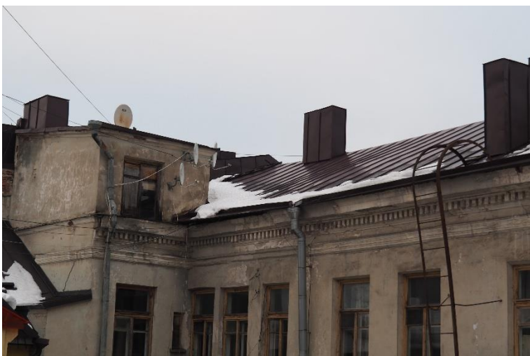
13. «Жилой дом б.М. Хакман», Ленинградская область, Выборгский район, г. Выборг, ул. Красноармейская, д. 14. Дворовый фасад. Фрагмент. Фото 30.11.2021г.
