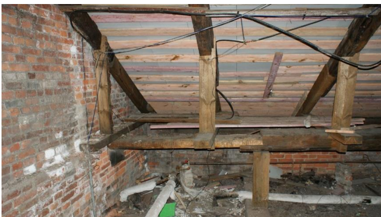
23. «Жилой дом б.М. Хакман», Ленинградская область, Выборгский район, г. Выборг, ул. Красноармейская, д. 14. Чердак. Фрагмент. Фото 30.11.2021г.
