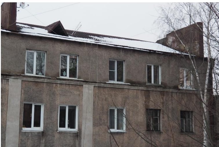
5. «Военно-сиротский дом», Ленинградская область, Выборгский район, г. Выборг, ул. Крепостная, д. 21. Дворовый фасад. Фрагмент. Фото 30.11.2021г.
