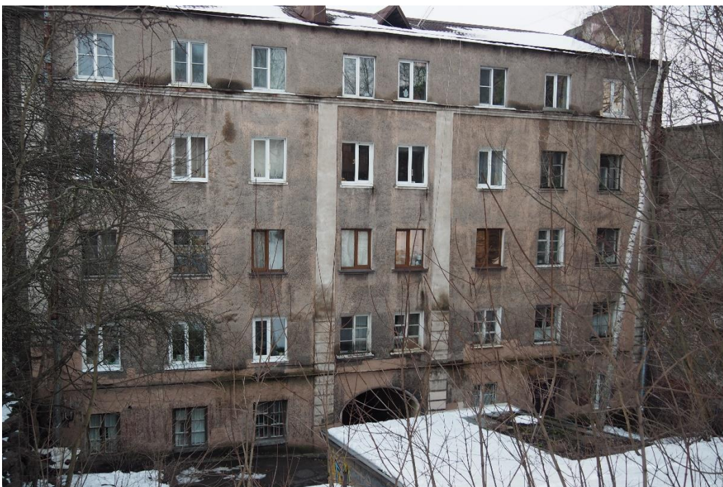
3. «Военно-сиротский дом», Ленинградская область, Выборгский район, г. Выборг, ул. Крепостная, д. 21. Дворовый фасад. Общий вид. Фото 30.11.2021г.
