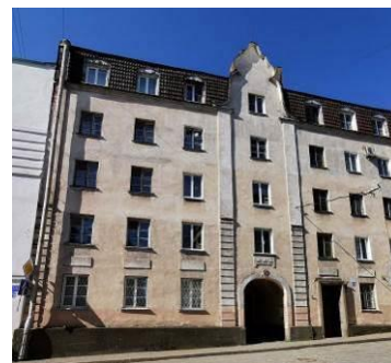
Лицевой С-В фасад
