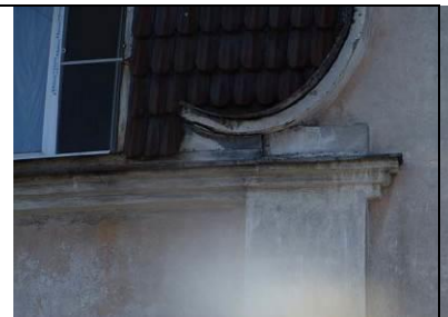
Карниз (лицевой фасад)
