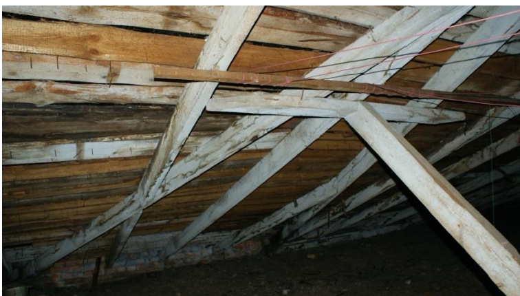
20. «Военно-сиротский дом», Ленинградская область, Выборгский район, г. Выборг, ул. Крепостная, д. 21. Чердак. Фрагмент. Фото 30.11.2021г.
