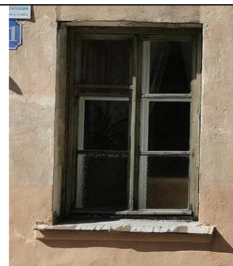
Подоконная тяга (проем 1-го этажа, лицевой фасад)
