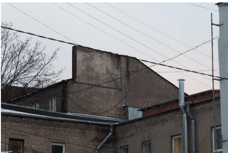
11. «Военно-сиротский дом», Ленинградская область, Выборгский район, г. Выборг, ул. Крепостная, д. 21. Дворовый фасад. Фрагмент. Фото 30.11.2021г.
