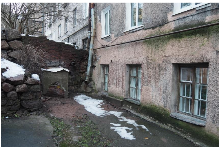
12. «Военно-сиротский дом», Ленинградская область, Выборгский район, г. Выборг, ул. Крепостная, д. 21. Дворовый фасад. Фрагмент. Фото 30.11.2021г.
