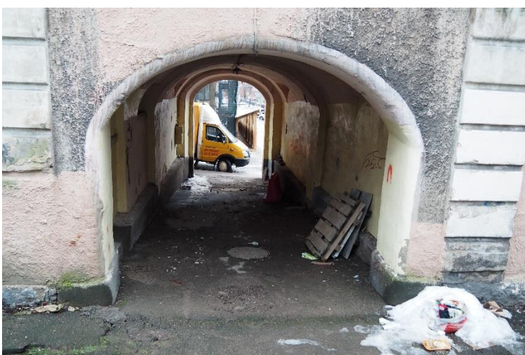
13. «Военно-сиротский дом», Ленинградская область, Выборгский район, г. Выборг, ул. Крепостная, д. 21. Дворовый фасад. Фрагмент. Фото 30.11.2021г.
