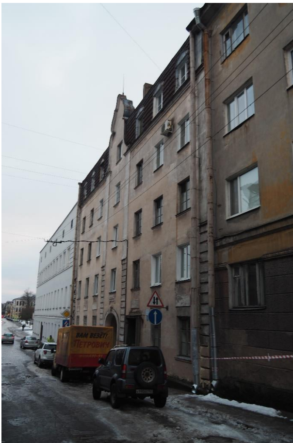
2. «Военно-сиротский дом», Ленинградская область, Выборгский район, г. Выборг, ул. Крепостная, д. 21. Северо-восточный фасад. Общий вид. Фото 30.11.2021г.
