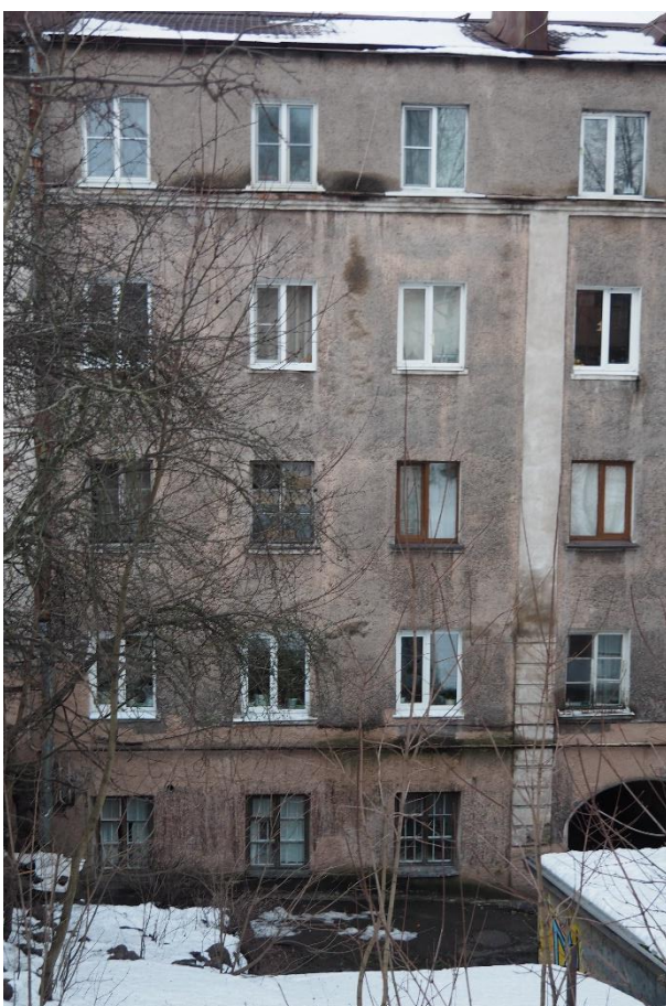
4. «Военно-сиротский дом», Ленинградская область, Выборгский район, г. Выборг, ул. Крепостная, д. 21. Дворовый фасад. Фрагмент. Фото 30.11.2021г.
