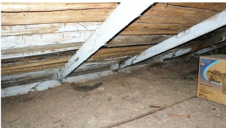
21. «Военно-сиротский дом», Ленинградская область, Выборгский район, г. Выборг, ул. Крепостная, д. 21. Чердак. Фрагмент. Фото 30.11.2021г.
