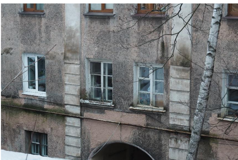
10. «Военно-сиротский дом», Ленинградская область, Выборгский район, г. Выборг, ул. Крепостная, д. 21. Дворовый фасад. Фрагмент. Фото 30.11.2021г.
