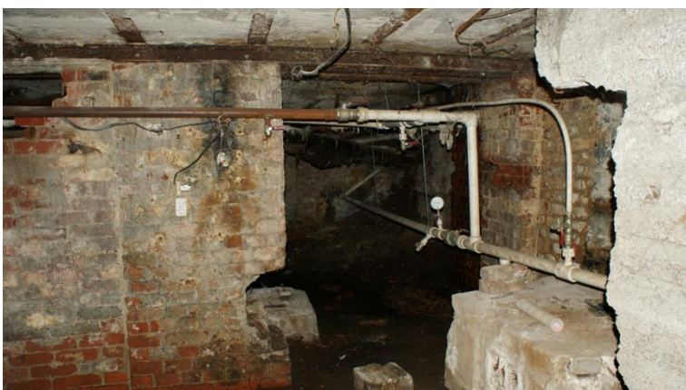
37. «Жилой дом И. Франкехаузера», Ленинградская область, Выборгский район, г. Выборг, ул. Сторожевой башни, д. 10. Подвал. Фрагмент. Фото 30.11.2021г.
