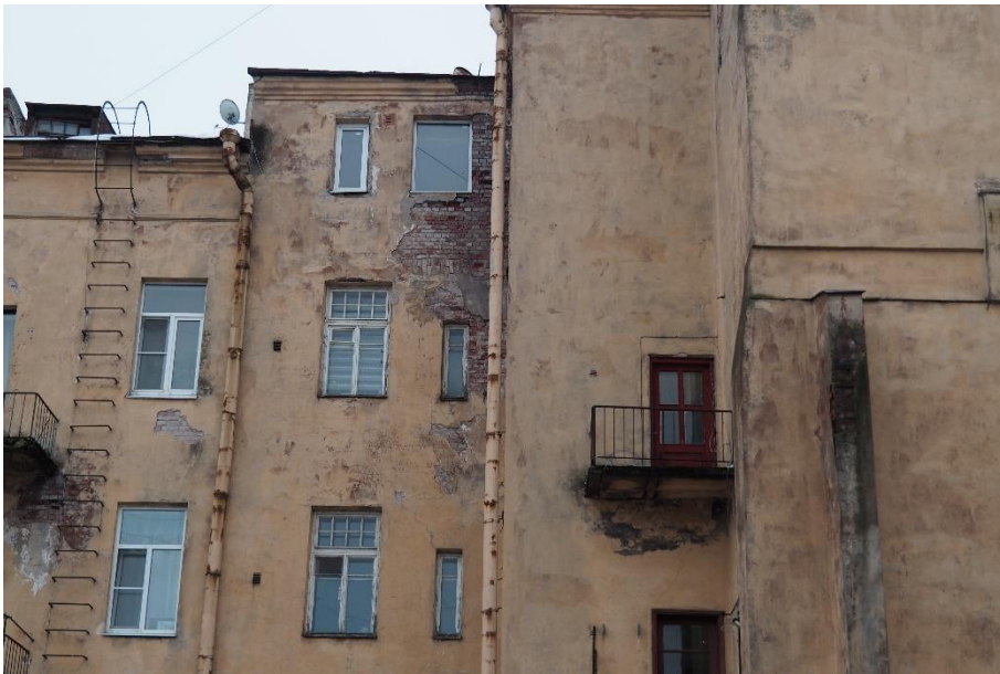
25. «Жилой дом И. Франкехаузера», Ленинградская область, Выборгский район, г. Выборг, ул. Сторожевой башни, д. 10. Дворовый фасад. Фрагмент. Фото 30.11.2021г.
