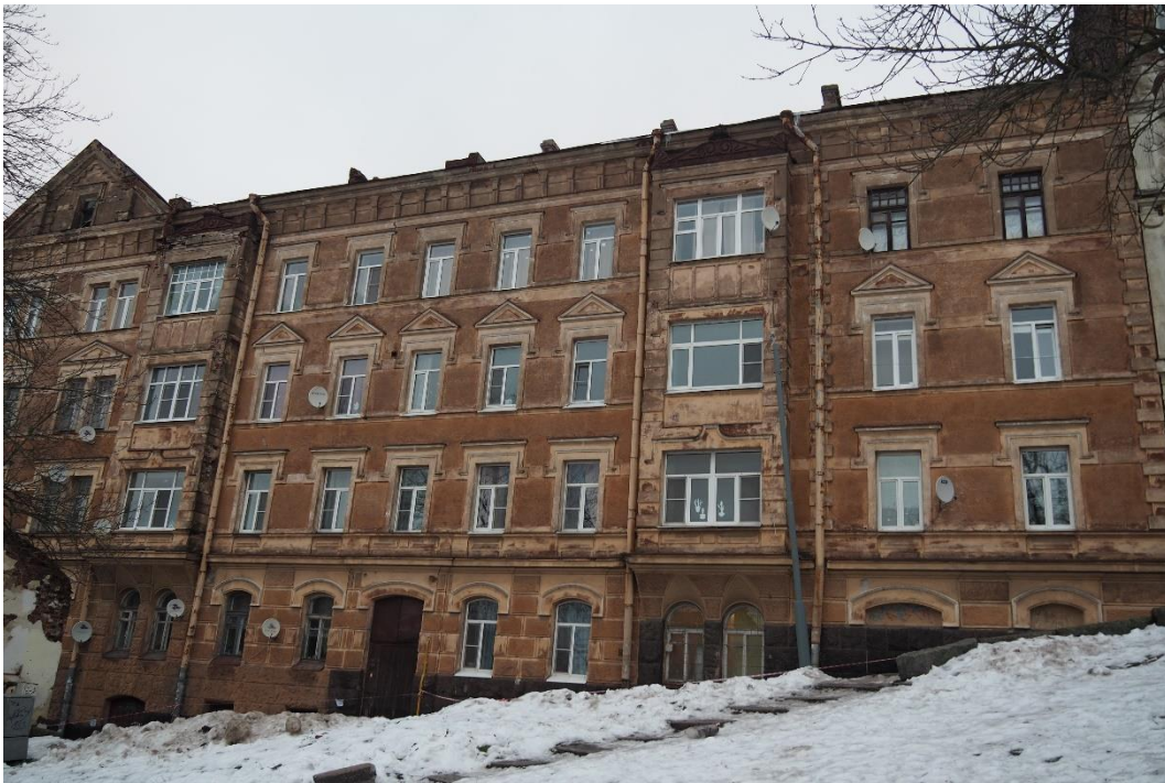
3. «Жилой дом И. Франкехаузера», Ленинградская область, Выборгский район, г. Выборг, ул. Сторожевой башни, д. 10. Юго-западный фасад. Общий вид. Фото 30.11.2021г.
