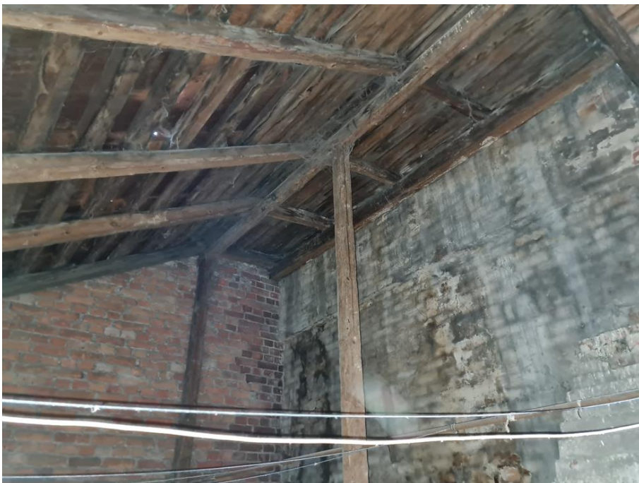
38. «Жилой дом И. Франкехаузера», Ленинградская область, Выборгский район, г. Выборг, ул. Сторожевой башни, д. 10. Чердак. Общий вид. Фото 30.11.2021г.
