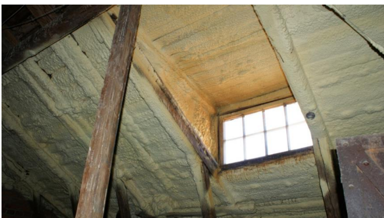
54. «Жилой дом И. Франкехаузера», Ленинградская область, Выборгский район, г. Выборг, ул. Сторожевой башни, д. 10. Чердак. Фрагмент. Фото 30.11.2021г.
