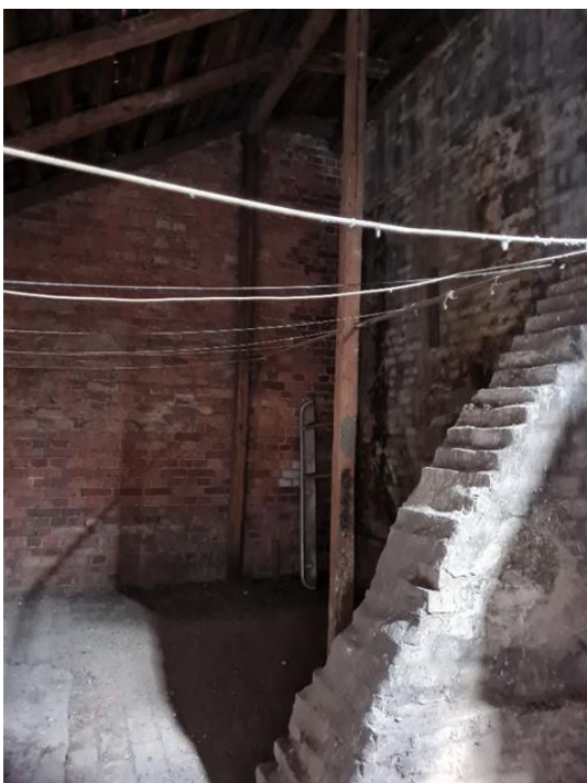
40. «Жилой дом И. Франкехаузера», Ленинградская область, Выборгский район, г. Выборг, ул. Сторожевой башни, д. 10. Чердак. Фрагмент. Фото 30.11.2021г.
