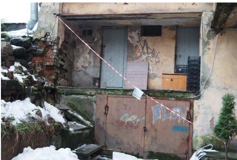
22. «Жилой дом И. Франкехаузера», Ленинградская область, Выборгский район, г. Выборг, ул. Сторожевой башни, д. 10. Дворовый фасад. Фрагмент. Фото 30.11.2021г.
