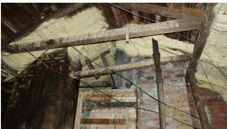
45. «Жилой дом И. Франкехаузера», Ленинградская область, Выборгский район, г. Выборг, ул. Сторожевой башни, д. 10. Чердак. Фрагмент. Фото 30.11.2021г.
