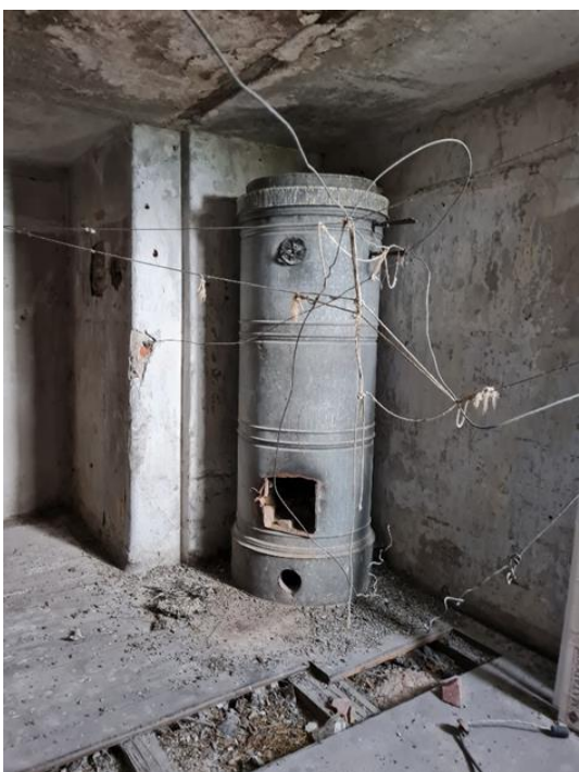
41. «Жилой дом И. Франкехаузера», Ленинградская область, Выборгский район, г. Выборг, ул. Сторожевой башни, д. 10. Чердак. Фрагмент. Фото 30.11.2021г.
