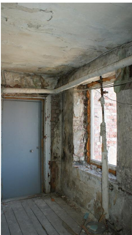
43. «Жилой дом И. Франкехаузера», Ленинградская область, Выборгский район, г. Выборг, ул. Сторожевой башни, д. 10. Чердак. Фрагмент. Фото 30.11.2021г.
