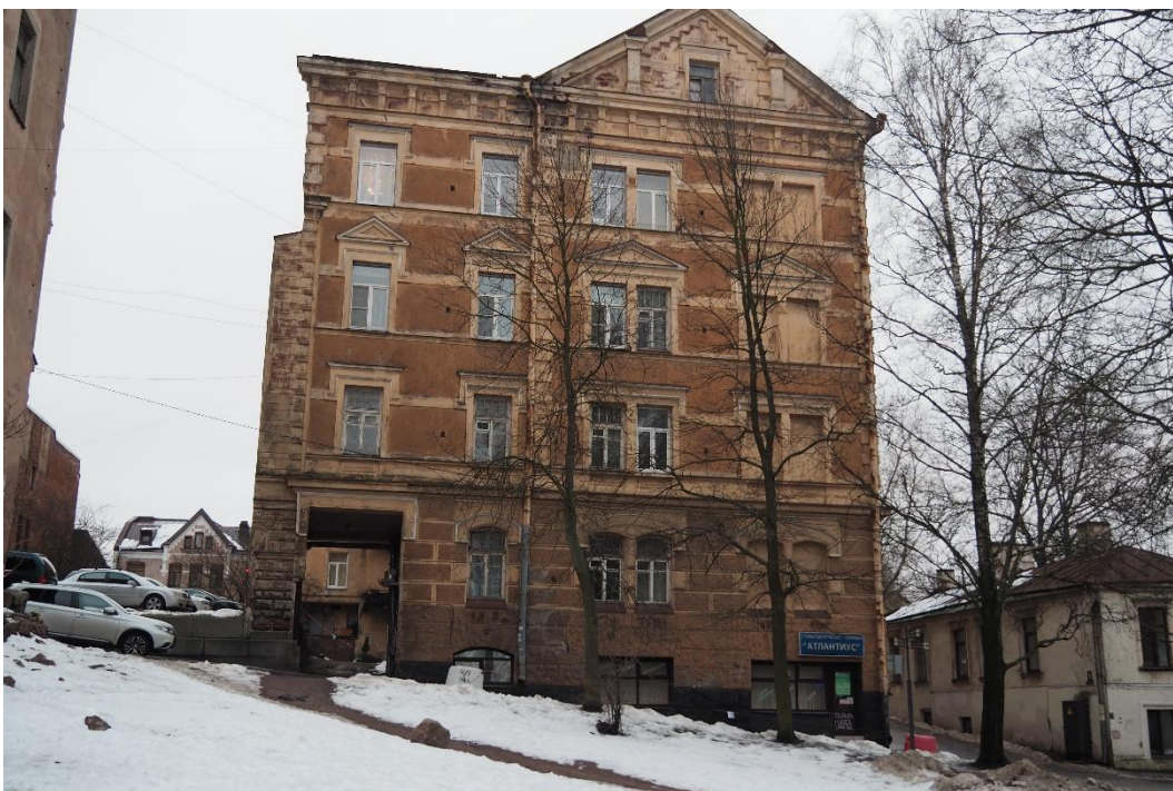
1. «Жилой дом И. Франкехаузера», Ленинградская область, Выборгский район, г. Выборг, ул. Сторожевой башни, д. 10. Северо-западный фасад. Общий вид. Фото 30.11.2021г.
