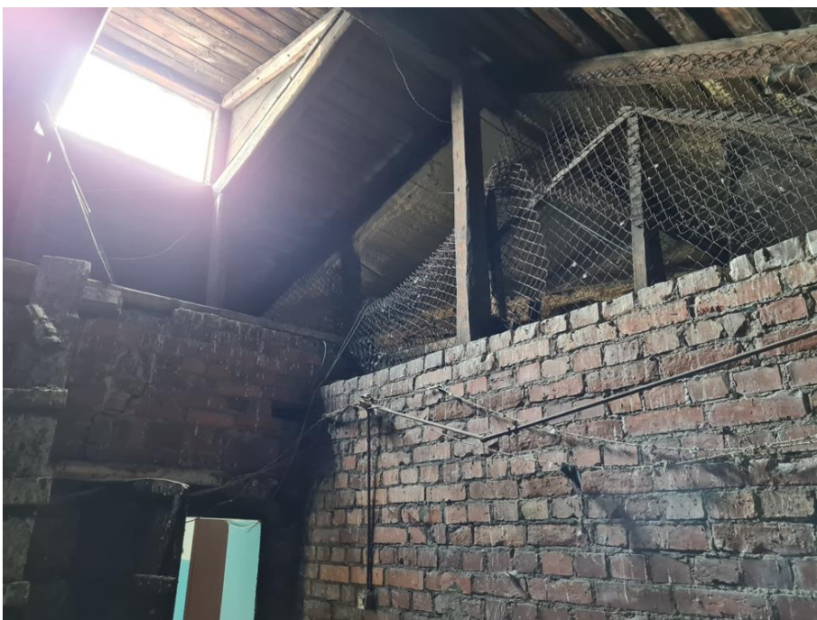
39. «Жилой дом И. Франкехаузера», Ленинградская область, Выборгский район, г. Выборг, ул. Сторожевой башни, д. 10. Чердак. Общий вид. Фото 30.11.2021г.
