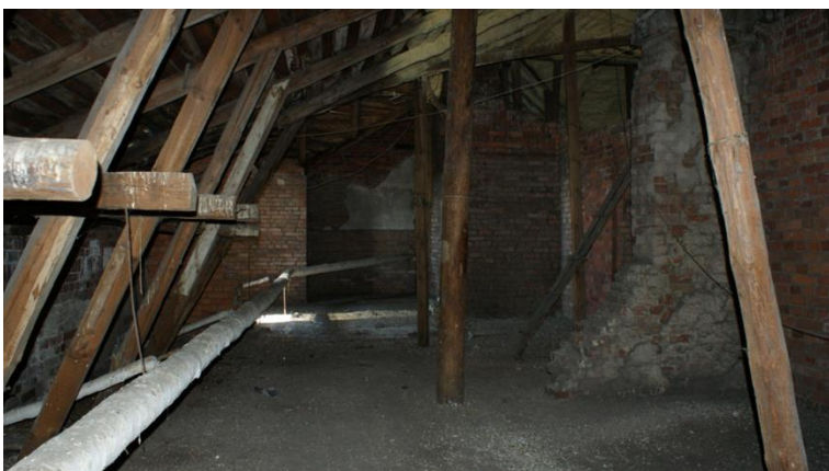
46. «Жилой дом И. Франкехаузера», Ленинградская область, Выборгский район, г. Выборг, ул. Сторожевой башни, д. 10. Чердак. Фрагмент. Фото 30.11.2021г.
