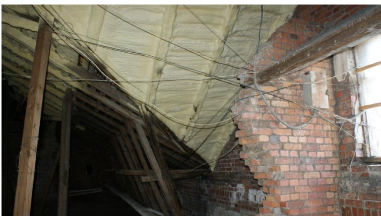
48. «Жилой дом И. Франкехаузера», Ленинградская область, Выборгский район, г. Выборг, ул. Сторожевой башни, д. 10. Чердак. Фрагмент. Фото 30.11.2021г.
