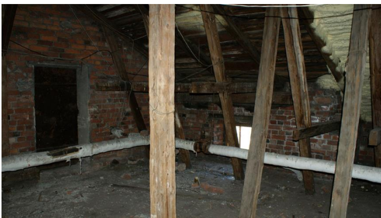
50. «Жилой дом И. Франкехаузера», Ленинградская область, Выборгский район, г. Выборг, ул. Сторожевой башни, д. 10. Чердак. Фрагмент. Фото 30.11.2021г.
