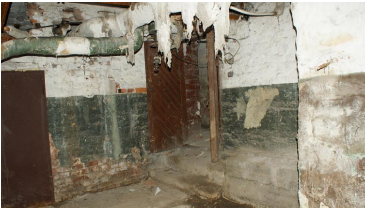
33. «Жилой дом И. Франкехаузера», Ленинградская область, Выборгский район, г. Выборг, ул. Сторожевой башни, д. 10. Подвал. Фрагмент. Фото 30.11.2021г.
