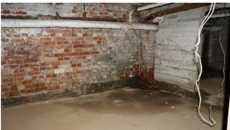
36. «Жилой дом И. Франкехаузера», Ленинградская область, Выборгский район, г. Выборг, ул. Сторожевой башни, д. 10. Подвал. Фрагмент. Фото 30.11.2021г.
