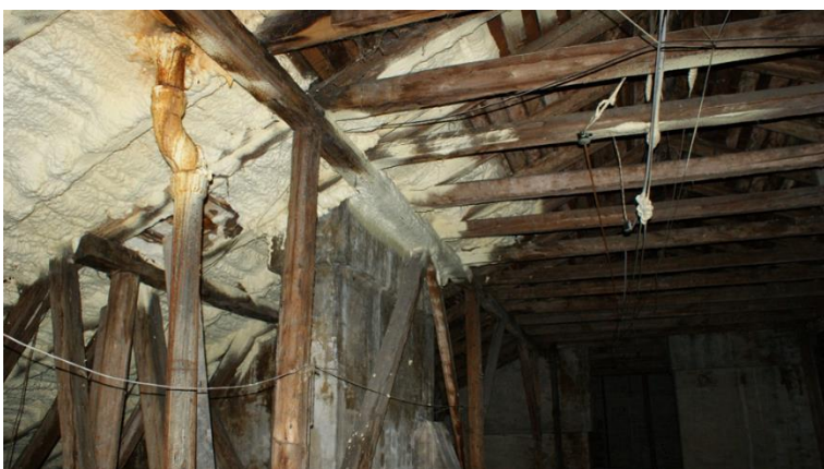
51. «Жилой дом И. Франкехаузера», Ленинградская область, Выборгский район, г. Выборг, ул. Сторожевой башни, д. 10. Чердак. Фрагмент. Фото 30.11.2021г.
