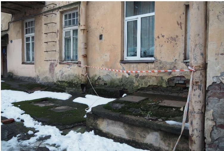
20. «Жилой дом И. Франкехаузера», Ленинградская область, Выборгский район, г. Выборг, ул. Сторожевой башни, д. 10. Дворовый фасад. Фрагмент. Фото 30.11.2021г.
