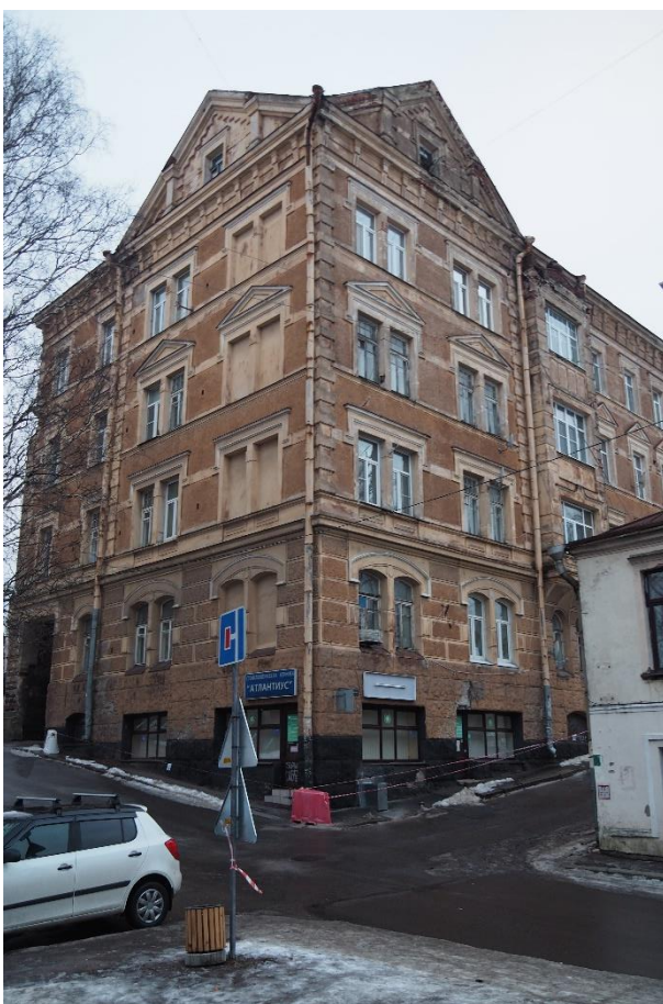
2. «Жилой дом И. Франкехаузера», Ленинградская область, Выборгский район, г. Выборг, ул. Сторожевой башни, д. 10. Общий вид с запада. Фото 30.11.2021г.
