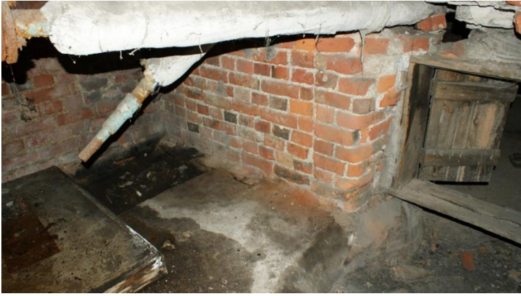
32. «Жилой дом И. Франкехаузера», Ленинградская область, Выборгский район, г. Выборг, ул. Сторожевой башни, д. 10. Подвал. Фрагмент. Фото 30.11.2021г.
