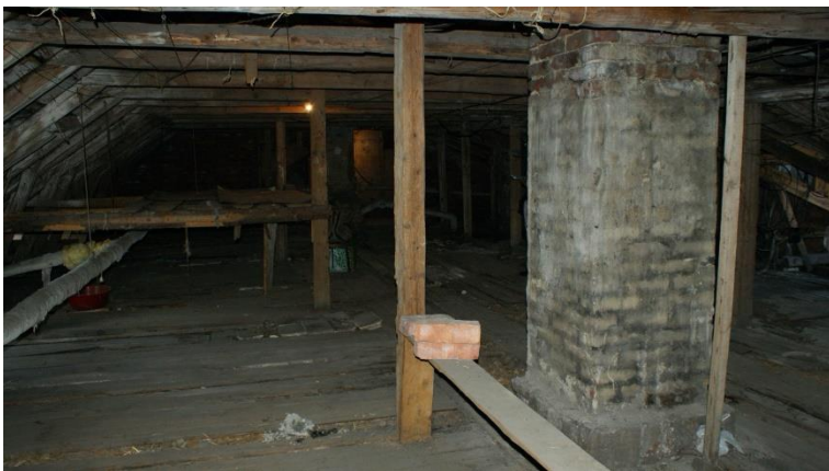
29. «Жилой дом», Ленинградская область, Выборгский район, г. Выборг, ул. Сторожевой башни, д. 12. Чердак. Общий вид. Фото 30.11.2021г.
