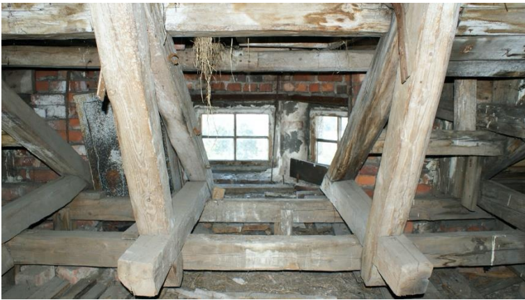
36. «Жилой дом», Ленинградская область, Выборгский район, г. Выборг, ул. Сторожевой башни, д. 12. Чердак. Фрагмент. Фото 30.11.2021г.
