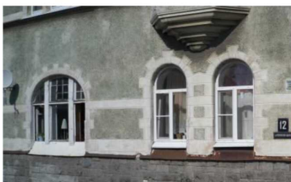
Оконные проемы 2-го яруса (1-го этажа). Лицевой Ю-3 фасад, правая часть
