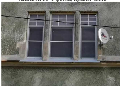
Оконные проемы 3-го яруса (2-го этажа). Лицевой Ю-3 фасад
