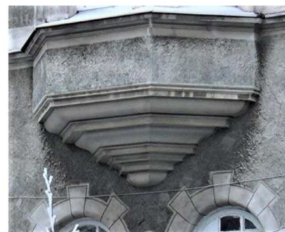
Основания эркеров. Ю-3 фасад
