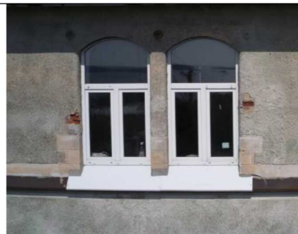
Оконные проемы 5-го яруса (4-го этажа). Лицевой Ю-3 фасад
