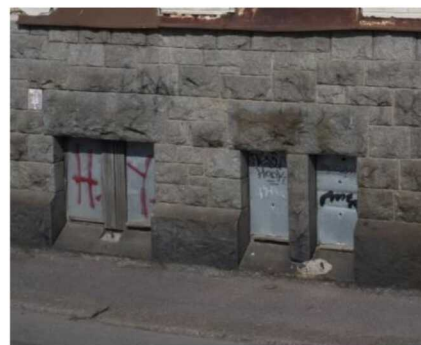
Оконные проемы цокольной части (лицевой Ю-3 фасад)
