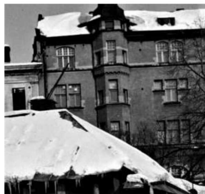
Расстекловка проемов (лицевой фасад). Фото (копия) 1942 г.
