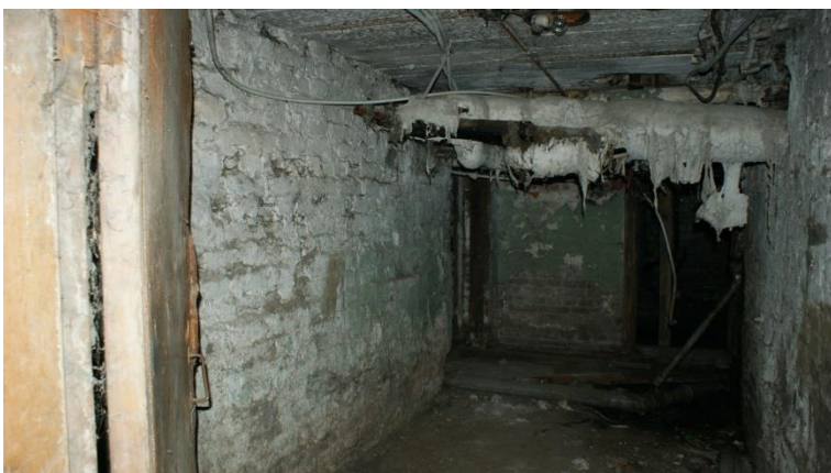
17. «Жилой дом», Ленинградская область, Выборгский район, г. Выборг, ул. Сторожевой башни, д. 12. Подвал. Общий вид. Фото 30.11.2021г.
