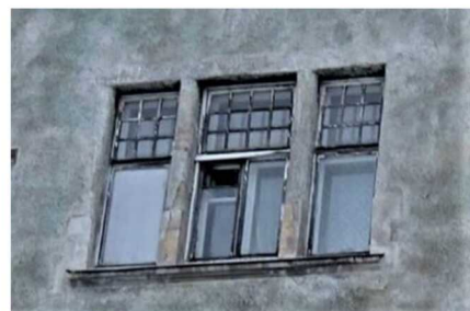
Малый подоконный карниз оконных проемов 3-го этажа. Лицевой Ю-3 фасад
