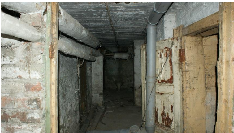
20. «Жилой дом», Ленинградская область, Выборгский район, г. Выборг, ул. Сторожевой башни, д. 12. Подвал. Общий вид. Фото 30.11.2021г.
