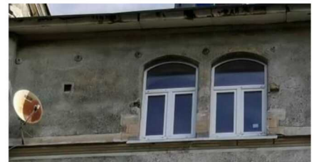
Металлические элементы крепления кронштейнов карниза Ю-3 фасад
