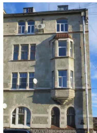
Штукатурные пояса. Лицевой Ю-3 фасад
