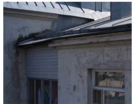
Венчающие карнизы. Дворовый С-В фасад
