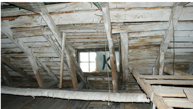
34. «Жилой дом», Ленинградская область, Выборгский район, г. Выборг, ул. Сторожевой башни, д. 12. Чердак. Фрагмент. Фото 30.11.2021г.
