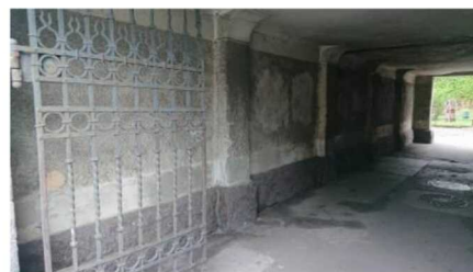
С-З стена сквозного арочного проезда
