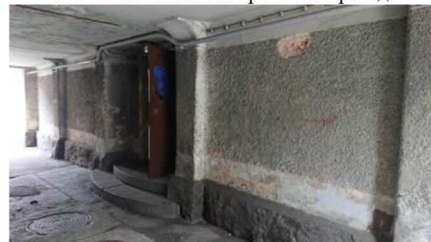
Ю-В стена сквозного арочного проезда
