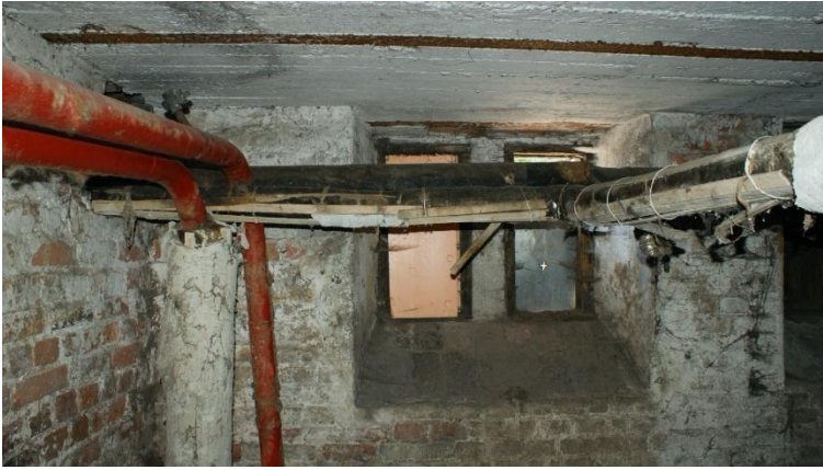
26. «Жилой дом», Ленинградская область, Выборгский район, г. Выборг, ул. Сторожевой башни, д. 12. Подвал. Фрагмент. Фото 30.11.2021г.
