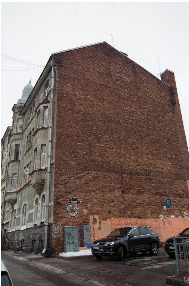
2. «Жилой дом», Ленинградская область, Выборгский район, г. Выборг, ул. Сторожевой башни, д. 12. Юго-восточный фасад. Общий вид. Фото 30.11.2021г.
