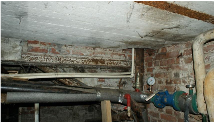
27. «Жилой дом», Ленинградская область, Выборгский район, г. Выборг, ул. Сторожевой башни, д. 12. Подвал. Фрагмент. Фото 30.11.2021г.
