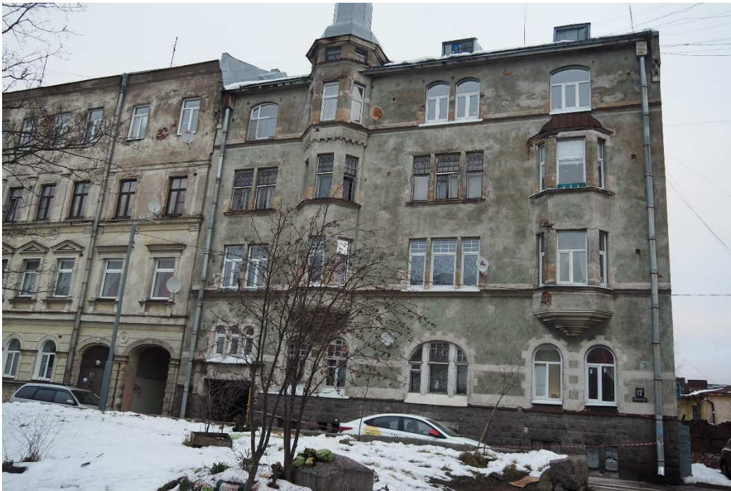
1. «Жилой дом», Ленинградская область, Выборгский район, г. Выборг, ул. Сторожевой башни, д. 12. Юго-западный фасад. Общий вид. Фото 30.11.2021г.
