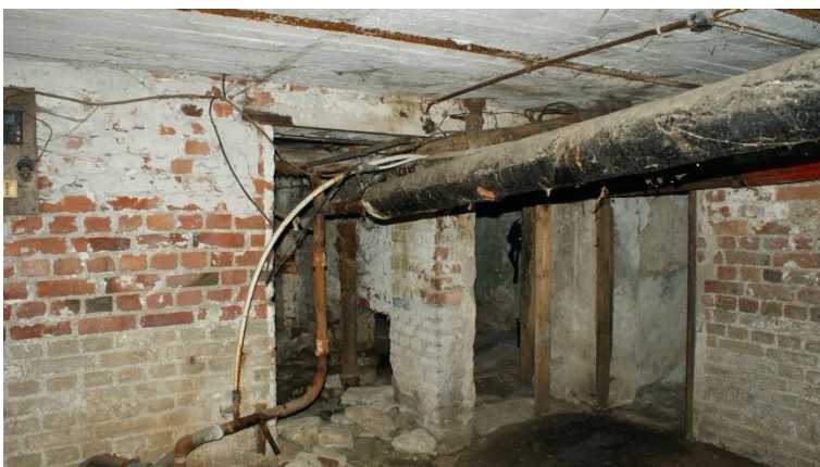
25. «Жилой дом», Ленинградская область, Выборгский район, г. Выборг, ул. Сторожевой башни, д. 12. Подвал. Общий вид. Фото 30.11.2021г.
