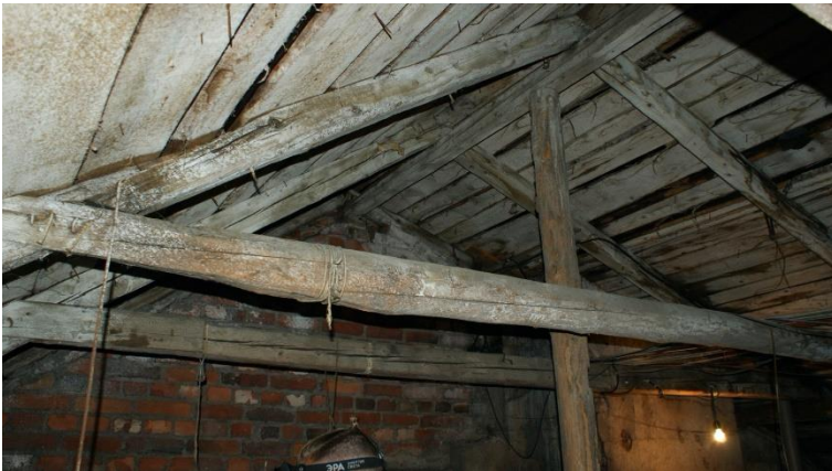
37. «Жилой дом», Ленинградская область, Выборгский район, г. Выборг, ул. Сторожевой башни, д. 12. Чердак. Фрагмент. Фото 30.11.2021г.
