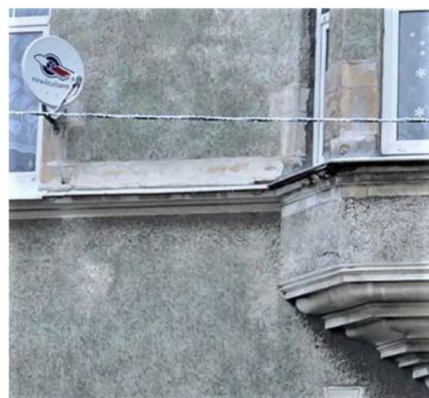
Межэтажный карниз (между 1-ым и 2-ым этажами). Лицевой Ю-3 фасад
