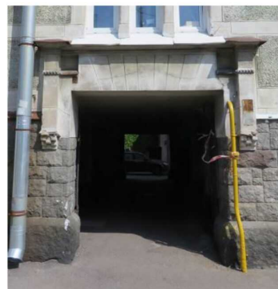
Арочный проем сквозного проезда (лицевой Ю-З фасад)
