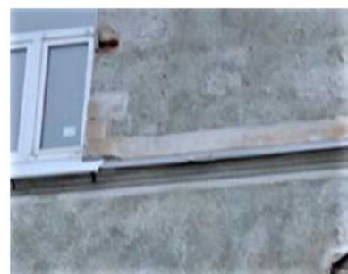
Межэтажный карниз (м/у 3-им и 4-ым этажами). Ю-3 фасад
