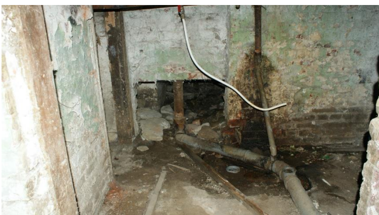
19. «Жилой дом», Ленинградская область, Выборгский район, г. Выборг, ул. Сторожевой башни, д. 12. Подвал. Общий вид. Фото 30.11.2021г.
