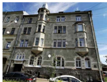
Лицевой Ю-З фасад
