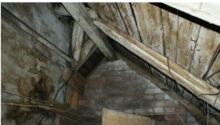
31. «Жилой дом», Ленинградская область, Выборгский район, г. Выборг, ул. Сторожевой башни, д. 12. Чердак. Фрагмент. Фото 30.11.2021г.
