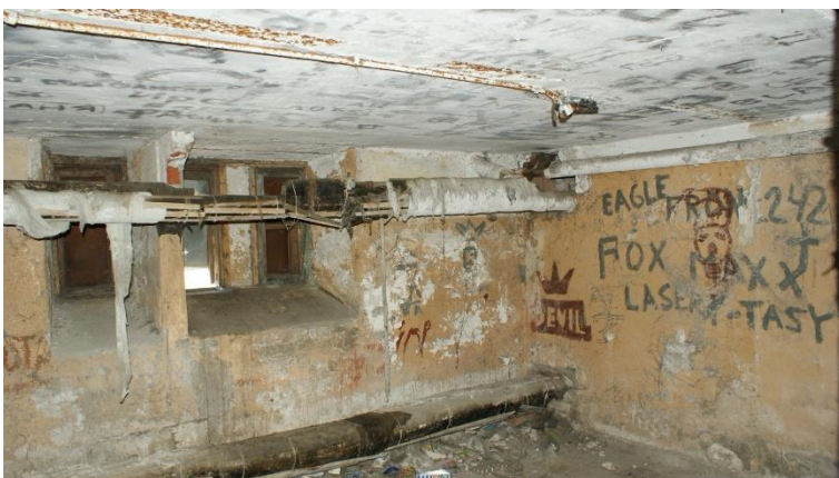
23. «Жилой дом», Ленинградская область, Выборгский район, г. Выборг, ул. Сторожевой башни, д. 12. Подвал. Общий вид. Фото 30.11.2021г.
