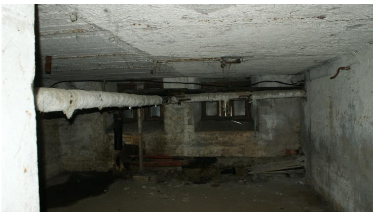
22. «Жилой дом», Ленинградская область, Выборгский район, г. Выборг, ул. Сторожевой башни, д. 12. Подвал. Общий вид. Фото 30.11.2021г.
