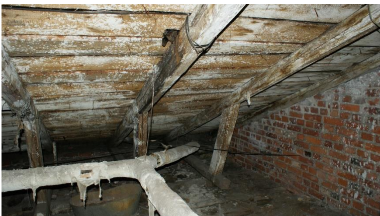
32. «Жилой дом», Ленинградская область, Выборгский район, г. Выборг, ул. Сторожевой башни, д. 12. Чердак. Фрагмент. Фото 30.11.2021г.
