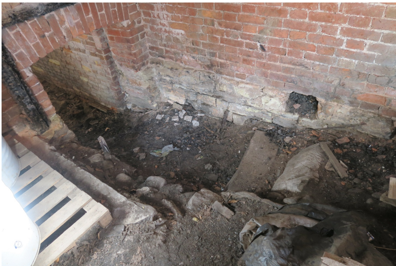
30. Интерьер хозяйственной пристройки. Вид с запада на лестницу и дверной проем из хозяйственной пристройки в подвал. Фото Н.М.Петуховой. 04.03.2022 г.
