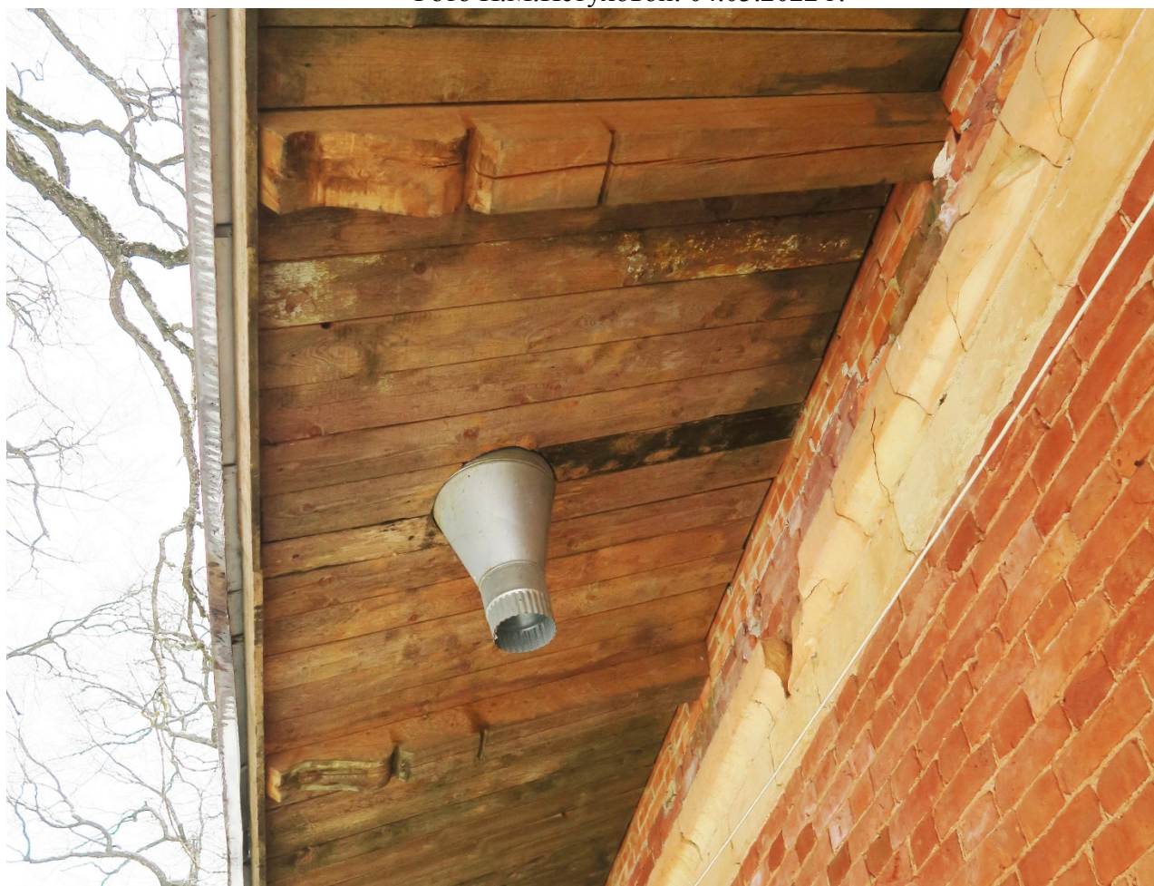
18. Карнизный свес с профилированными кобылками на боковом (северо-западном) фасаде. Фото Н.М.Петуховой. 04.03.2022 г.
