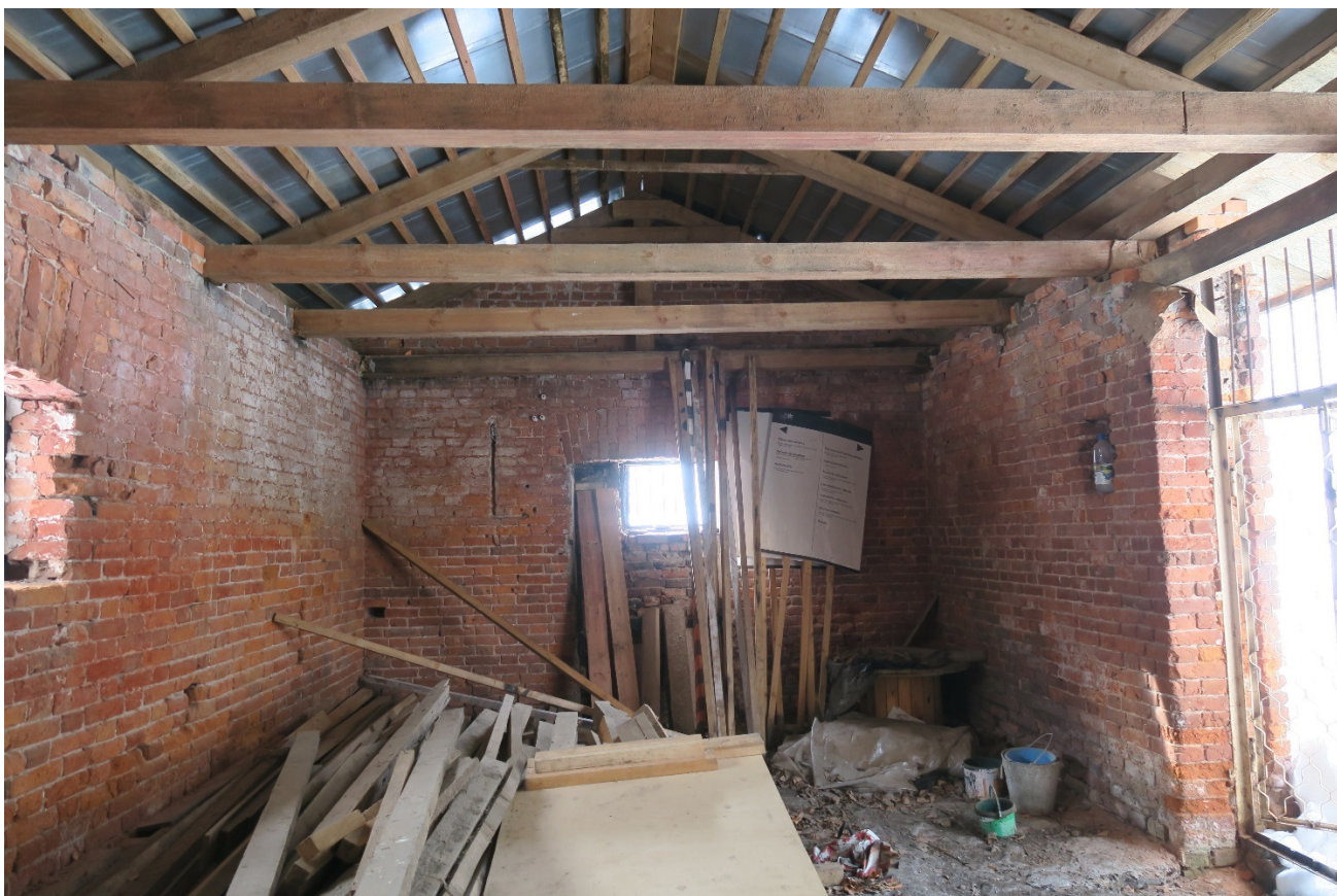
27. Интерьер хозяйственной пристройки. Вид с северо-востока на юго-западную стену. Фото Н.М.Петуховой. 04.03.2022 г.
