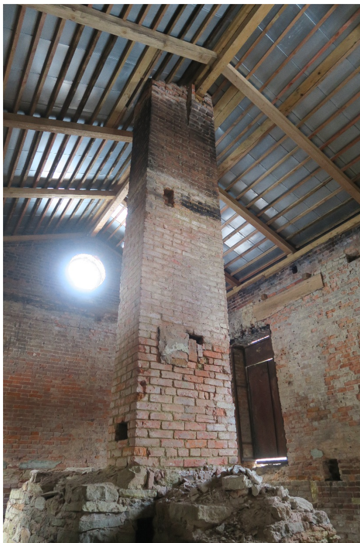
25. Интерьер основного объема. Вид с востока. Печная труба и конструкции крыши. Фото Н.М.Петуховой. 04.03.2022 г.
