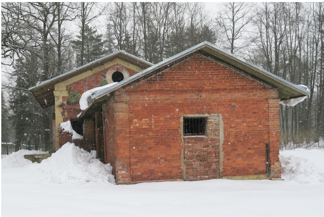
11. Вид здания караулки с юго-запада. Фото Н.М.Петуховой. 04.03.2022 г.
