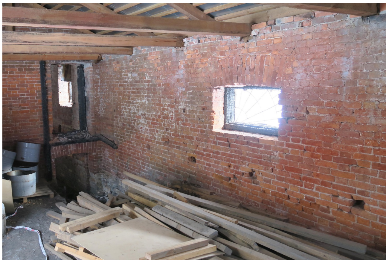
28. Интерьер хозяйственной пристройки. Вид с запада на юго-восточную стену. Фото Н.М.Петуховой. 04.03.2022 г.
