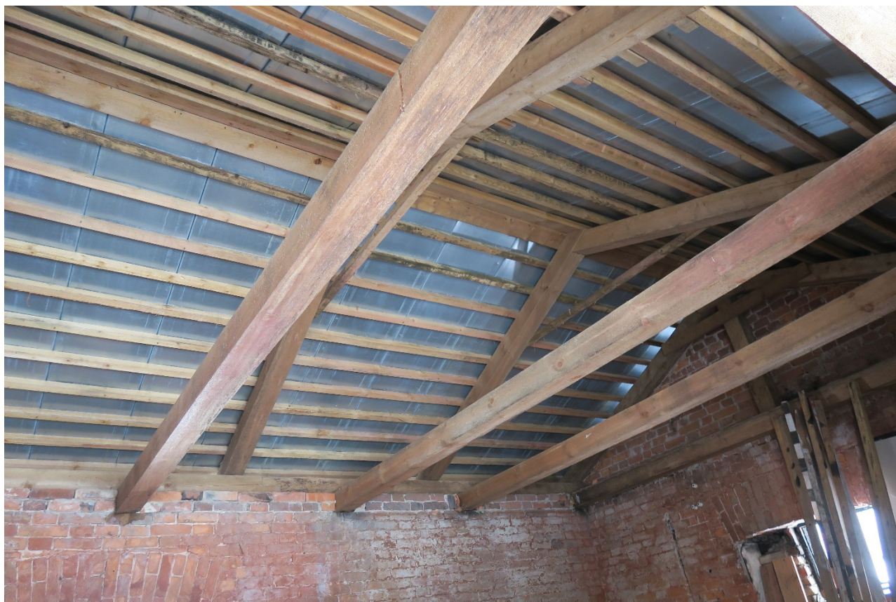
31. Интерьер хозяйственной пристройки. Кровля. Вид с севера. Фото Н.М.Петуховой. 04.03.2022 г.
