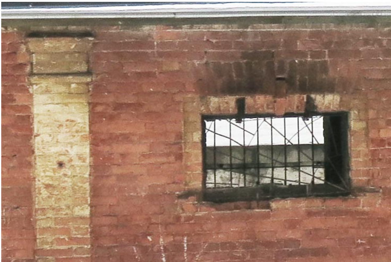
17. Пилястра и оконный проем на боковом (юго-восточном) фасаде хозяйственной пристройки. Фото Н.М.Петуховой. 04.03.2022 г.
