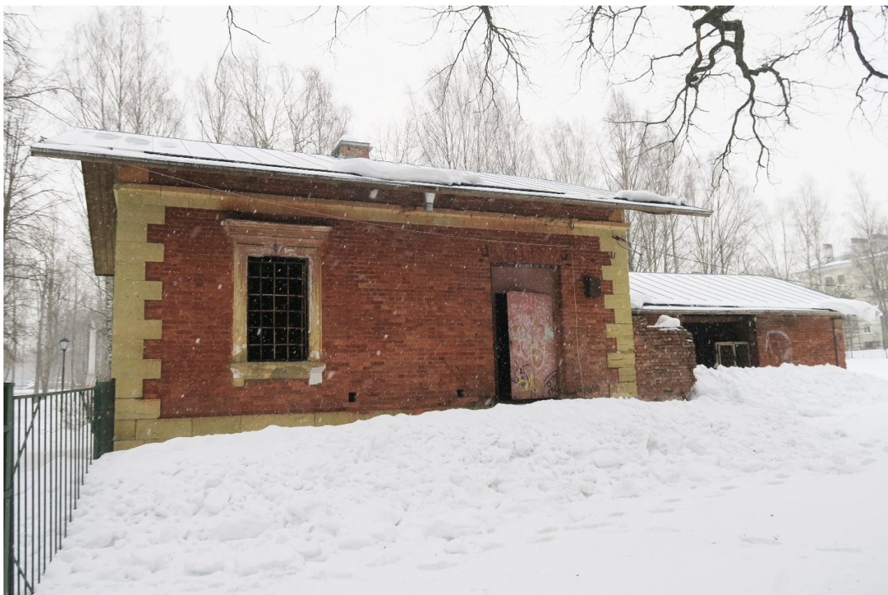
9. Вид здания караулки с северо-запада. Фото Н.М.Петуховой. 04.03.2022 г.
