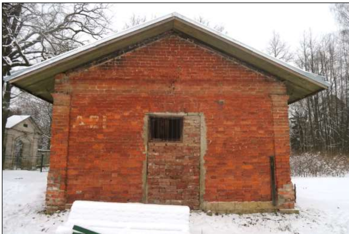
4. Задний (юго-западный) фасад хозяйственной пристройки.
