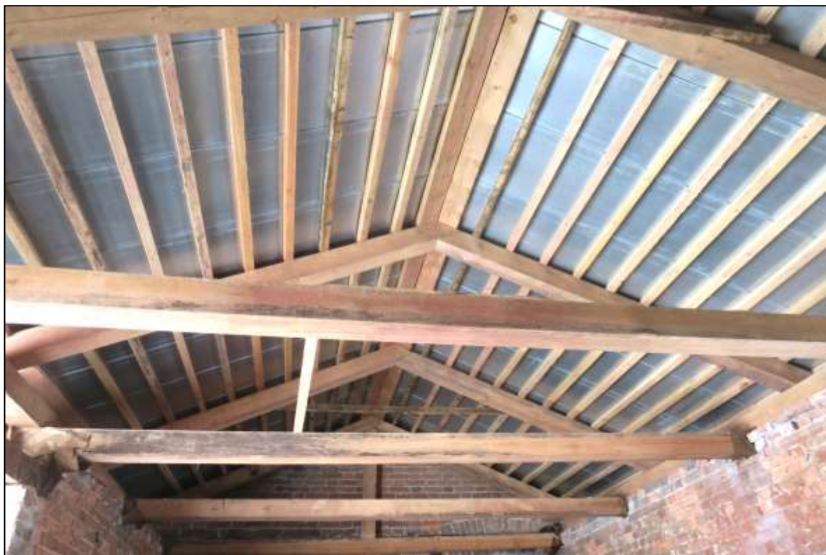
15. Интерьер хозяйственной пристройки. Воссозданные конструкции крыши.
