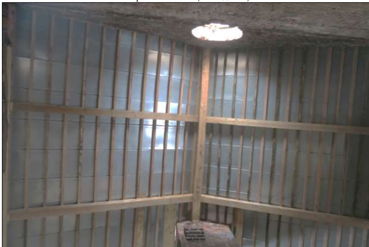
12. Конструкции воссозданной крыши основного объема.
