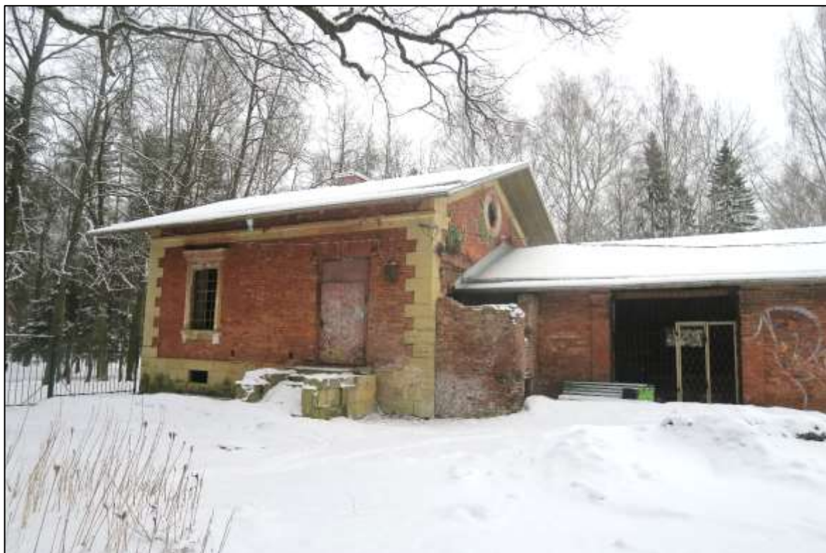
3. Вид здания с севера.
