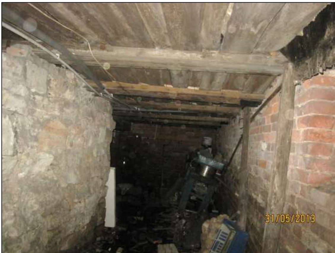
32. Караулка у Черных ворот. Перекрытие над подвалом. Слева-фундамент печи.
