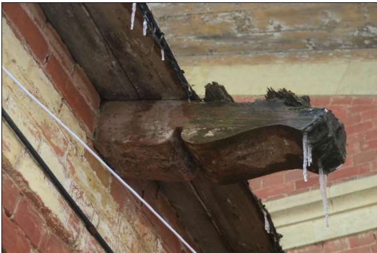
20. Караулка у Березовых ворот. Хозяйственная пристройка. Сохранившаяся резная кобылка свеса кровли на боковом фасаде.
