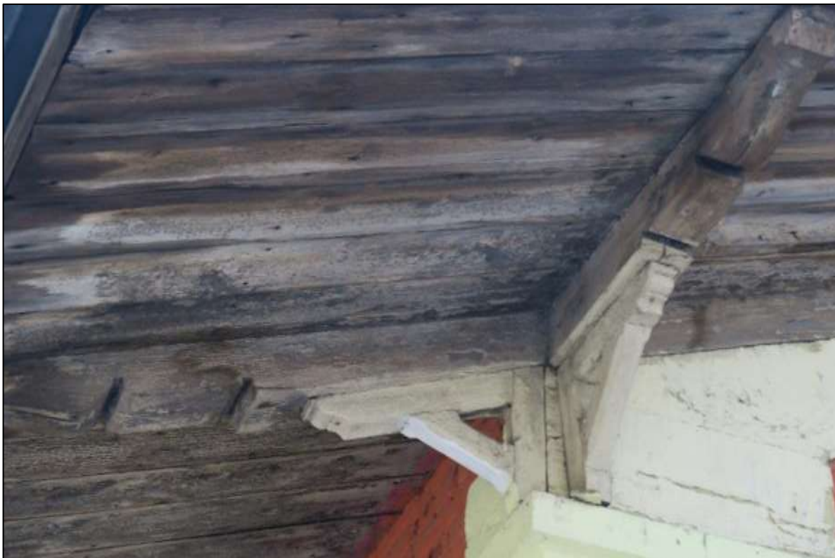
16. Караулка на ул.Хохлова, д.1. Угловая часть кровельного свеса. Декоративное оформление – резные кобылки, кронштейны.
