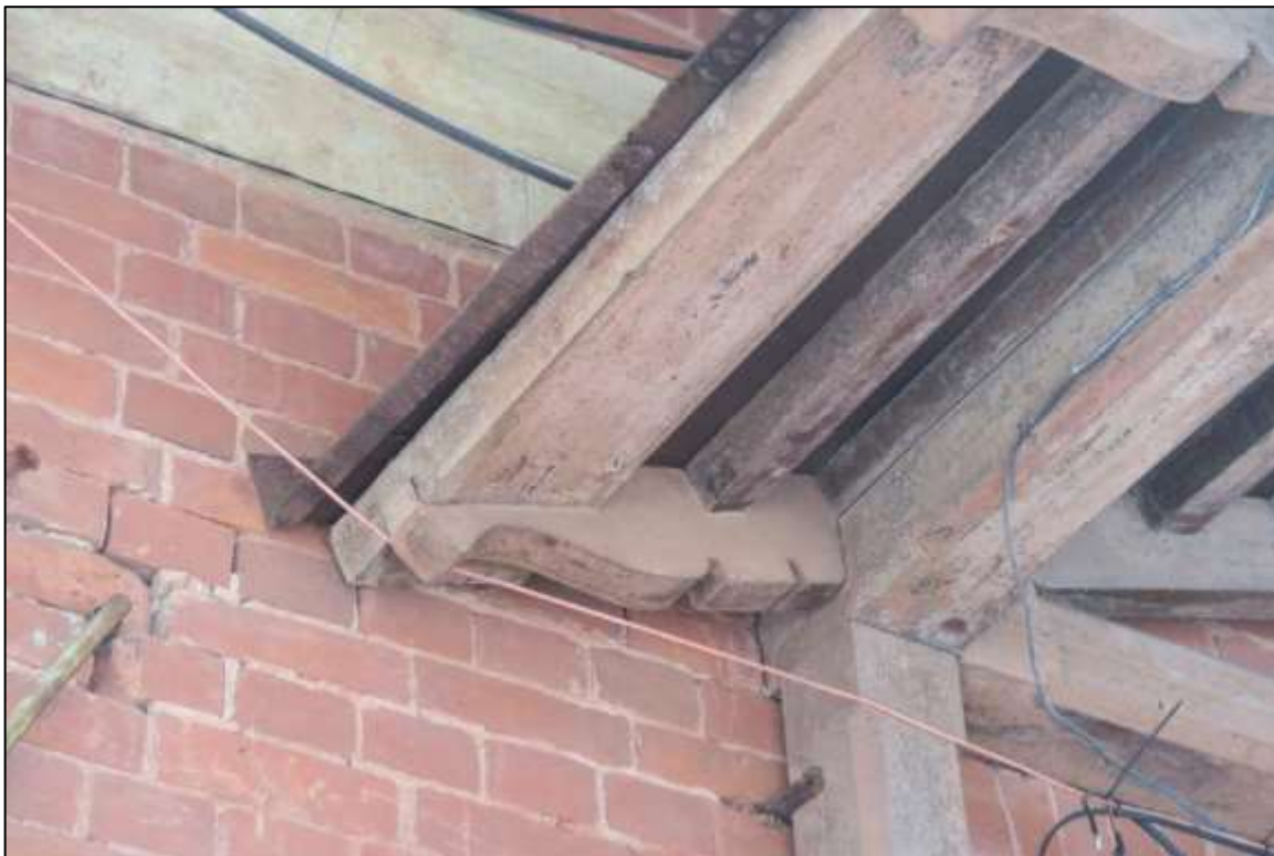
9. Караулка у Березовых ворот. Свес кровли навеса над крыльцом. Обработка кобылок и брусьев каркаса. Сохранились остатки красочного слоя.
