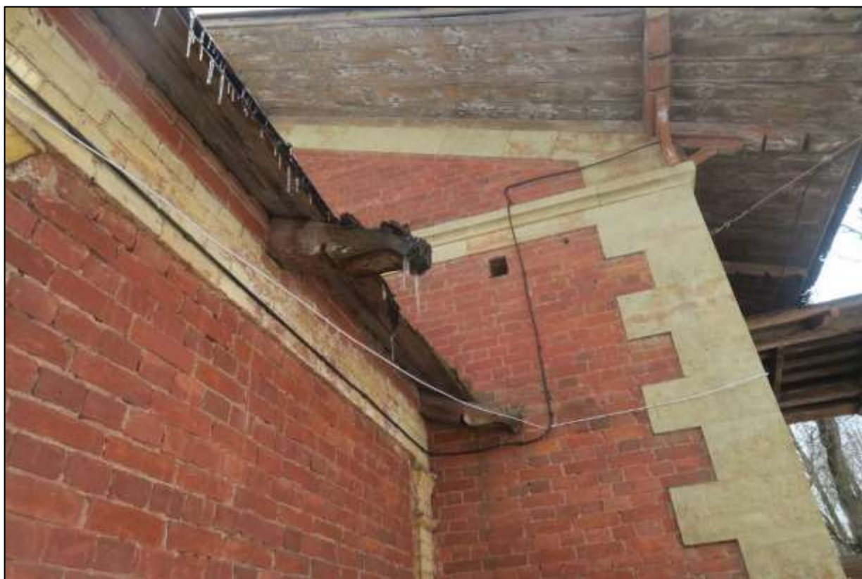
19. Караулка у Березовых ворот. Примыкание хозяйственной пристройки к основному объему. Сохранились кобылки кровли пристройки. Видно цветовое решение обеих частей здания.
