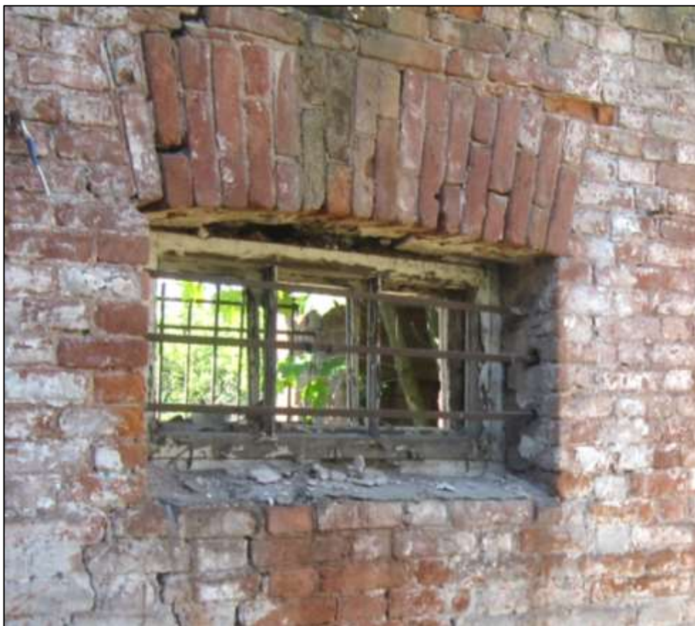
30. Караулка у Черных ворот. Оконный проем и сохранившееся заполнение. Вид из интерьера.
