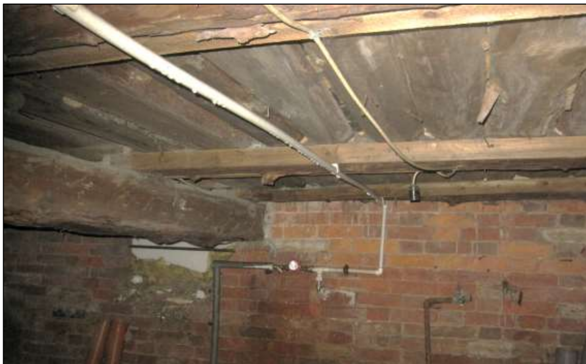
31. Караулка у Черных ворот. Подвал. Видны балки перекрытия над подвалом.
