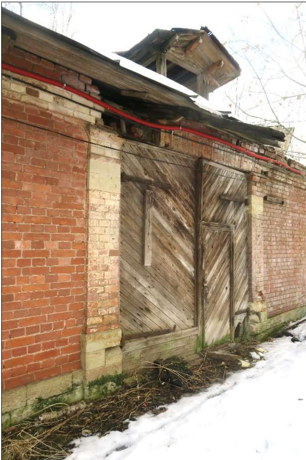
23. Караулка у Березовых ворот. Хозяйственная пристройка. Сохранились ворота и слуховое окно. В кладку пилястр включены известняковые блоки.
