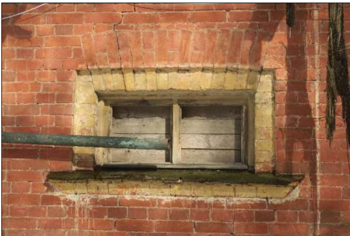
21. Караулка у Березовых ворот. Хозяйственная пристройка. Оконный проем на боковом фасаде. Характер покраски. Столярное заполнение – ремонтное.
