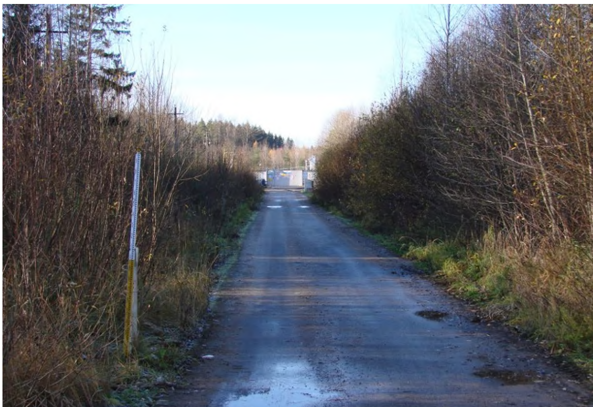
Рис. 178. Г. Санкт-Петербург, Выборгский район. ТФ 18. Общий вид с востока на ГРС «Конная Лахта». Для масштаба использована рейка длиной 2 м.
