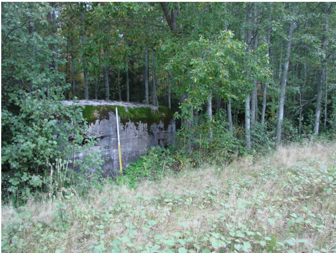
Рис. 118. Г. Санкт-Петербург, Курортный район. ДОТ № 54 Карельского укрепрайона. Вид с северо-запада. Для масштаба использована рейка длиной 2 м.
