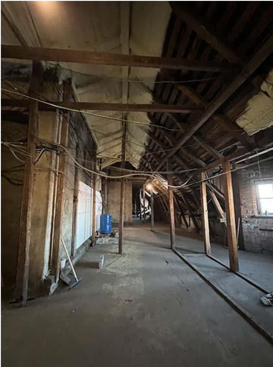
Фото 10. Чердак. Общий вид помещения уличной части. Фото с северо-востока. Дата съемки: 01.02.2022 г. Автор съемки: Куваева Ю.П.
