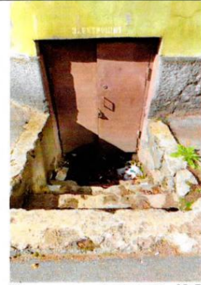
Спуск в подвал (дворовый Ю-В фасад)
