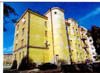
Ю-В дворовый фасад
