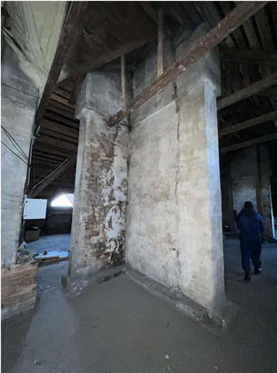
Фото 12. Чердак. Вентиляционные шахты в центральной части помещения. Дата съемки: 01.02.2022 г. Автор съемки: Куваева Ю.П.
