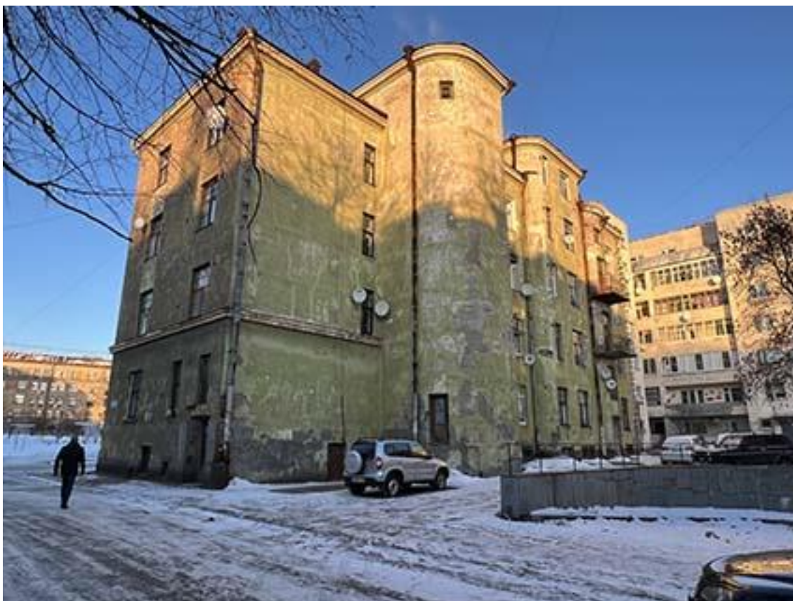
Фото 3. Общий вид здания с юга. Дата съемки: 01.02.2022 г. Автор съемки: Куваева Ю.П.
