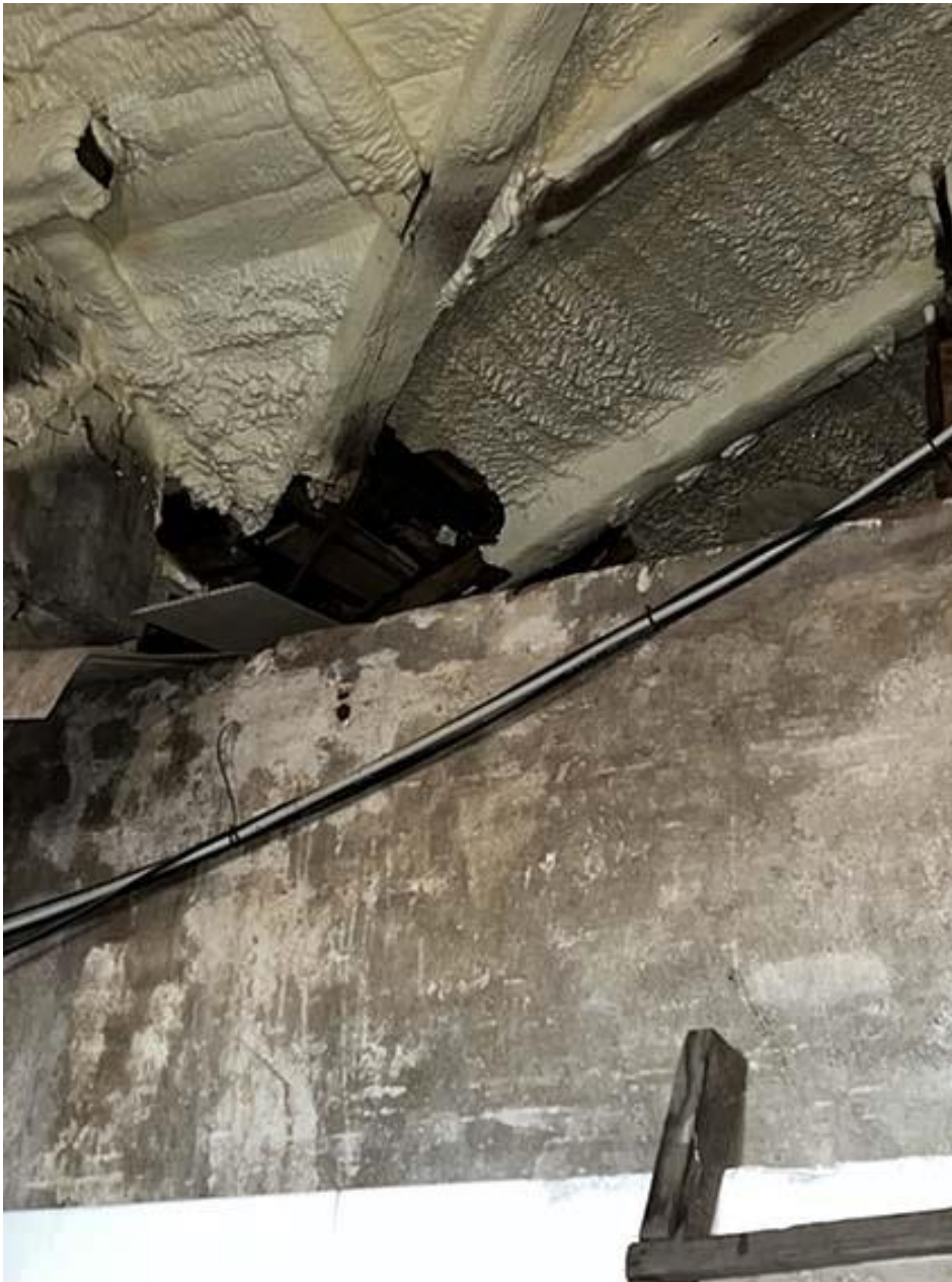
Фото 11. Чердак. Фрагмент покрытия у вентиляционной шахты. Дата съемки: 01.02.2022 г. Автор съемки: Куваева Ю.П.
