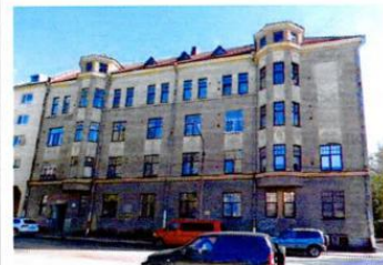
С-З лицевой фасад
