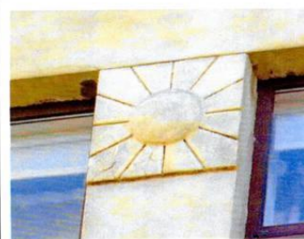
Рельефный орнамент в простенках проемов 4-го этажа (С-З фасад)
