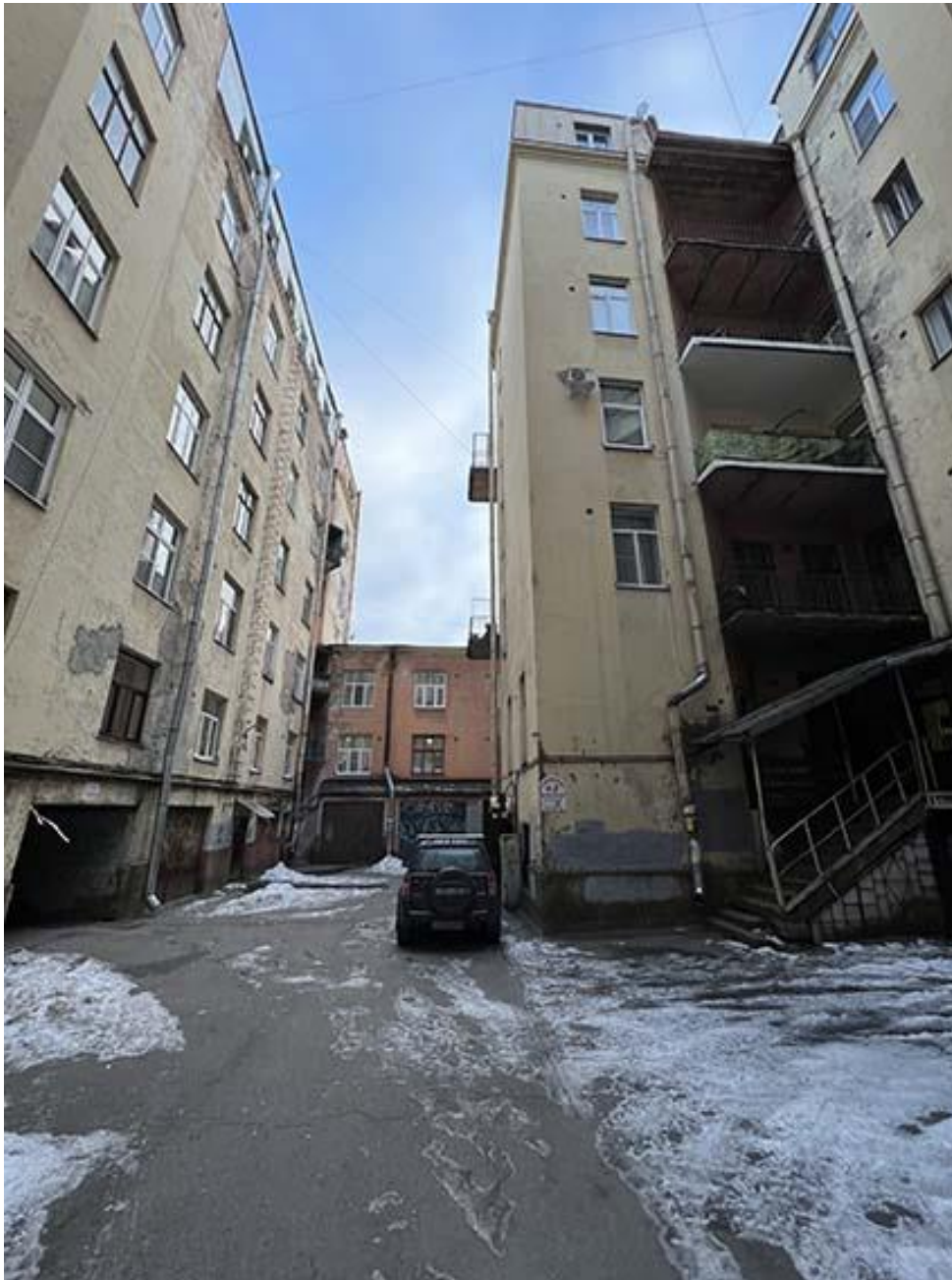
Фото 7. Общий вид дворовых фасадов с северо-запада. Дата съемки: 01.02.2022 г. Автор съемки: Куваева Ю.П.
