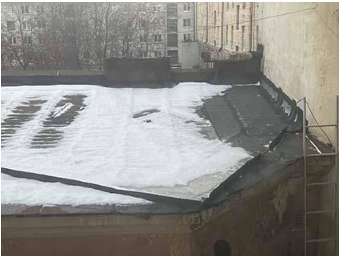
Фото 9. Фрагмент покрытия кровли двухэтажного корпуса здания. Дата съемки: 01.02.2022 г. Автор съемки: Куваева Ю.П.
