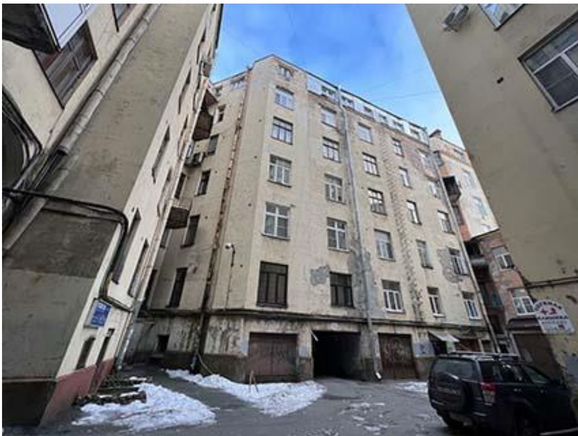
Фото 8. Общий вид дворового юго-восточного фасада дворового корпуса здания. Дата съемки: 01.02.2022 г. Автор съемки: Куваева Ю.П.
