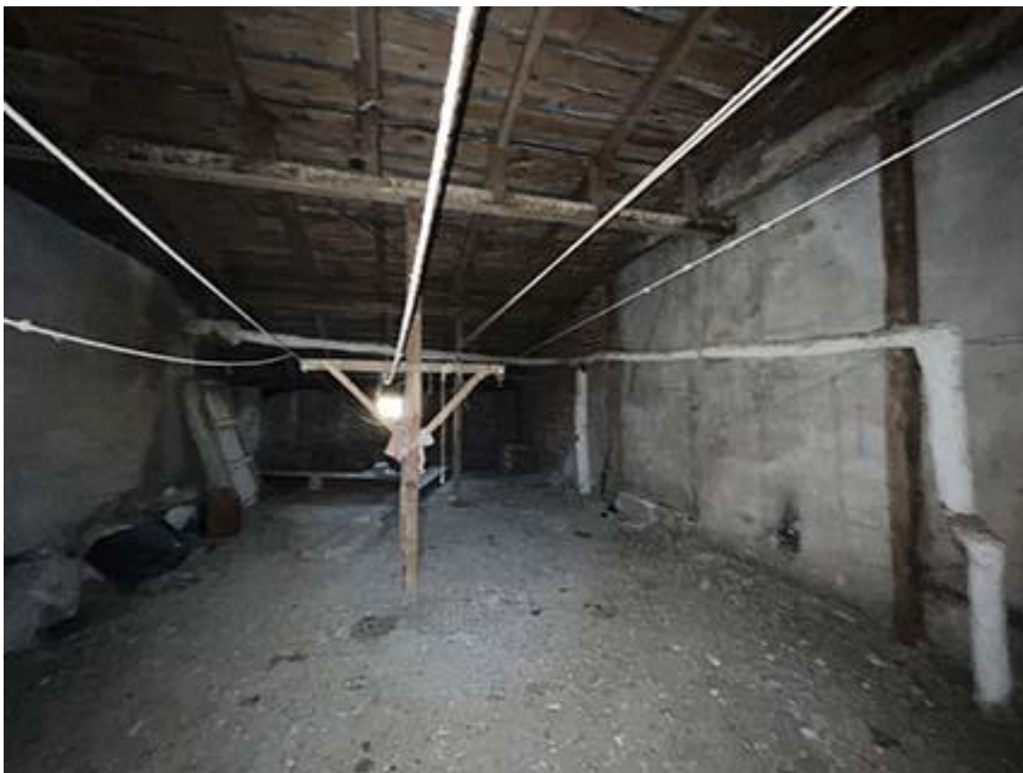
Фото 20. Чердак. Общий вид помещения уличного корпуса здания. Дата съемки: 01.02.2022 г. Автор съемки: Куваева Ю.П.
