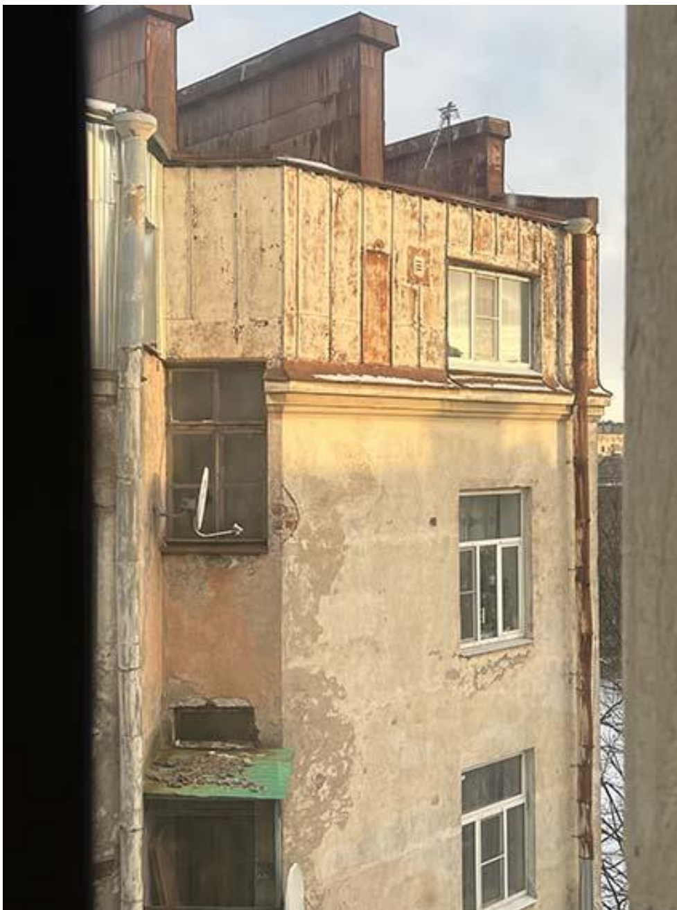
Фото 13. Фрагмент крыши дворового корпуса. Дата съемки: 01.02.2022 г. Автор съемки: Куваева Ю.П.
