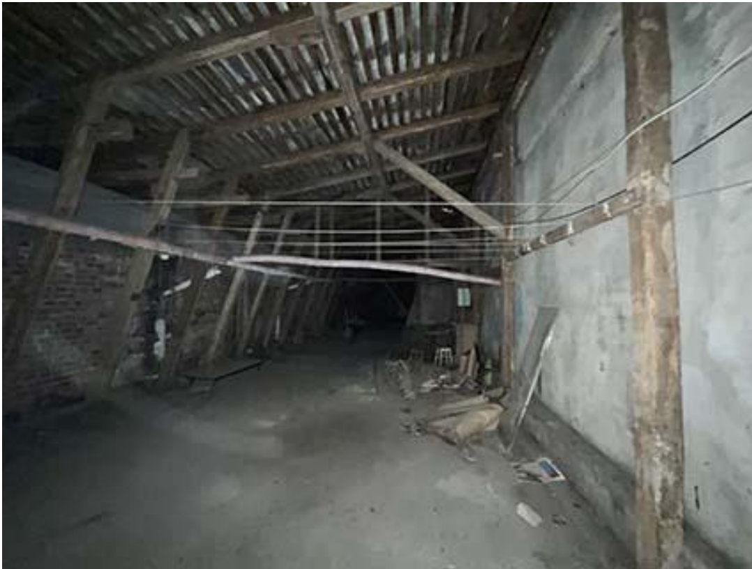
Фото 22. Чердак. Общий вид помещения уличного корпуса здания. Фото с юго-востока. Дата съемки: 01.02.2022 г. Автор съемки: Куваева Ю.П.
