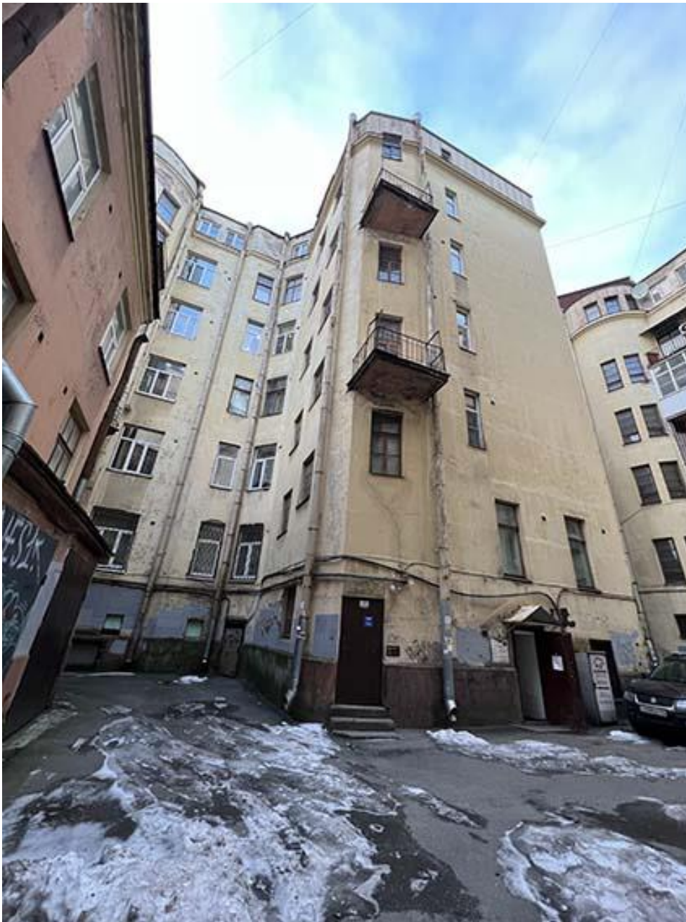
Фото 10. Общий вид дворовых фасадов с северо-востока. Дата съемки: 01.02.2022 г. Автор съемки: Куваева Ю.П.
