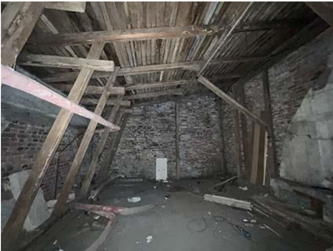
Фото 25. Чердак. Северо-западная часть помещения уличного корпуса здания. Дата съемки: 01.02.2022 г. Автор съемки: Куваева Ю.П.
