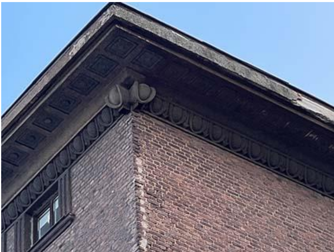
Фото 5. Фрагмент западного угла здания. Дата съемки: 01.02.2022 г. Автор съемки: Куваева Ю.П.
