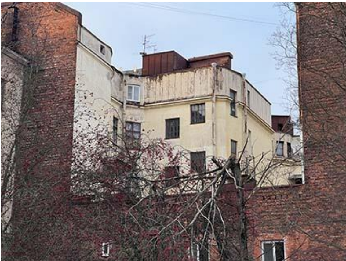
Фото 6. Фрагмент северо-восточных дворовых фасадов. Дата съемки: 01.02.2022 г. Автор съемки: Куваева Ю.П.
