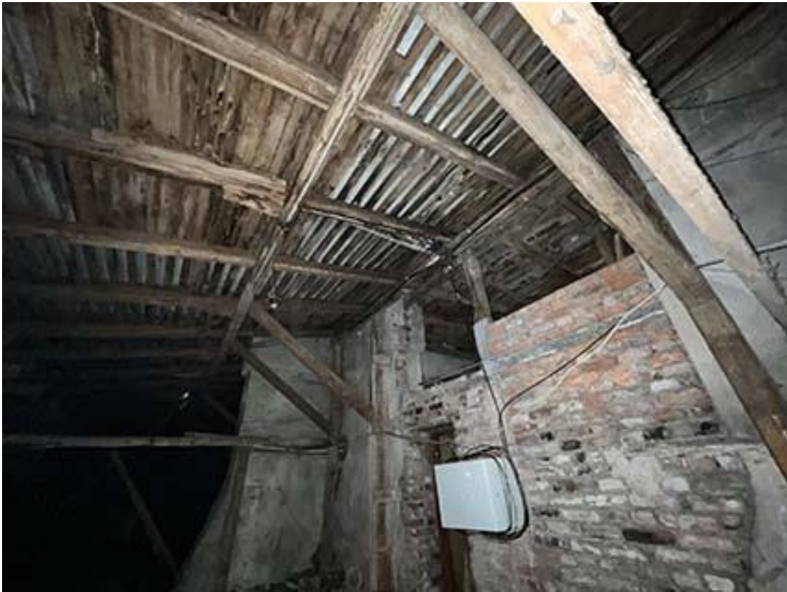
Фото 24. Чердак. Северо-западная часть помещения уличного корпуса здания. Дата съемки: 01.02.2022 г. Автор съемки: Куваева Ю.П.
