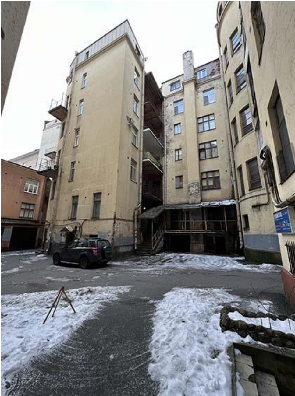
Фото 12. Общий вид дворовых фасадов с северо-востока. Дата съемки: 01.02.2022 г. Автор съемки: Куваева Ю.П.
