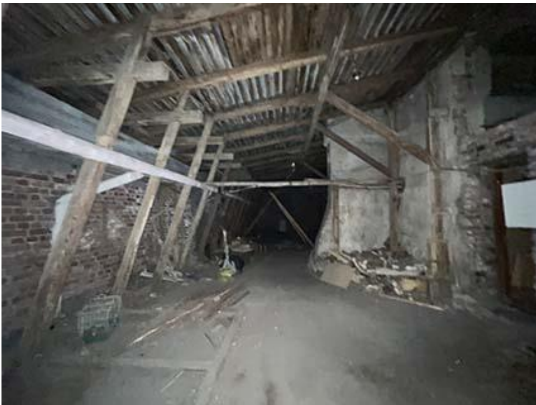
Фото 23. Вид на северо-западную часть помещения уличного корпуса здания. Дата съемки: 01.02.2022 г. Автор съемки: Куваева Ю.П.
