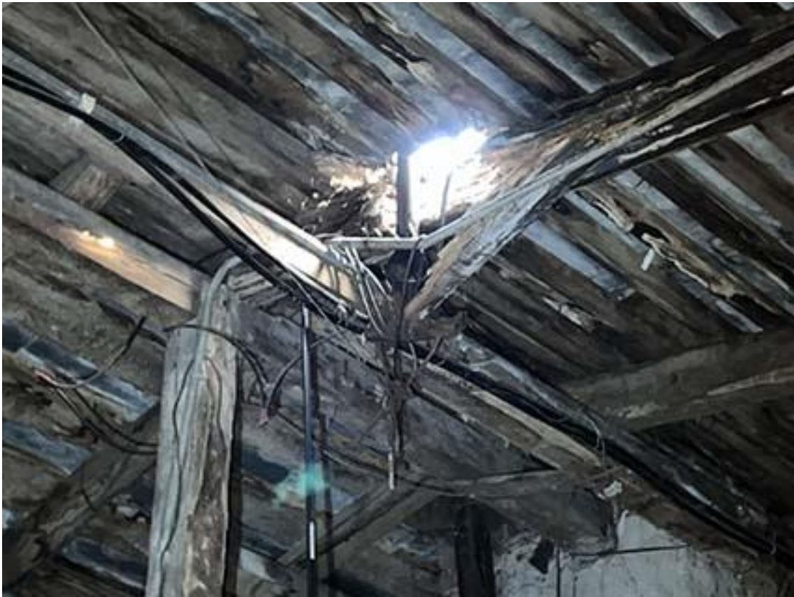
Фото 26. Фрагмент стропильной системы. Дата съемки: 01.02.2022 г. Автор съемки: Куваева Ю.П.
