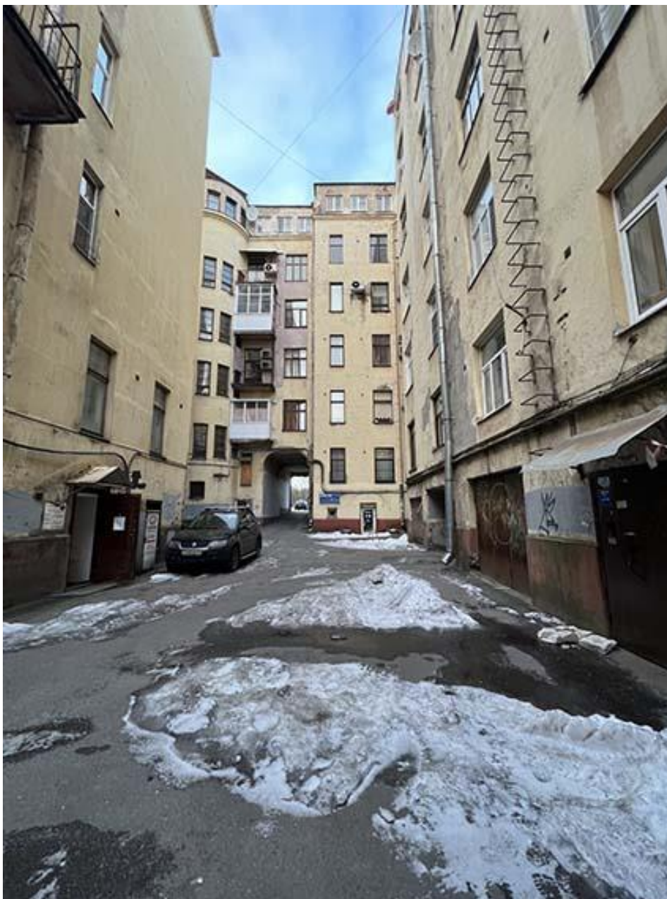
Фото 11. Общий вид юго-восточного дворового фасада уличного корпуса здания. Дата съемки: 01.02.2022 г. Автор съемки: Куваева Ю.П.
