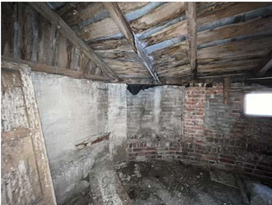
Фото 21. Чердак. Западный угол помещения уличного корпуса здания. Дата съемки: 01.02.2022 г. Автор съемки: Куваева Ю.П.
