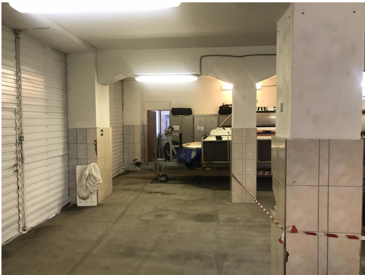
Фото 15. Помещение 1 этажа (в соответствии с планом ПИБ 2017 г. – помещение II, 1)
