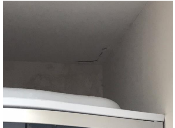
Фото 23, 24. Помещение душевой. Следы протечек на стене. 2 этаж.
