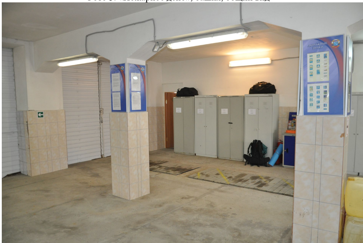
Фото 4. «Пожарное депо», первый этаж, общий вид
