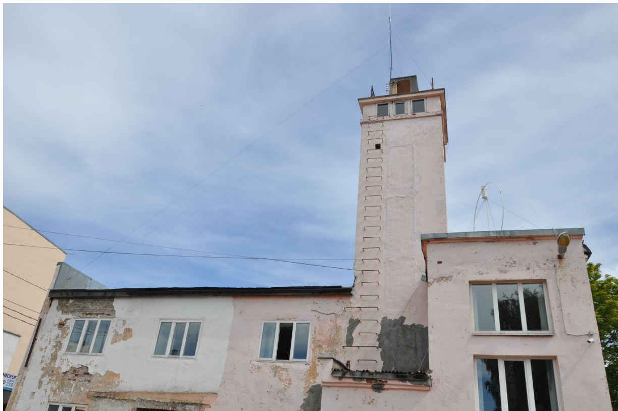
Фото 3. «Пожарное депо», башня, общий вид
