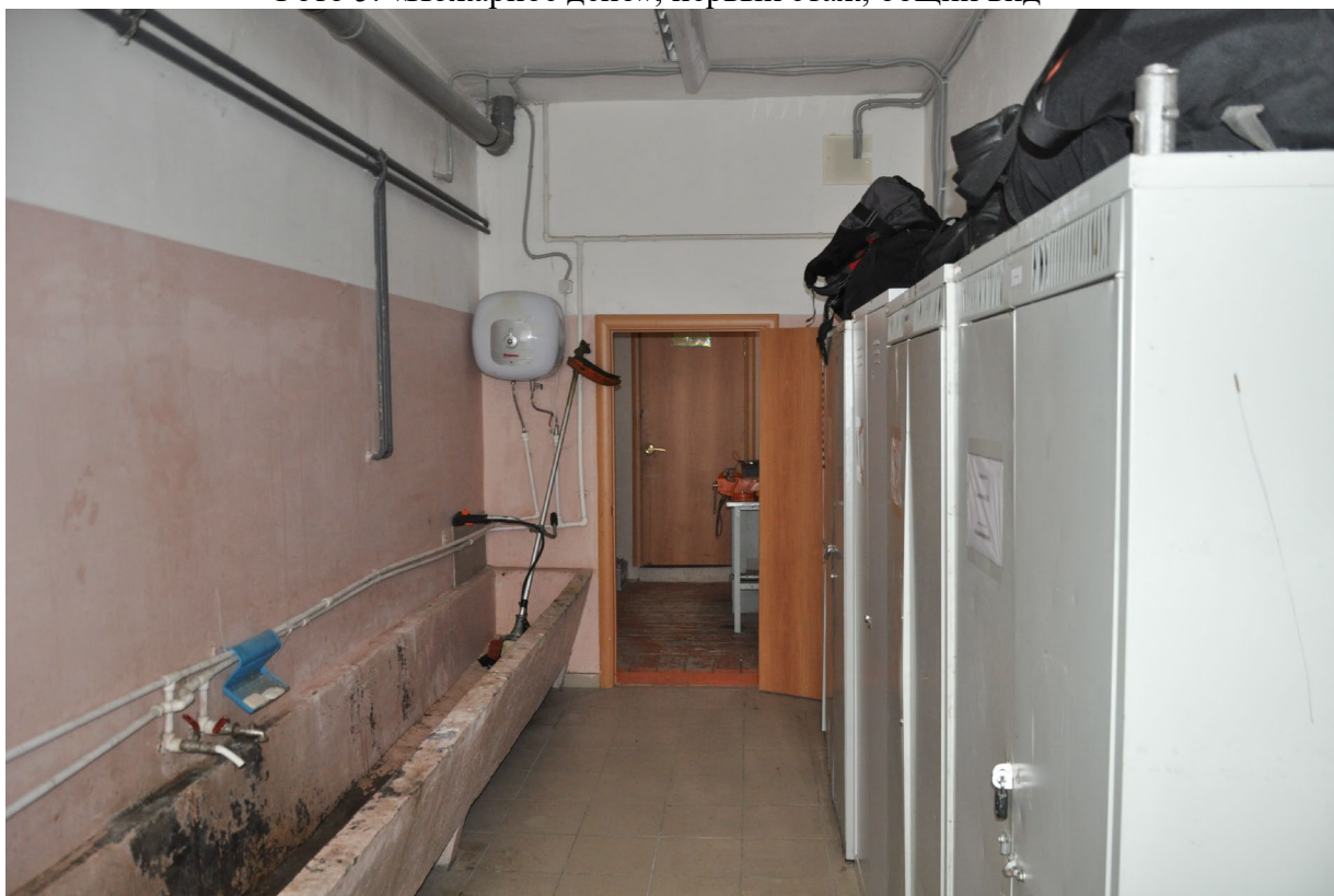
Фото 6. «Пожарное депо», первый этаж, общий вид
