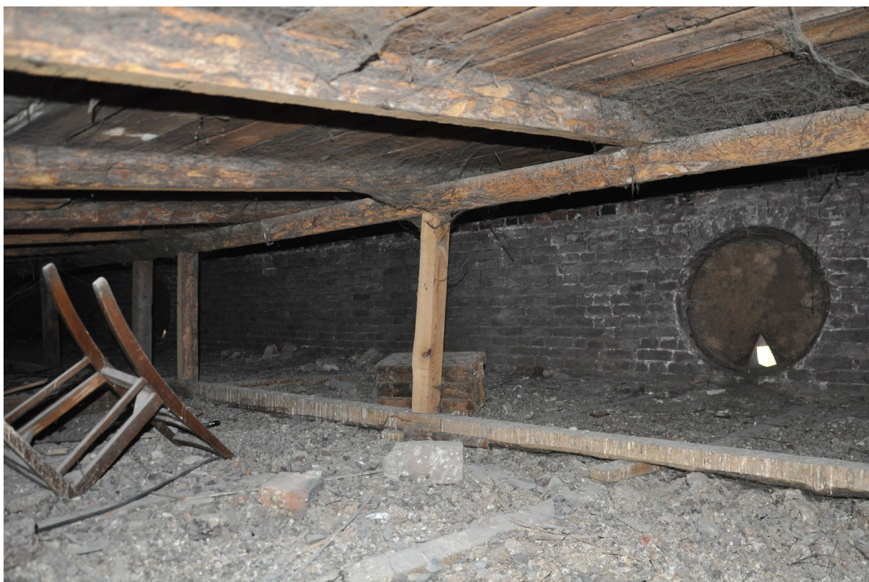
Фото 10. «Пожарное депо», чердачное помещение, общий вид
