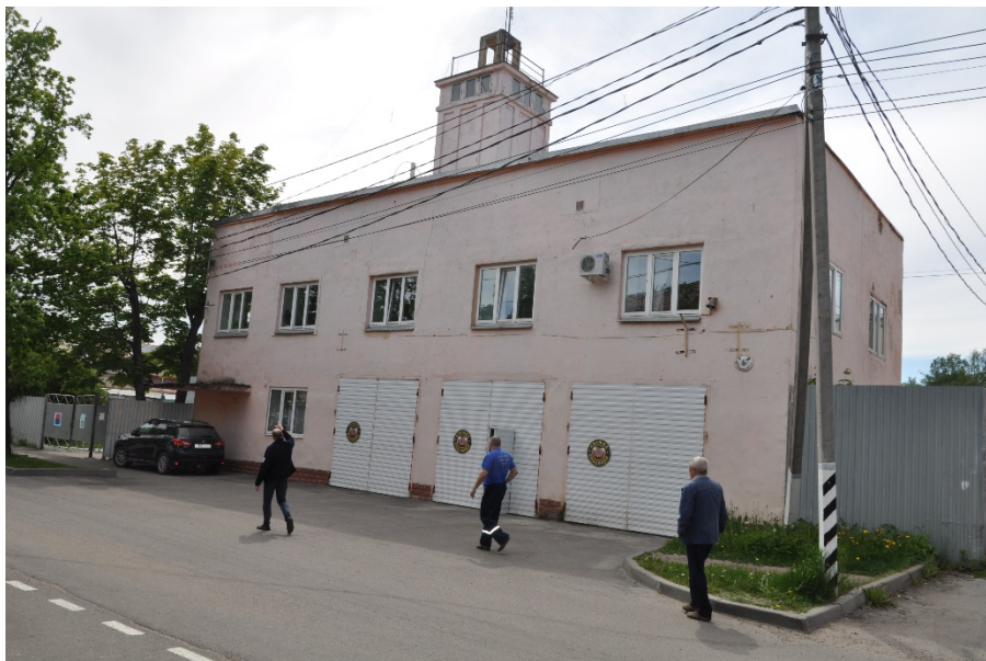
Фото 2.1. Общий вид здания.
