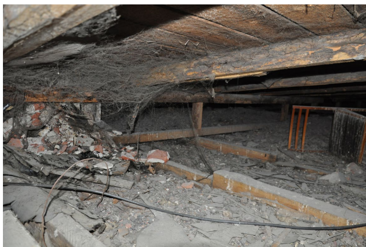
Фото 3.4.1. Чердачное пространство в осях 2-6/А-Е.
