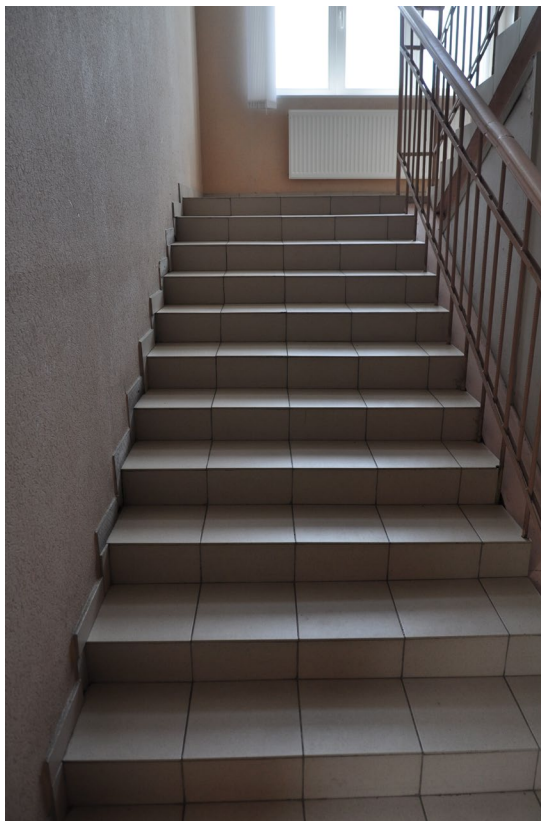
Фото 3.5.1. Общий вид лестницы.
