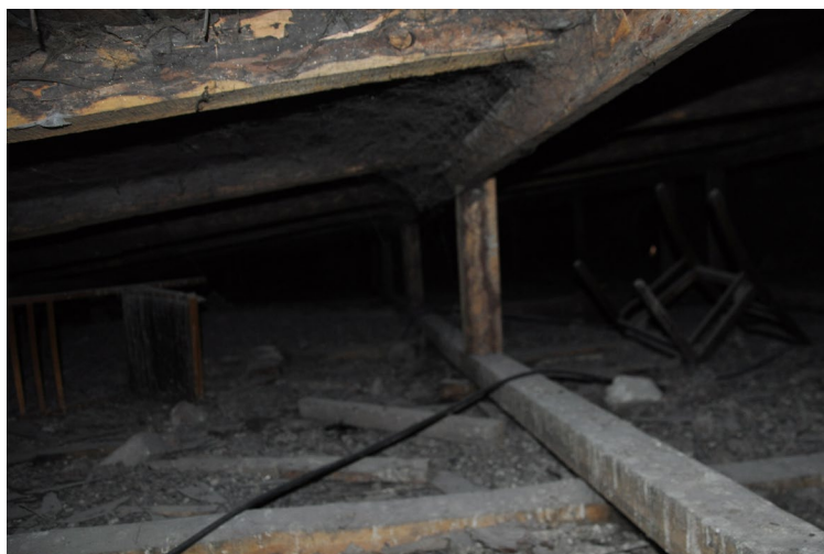
Фото 3.4.2. Стропила, прогоны, стойки и лежни.
