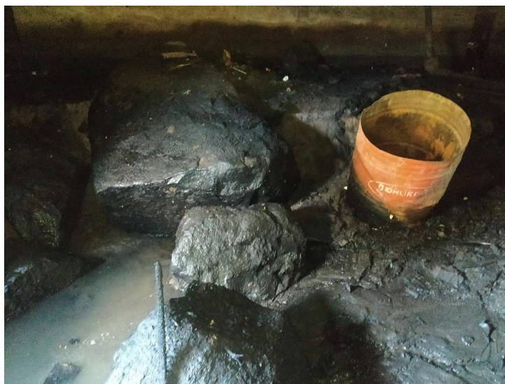
Фото Ф22. Пол подвала.
