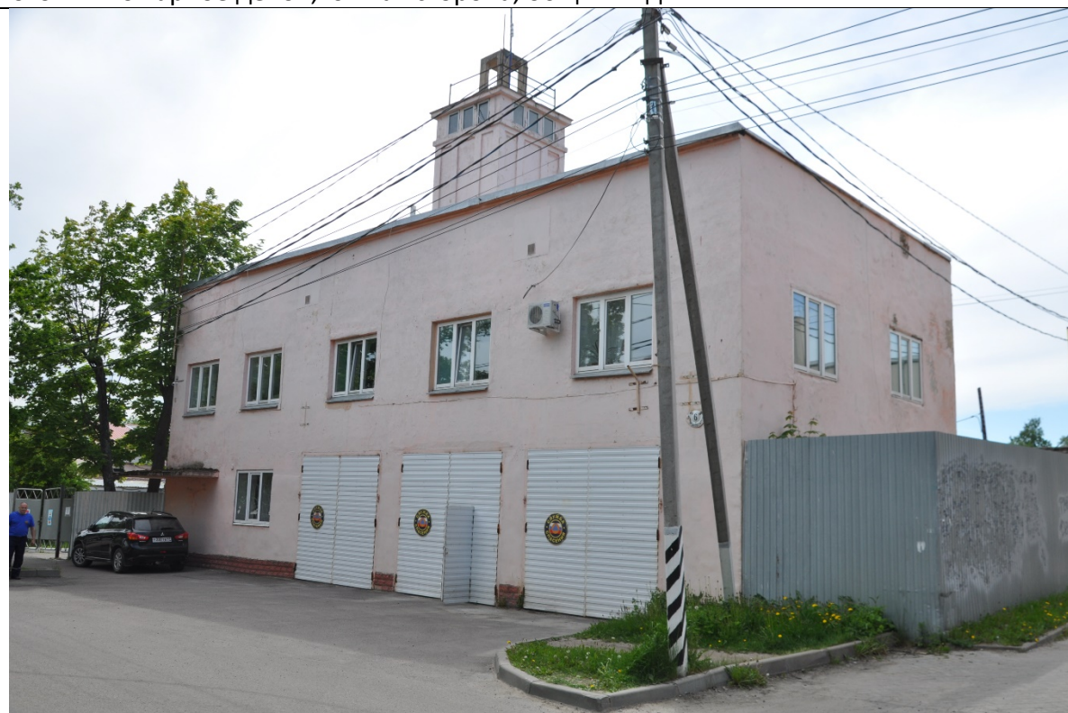
Фото 2. «Пожарное депо», северная сторона, общий вид
