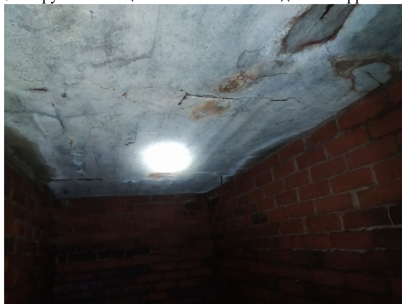
Фото Ф19. Разрушение защитного слоя на плите. Коррозия арматуры.
