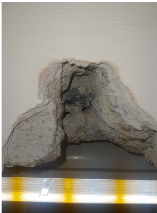
Фото 3.3.7. Рабочая арматура главной балки перекрытия над первым этажом.
