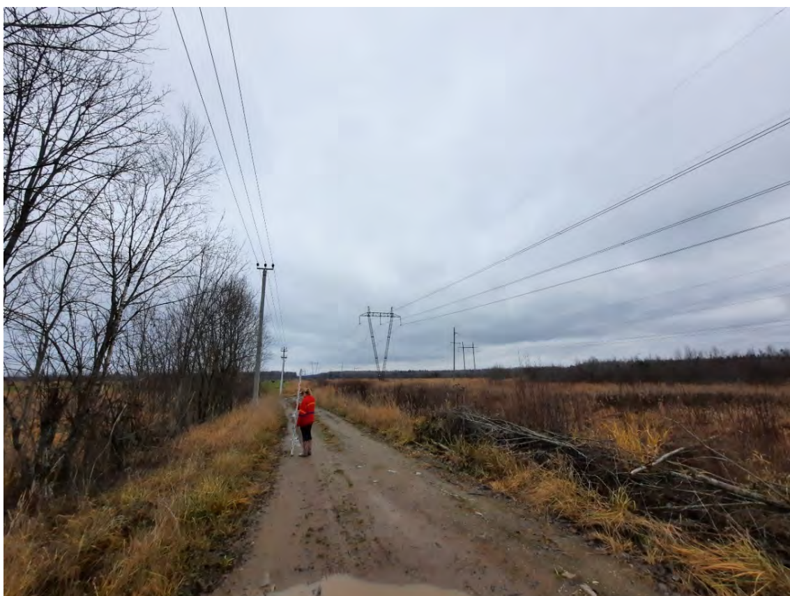
Рис. 26. Ленинградская обл., Киришский р-н, «Подъездная автодорога к существующей площадке УДЗ на км 590,4». Точка фотофиксации 2. Вид с З.
