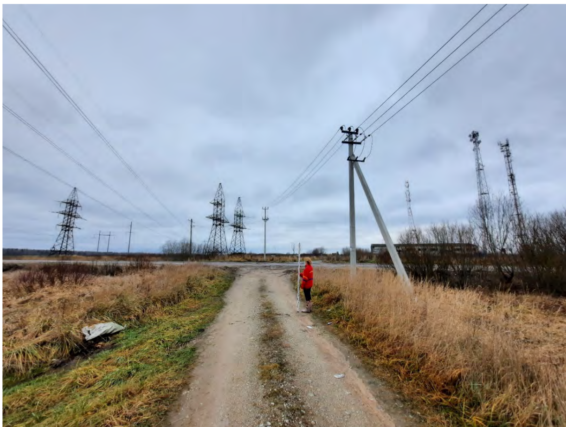
Рис. 7. Ленинградская обл., Киришский р-н, «Подъездная автодорога к существующей площадке УДЗ на км 590,4». Точка фотофиксации 1. Вид с В.
