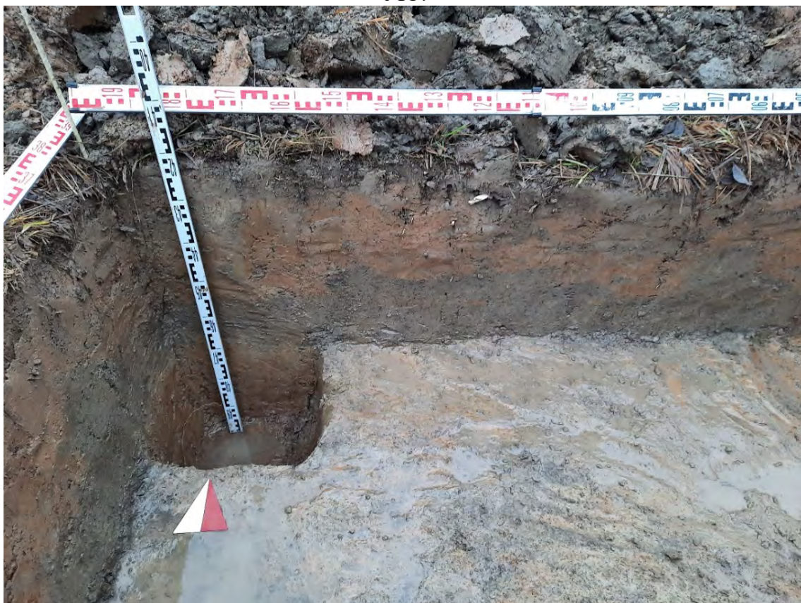
Рис. 12. Ленинградская обл., Киришский р-н, «Подъездная автодорога к существующей площадке УДЗ на км 590,4». Шурф 1. Контрольный прокоп. Вид с Ю.
