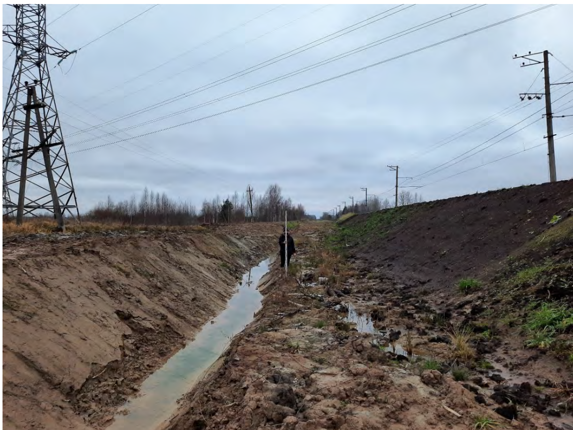
Рис. 75. Ленинградская обл., Киришский р-н, «Подъездная автодорога к существующей площадке УДЗ на км 590,4». Точка фотофиксации 10. Вид с ЮВ.
