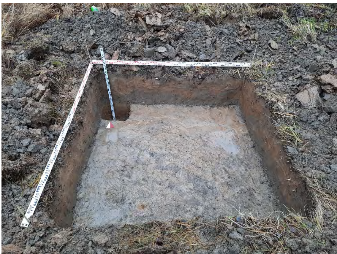
Рис. 10. Ленинградская обл., Киришский р-н, «Подъездная автодорога к существующей площадке УДЗ на км 590,4». Шурф 1. Зачистка по матерiku. Вид с Ю.
