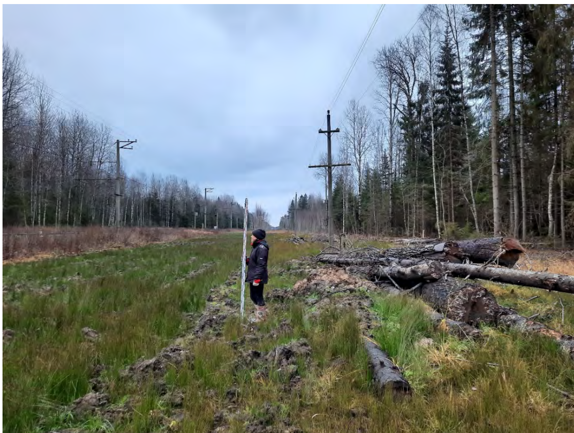
Рис. 51. Ленинградская обл., Киришский р-н, «Подъездная автодорога к существующей площадке УДЗ на км 590,4». Точка фотофиксации 7. Вид с СЗ.
