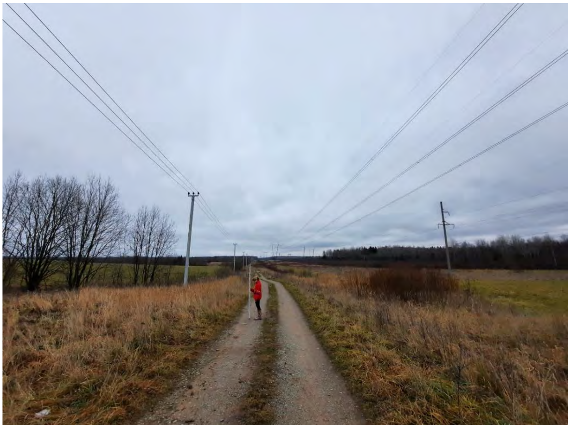
Рис. 6. Ленинградская обл., Киришский р-н, «Подъездная автодорога к существующей площадке УДЗ на км 590,4». Точка фотофиксации 1. Вид с 3.
