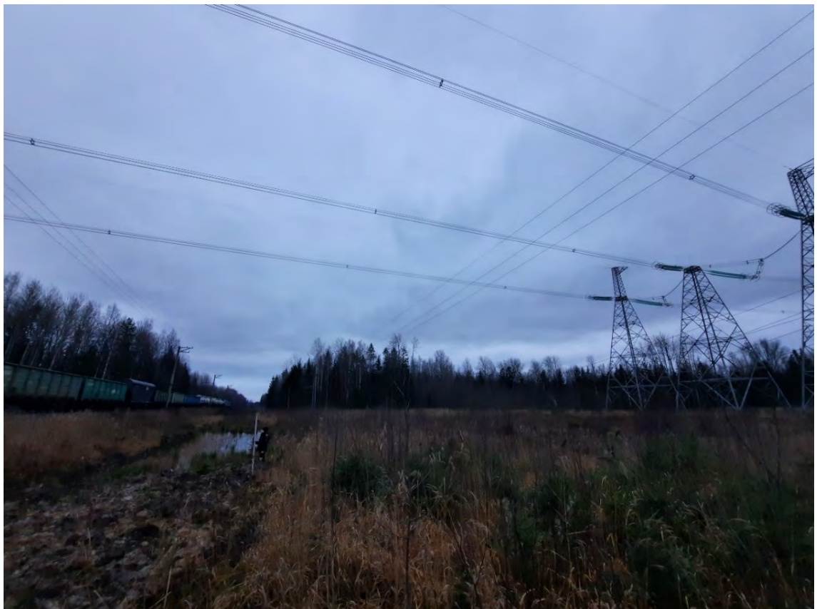
Рис. 65. Ленинградская обл., Киришский р-н, «Подъездная автодорога к существующей площадке УДЗ на км 590,4». Точка фотофиксации 8. Вид с СЗ.
