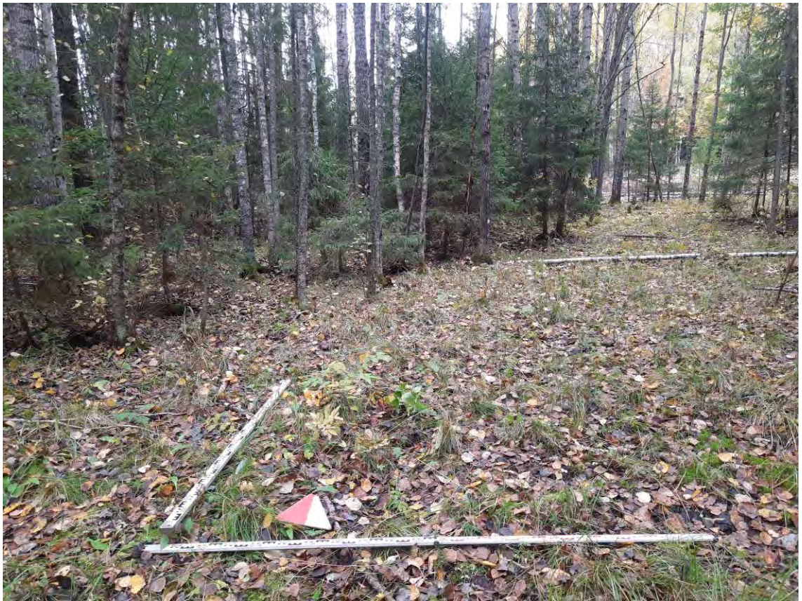
Рис. 55. Ленинградская обл., Киришский р-н, «Подъездная автодорога к существующей площадке УДЗ на км 590,4». Шурф 7. До начала земляных работ. Вид с Ю.
