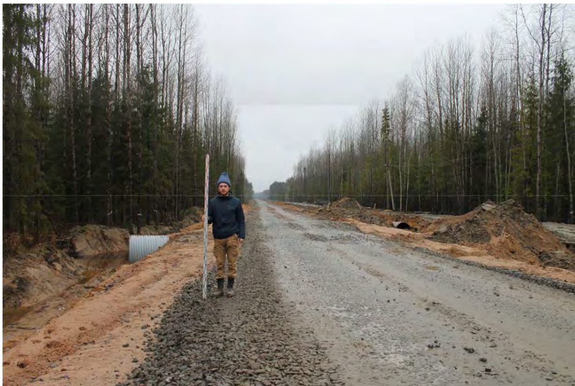
Рис. 154. Точка фотофиксации 6. Вид на юго-запад.
