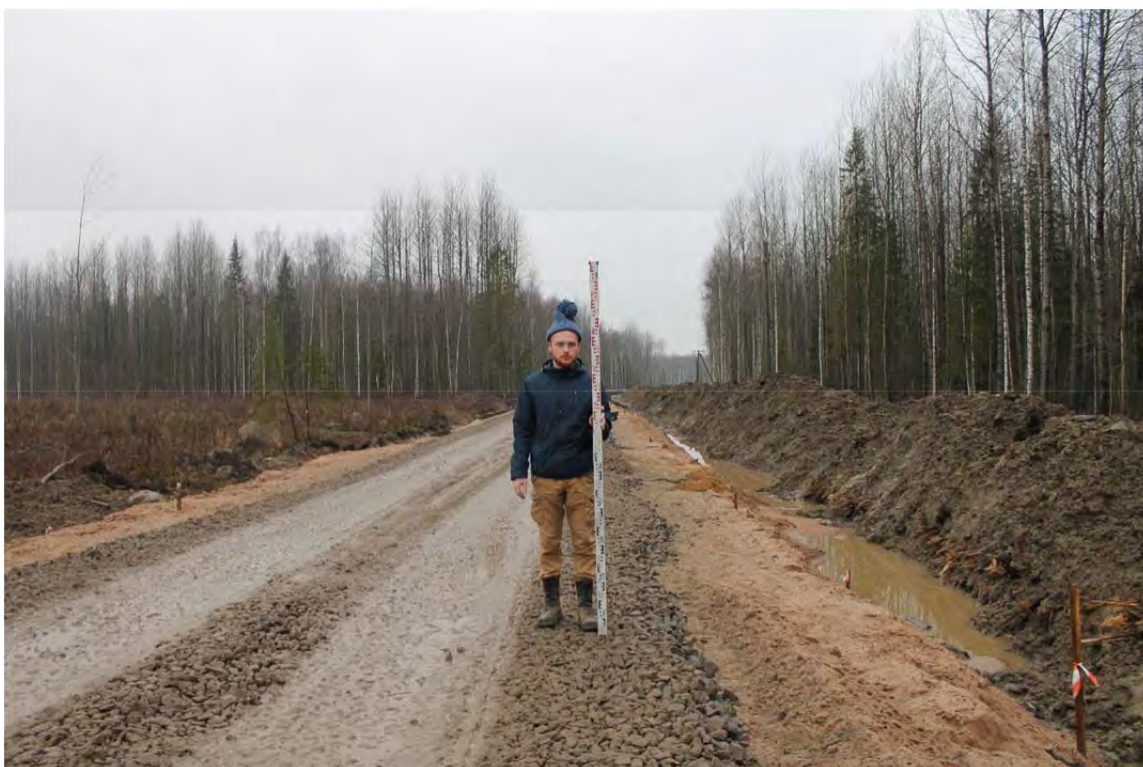
Рис. 248. Точка фотофиксации 15. Вид на юго-запад.
