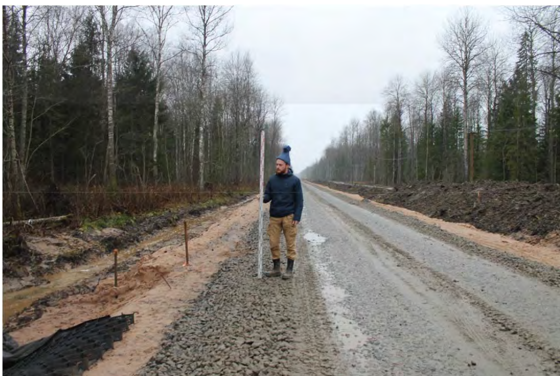
Рис. 238. Точка фотофиксации 10. Вид на юго-запад.
