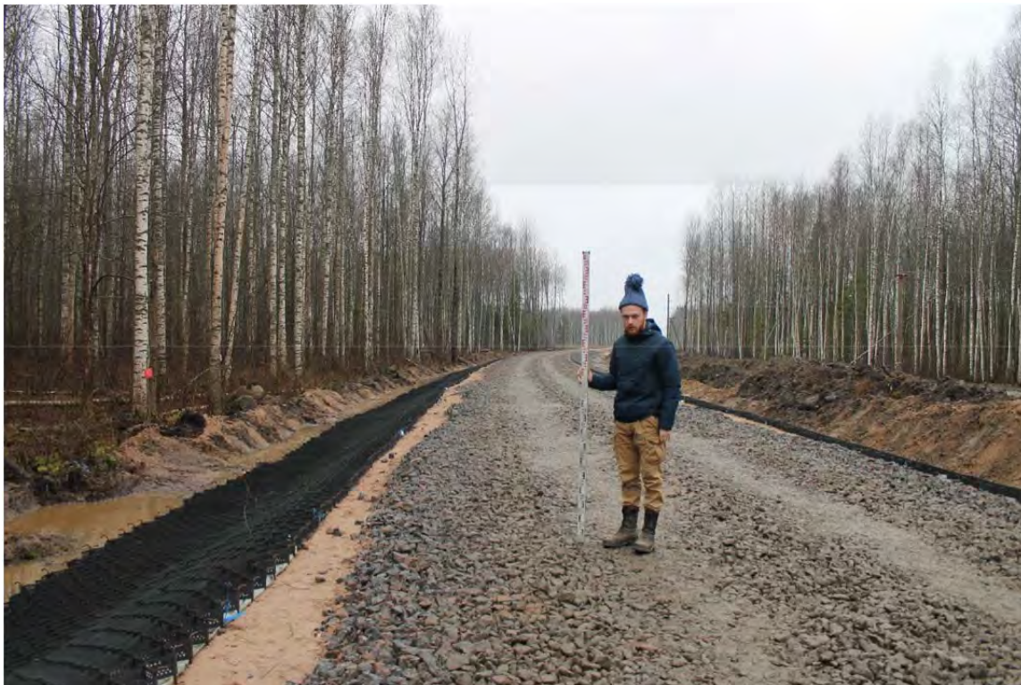
Рис. 247. Точка фотофиксации 14. Вид на юго-запад.
