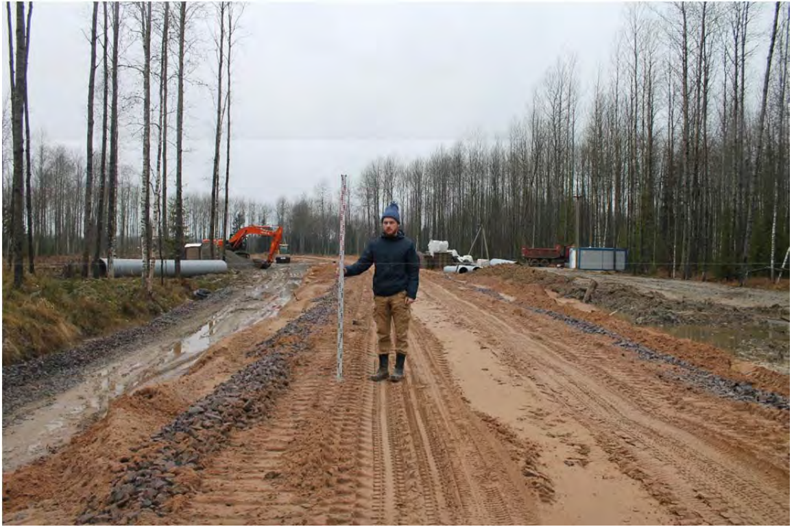
Рис. 17. Точка фотофиксации 2. Вид на юго-запад.
