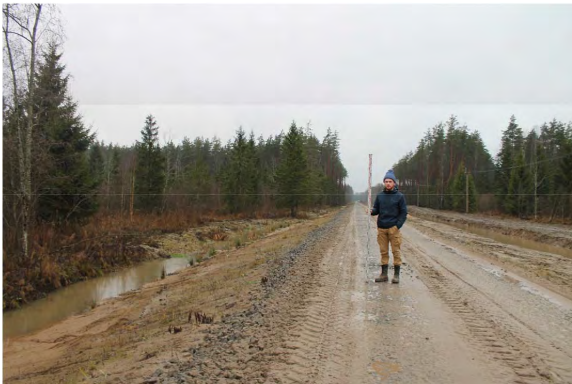
Рис. 85. Точка фотофиксации 5. Вид на юго-запад.
