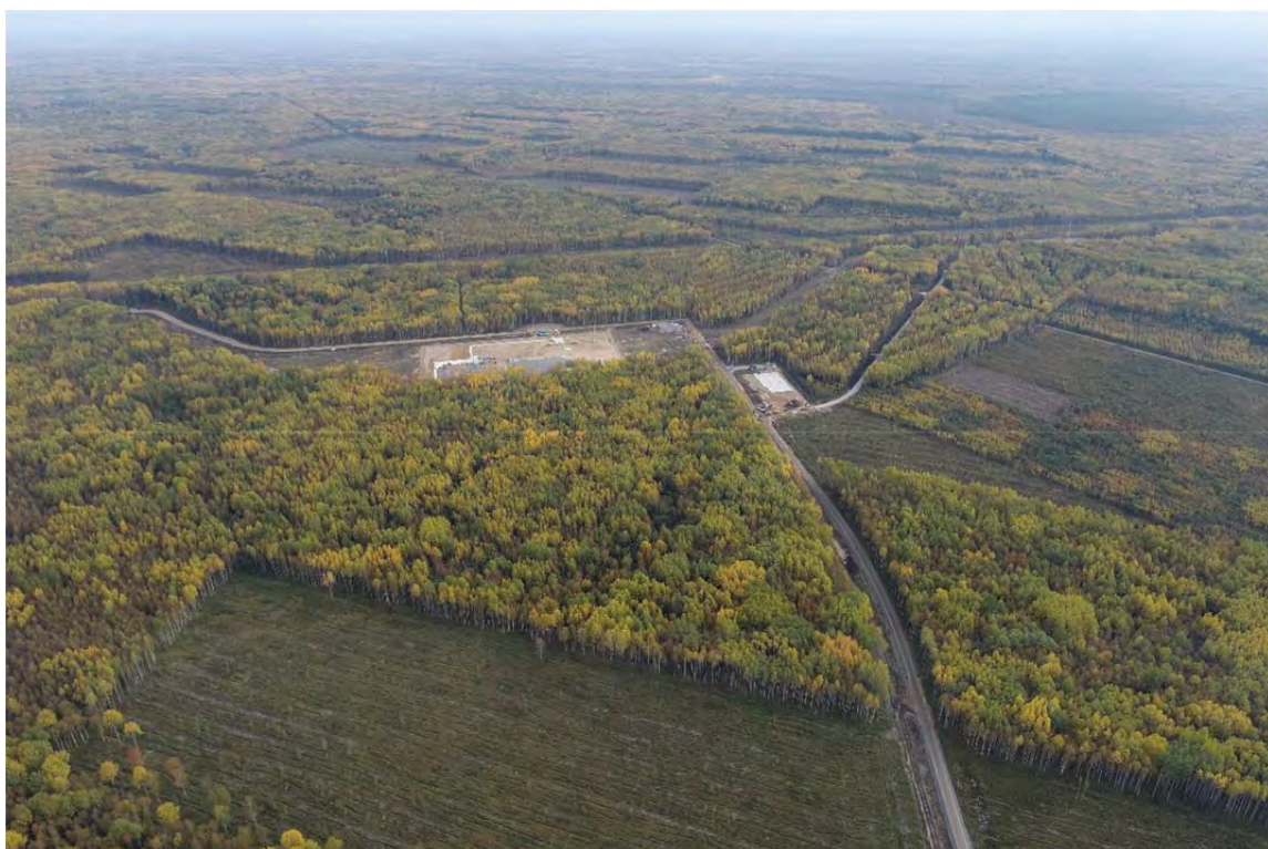
Рис. 244. Точка фотофиксации 11. Фото с квадрокоптера, высота 500 м. Вид на северо-восток.
