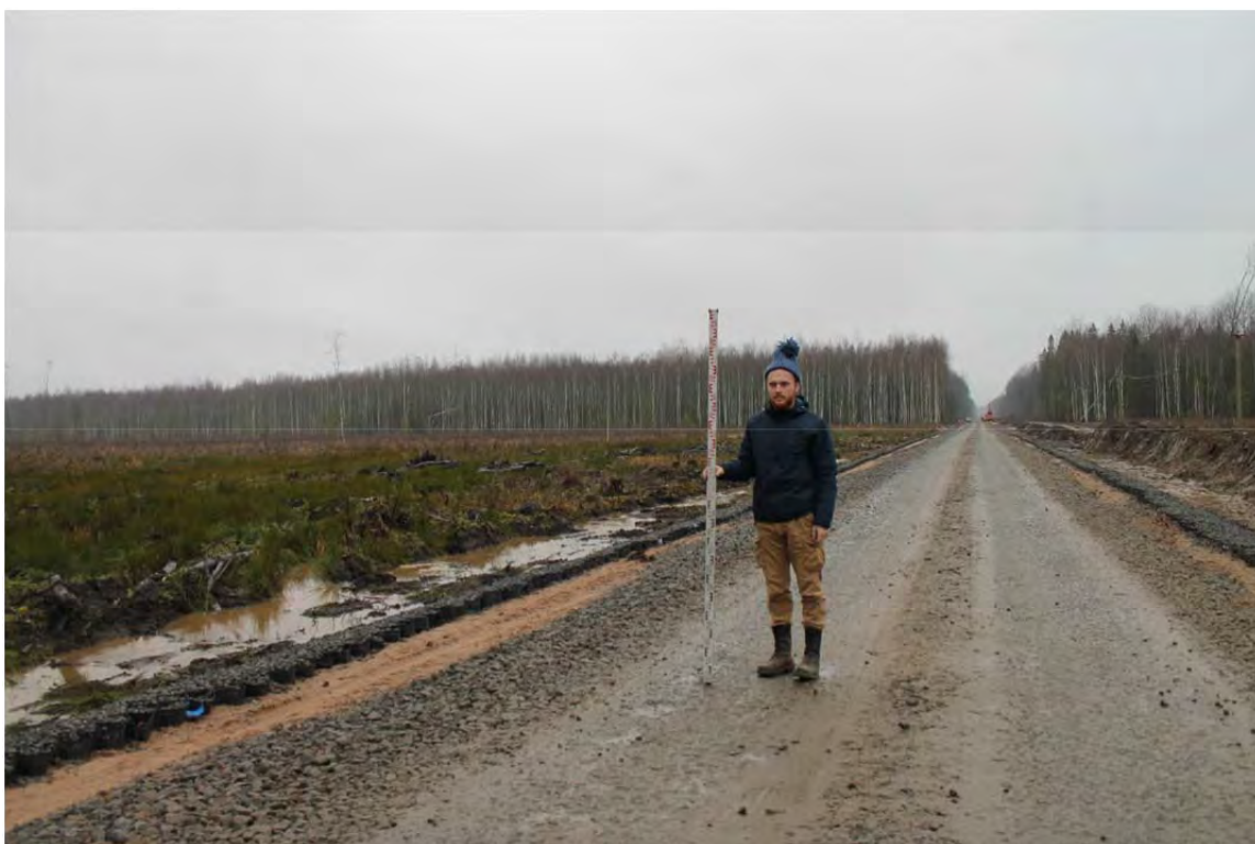
Рис. 246. Точка фотофиксации 13. Вид на юго-запад.
