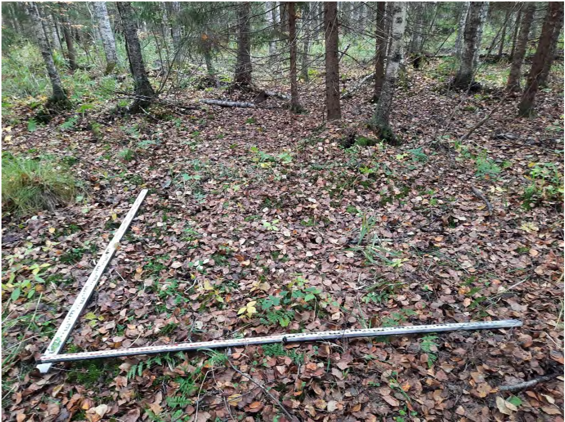
Рис. 133. Шурф 22. До начала земляных работ. Вид с Ю.
