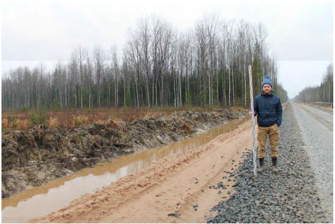
Рис. 186. Точка фотофиксации 8. Вид на юго-запад.
