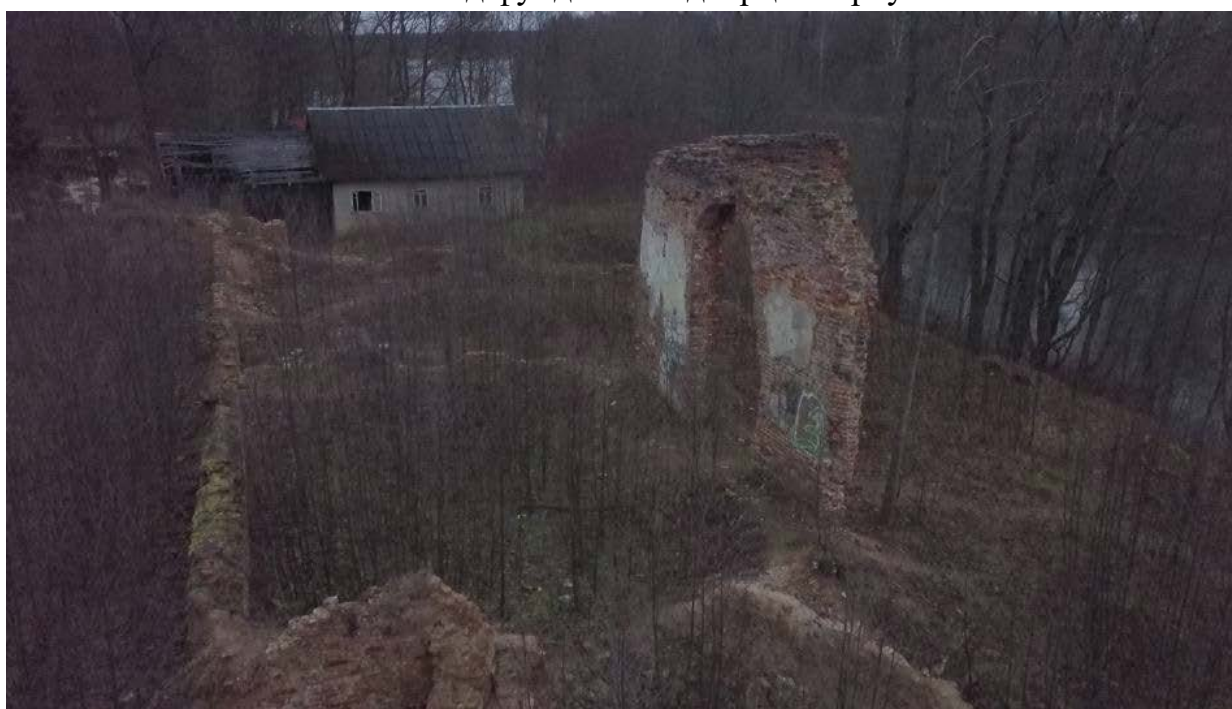
6. Вид на сохранившийся фрагмент стены с запада
