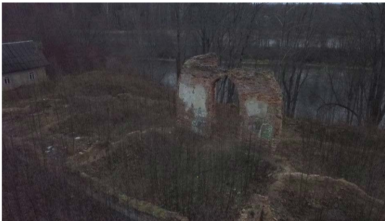
7. Вид на сохранившийся фрагмент стены с севера
