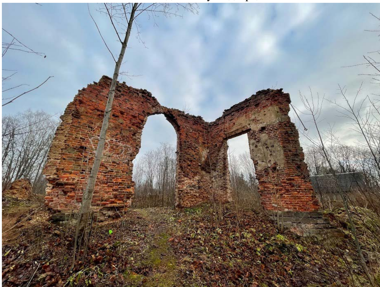
14. Вид на фрагменты стен с юга
