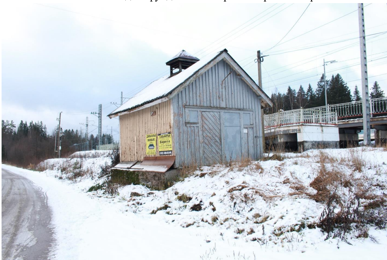
Фото 13. Вид на станционную хозяйственную постройку с севера.
