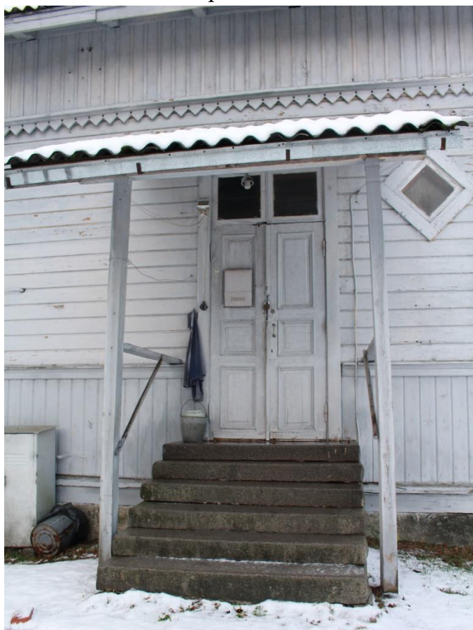
Фото 7. Вход в северной части восточного фасада вокзала железнодорожной станции «Гвардейское».
