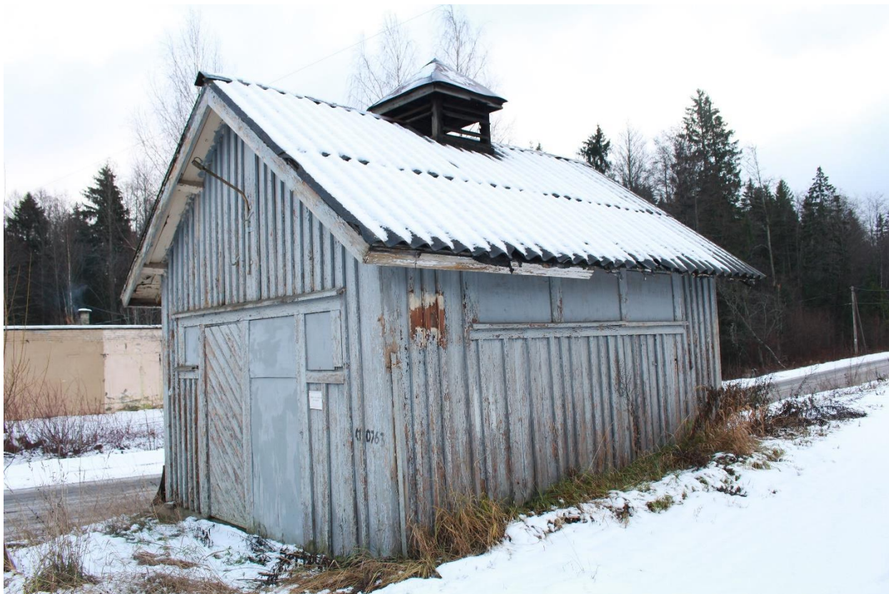
Фото 16. Вид на западный и северный фасады станционной хозяйственной постройки.
