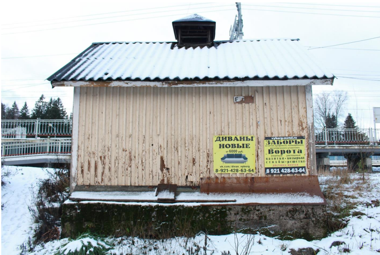
Фото 14. Вид на восточный фасад станционной хозяйственной постройки.
