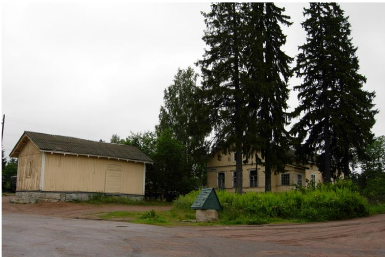
Илл. 12. Железнодорожная станция «Карисалми». 2007 г. (источник: https://terijoki.spb.ru/railway/rw_dir_hiitola.php ).
