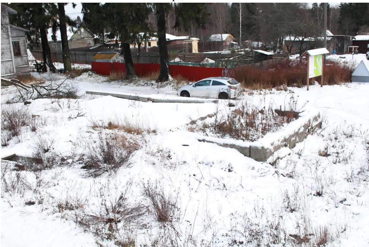
Фото 9. Вид на фундамент товарного сарая с запада.
