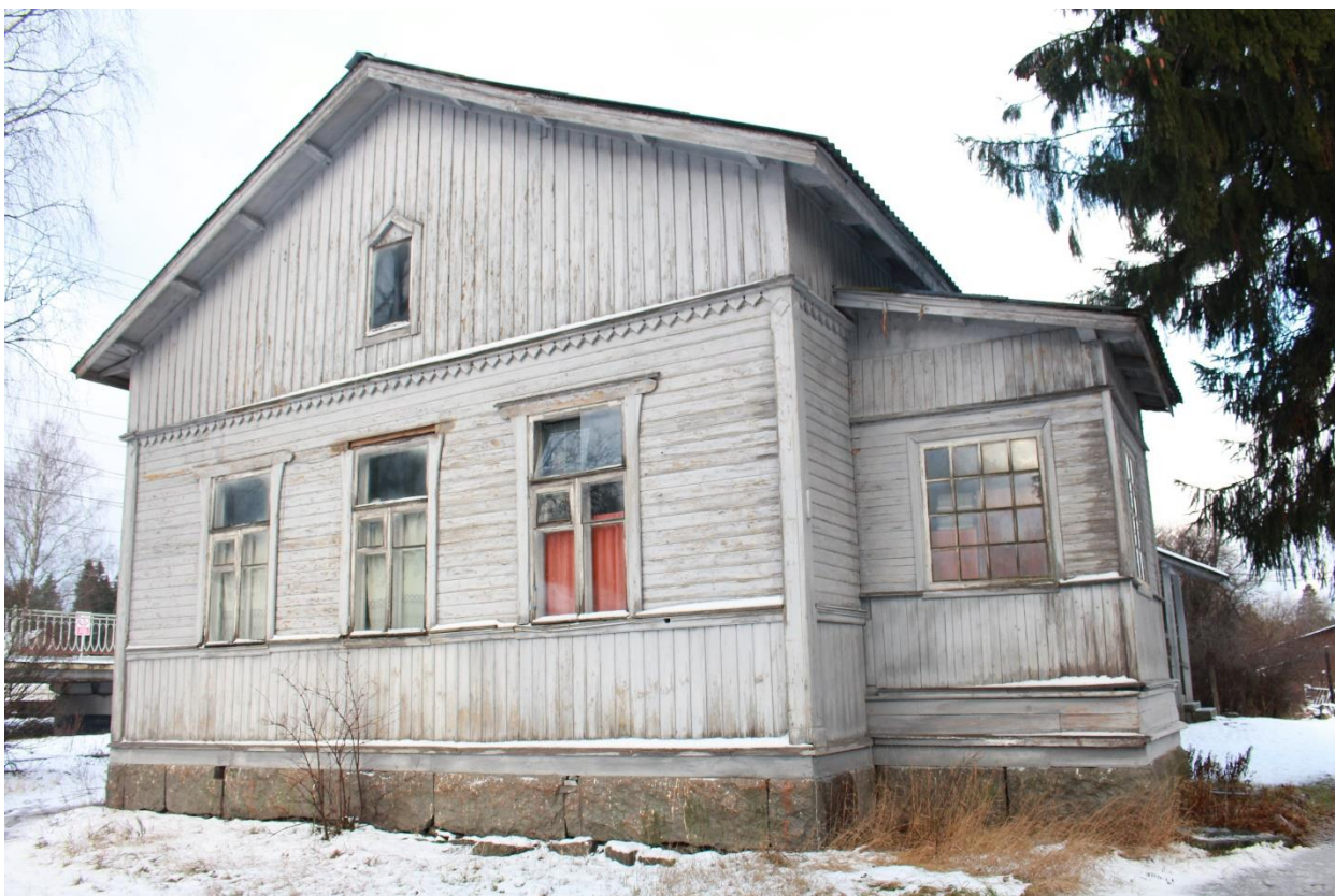
Фото 4. Вид на южной фасад вокзала железнодорожной станции «Гвардейское».
