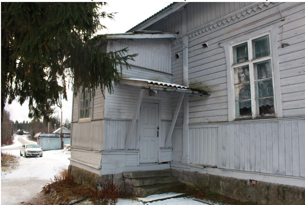
Фото 5. Вид на пристроенный тамбур к юго-восточной части здания вокзала железнодорожной станции «Гвардейское».
