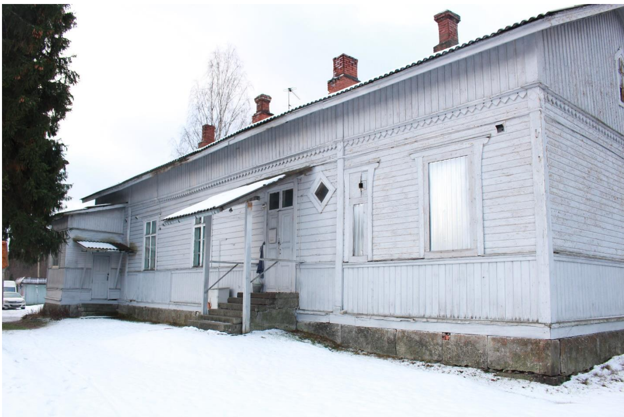
Фото 6. Вид на восточный фасад вокзала железнодорожной станции «Гвардейское».
