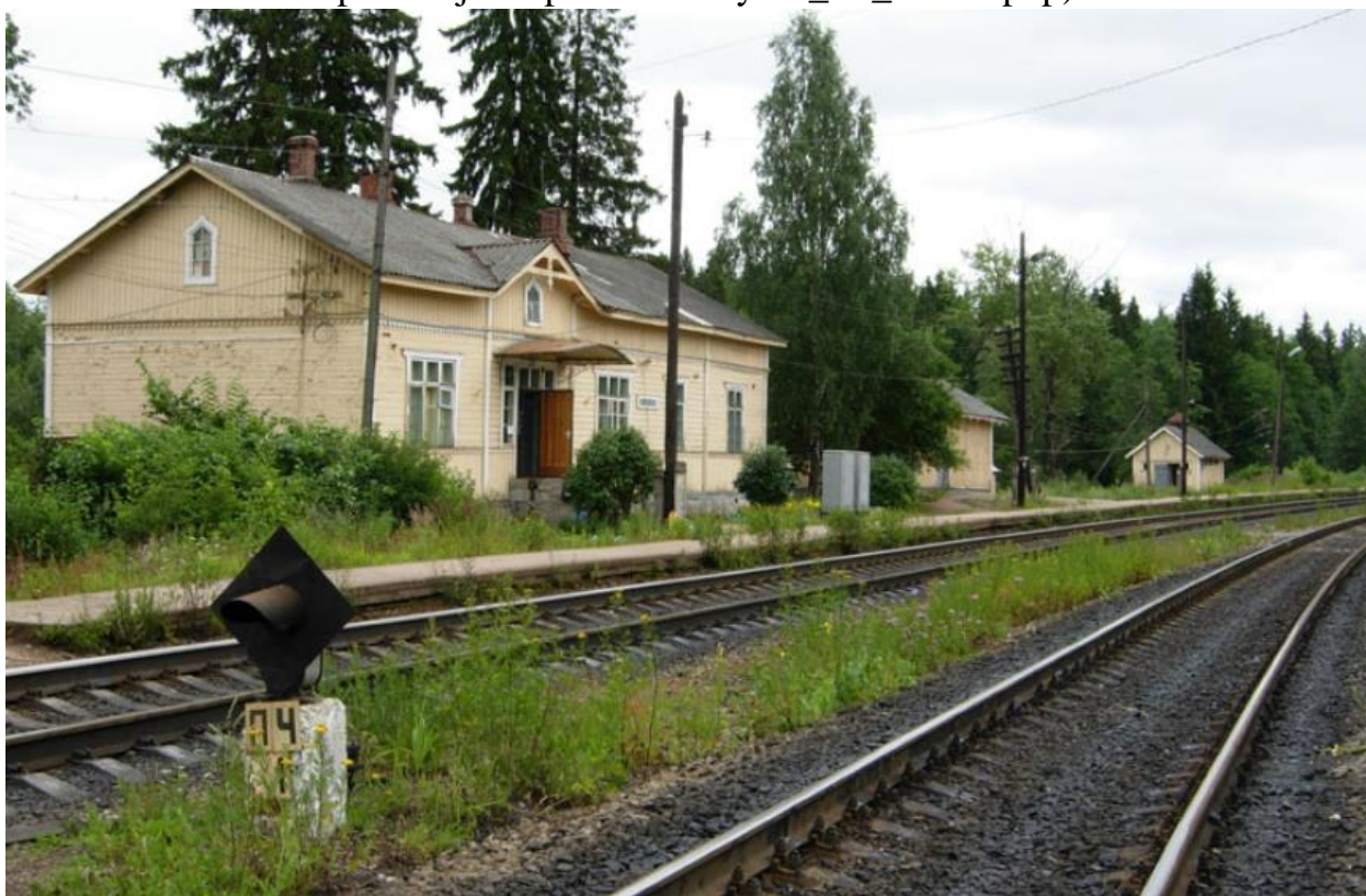
Илл. 13. Железнодорожная станция «Карисалми». 2007 г. (источник: https://terijoki.spb.ru/railway/rw_dir_hiitola.php ).
