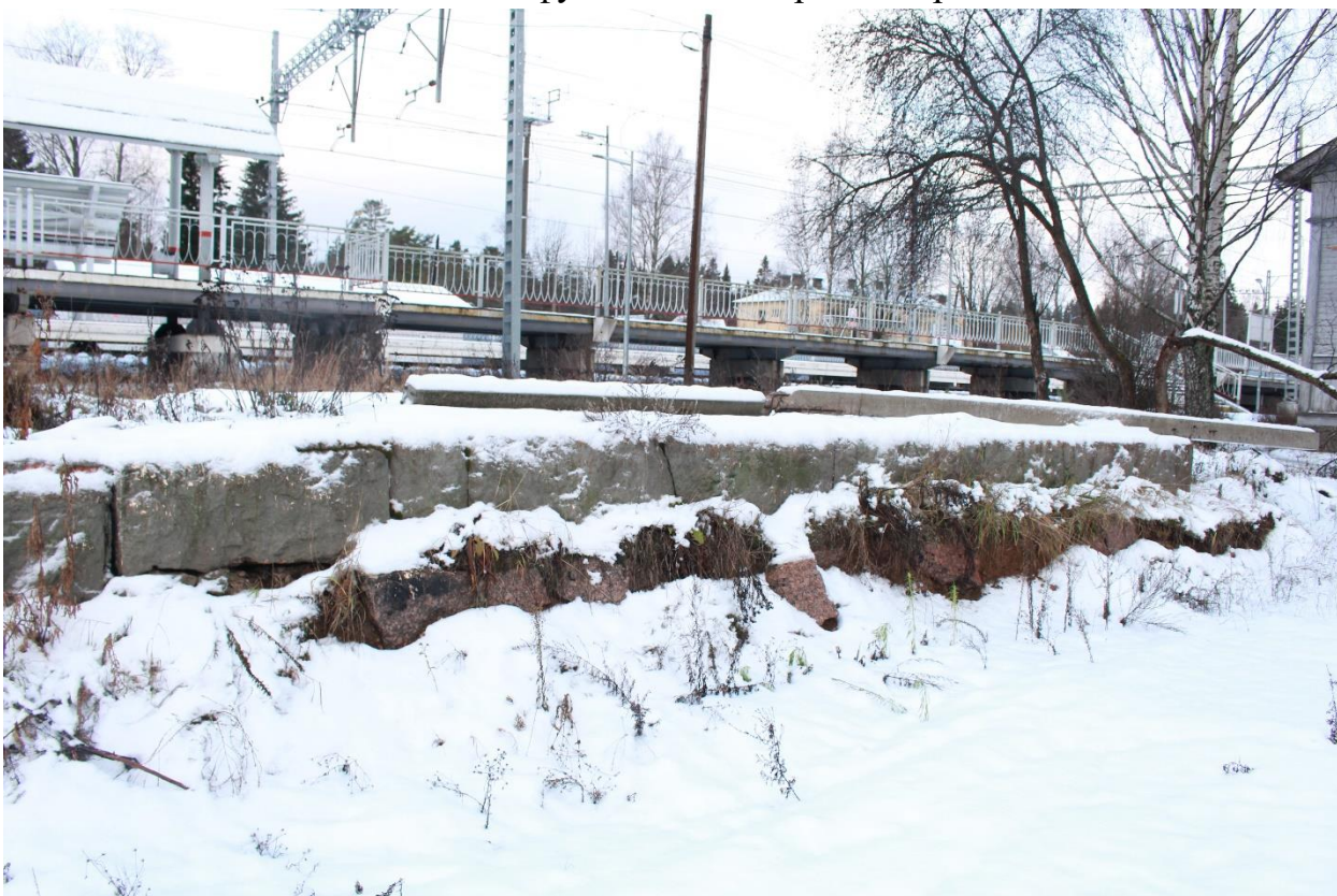
Фото 11. Вид на фундамент товарного сарая с востока.
