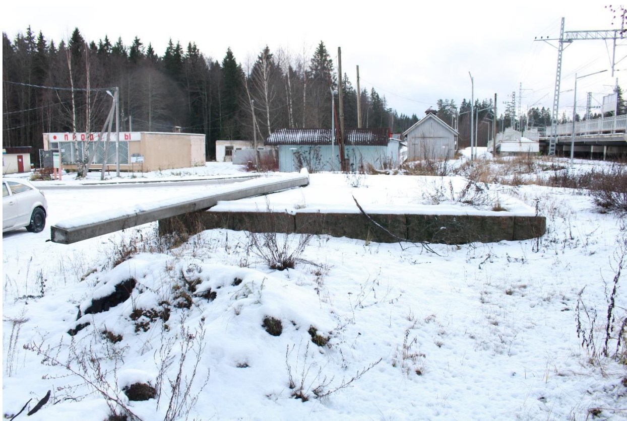
Фото 12. Вид на фундамент товарного сарая с севера.
