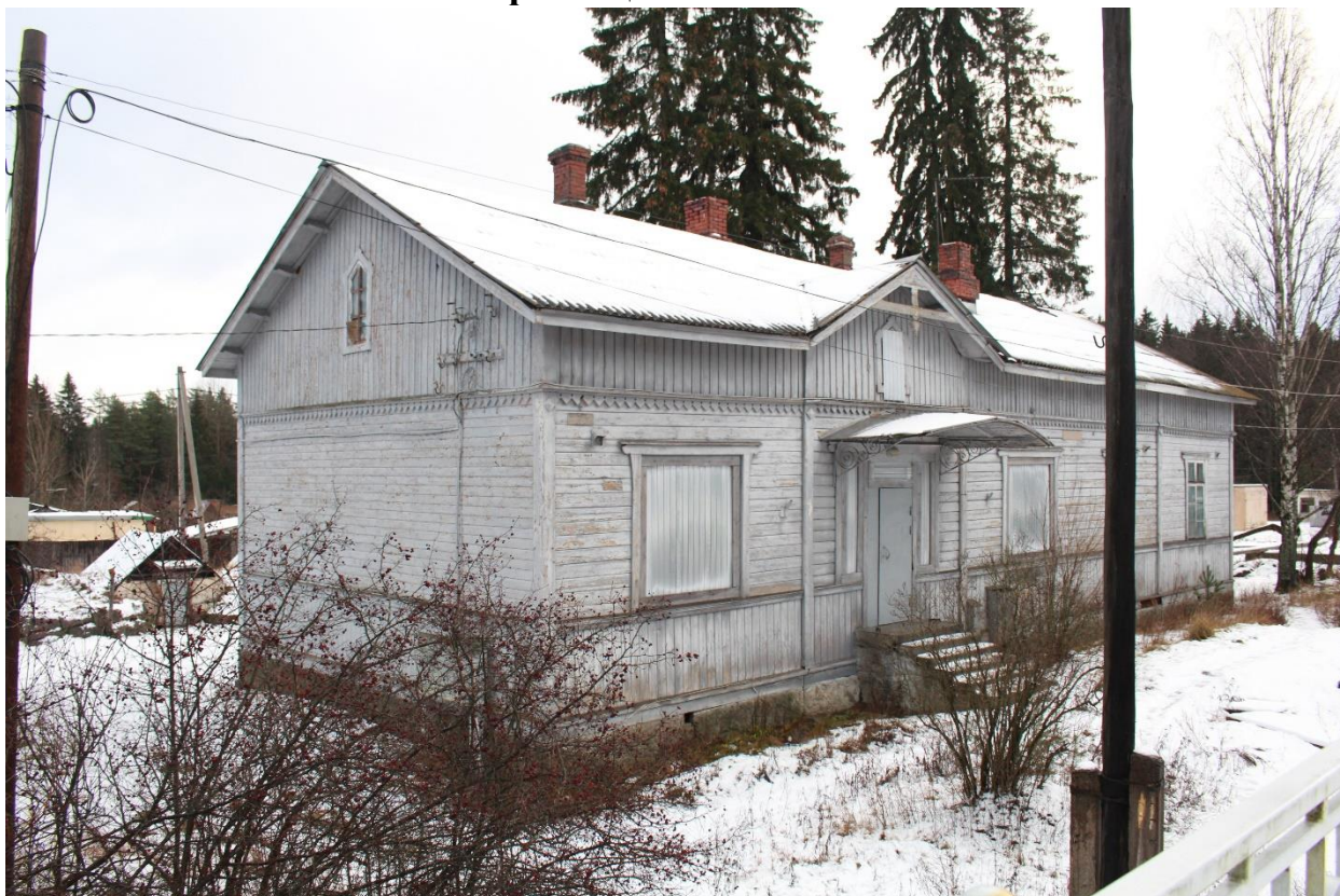
Фото 1. Вид на северный и западный фасад вокзала железнодорожной станции «Гвардейское».
