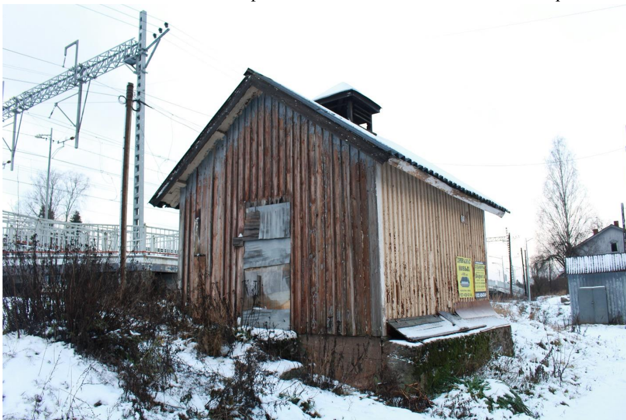
Фото 15. Вид на южный фасад станционной хозяйственной постройки.
