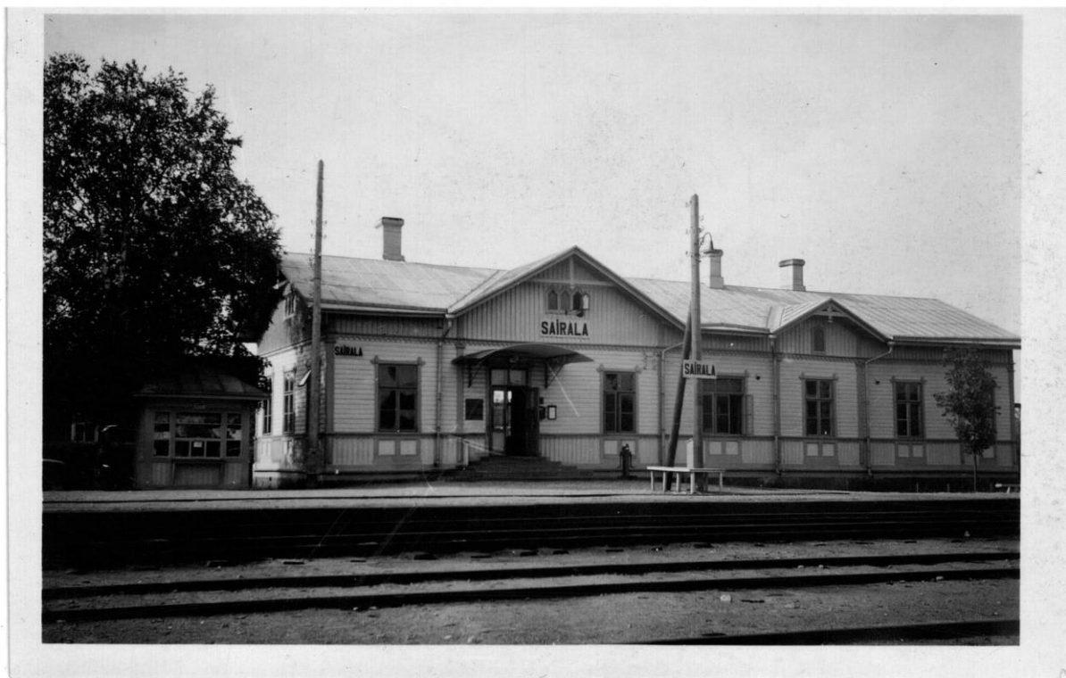
Илл. 10. Вокзал железнодорожной станции «Сайрала». 1930-е гг. (источник: http://www.kirvu.fi/kaikki-kotiarkistomme ).
