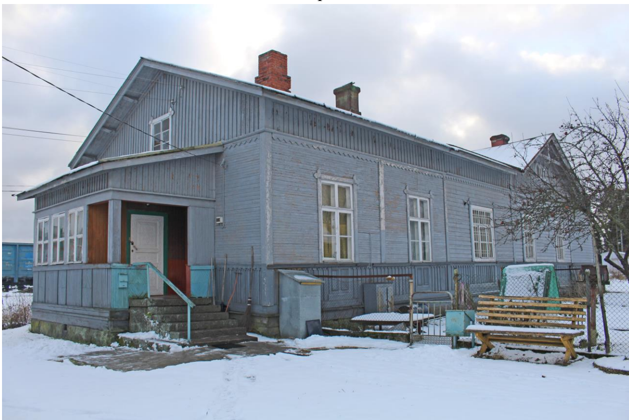
Фото 6. Вид на северо-западный фасад вокзала железнодорожной станции «Бородинское».
