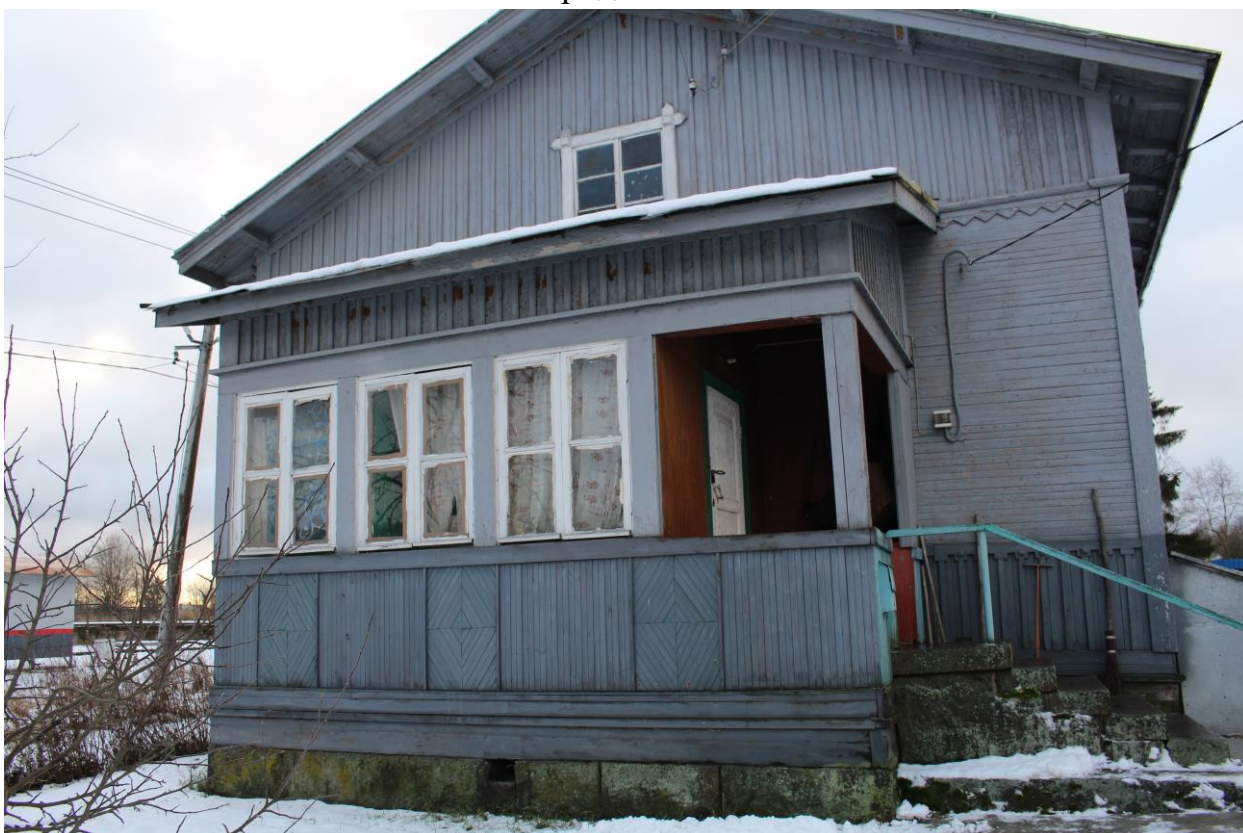
Фото 4. Вид на веранду с северо-восточной стороны вокзала железнодорожной станции «Бородинское».
