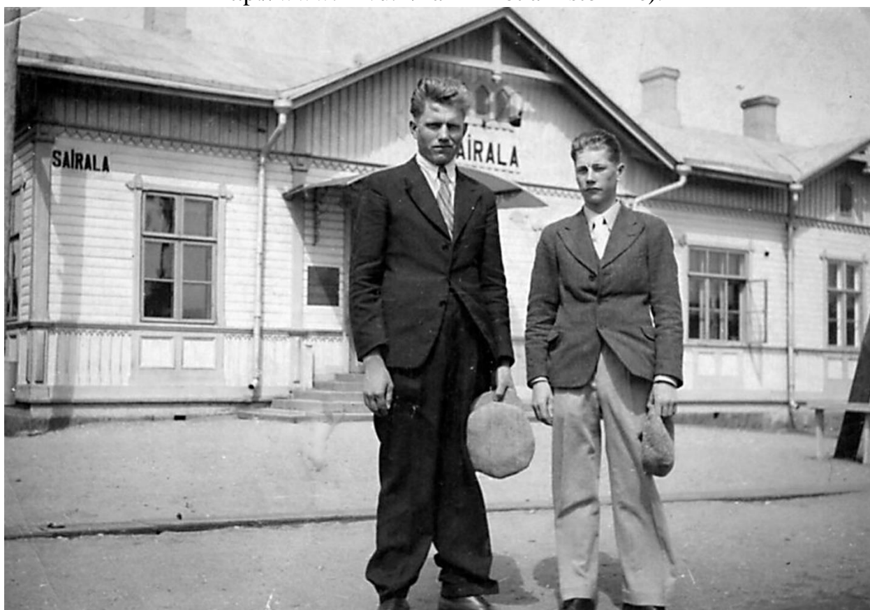
Илл. 11. Вокзал железнодорожной станции «Сайрала». 1930-е гг. (источник: http://www.kirvu.fi/kaikki-kotiarkistomme ).
