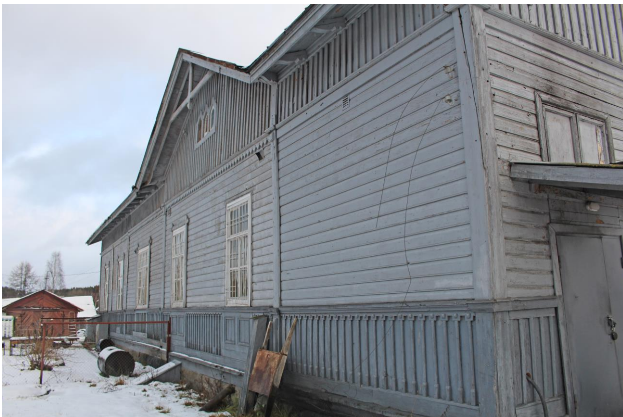
Фото 7. Вид на северо-западный фасад вокзала железнодорожной станции «Бородинское».
