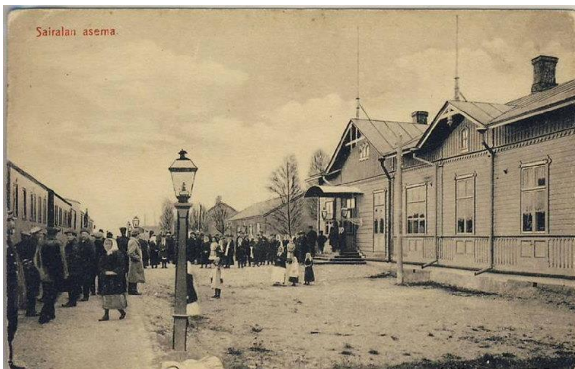
Илл. 8. Вокзал железнодорожной станции «Сайрала», 1908 – нач. XX в. (источник: https://terijoki.spb.ru/railway/rw_dir_hiitola.php ).
