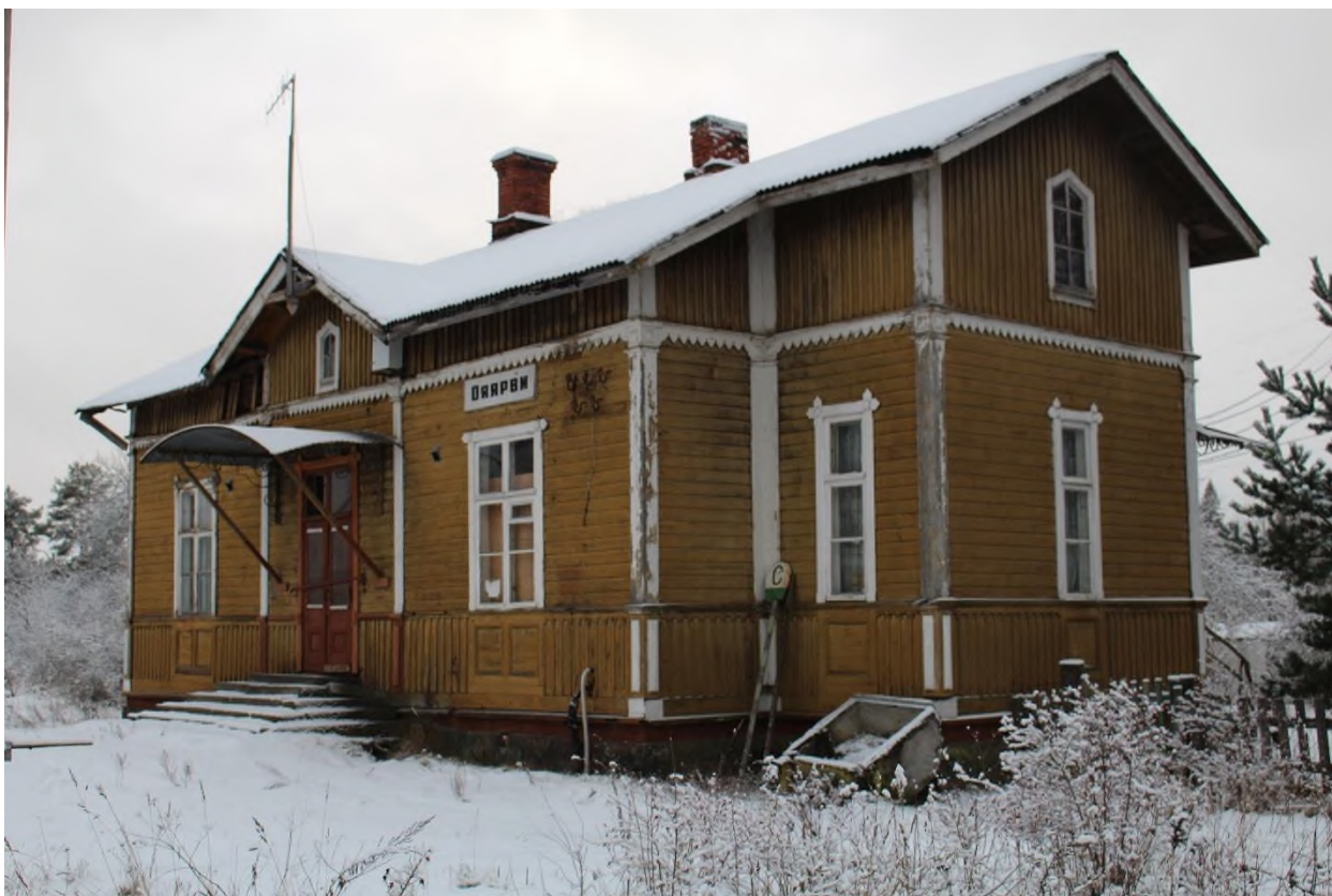
Фото 4. Вид на восточный и северный фасады вокзала железнодорожной станции «Оярви».
