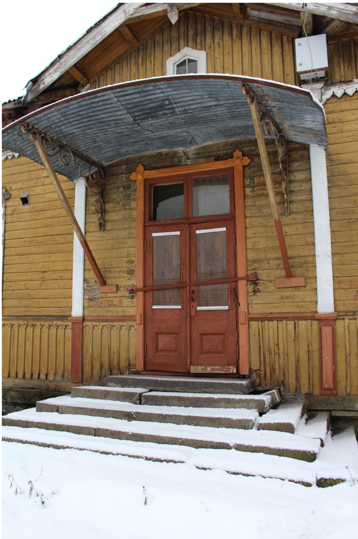
Фото 3. Вид на крыльцо с восточной стороны здания.
