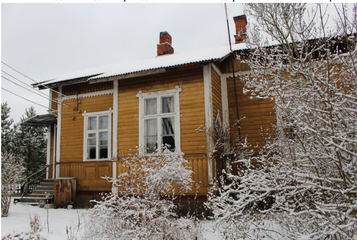
Фото 7. Вид на западный фасад вокзала железнодорожной станции «Оярви».
