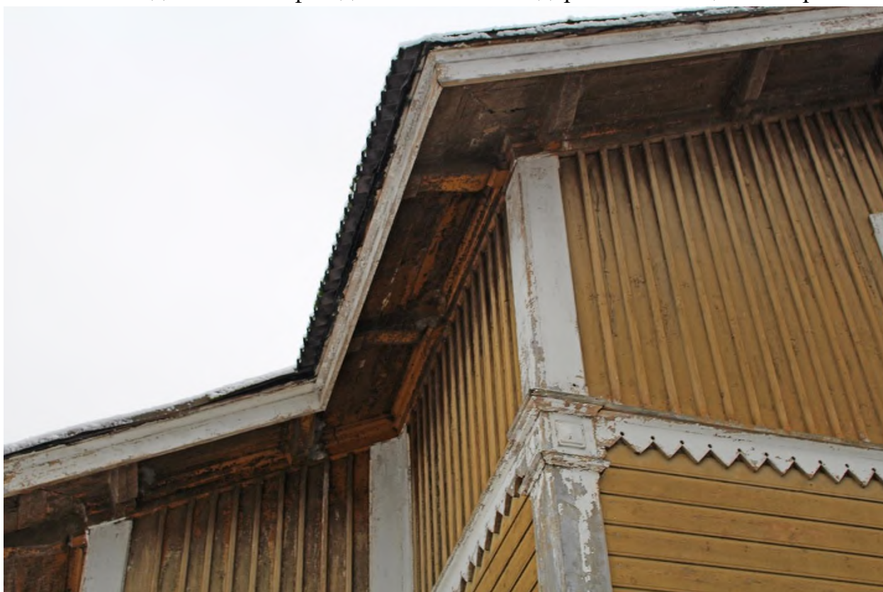
Фото 9. Вид на свесы крыши.
