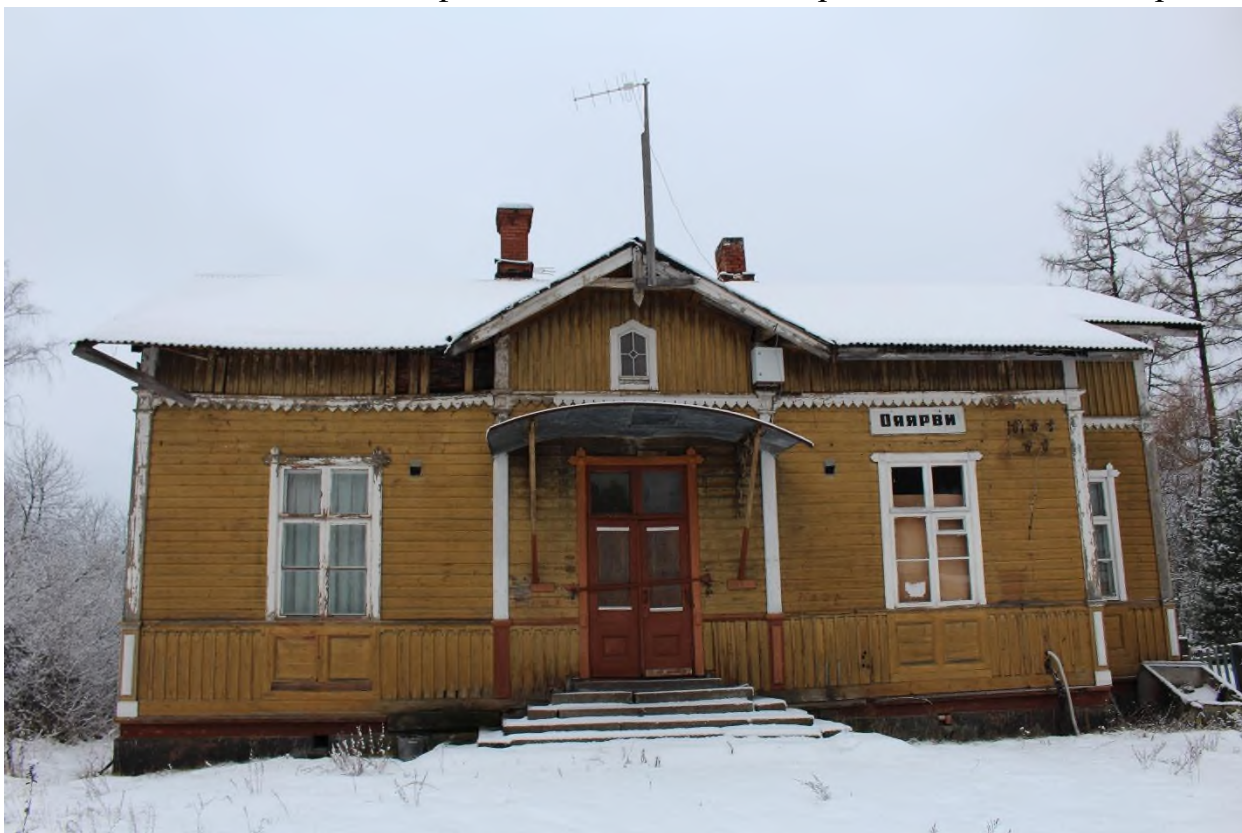
Фото 2. Вид на восточный фасад вокзала железнодорожной станции «Оярви».
