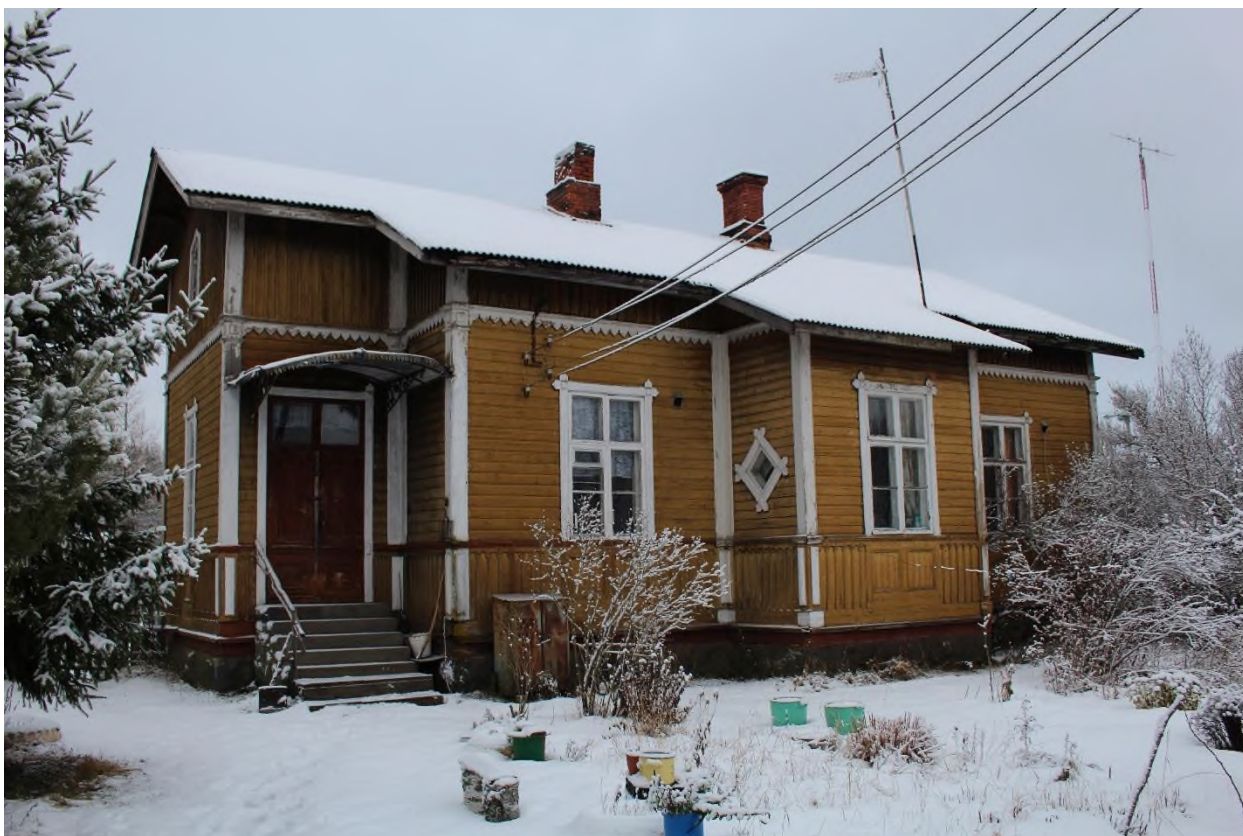
Фото 6. Вид на западный фасад вокзала железнодорожной станции «Оярви».
