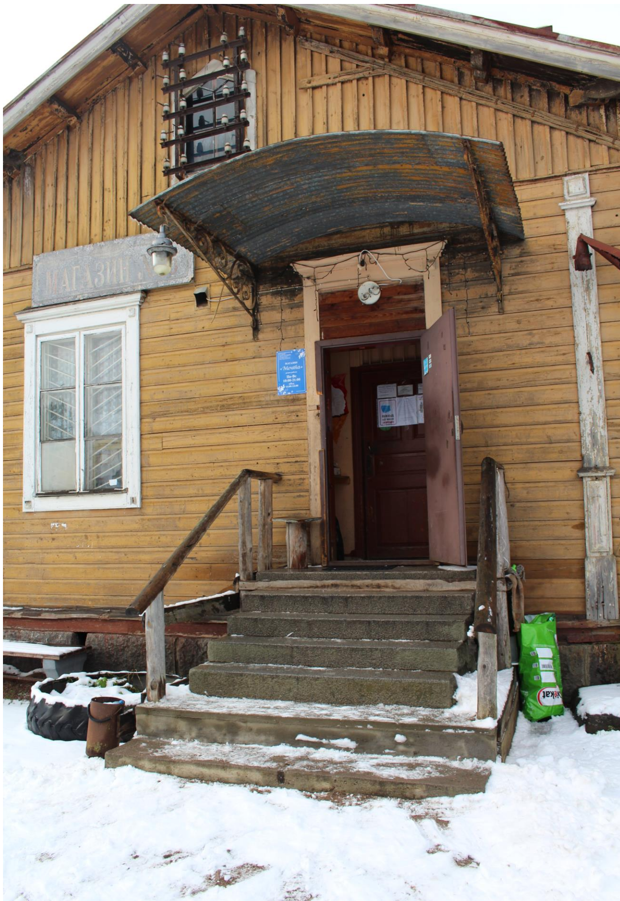
Фото 4. Вид на крыльцо в южной части восточного фасада здания.
