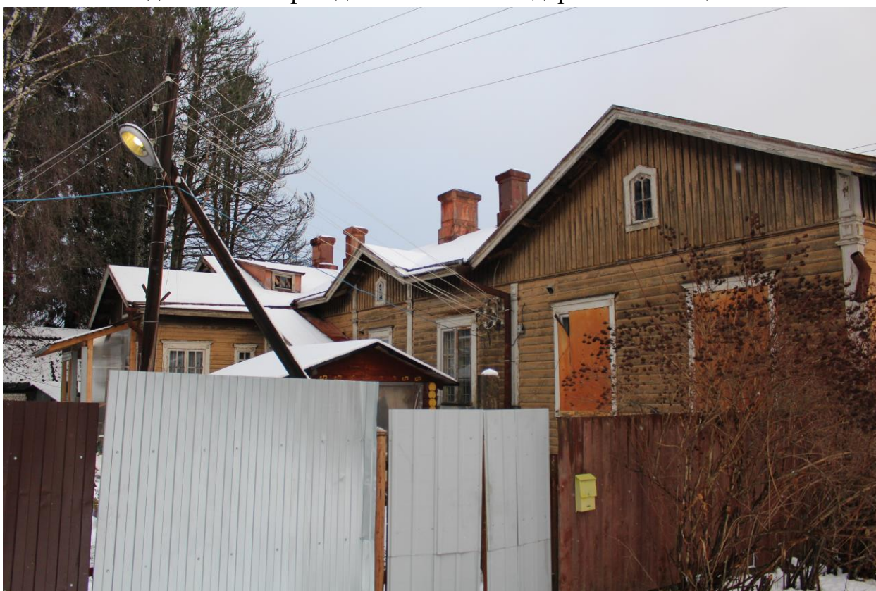
Фото 6. Вид на западный фасад вокзала железнодорожной станции «Инкиля».
