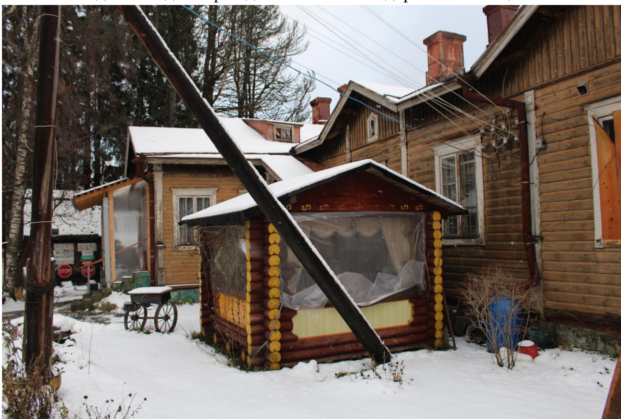
Фото 8. Вид на западный фасад вокзала железнодорожной станции «Инкиля».
