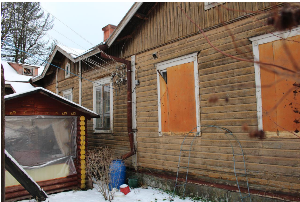
Фото 7. Вид на западный фасад вокзала железнодорожной станции «Инкиля».
