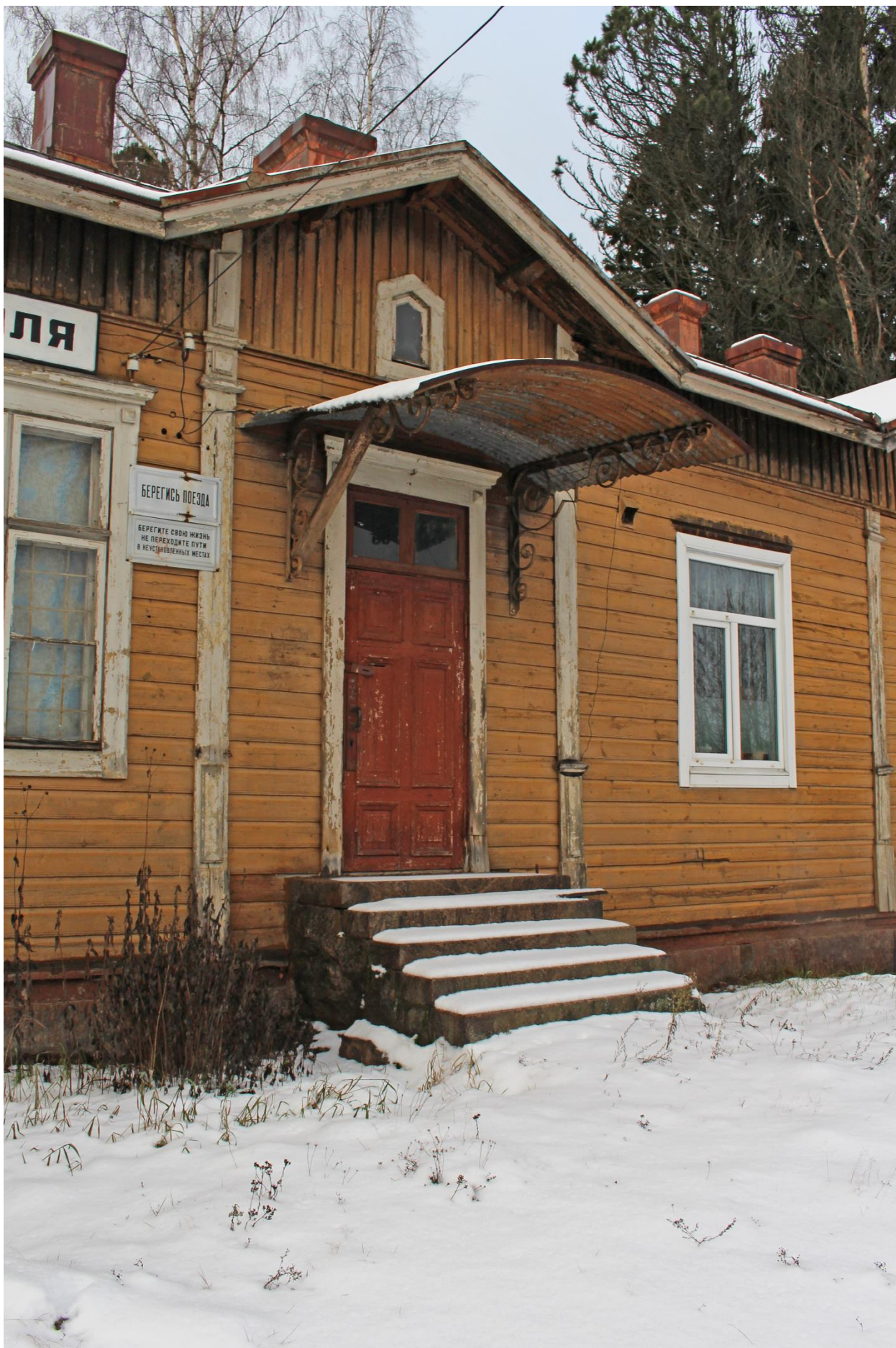
Фото 3. Вид на крыльцо в центральной части восточного фасада здания.
