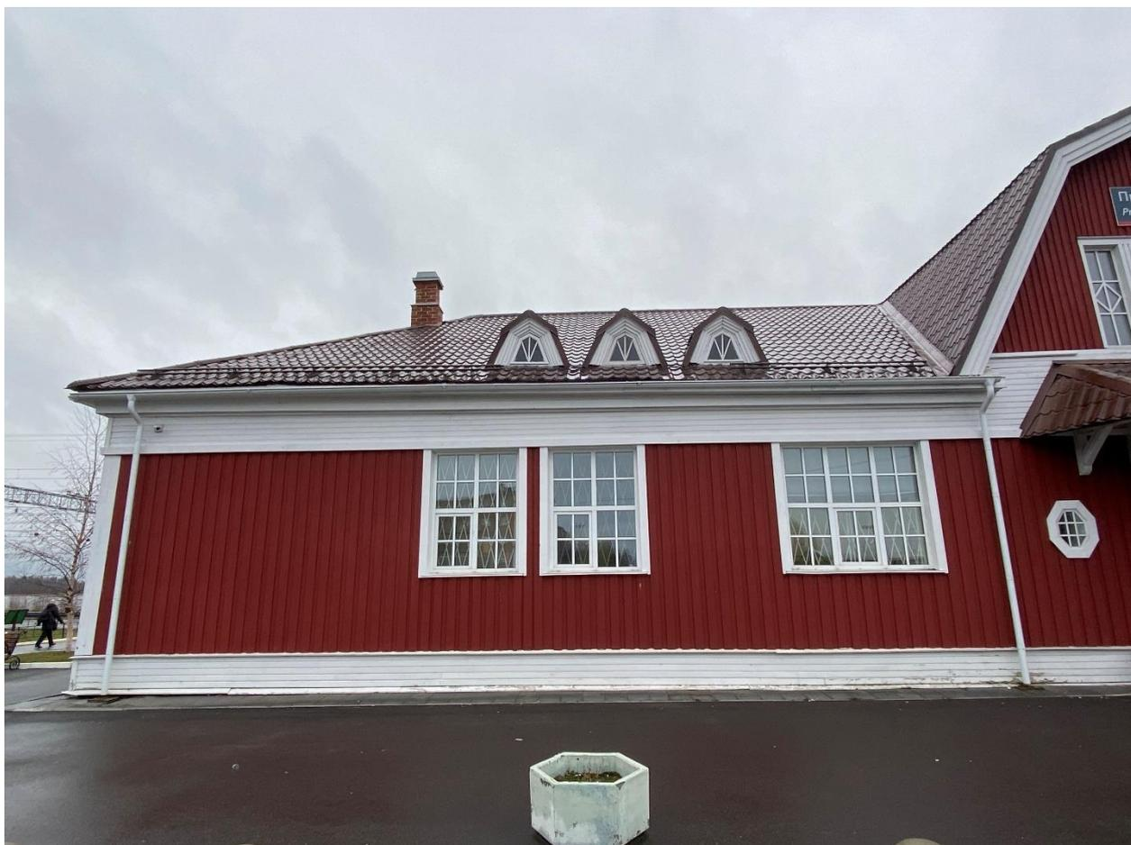
Фото 7. Южная часть северо-восточного фасада. Современные металлопластиковые оконные заполнения прямоугольной конфигурации с сохранением исторического рисунка расстекловки, оформленные деревянными наличниками.
