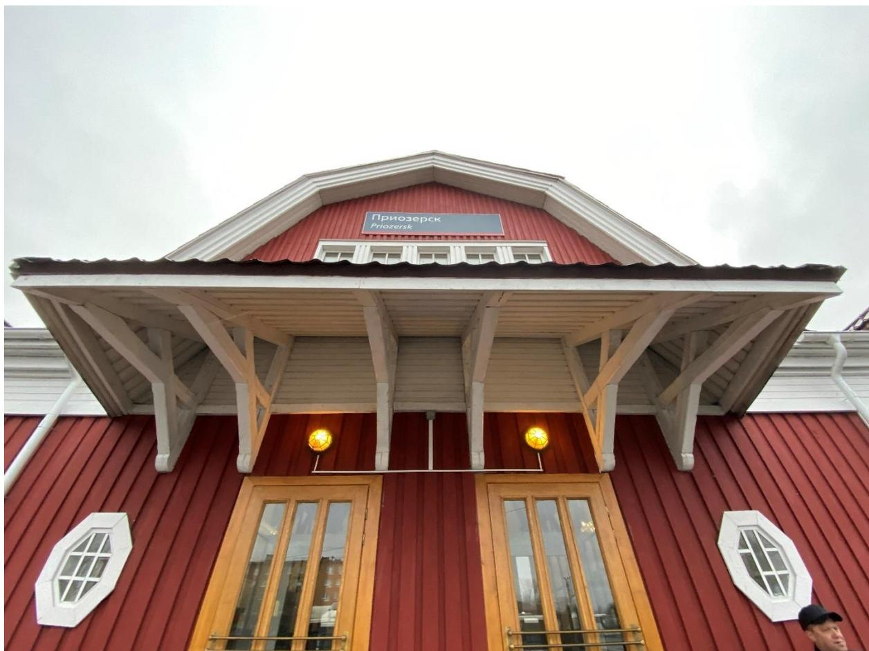
Фото 12. Деревянный козырек, окрытый металлочерепицей на деревянных кронштейнах со стороны северо-восточного фасада.
