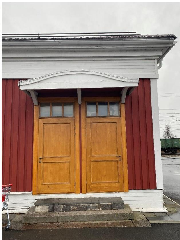
Фото 14. Деревянные дверные заполнения со стороны северо-восточного фасада. Гранитные ступени. Козырек на деревянных кронштейнах.
