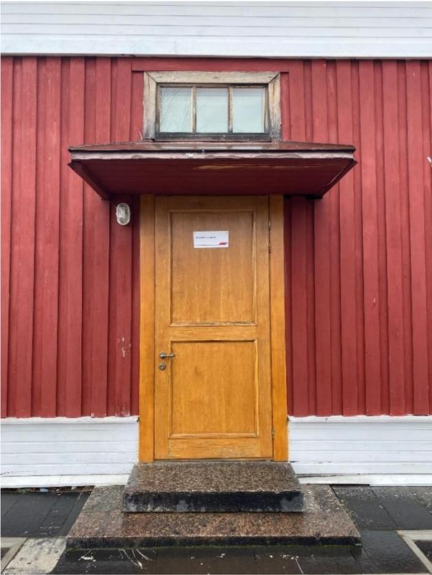
Фото 15. Вход в здание с юго-восточного фасада. Деревянное дверное заполнение. Гранитные ступени.
