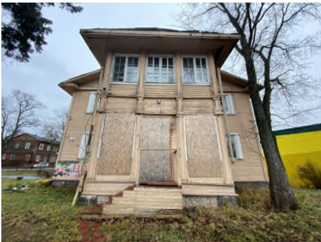
Фото 6. Западный фасад здания.
