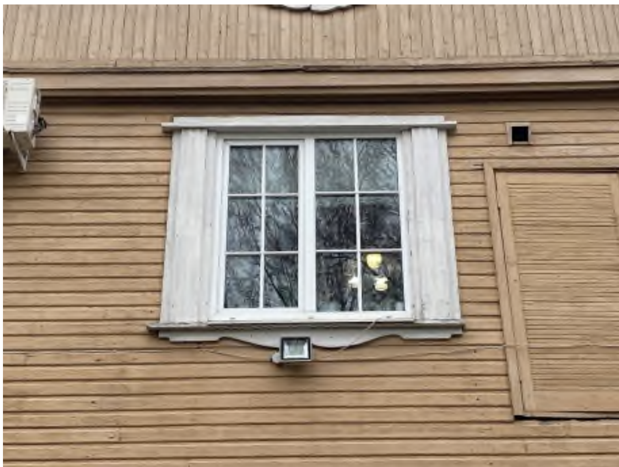
Фото 9. Оконные проемы, оформленные резными деревянными наличниками.
