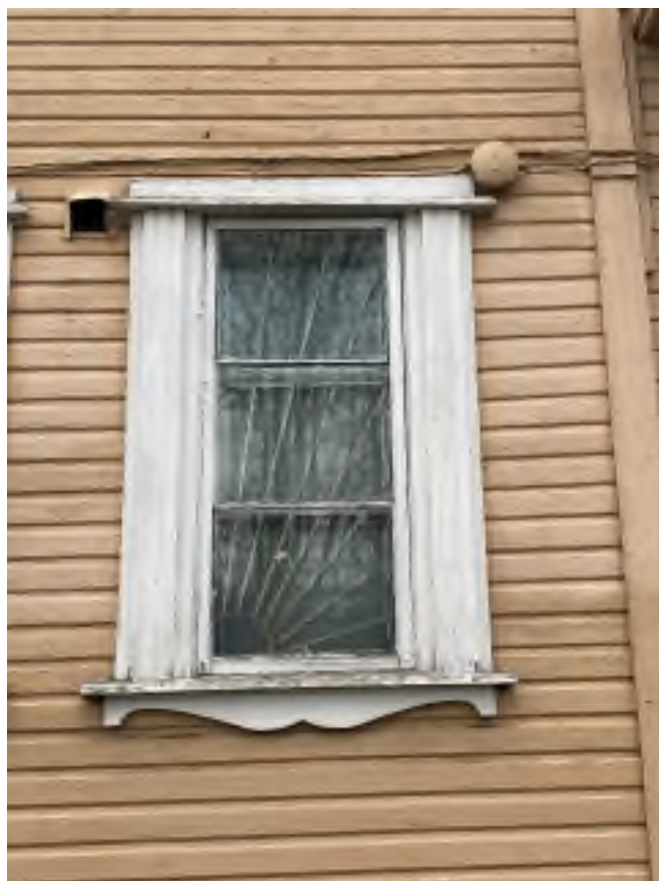
Фото 8. Оконные проемы, оформленные резными деревянными наличниками.
