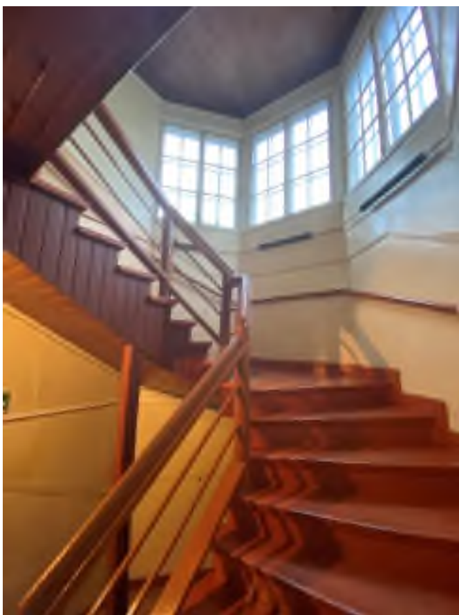
Фото 14. Деревянная лестница в уровне между 1-м и 2-м этажами. Вид с юга.
