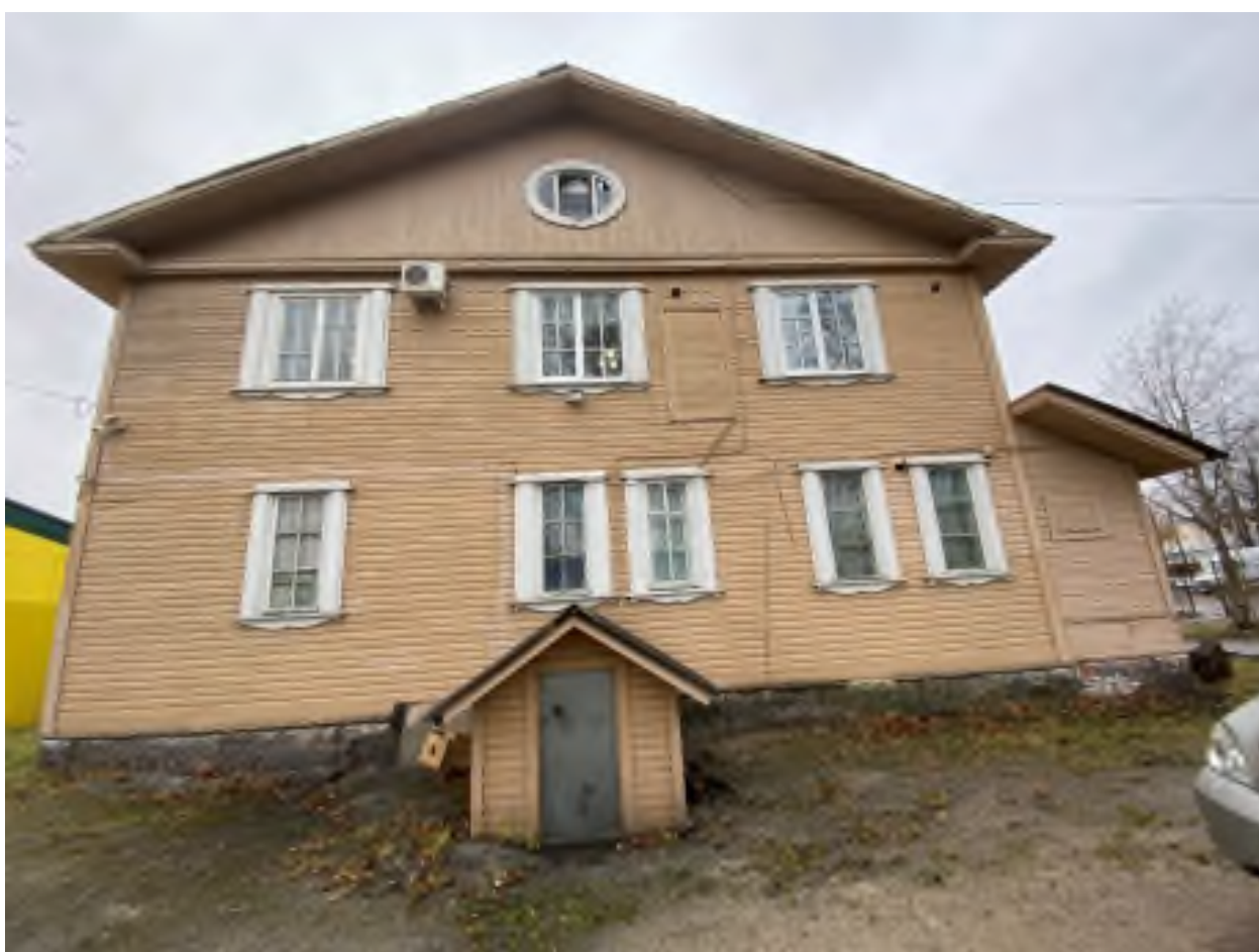
Фото 4. Восточный фасад здания.
