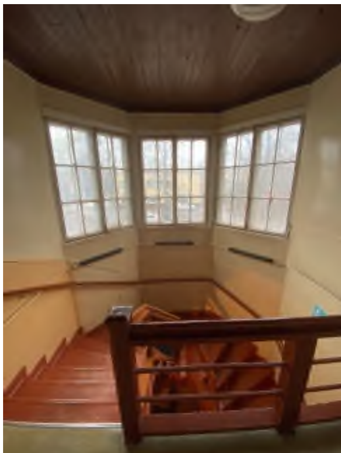
Фото 16. Общий вид лестничного объема сверху.
