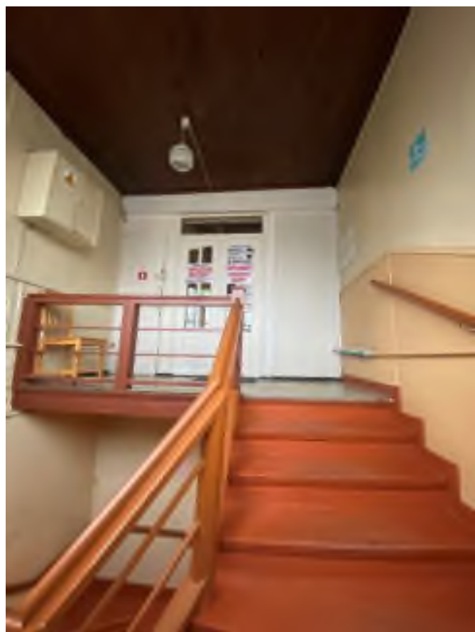
Фото 15. Деревянная лестница в уровне 2-го этажа. Вид с севера.
