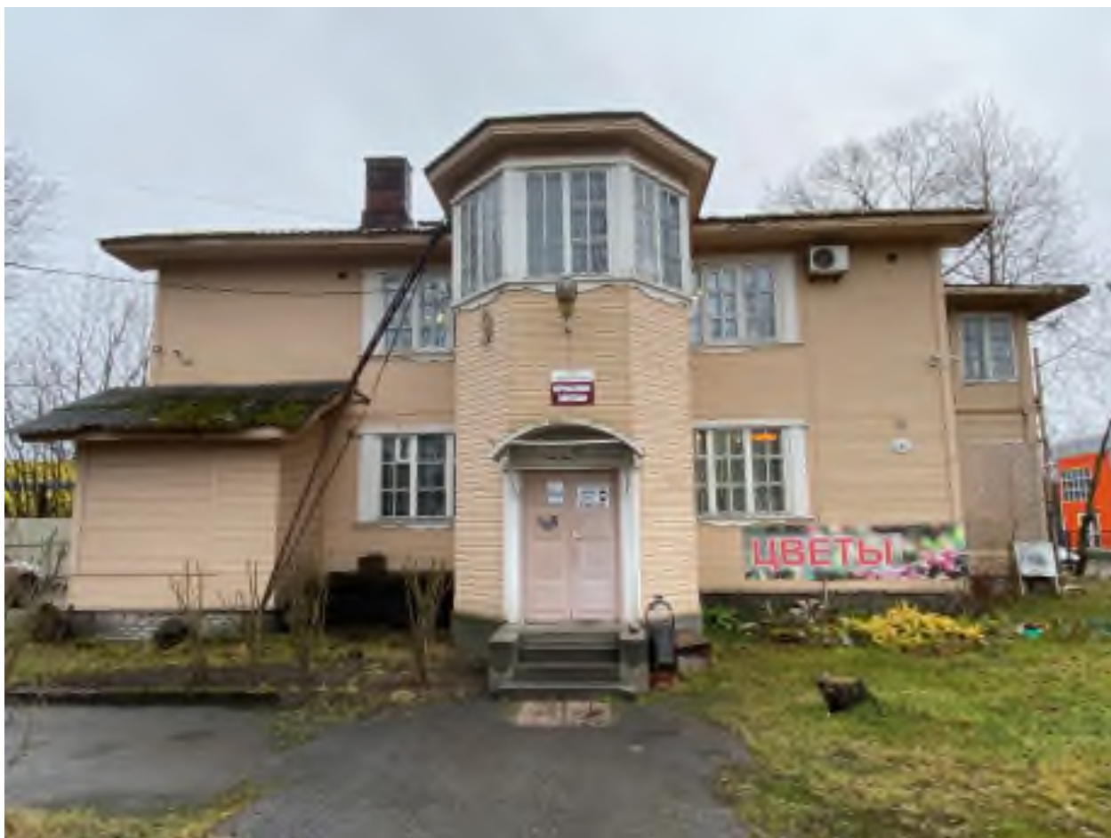
Фото 2. Северный фасад здания.
