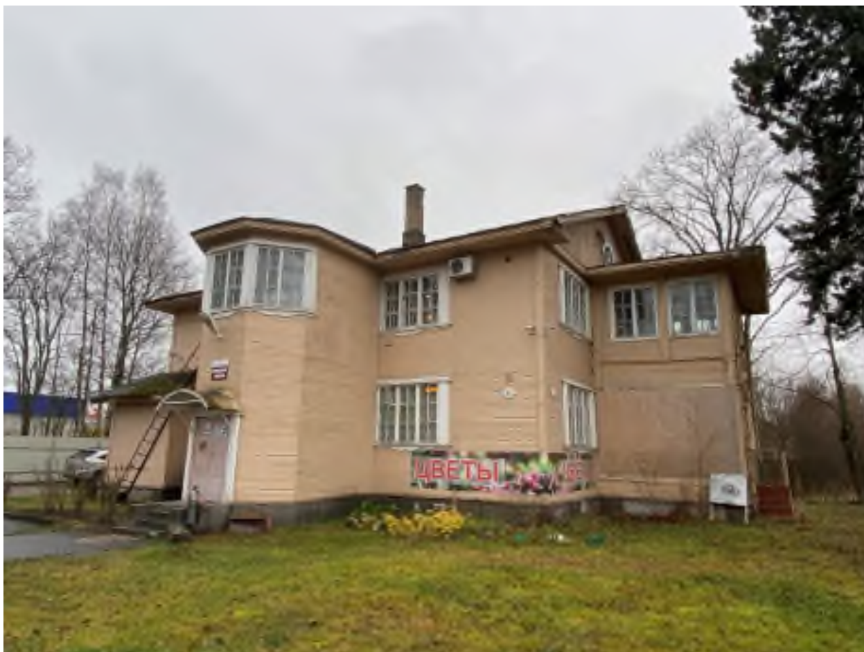
Фото 5. Общий вид объекта с северо-запада.
