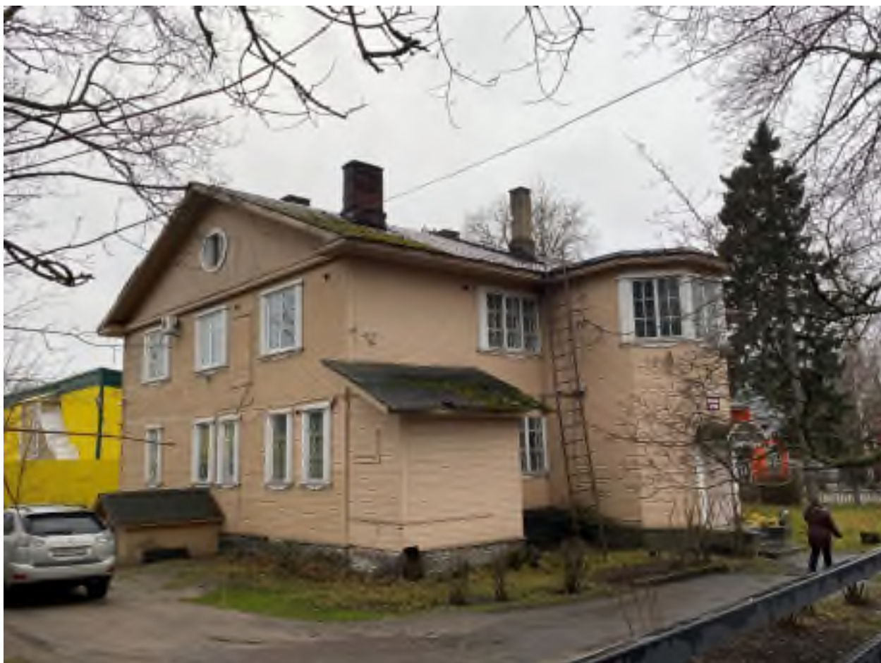
Фото 1. Общий вид выявленного объекта культурного наследия «Жилой дом», расположенного по адресу: Ленинградская область, Приозерский район, г. Приозерск, Советская, 6 / Жуковского, 1.
