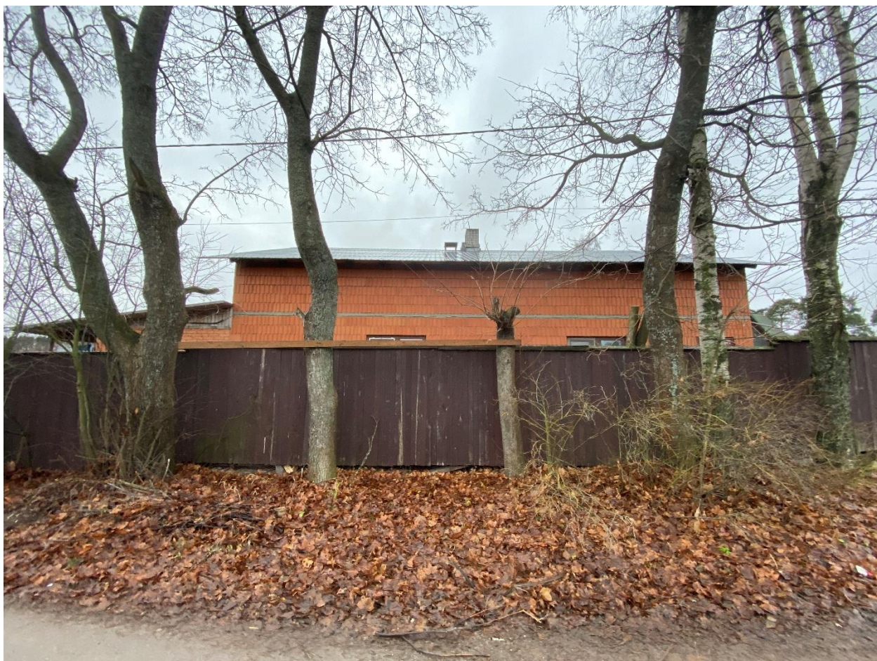
Фото 5. Восточный фасад дома. Вид с улицы Урицкого
