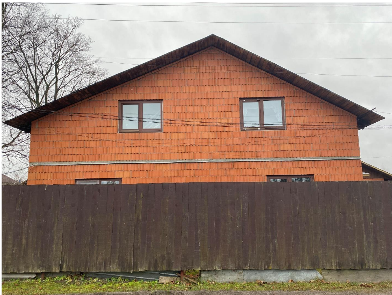
Фото 3. Северный фасад дома. Вид с улицы Суворова.
