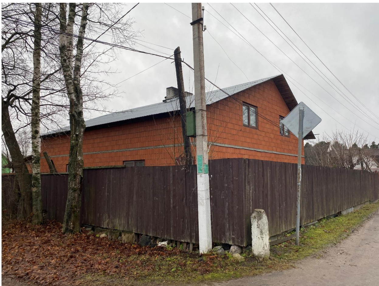
Фото 4. Общий вид объекта с северо-востока.
