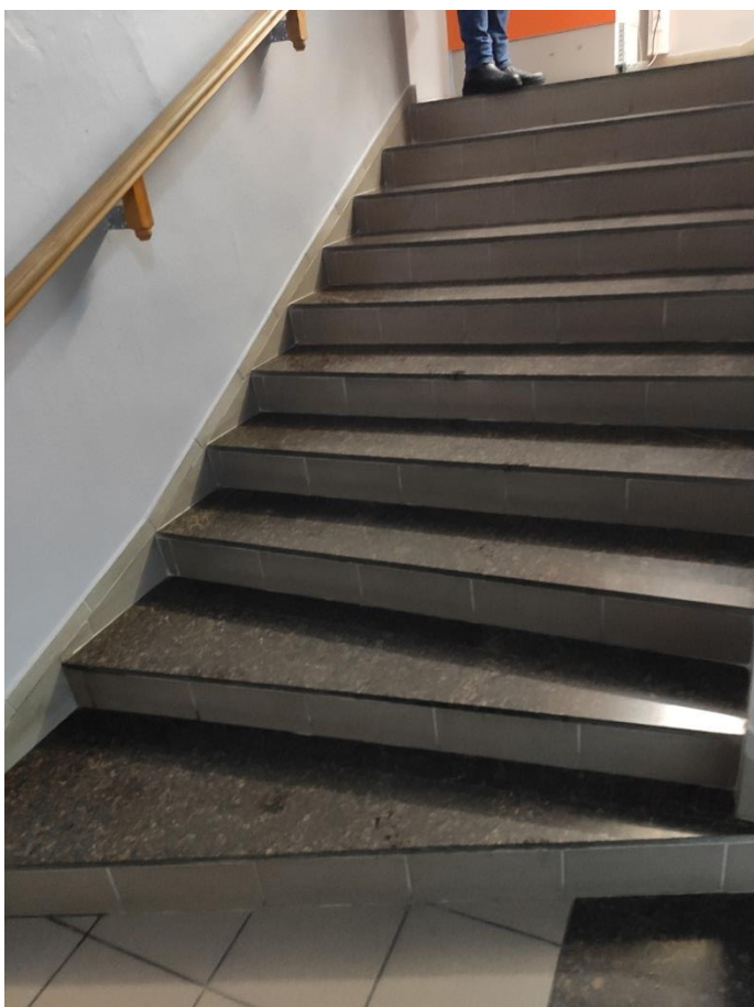
16. «Магазин, контора», Ленинградская область, Выборгский район, г. Выборг, ул. Мира, д. 8. Подвал. Фрагмент. Фото 01.04.2022г.
