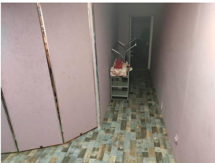
18. «Магазин, контора», Ленинградская область, Выборгский район, г. Выборг, ул. Мира, д. 8. Подвал. Общий вид. Фото 01.04.2022г.
