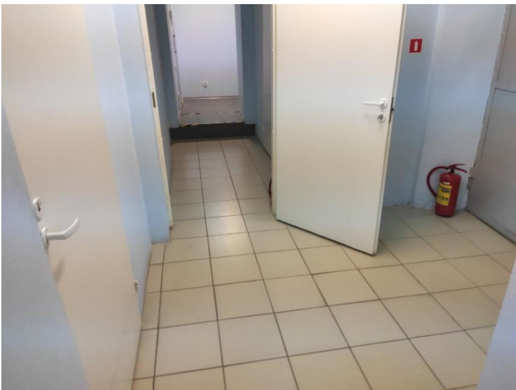
11. «Магазин, контора», Ленинградская область, Выборгский район, г. Выборг, ул. Мира, д. 8. Подвал. Общий вид. Фото 01.04.2022г.
