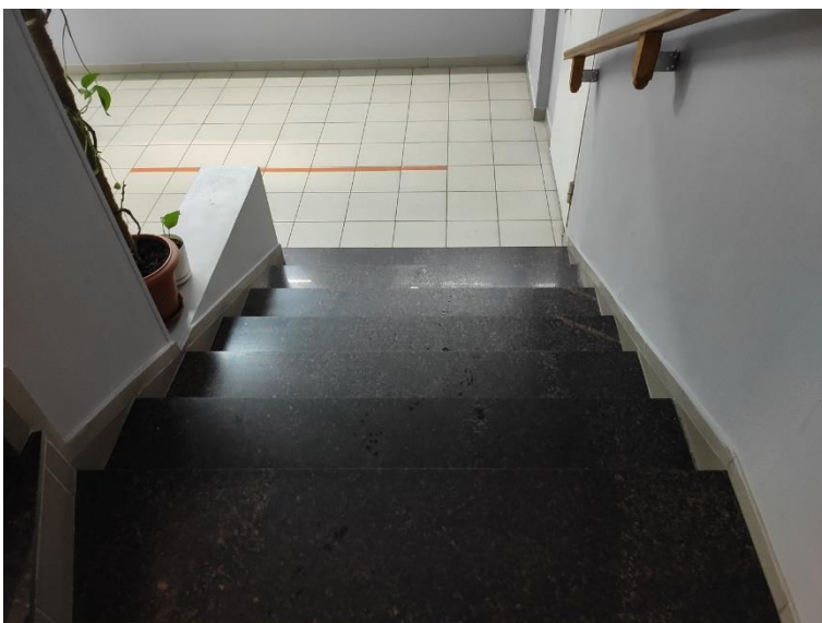
17. «Магазин, контора», Ленинградская область, Выборгский район, г. Выборг, ул. Мира, д. 8. Подвал. Общий вид. Фото 01.04.2022г.
