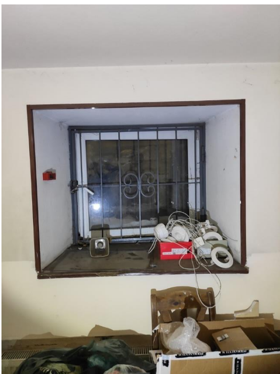
21. «Магазин, контора», Ленинградская область, Выборгский район, г. Выборг, ул. Мира, д. 8. Подвал. Общий вид. Фото 01.04.2022г.
