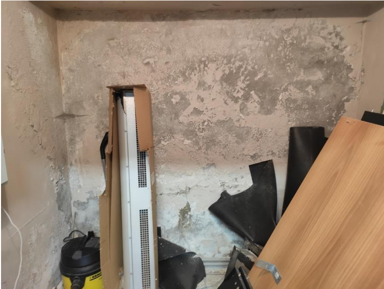
9. «Магазин, контора», Ленинградская область, Выборгский район, г. Выборг, ул. Мира, д. 8. Подвал. Общий вид. Фото 01.04.2022г.
