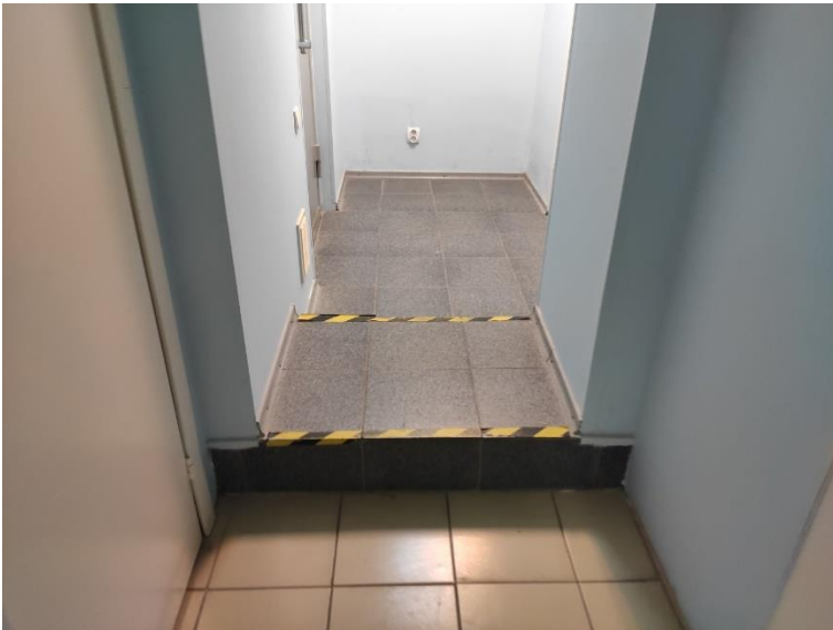
10. «Магазин, контора», Ленинградская область, Выборгский район, г. Выборг, ул. Мира, д. 8. Подвал. Общий вид. Фото 01.04.2022г.
