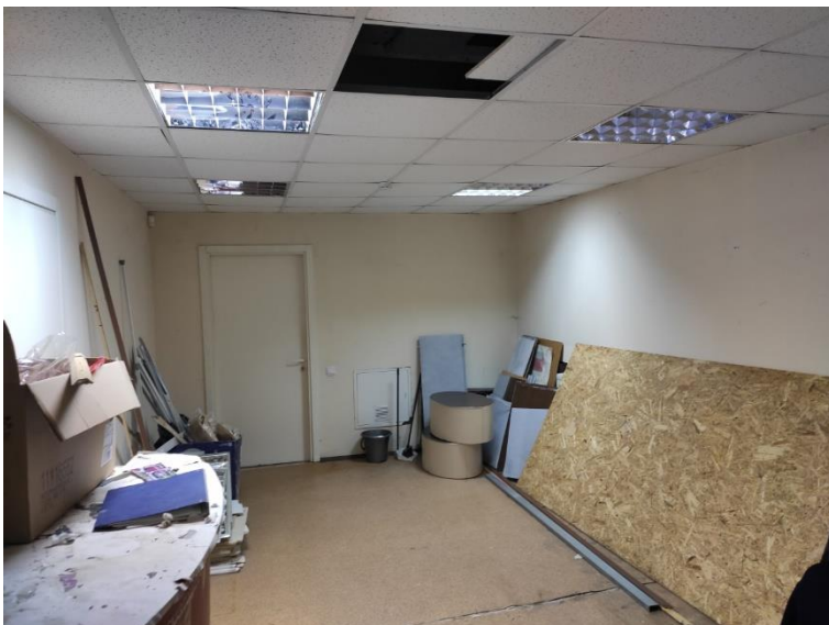
20. «Магазин, контора», Ленинградская область, Выборгский район, г. Выборг, ул. Мира, д. 8. Подвал. Общий вид. Фото 01.04.2022г.
