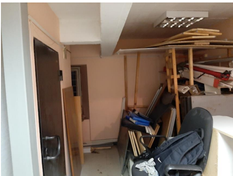
6. «Магазин, контора», Ленинградская область, Выборгский район, г. Выборг, ул. Мира, д. 8. Подвал. Общий вид. Фото 01.04.2022г.
