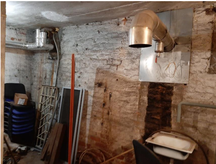
3. «Магазин, контора», Ленинградская область, Выборгский район, г. Выборг, ул. Мира, д. 8. Подвал. Общий вид. Фото 01.04.2022г.
